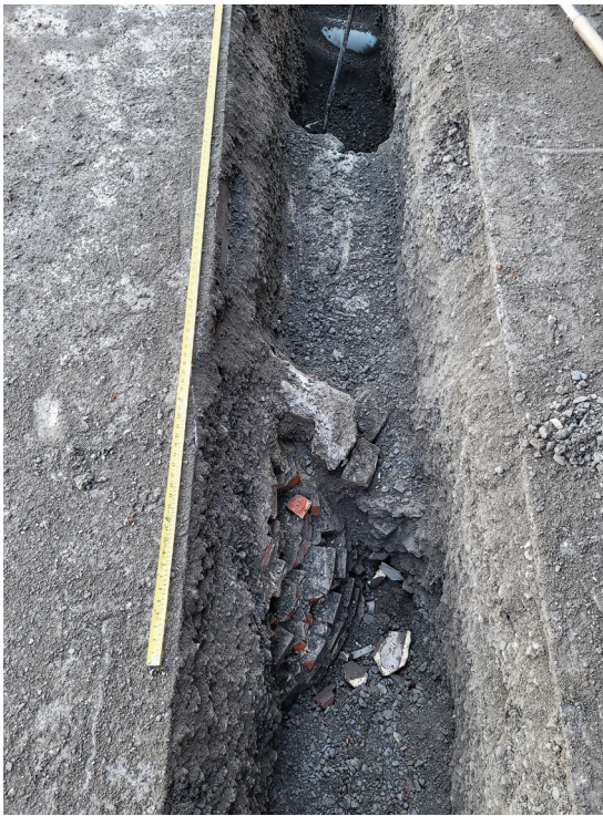
Photo 3 - La chambre d'accès en brique imbriquée dans un massif en béton, l'égout pluvial est visible en arrière-plan, vers le sud (MTL23-25-09-N1-042)
