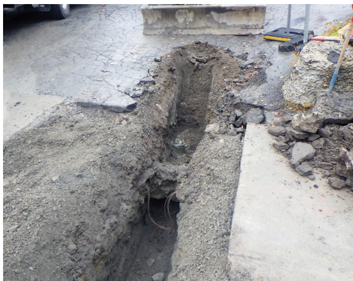
Photo 2 - Un massif en béton (en premier plan) et un bloc de béton ont été trouvés sous le trottoir près de l'entrée du complexe hospitalier Royal Victoria, vers l'ouest (MTL23-25-09-N1-015)
