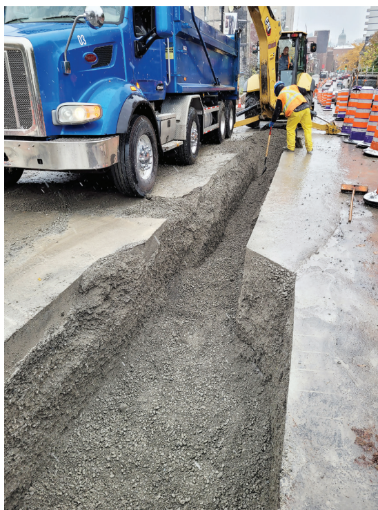
Photo 1 - L'épais remblai de gravier sous l'asphalte, vers le nord (MTL23-25-09-N1-039)
