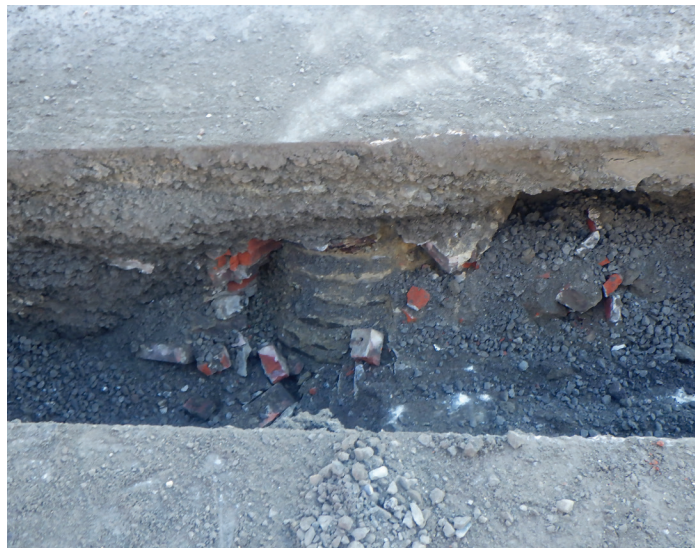
Photo 4 - Le comblement de la chambre électrique, vers l'est (MTL23-25-09-N1-030)
