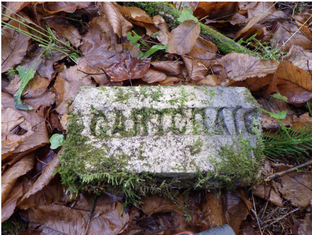
Photo 4 Brique réfractaire de type « Gartcraig » provenant de la paroi nord du moulin
