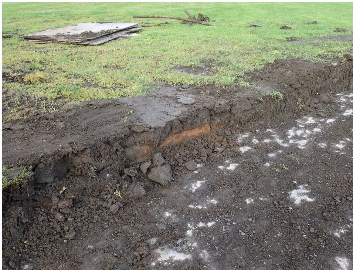
Photo 4.2 Segment de conduite en fonte observé lors de l'excavation de la sous-opération 2A (PATR23N12_1296).
