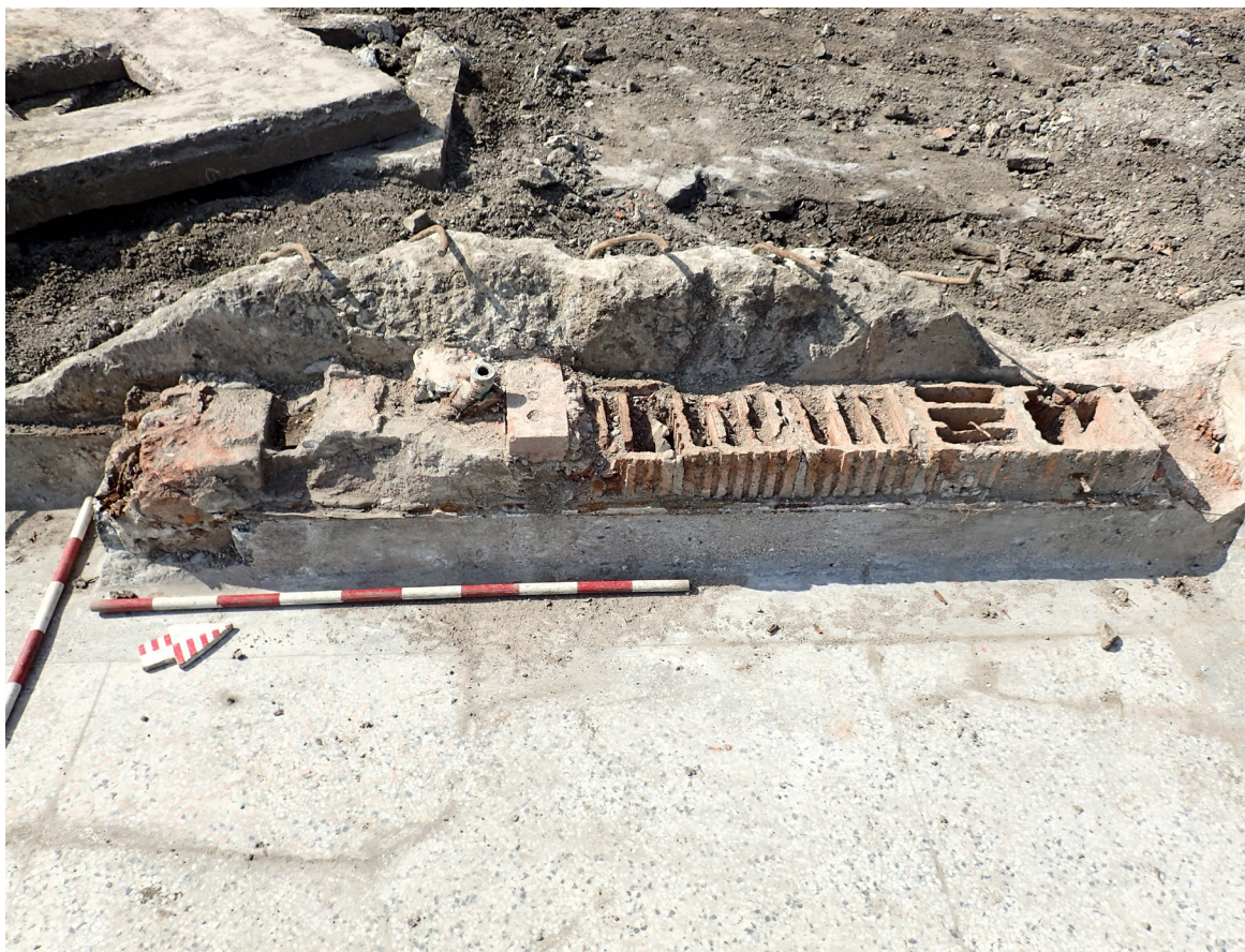
Photo 4.57 Vue vers le nord, d'un parement de brique alvéolaires bordant un pilastre en béton armé du mur (photo PATR23N12_1980).
