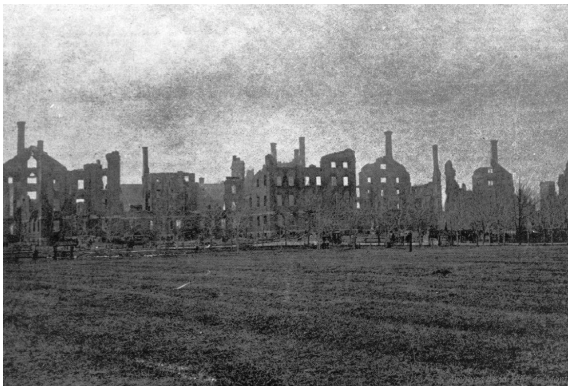
Figure 3.5 Pavillons incendiés du premier hospice Saint-Jean-de-Dieu en 1890 (Archives de villes de Montréal, VM5_0_13_vol17-fig0141).
