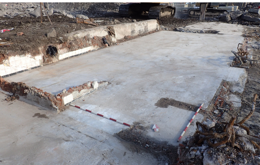
Photo 4.71 Vue générale vers l'est de la pièce nord du solarium de 1960, sous-opération 9E (photo PATR23N12_2239).
