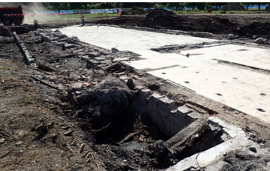
Photo 4.18 Mur nord (vesige 4A117) du pavillon montrant une partie du terrazzo conservé au-dessus des solives. Vue vers l'ouest (photo PATR23N12_1550).
