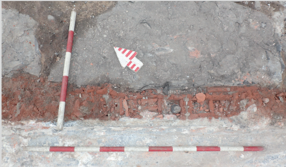
Détails briques alvéolées/ondulées (3A118), vue vers le nord-est. (PATR23N12-1364)
