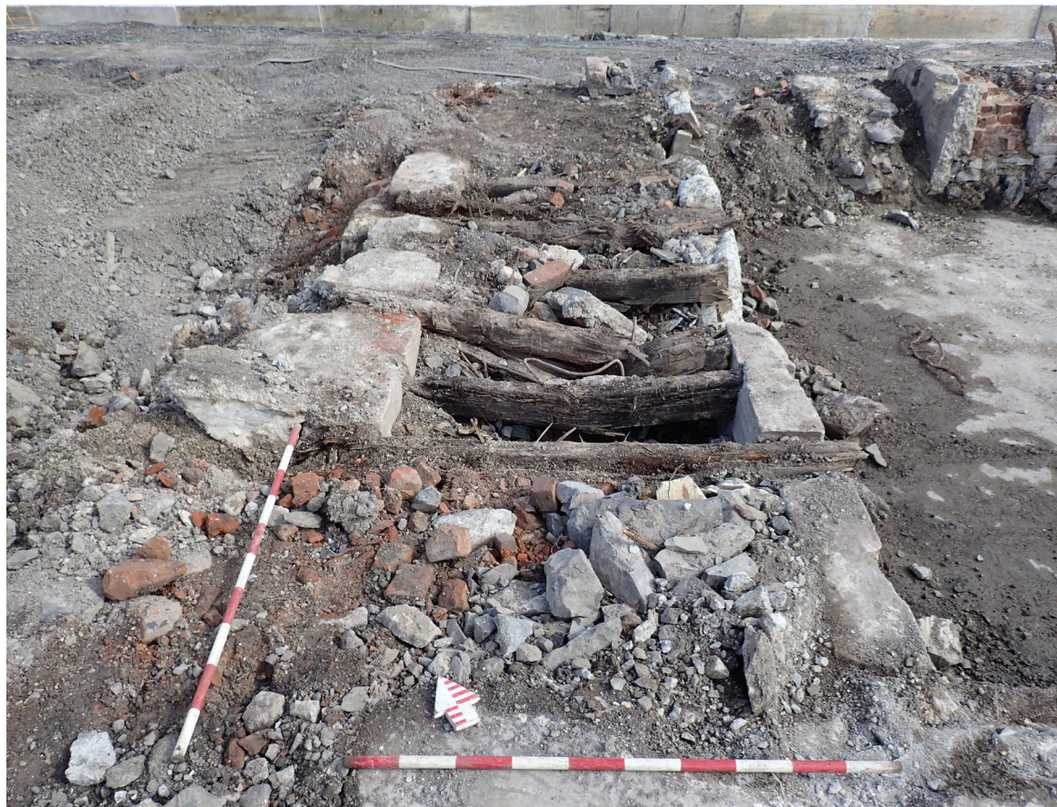
Photo 4.67 Solives entre les murs de refend de béton 9A103 et 9A117. Vue vers l'est (photo PATR23N12_2311).
