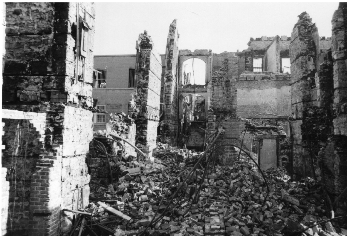
Figure 3.18 Intérieur de l'un des pavillons de l'aile Sainte-Marie après l'incendie du 20 septembre 1977 (Archives de villes de Montréal, R3510-2_7401_-1977-001).
