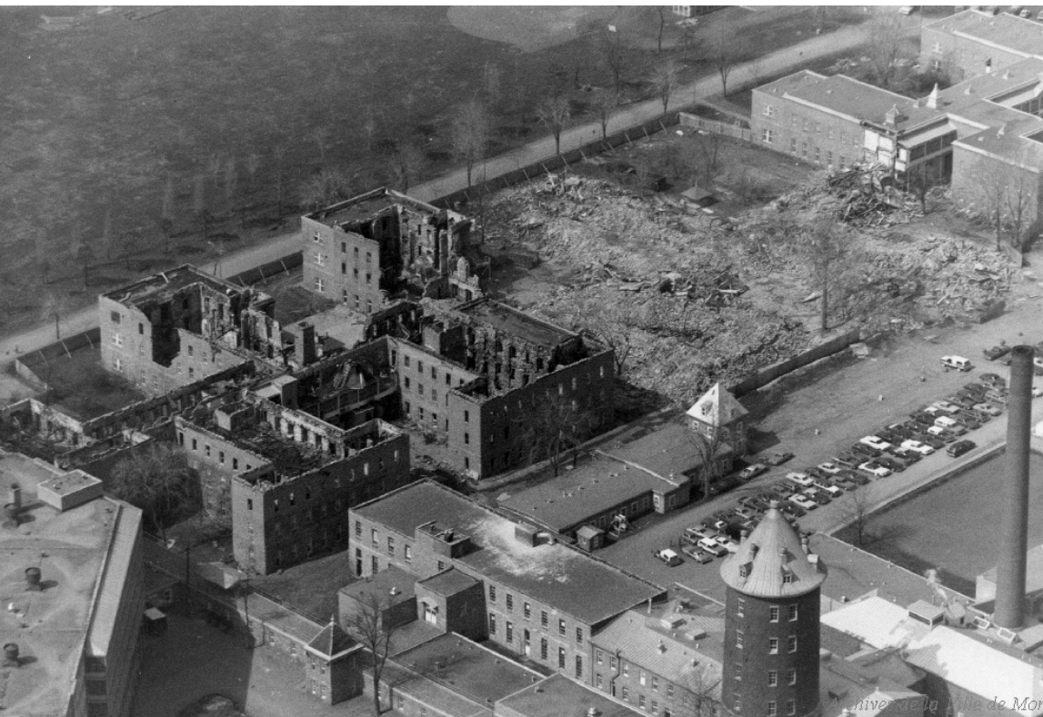
Figure 3.20 Vue aérienne des vestiges de l'incendie de l'aile Sainte-Marie en 1978 (Archives de villes de Montréal, VM006, S10).
