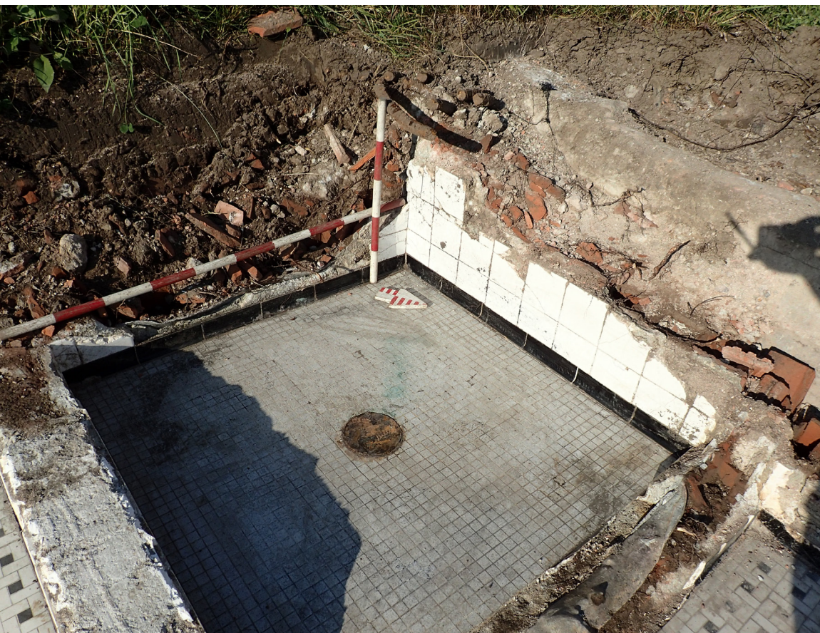
Photo 4.33 Cubicule de douche, vers le nord-ouest, lot 5B1 (photo PATR23N12_1698).
