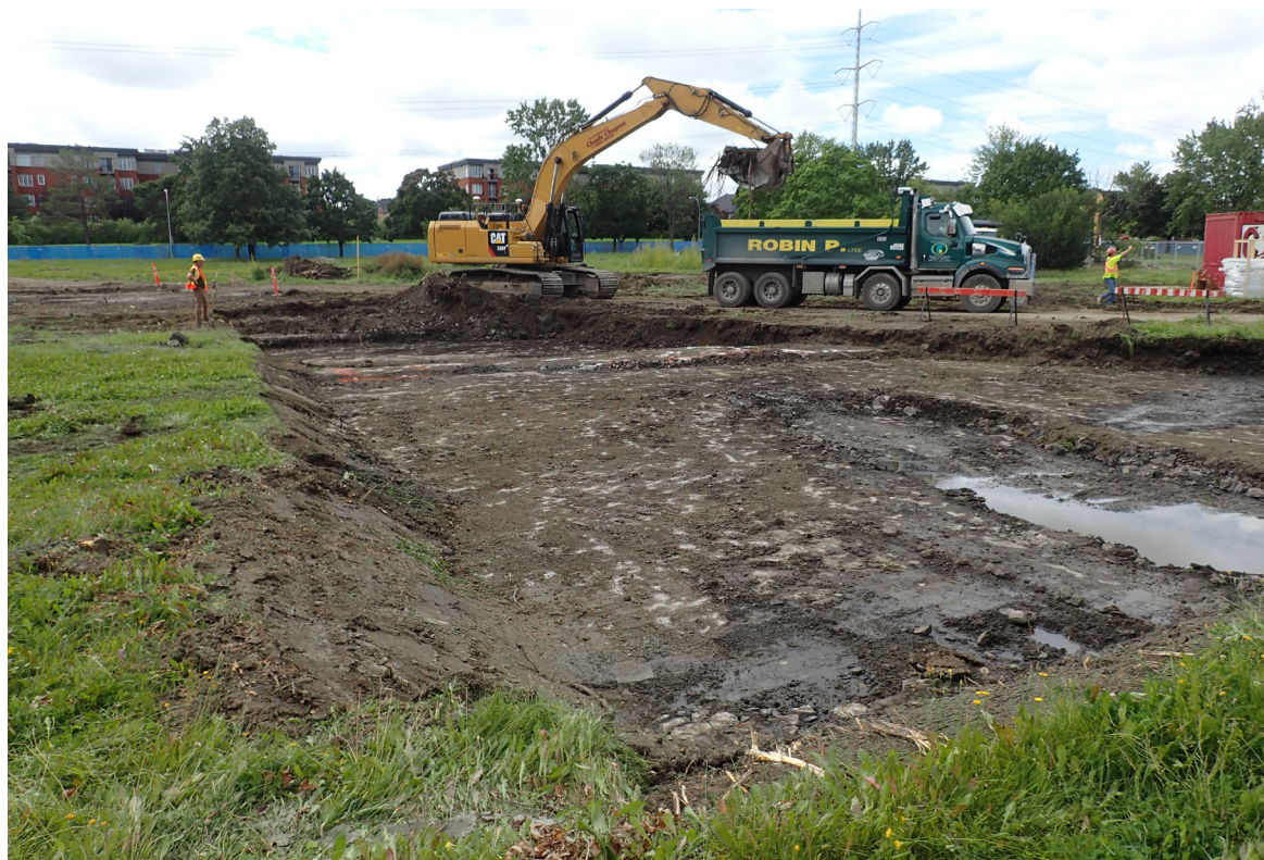
Photo 4.1 Vue générale vers le nord-est de l'opération 2 en cours d'excavation (photo PATR23N12_1332).
