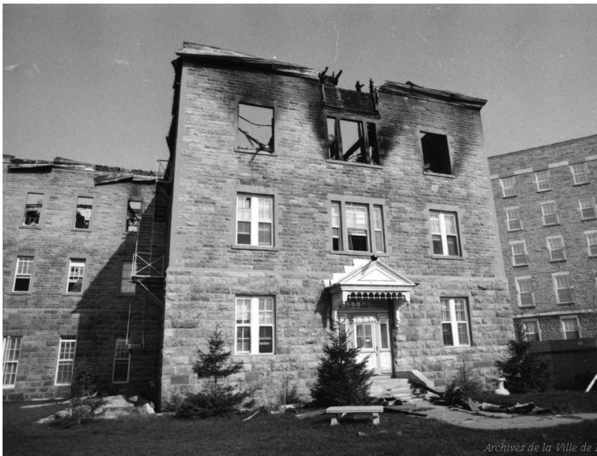
Figure 3.19 Façade de l'un des pavillons de l'aile Sainte-Marie après l'incendie du 20 septembre 1977 (Archives de villes de Montréal, R3510-2_7401_-1977-005).
