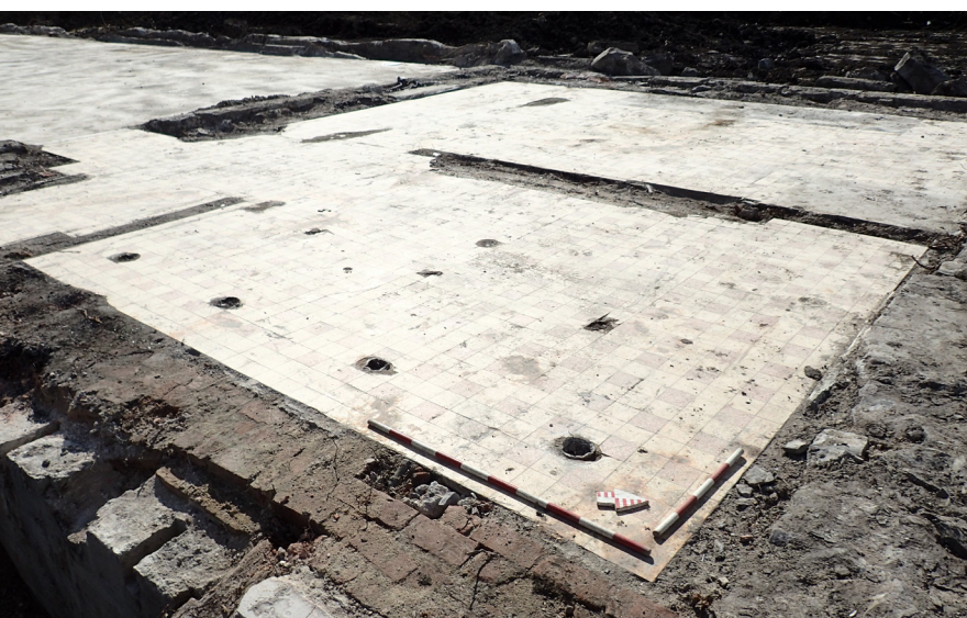
Photo 4.20 Vue vers le nord-ouest du bloc sanitaire de la sous-opération 4B (photo PATR23N12_1608).
