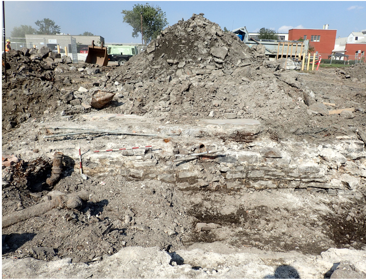
Photo 4.43 Parement est du mur 6A103 (photo PATR23N12_2009).
