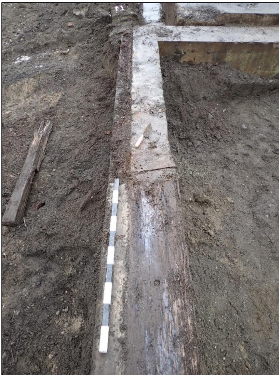
Figure 15. Vestige CcEr-1-2E100, détail du sommet des murs avec madriers encastrés, vue vers le nord (Photographie VJS1_BP1_142)
