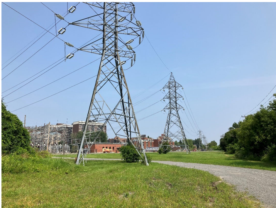
Photo 1. L'aire d'intervention lors d'une visite en juillet 2023. Le poste Hampstead est visible à l'arrière-plan, vue vers le nord (Crédit : Jonathan Choronzey)
