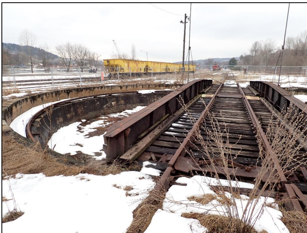
Figure 30. Détail du système sur rails de la plaque tournante (« turntable ») au sud-est de la zone d'étude (Photographie VJS1_BP1_231)
