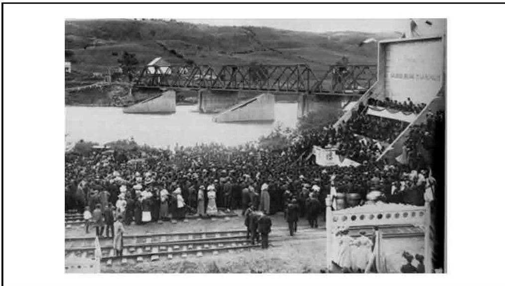
Et Journal En bauce (Archives musée ferroviaire de Beauce) : visite de Wilfrid Laurier à l'été 1911 à Vallée Jonction, second pont https://www.enbeauce.com/actualites/chroniques/453522/nos-ponts-des-chars-de-1881-a-aujourd'hui2-de-2
