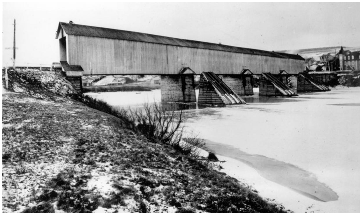
Figure 6 : Premier pont ferroviaire de Vallée-Jonction, vue vers la gare (Source : En Beauce, 27 février 2022, Nos « ponts des chars » de 1881 à aujourd'hui (1 de 2))
