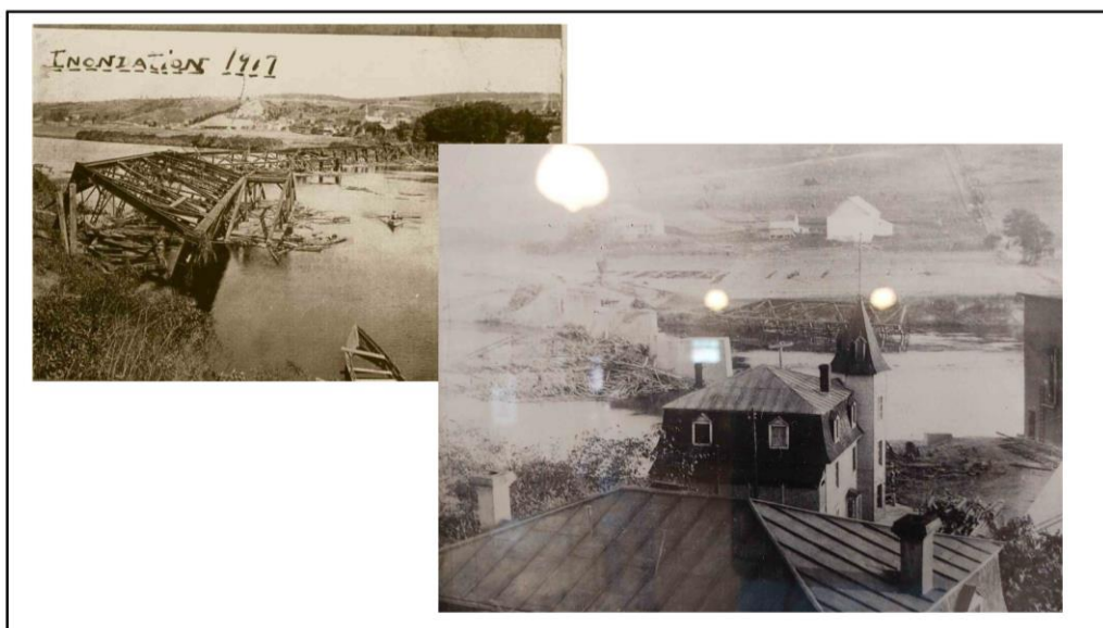
Musée ferroviaire de Beauce : Second pont ferroviaire (photo exposée à droite et journal en Beauce n ligne à gauche)
