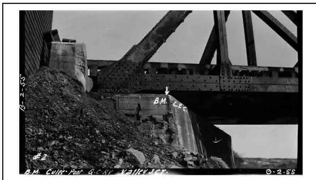
BAnQ Numérique: Détail du Pont du Québec C. Railway à Vallée-Jonction
