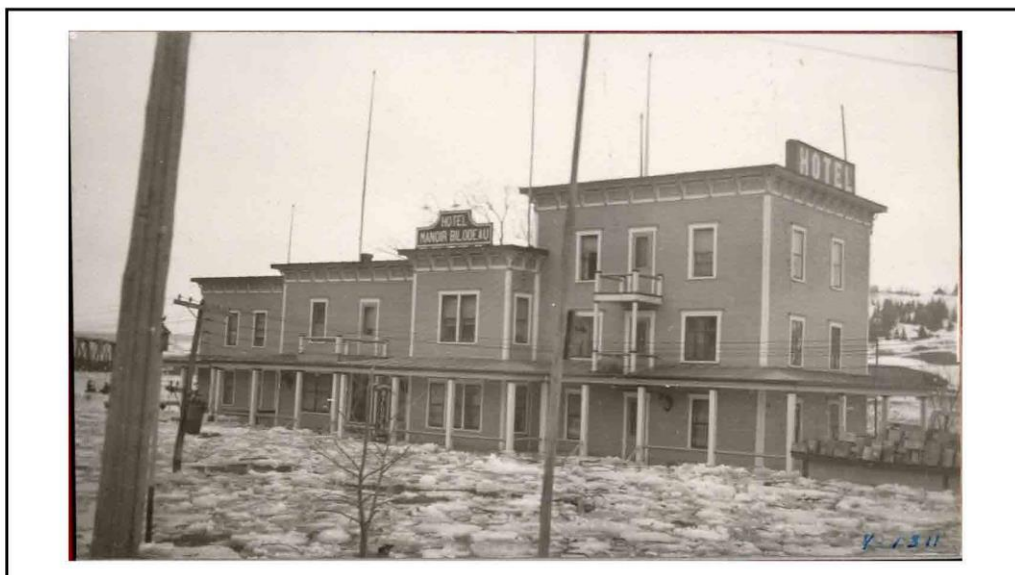
BAnQ numérique : Rivière Chaudière - Inondation à Vallée-Jonction et débâcle
