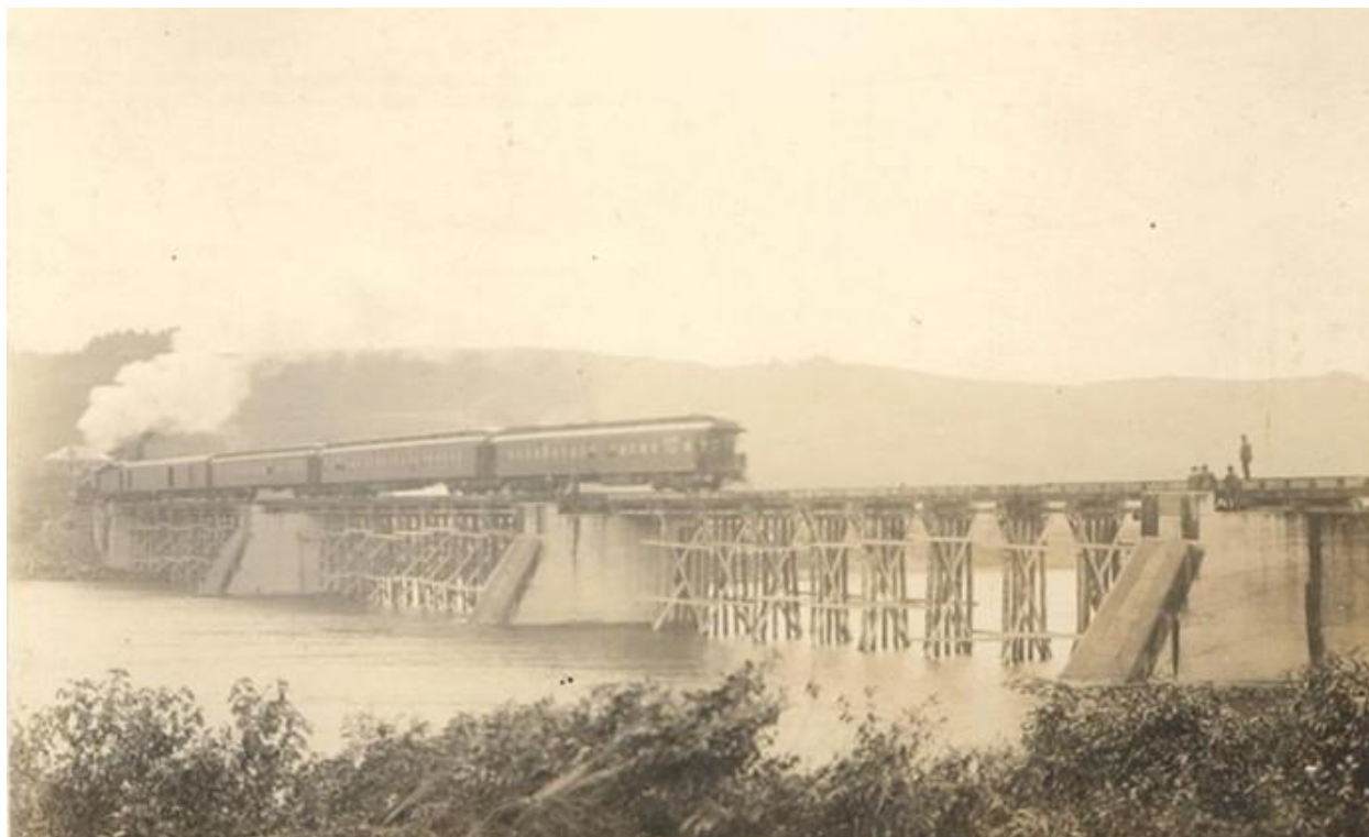
Figure 11 Construction du tablier du troisième pont ferroviaire de Vallée-Jonction en août 1917 (Source : En Beauce, 27 février 2022, Nos « ponts des chars » de 1881 à aujourd'hui (1 de 2))
