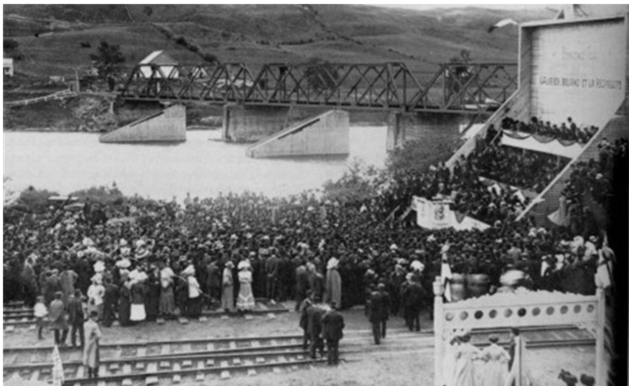
Figure 7 : Second pont ferroviaire de Vallée-Jonction lors de la visite de Wilfrid Laurier en 1911, vue vers la rive ouest (Source : En Beauce, 27 février 2022, Nos « ponts des chars » de 1881 à aujourd'hui (2 de 2))
