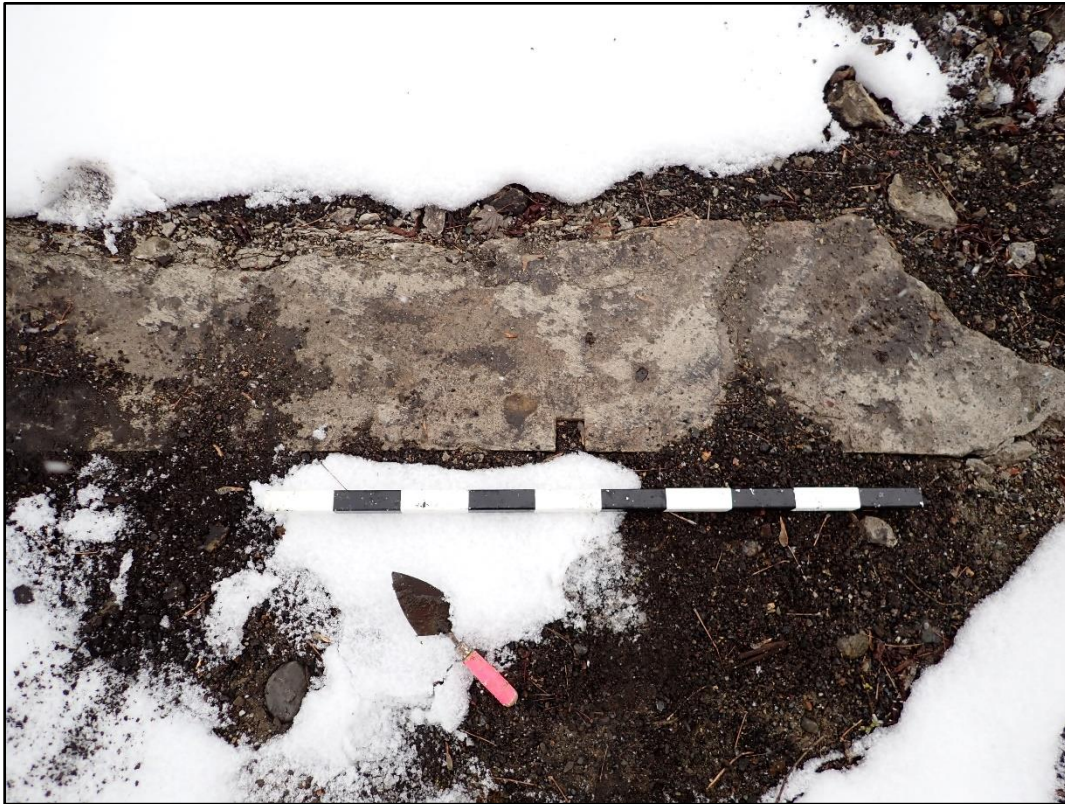
Figure 21. Vestige CcEr-1-2F100, encoche carrée sur le parement extérieur du vestige (Photographie VJS1_BP1_079)
