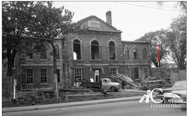
Photo 6.54 Démolition en cours du deuxième palais de justice en 1961 (Bélanger). L'emplacement qui avait été choisi pour le nouveau logis du geôlier est indiqué par la flèche rouge.
