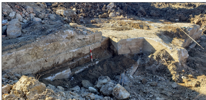
Photo 6.27 Sous-opération 2C, partie centrale du mur est du palais de justice Archéotec 2023, SHI23_PV2_080
