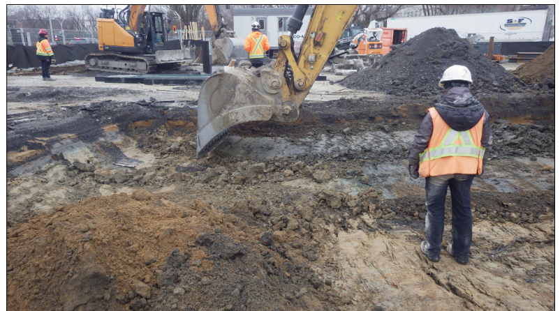
Photo 6.67 Sous-opération 3E, supervision des excavations mécaniques dans le secteur des bâtiments secondaires au nord du palais Archéotec 2023, SHI23_PV1_195
