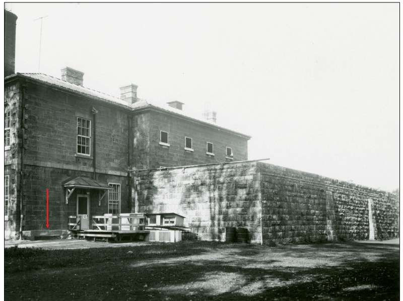
Photo 6.55 Mur est du palais et de la prison avec le mur de la cour. Cet emplacement avait été choisi pour le nouveau logis du geôlier. On observe la présence d'une ouverture à la base du mur est du palais (flèche rouge).
