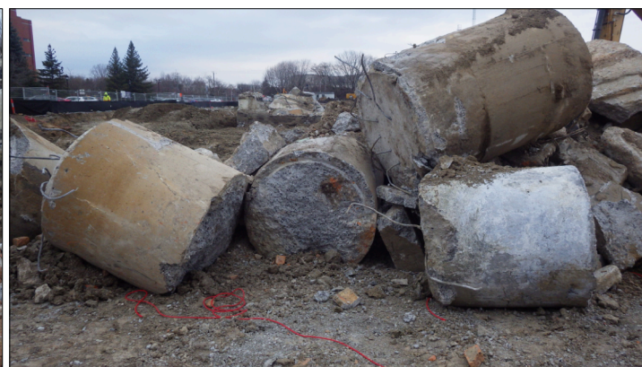
Photo 6.53 Sous-opération 2C, aperçu du démantèlement des structures en béton en sous-œuvre Archéotec 2023, SHI23_PV1_211
