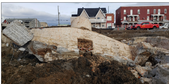
Photo 6.51 Sous-opération 2C, aperçu du démantèlement des structures en béton en sous-œuvre Archéotec 2023, SHI23_PV2_269
