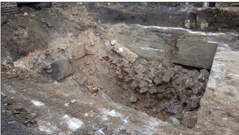
Photo 6.16 Sous-opération 2C, aperçu de la composition des débris de démolition dans la chaufferie, avec des traces de poussière d'anthracite.
