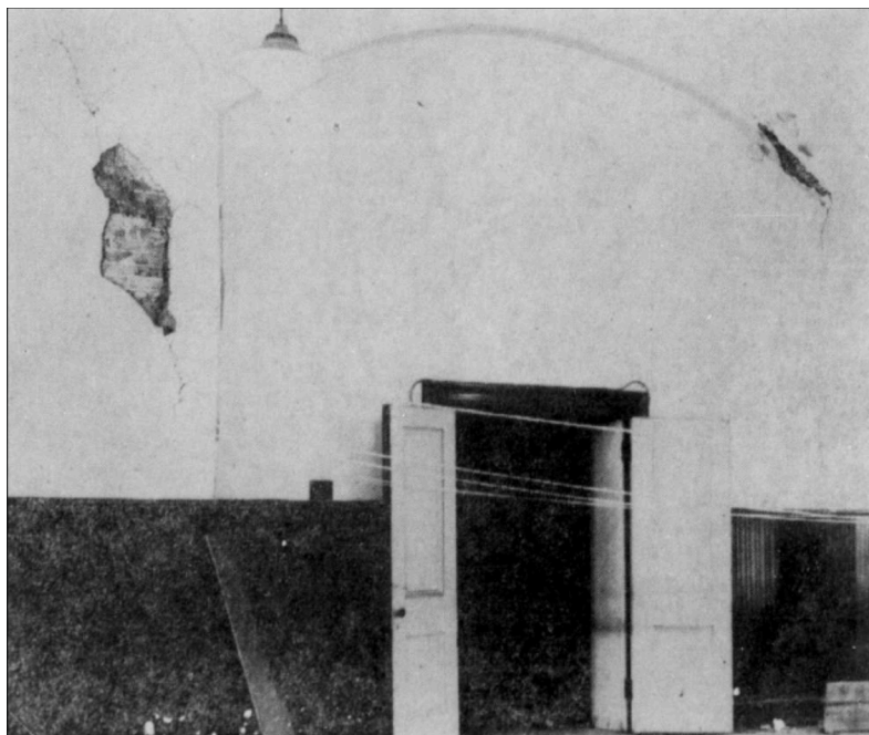
Photo 5.7 Aperçu de l'intérieur de l'ancien palais de justice avant sa démolition en 1961
