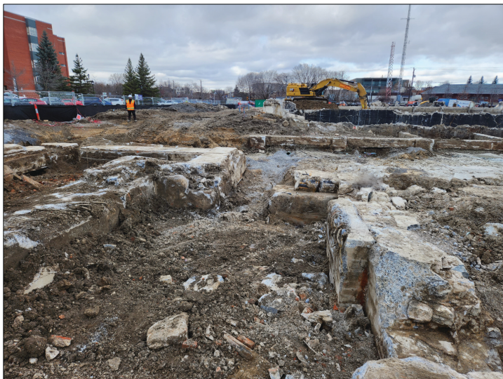
Photo 6.49 Sous-opération 2C, vestiges de la salle d'archives du protonotaire, aile construite en 1877 et agrandie après 1922 Archéotec 2023, SHI23_JF1_300
