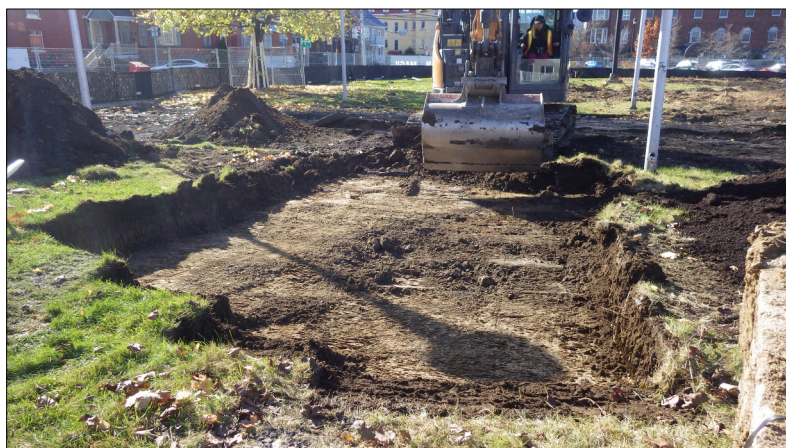
Photo 6.2 Vue générale de la sous-opération 2A et de l'ancien niveau de surface (2A3)
