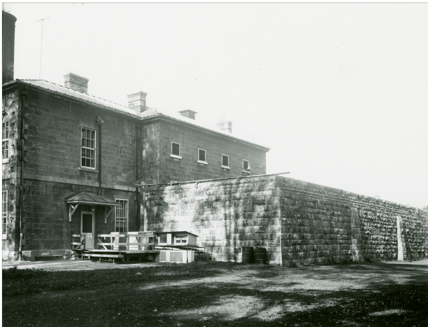
Photo 5.5 Mur de la prison de Saint-Hyacinthe. Des contreforts sont visibles à droite, sur le mur qui faisait face à la rue Rosalie (rue de l'Hôtel-de-Ville). Centre d'histoire de Saint-Hyacinthe, CH085/011/008/0005
