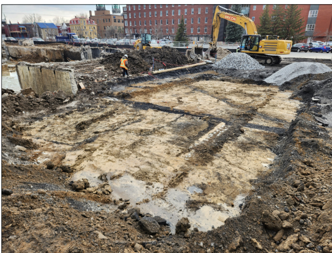
Photo 6.72 Sous-opération 3E, vue générale montrant la base des excavations, vers le sud-ouest, avec les éléments mis au jour à la surface du sol naturel
