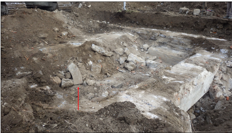
Photo 6.9 Sous-opération 2C, salle de débarras. Débris de démolition du palais de justice avec avec une partie de l'arc d'un cadre de fenêtre en pierre (flèche rouge), notamment Archéotec 2023, SHI23_PV1_050
