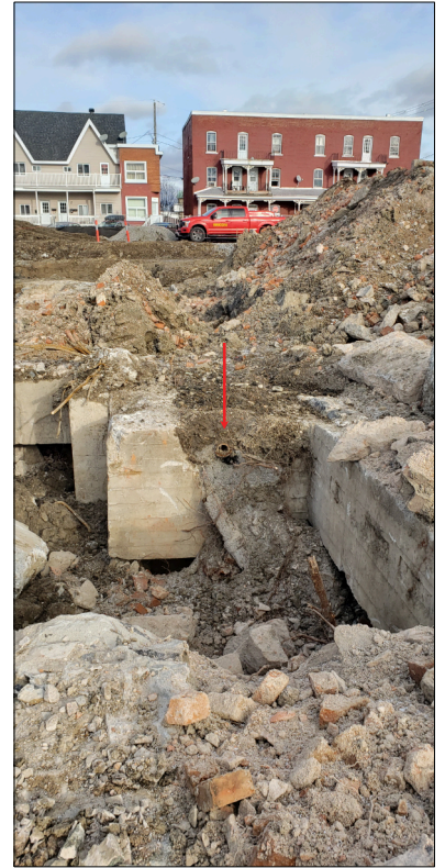
Photo 6.31 Sous-opération 2C, canalisation en fonte dans la partie centrale du palais, dans un axe est-ouest Archéotec 2023, SHI23_PV2_260
