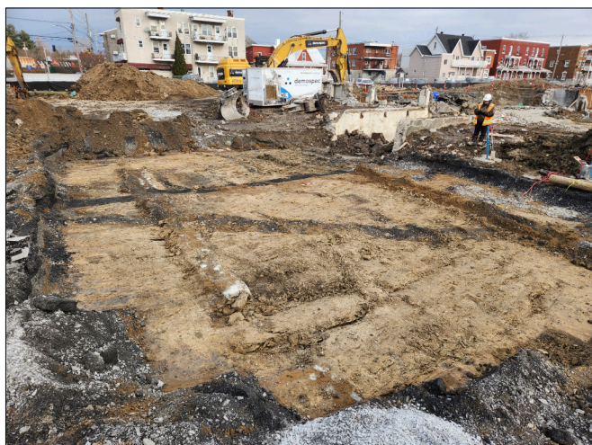
Photo 6.71 Sous-opération 3E, vue générale montrant la base des excavations, vers le sud-est, avec les éléments mis au jour à la surface du sol naturel
