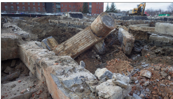
Photo 6.52 Sous-opération 2C, aperçu du démantèlement des structures en béton en sous-œuvre Archéotec 2023, SHI23_PV1_194
