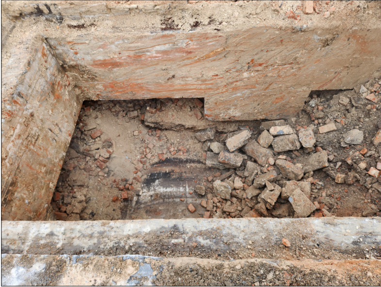
Photo 6.21 Sous-opération 2C, vestiges de la salle des empreintes et photos. Détail de la structure en sous-œuvre et de la dalle de béton Archéotec 2023, SHI23_JF1_079
