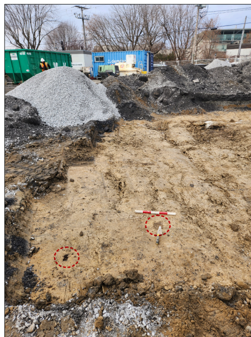
Photo 6.74 Sous-opération 3E, vue vers le nord, avec les éléments mis au jour à la surface du sol naturel, dont au moins un pilotis et un trou de poteau (cercles rouges)
