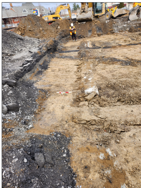
Photo 6.73 Sous-opération 3E, vue vers l'est, avec les éléments mis au jour à la surface du sol naturel, dont la fondation d'un mur de soutènement en béton
