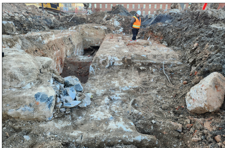
Photo 6.30 Sous-opération 2C, cage d'escalier dans la partie nord-est du palais de justice Archéotec 2023, SHI23_JF1_149
