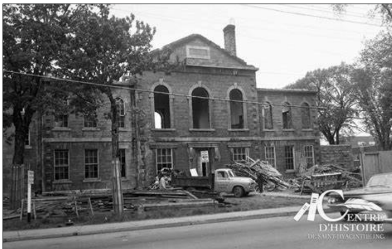
Photo 5.8 Démolition en cours du deuxième palais de justice en 1961 (Bélanger)
