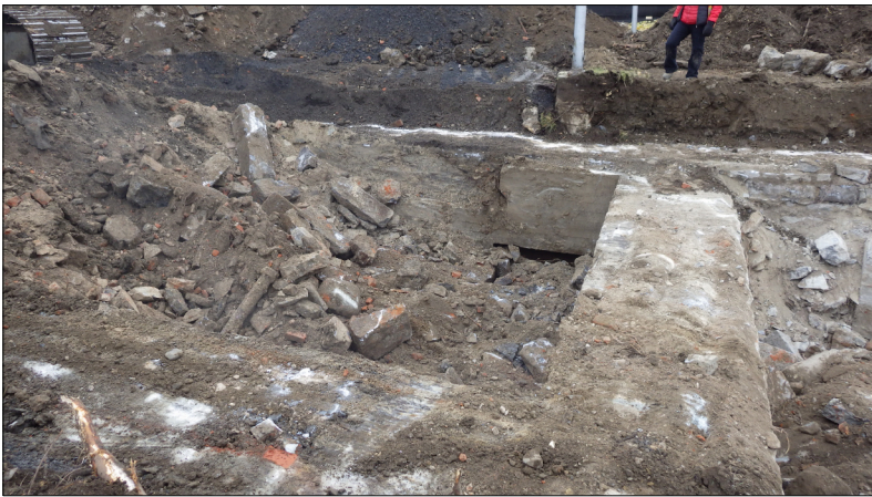
Photo 6.15 Sous-opération 2C, aperçu de la composition des débris de démolition du palais
