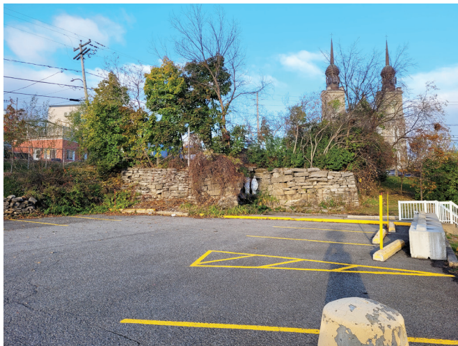
Photo 15 - BjFj-232 — Mur de soutènement à l'arrière du terrain. La pente naturelle du terrain est visible à droite des murs en pierre — Vue vers le nord-ouest (BjFj-232-23-N1-38)
