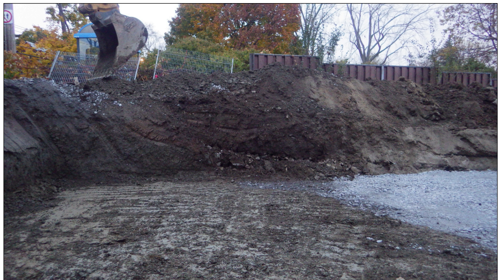
Photo 4.8 Sous-opération 1A, paroi est à la fin de l'excavation, pente vers l'ancienne berge avec enrochement Archéotec 2023, PCS23b_JF1_2980
