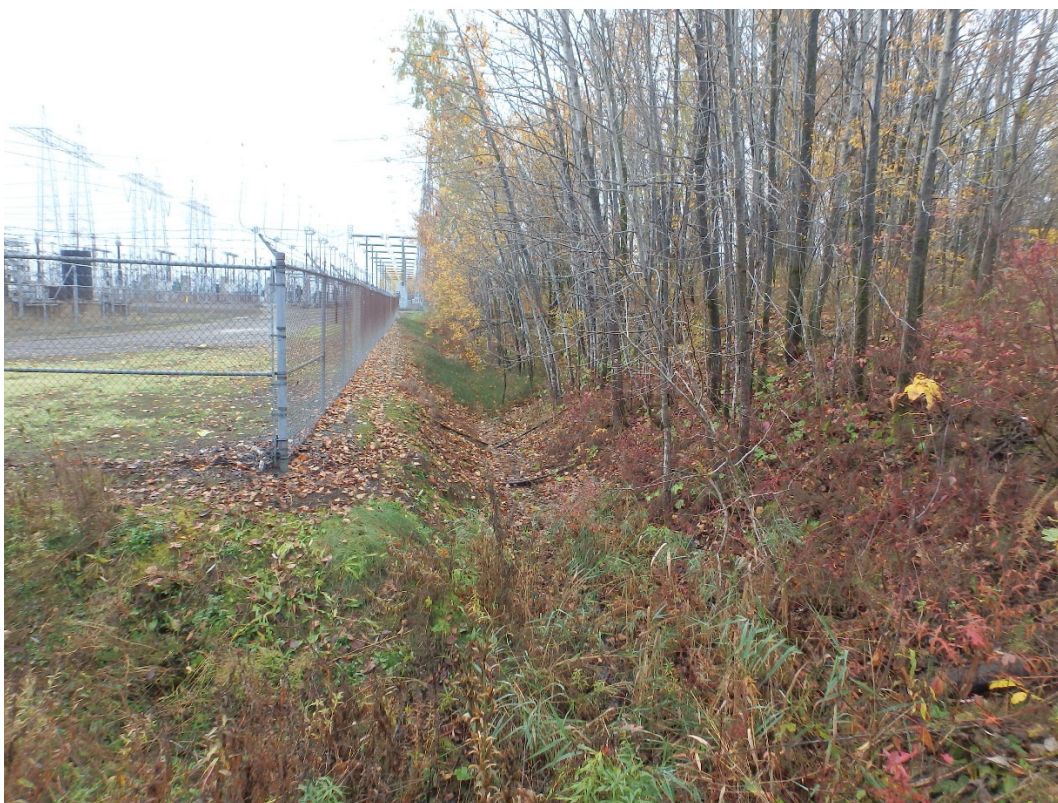
Photo 6. Fossé et remblai à l'ouest du poste Laurentides, vue vers le sud (HYD2338-NUM2-14)
