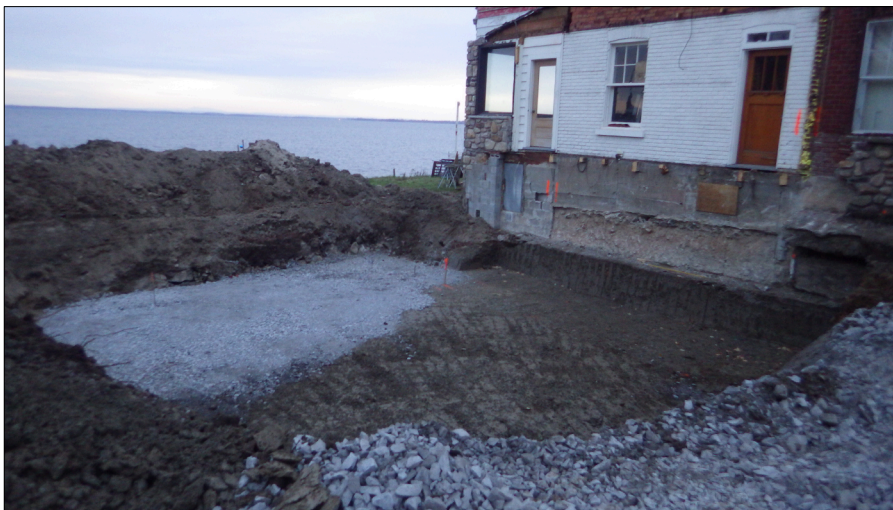
Photo 4.10 Sous-opération 1A, emplacement approximatif de l'ancienne rupture de pente (limite du concassé), vue vers le sud-ouest Archéotec 2023, PCS23b_JF1_2982
