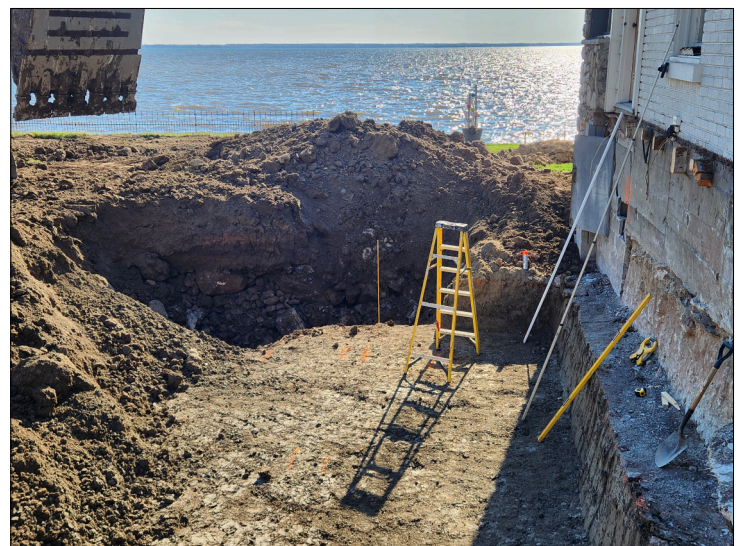
Photo 4.5 Sous-opération 1A, enrochement témoin de l'ancienne berge, vue vers le sud Archéotec 2023, PCS23b_JF2_0017
