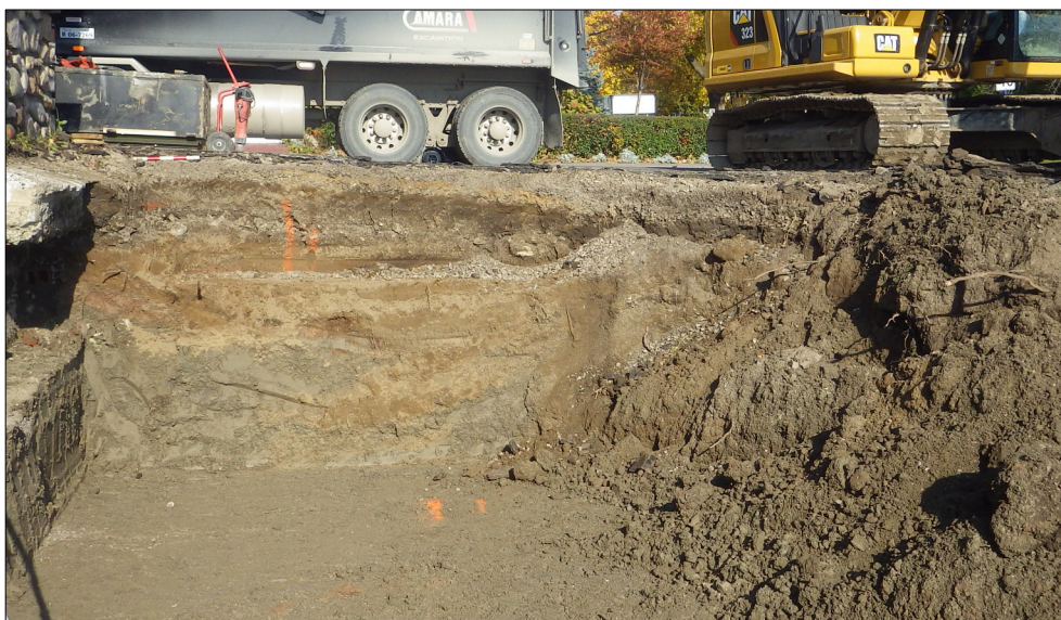
Photo 4.6 Sous-opération 1A, paroi nord moitié ouest, vue vers le nord Archéotec 2023, PCS23b_JF1_2952
