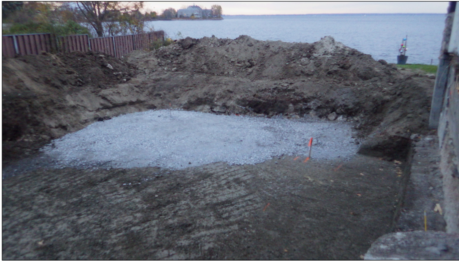
Photo 4.9 Sous-opération 1A, paroi sud, vue vers le sud-est avec la pointe Claire et le couvent Notre-Dame-du-Vieux-Moulin en arrière-plan Archéotec 2023, PCS23b_JF1_2985
