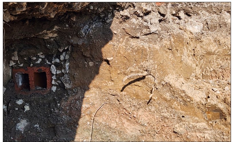
Photo 4.4 Sous-opération 1A, tranchée avec brique plâtrière le long de la maison, vue vers le nord-ouest Archéotec 2023, PCS23b_JF2_0014
