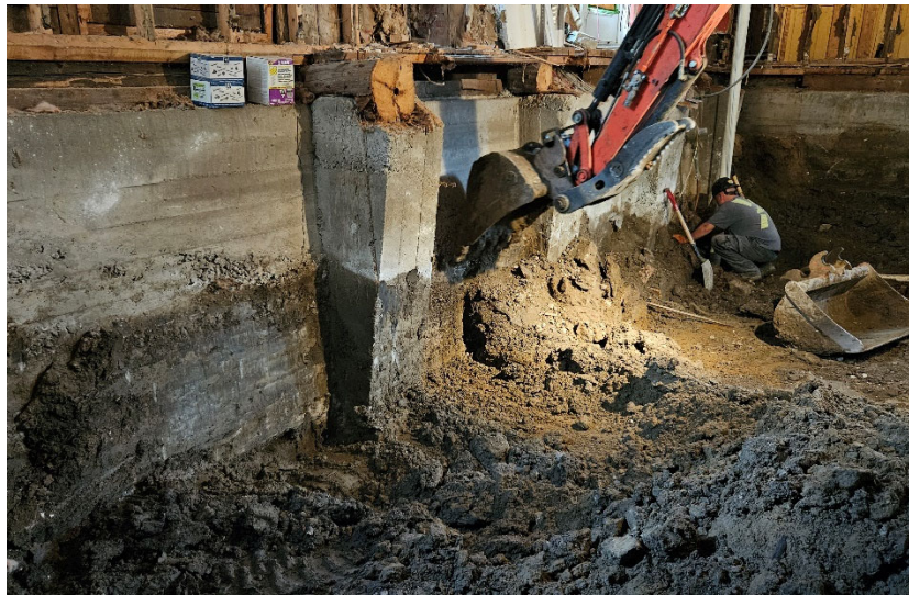
Photo 10. Excavations le long du mur de fondation ouest, vue vers le nord-ouest (BjFi-23-24-NUM1-020)
