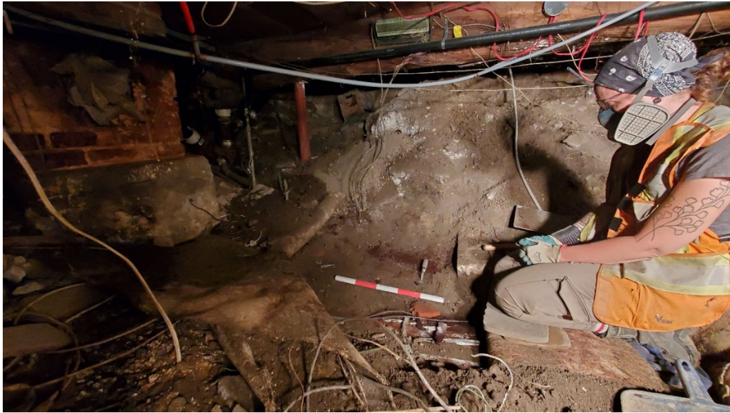
Photo 8. Réalisation du sondage 1D à l'ouest de la base de cheminée, vue vers le sud (BjFi-23-21-NUM1-18)
