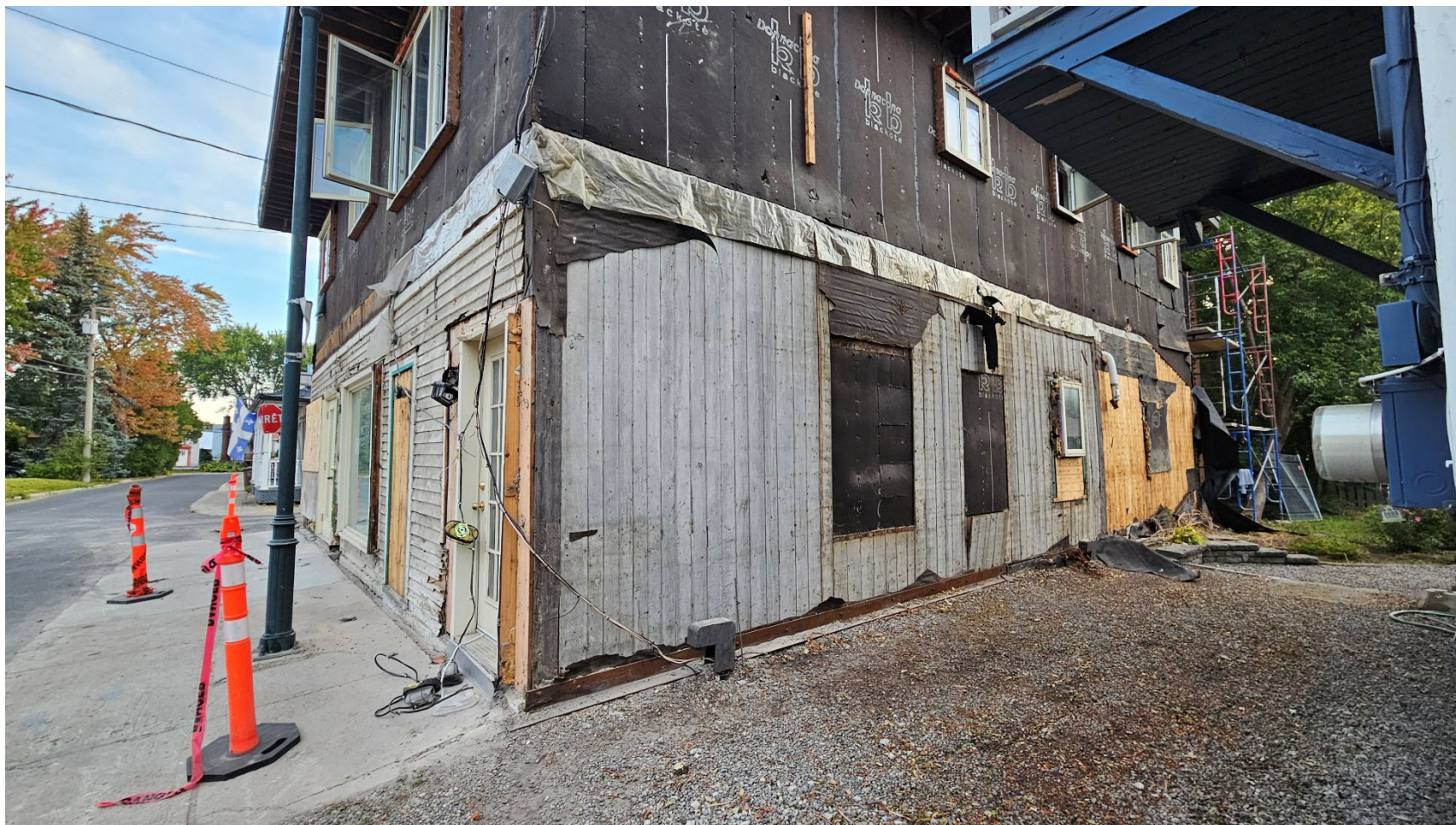
Aspect extérieur du mur sud de la section ouest du bâtiment, vue vers le nord-est (BjFi-23-24-NUM1-010)
