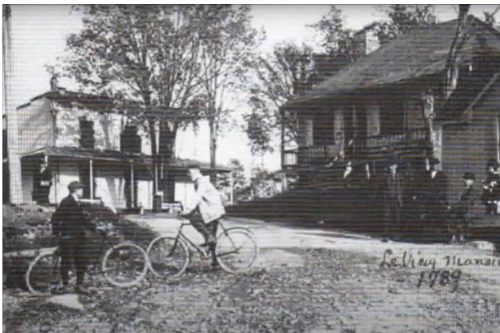
Figure 7 Cette photographie ancienne montre deux bâtiments présents à l'extrémité nord de l'avenue L'Archevêque, de même que la descente menant vers la rivière (Source : Traverse Sigouin-L'Archevêque).
