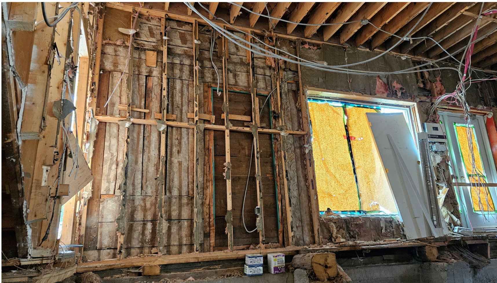
Aspect intérieur du mur ouest de la section ouest du bâtiment, vue vers le nord-ouest (BjFi-23-24-NUM1-032)
