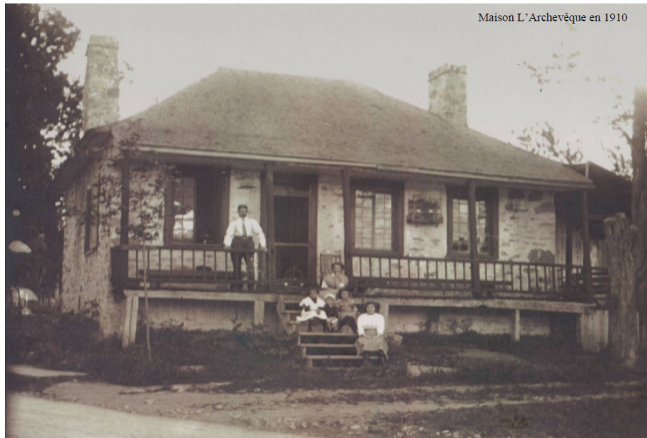
Figure 5 Maison Corbeil-L'Archevêque vers 1910 (Source Guiard 2018).
