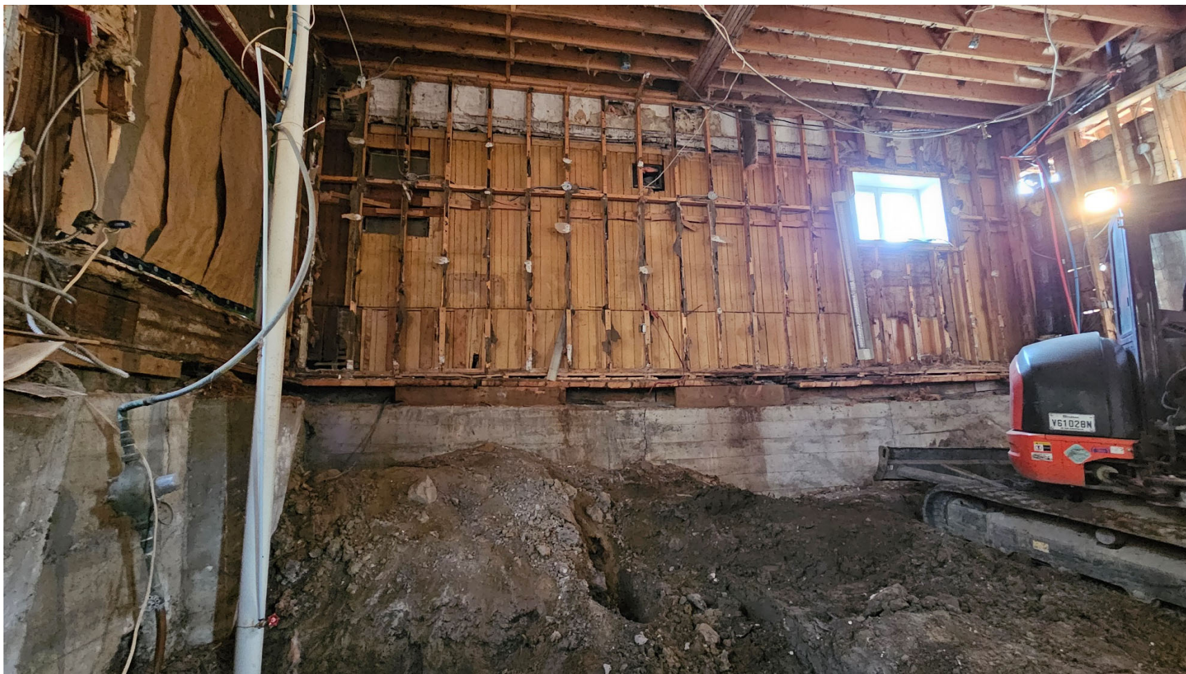
Aspect intérieur du mur nord de la section ouest du bâtiment, vue vers le nord (BjFi-23-24-NUM1-016)
