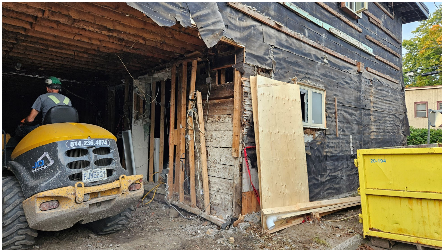
Quelques détails de l'extérieur mais surtout de l'intérieur du mur de refend (est) de la section ouest du bâtiment, vue vers le sud-ouest (BjFi-23-24-NUM1-009)
