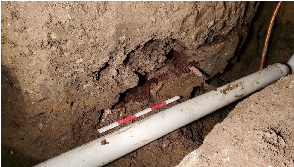
Photo 4. Planches de bois visibles dans la paroi sud de la tranchée du nouvel égout, vue vers le sud-ouest (Bjfi-23-21-NUM1-8)
