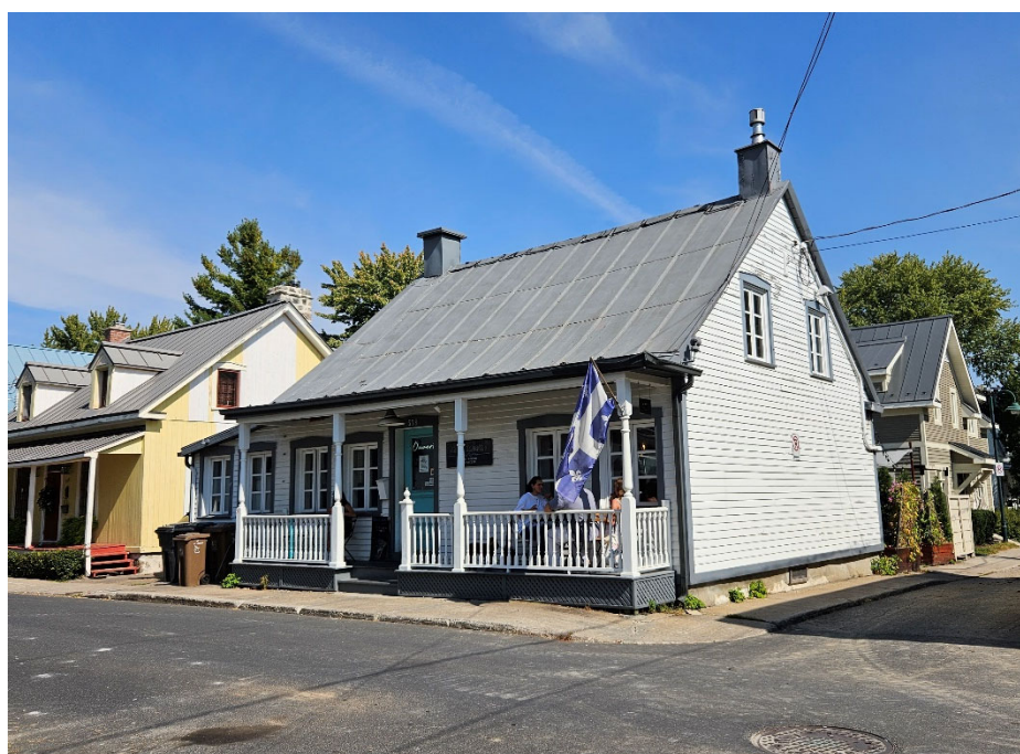
Photo 15. Le bâtiment voisin, situé au 578, St-Charles, dispose vraisemblablement de deux cheminées dans ses murs pignons, vue vers le nord-est (BjFi-23-24-NUM1-040)
