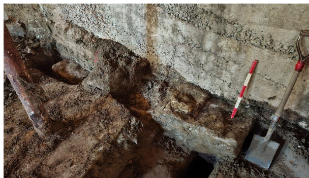
Photo 13. Sous le mur de fondation, une possible base de cheminée est présente, vue vers le sud-est (BjFi-23-24-NUM1-028)
