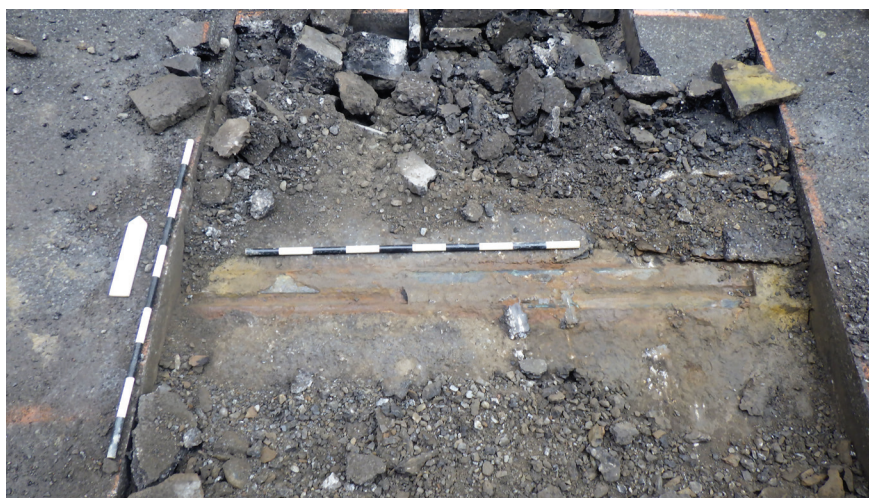
Photo 3 - Sous-opération 1A – Ancien rail du tramway (ST-1) – Vue vers le nord (MTL23-25-03-N1-008)
