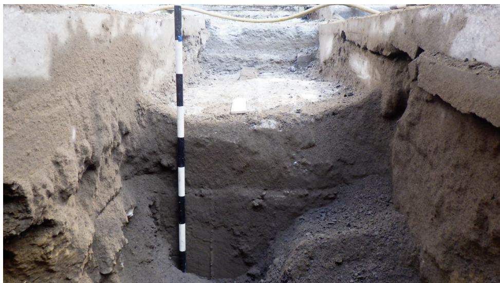
Photo 6 - Sous-opération 1A – Chambre électrique ST-2 – Vue en direction nord (MTL23-25-03-N1-019)
