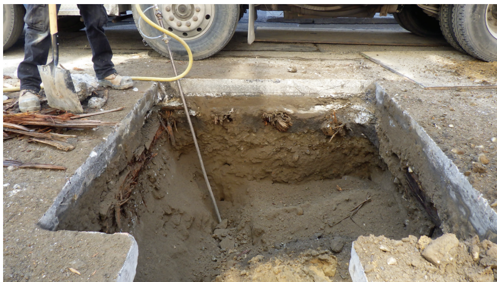
Photo 4 - Sous-opération 1A – Traverses de bois et infrastructure de l'ancienne voie de tramway – Vue vers le sud (MTL23-25-03-N1-029)
