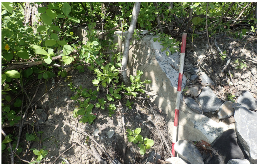
Photo 4.17 Parc Couvrette (LVL23-22), parement extérieur sud-est de la fondation de béton (photo PATR23N04_0137).
