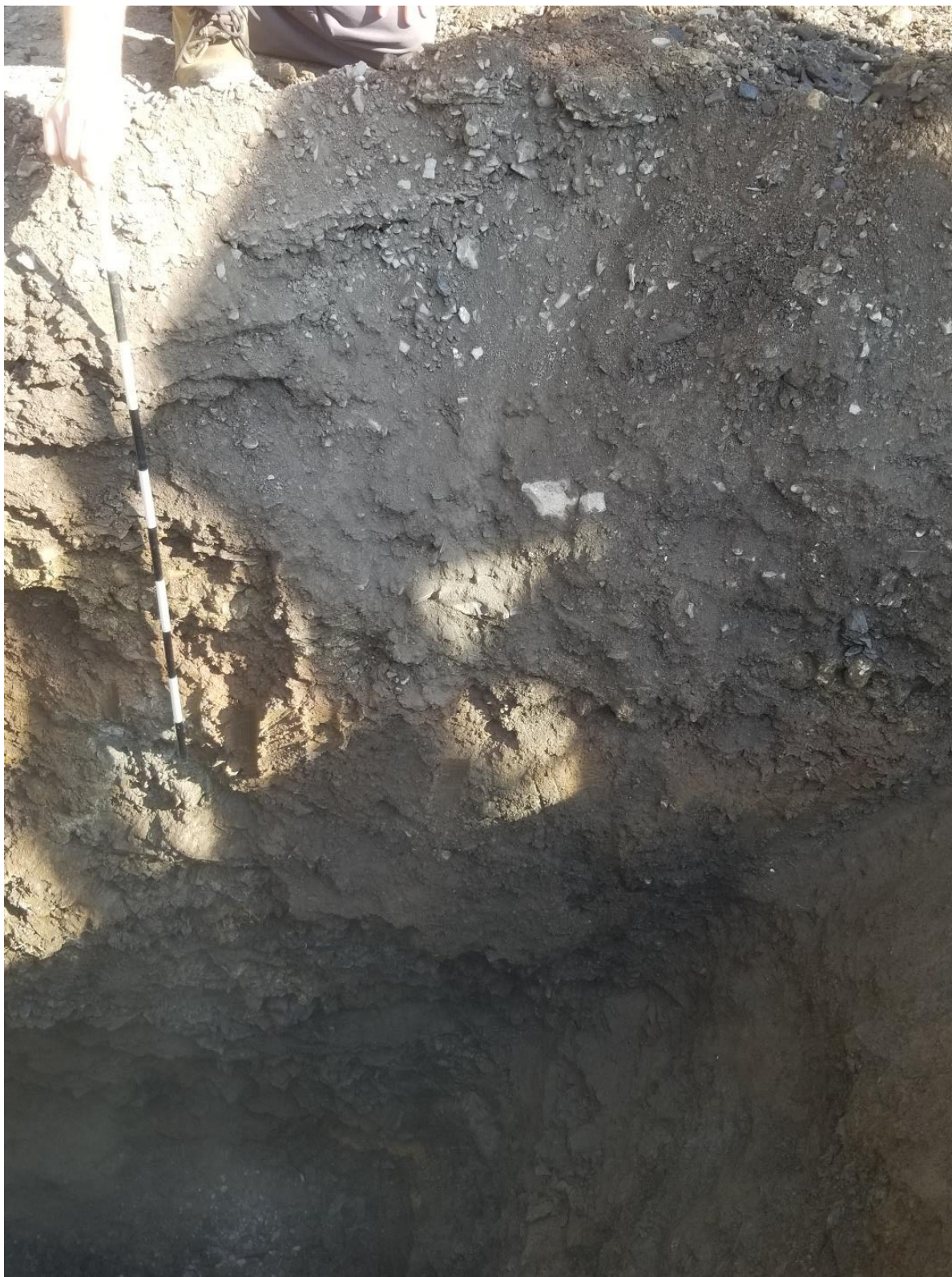
Photo 1 : Paroi nord de la tranchée 25B, dans laquelle la surface du roc sain n'a pas été atteinte à 3,00 m de profondeur.
