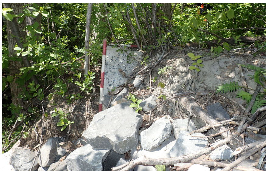
Photo 4.18 Parc Couvrette (LVL23-22), profil de la fondation de béton qui devait soutenir le mur sud-est (photo PATR23N04_0139).
