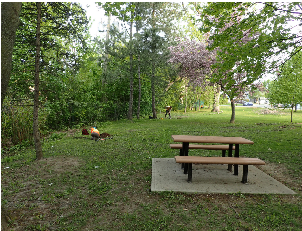
Photo 4.6 Berge Couvrette (LVL23-22), excavation en cours des sondages dans la portion nord-ouest de la berge Couvrette (photo PATR23N04_0164).
