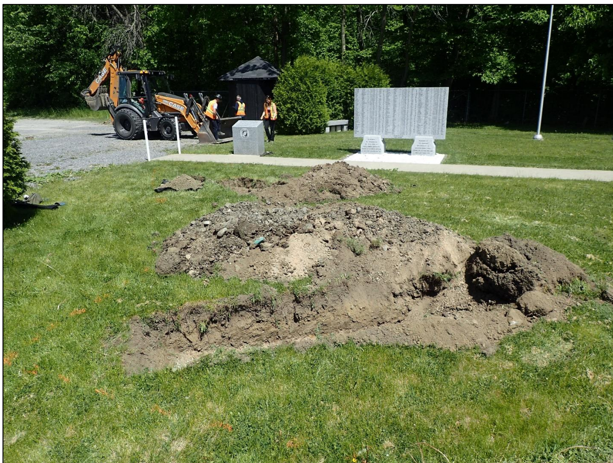
Figure 4 : Vue du parc des Vétérans (secteur 1) et des tranchées 1 et 2 (vue vers le nord; photo 4925).
