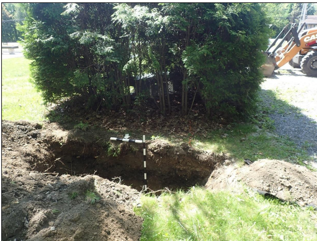
Figure 9 : Vue de la tranchée 3 dans le parc des Vétérans (secteur 1) (vue vers le sud; photo 4908).
