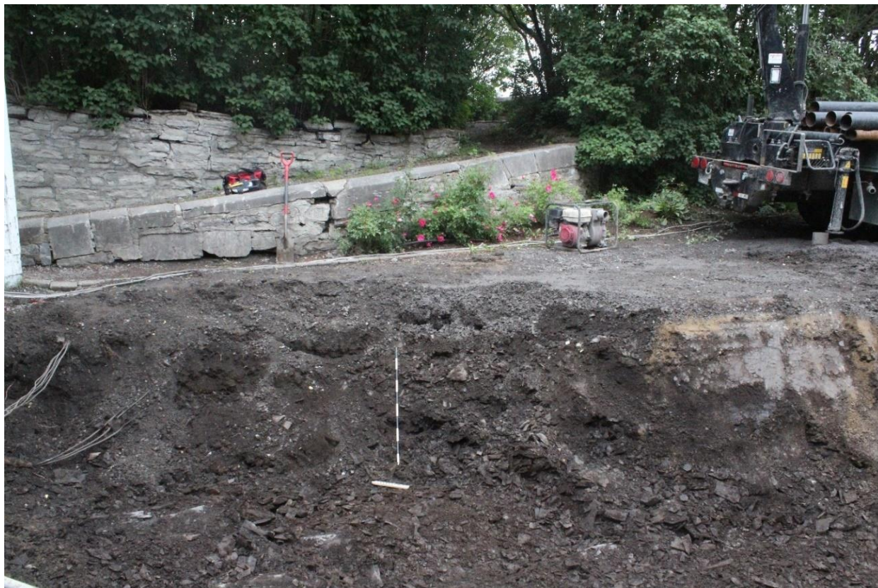
Photo 4 : Paroi est de l'excavation 26A. En arrière-plan se trouve le parc du préau, couvert de végétation. Vue vers l'est.
