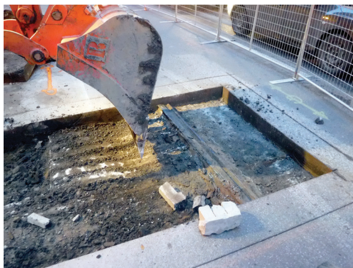
Photo 1 - Sous-opération 1A – Vestiges de la voie ferrée du tramway sous la chaussée actuelle (MTL18-25-01-N1-001)
