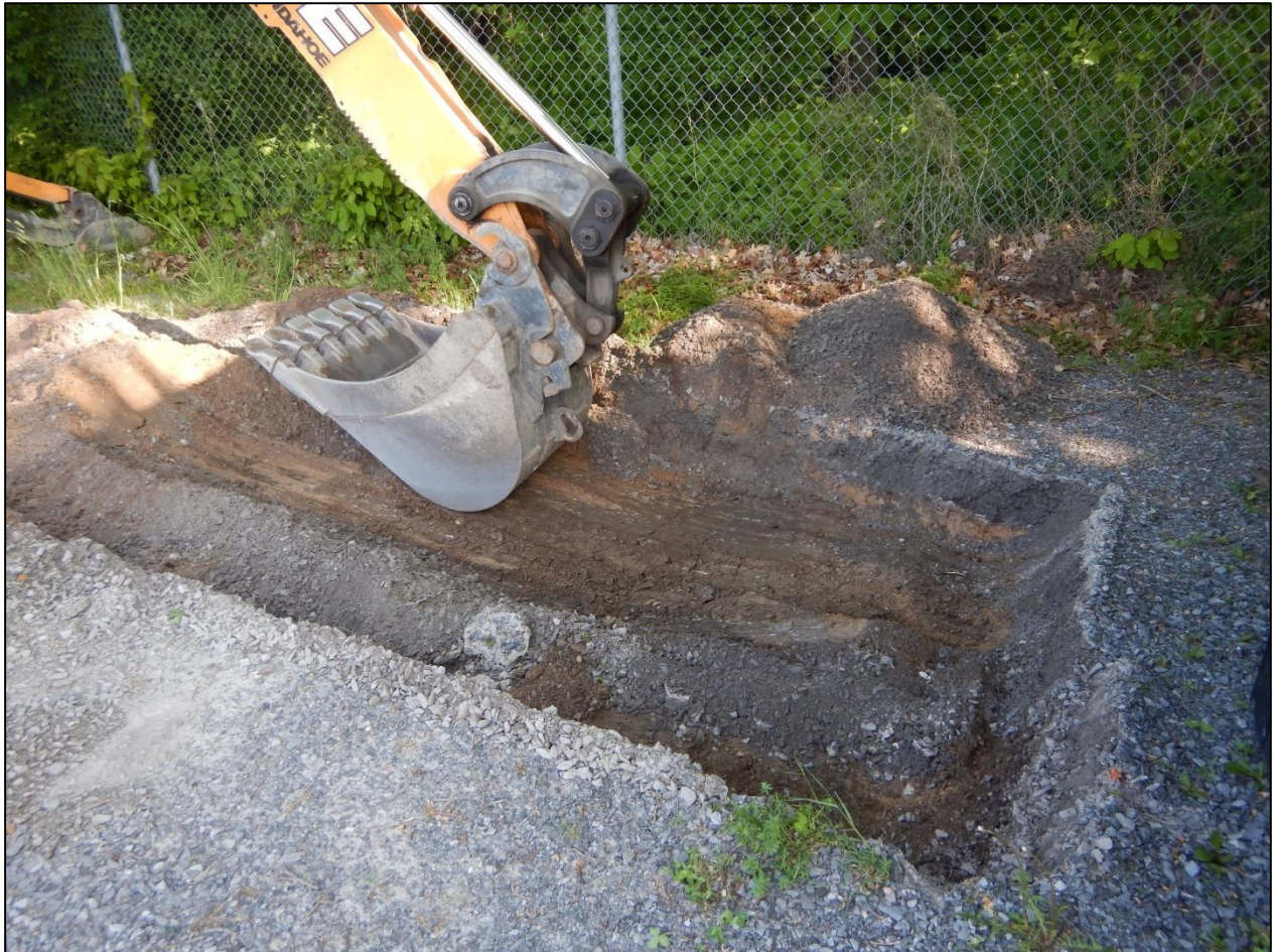
Figure 11 : Vue de la tranchée 4 en cours d'excavation, parc des Vétérans (secteur 1) (vue vers le nord; photo 3721).
