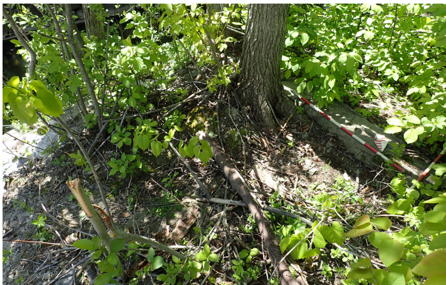
Photo 4.16 Parc Couvrette (LVL23-22), vue vers le sud d'un vestige de béton (photo PATR23N04_0142).
