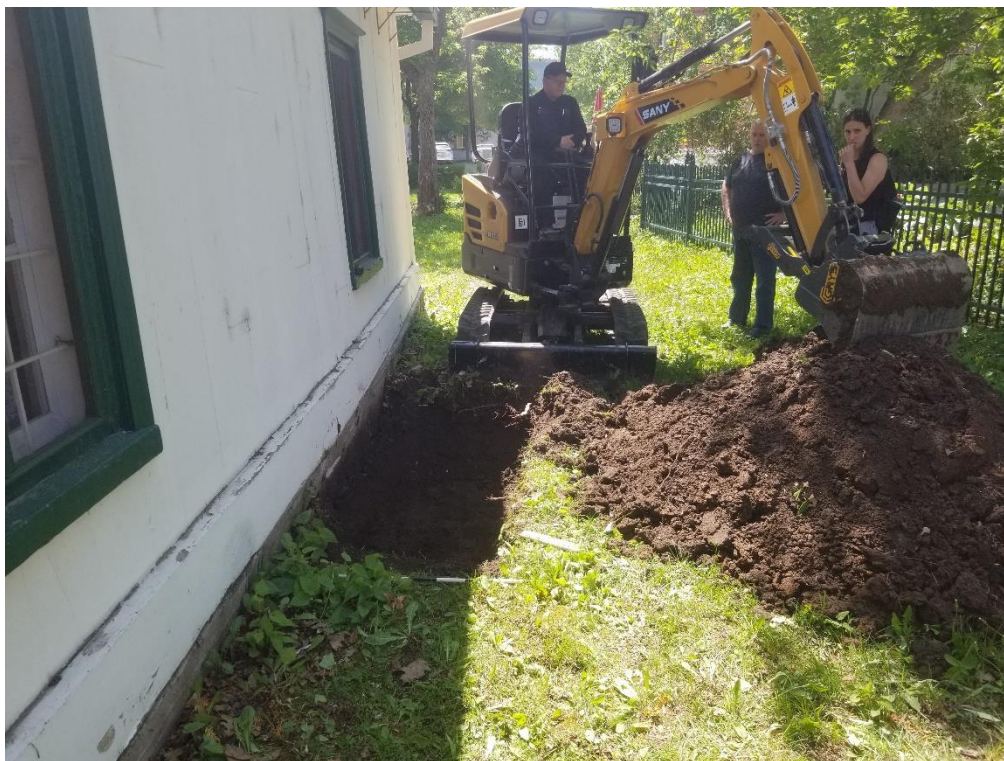
Figure 8 : Vue générale de la sous-opération CfEt-7-16A en fin d'excavation. Vue vers l'ouest. CfEt-7-16-014
