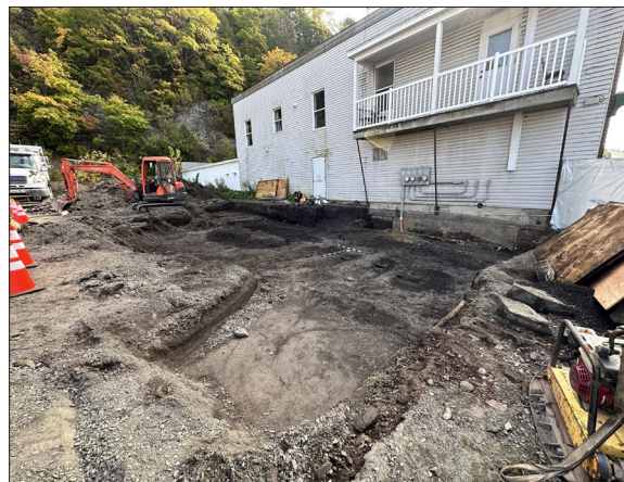
Figure 3.10. Vue générale de la sous-opération 3B. Vers le sud-est, CeEt-981-2023-N2-073
