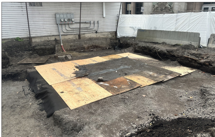
Figure 3.47 : Vue générale des mesures de protection visant à protéger les sépultures en place. Vers le sud-ouest, CeEt-981-2023-N2-157
