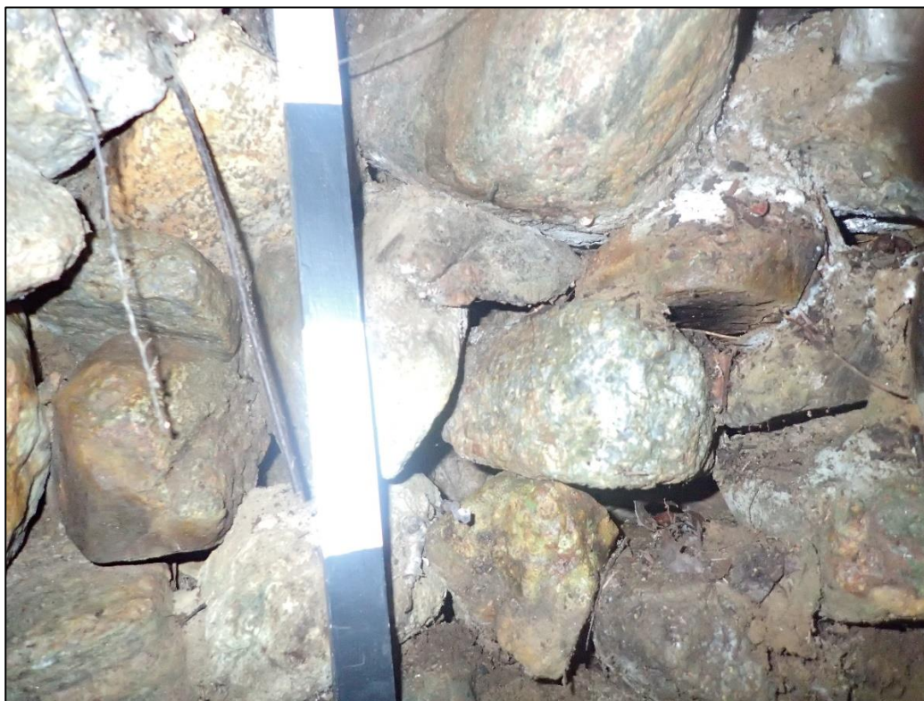
Figure 25 : Vue d'une partie de l'intérieur de la structure de maçonnerie sèche de la structure circulaire 4A100 (photo 5067; vue vers l'ouest).
