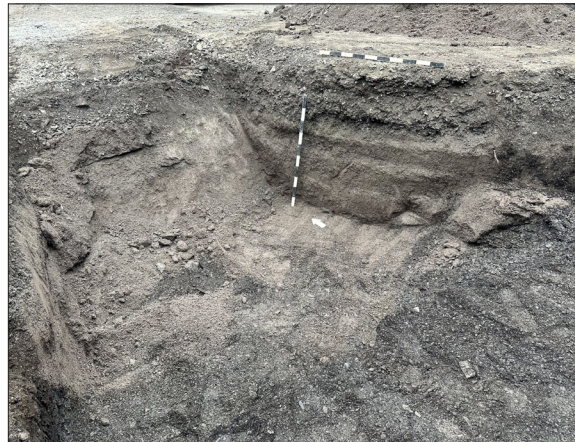
Figure 3.24 : Vue générale de la tranchée de décontamination (2016) dans la portion nord de la sous-opération 3B en cours d'excavation. Vers le nord-est, CeEt-981-2023-N2-028
