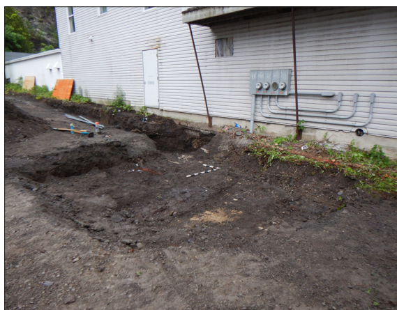
Figure 3.7 : Vue générale de la tranchée mécanique 1B. Vers le sud-est, CeEt-981-2023-N1-008
