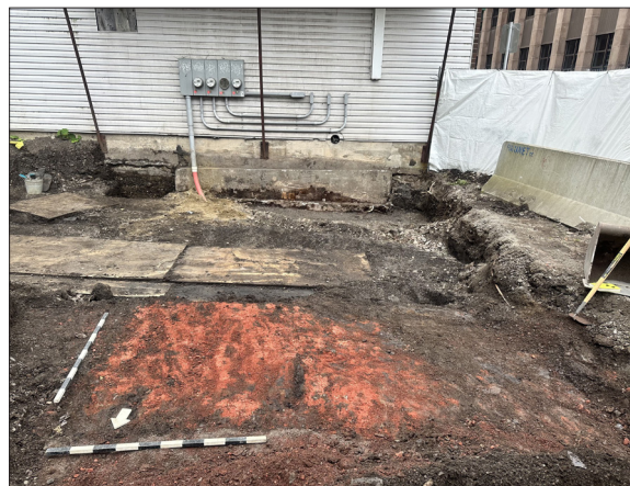
Figure 3.23 : Vue générale de la sous-opération 3A, fin de l'excavation. Vers le sud, CeEt-981-2023-N2-022
