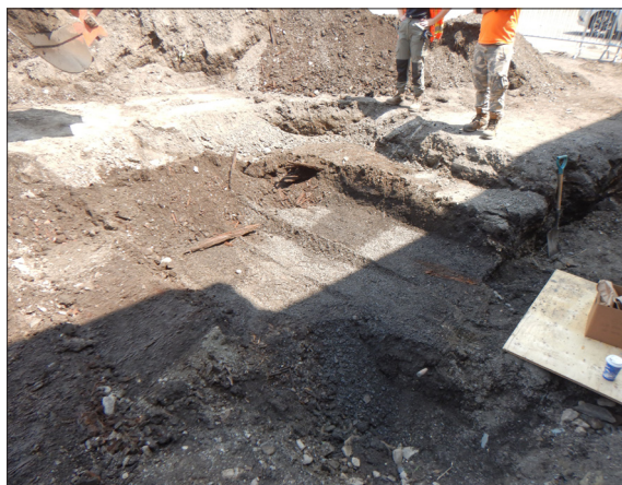
Figure 3.40 : Vue générale de la préparation de la surface au nord de 1B-S1 pour permettre la fouille de la sépulture (future sous-opération 1C). Vers le nord-est, CeEt-981-2023-N1-089
