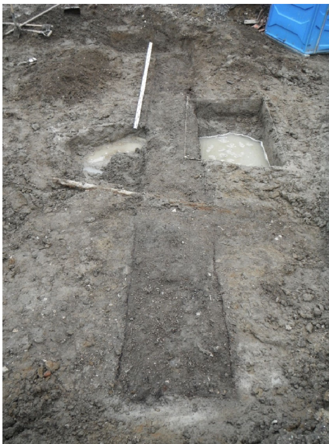
Photo 16. Drain 2N25 bordé des sondages 2J et 2K, vue vers le sud (VDQ2018-23-NUM1-158)
