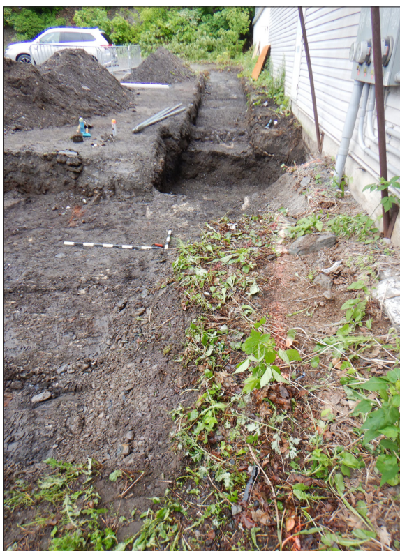
Figure 3.5 : Vue générale de la tranchée mécanique 1A. Vers l'est, CeEt-981-2023-N1-009
