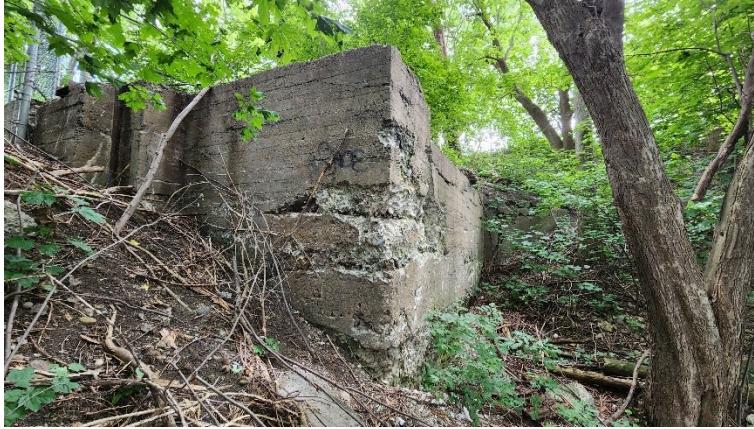
Photo 25. Le parement interne du mur 2A3 est très haut. Au sud-est, l'ouvrage entre dans le talus de la terrasse fluviale, vue vers l'est (HYD2329-23-NUM4-038)
