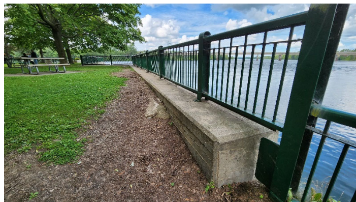
Photo 30. Un rehaussement récent de certains vestiges s'est effectué à l'aide d'une nouvelle coulée de béton moderne. Dans ce cas-ci, le mur 2A6 est partiellement rehaussé, vue vers le nord-ouest (HYD2329-23-NUM4-052)
