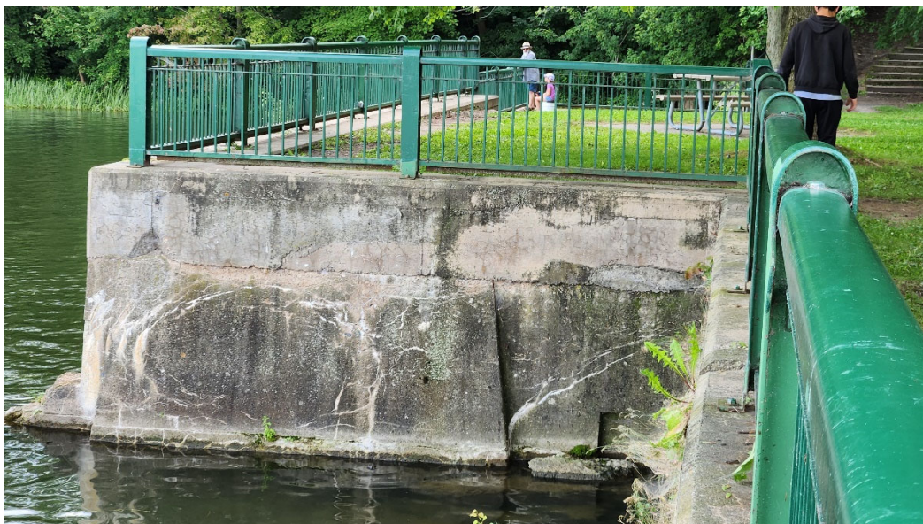
Photo 33. Le mur 2A7 est très similaire au mur 2A5 dans ses formes et sa construction. Il possède également un décrochement présentant une encoche ou une glissière, vue vers le sud-est (HYD2329-23-NUM4-049)
