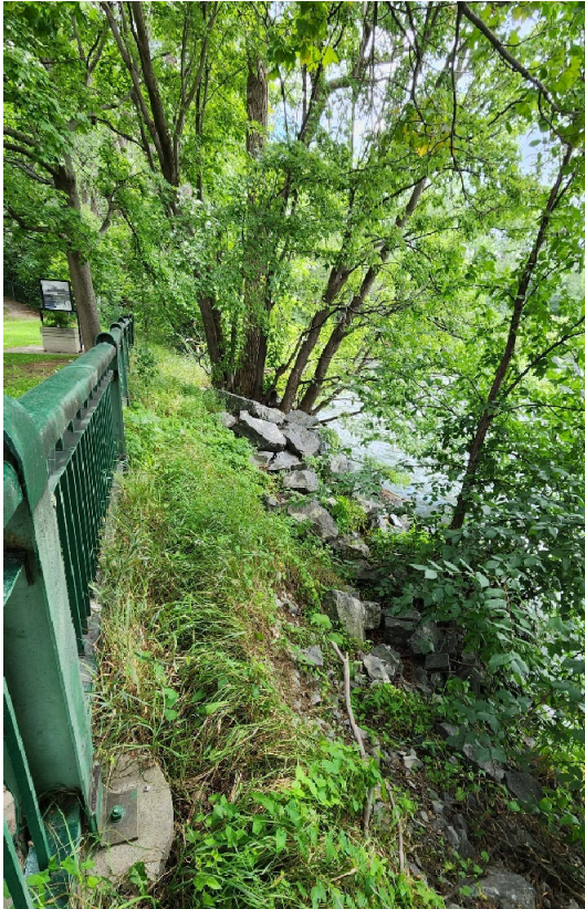
Photo 15. Talus de remblai composé de pierres et de terre bordant le radier dans l'ensemble au sud-est, vue vers le sud-est (HYD2329-23-NUM4-058)
