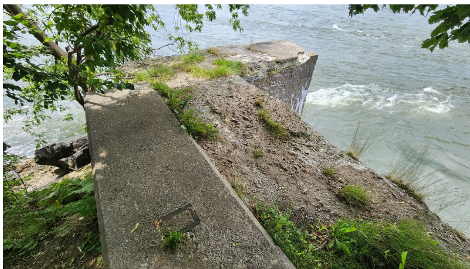
Photo 36. À la limite sud-ouest du mur 2A9, le vestige se dédouble en formant un décrochement massif. Un retour dans l'axe nord-ouest / sud-est est également présent, vue vers le sud-ouest (HYD2329-23-NUM4-056)
