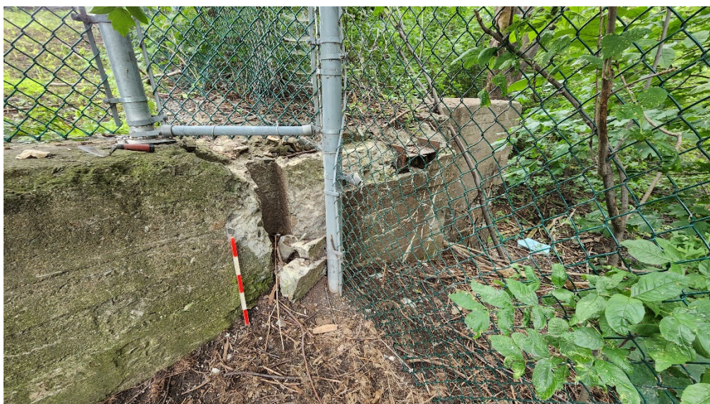
Photo 24. Le parement interne du mur 2A3 présente une entaille ou une encoche, vue vers le sud-est (HYD2329-23-NUM4-036)
