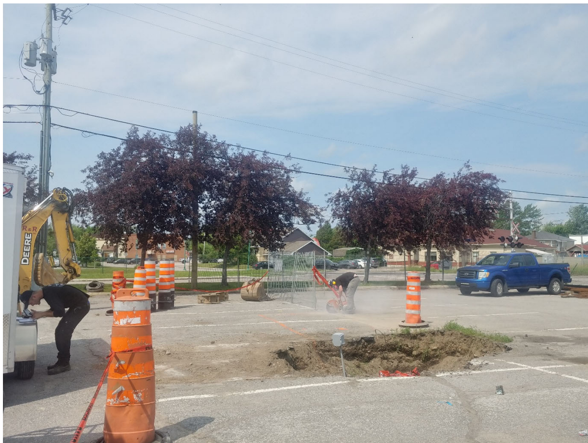
Photo 1. Vue générale de l'aire d'intervention à Roberval vers le nord-ouest (HYD2329-23-NUM1-20230717_1111447)
