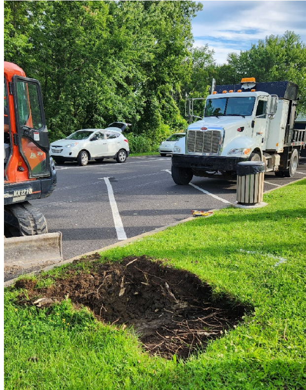
Photo 11. À l'intérieur du terre-plein de la halte routière, une petite tranchée de caractérisation a été excavée, vue vers le nord (HYD2329-23-NUM1-010)
