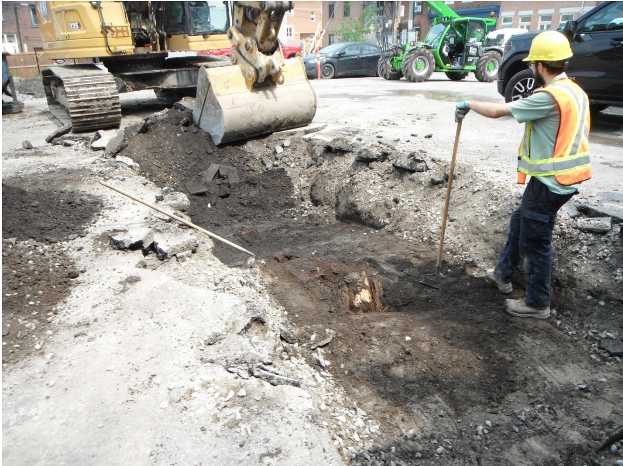
Photo 16. Excavation en cours dans la sous-opération CeEt-534 2B (CeEt-534-23-NUM1-20)
