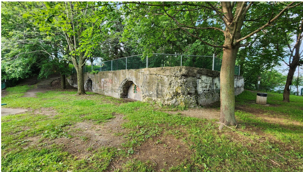
Photo 16. Une portion surélevée de l'ouvrage présente trois ouvertures ayant été bouchées, vue vers le sud (HYD2329-23-NUM4-003)
