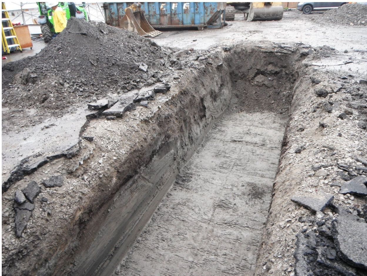
Photo 17. Fin de l'excavation (CeEt-534-23-NUM1-33)
