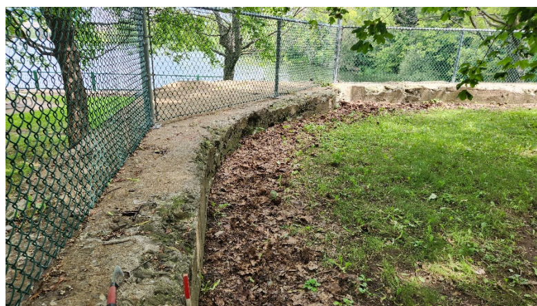
Photo 21. La jonction entre 2A1 et 2A2 montre un parement interne arrondi, vue vers le nord-est (HYD2329-23-NUM4-030)
