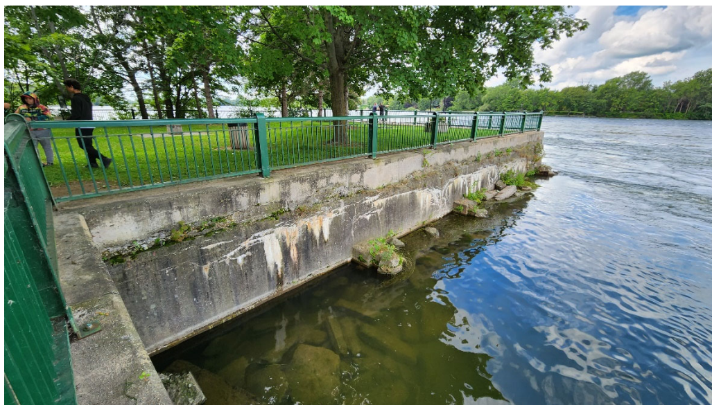
Photo 34. Le long du parement nord-est de 2A8, quatre « butées » sont présentes, lesquelles comptent aussi des éléments liés aux encoches ou glissières permettant probablement le mouvement de portes ou de vannes, vue vers l'ouest (HYD2329-23-NUM4-051)
