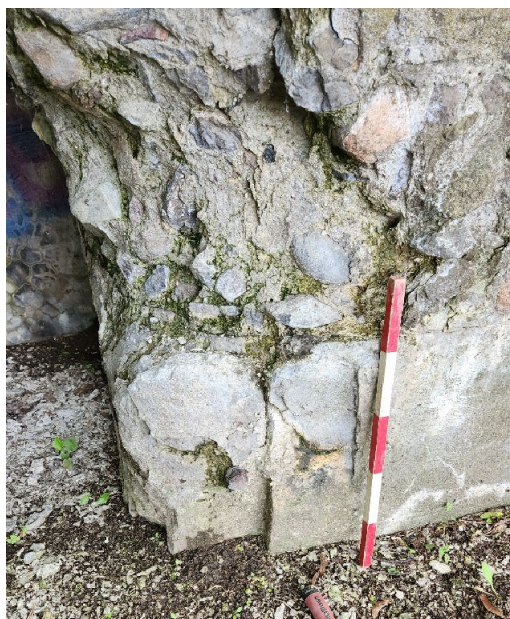
Photo 20. Le rebord des ouvertures bouchées présente un chanfrein mesurant 5 x 20 cm, vue vers le sud-ouest (HYD2329-23-NUM4-025)
