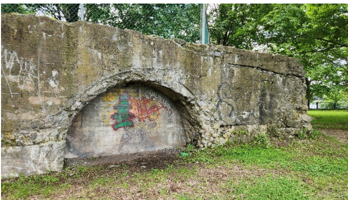
Photo 19. Au nord-ouest de la dernière ouverture, le mur ne présente pas de parement; un segment semble avoir été arraché, vue vers le sud-ouest (HYD2329-23-NUM4-042)
