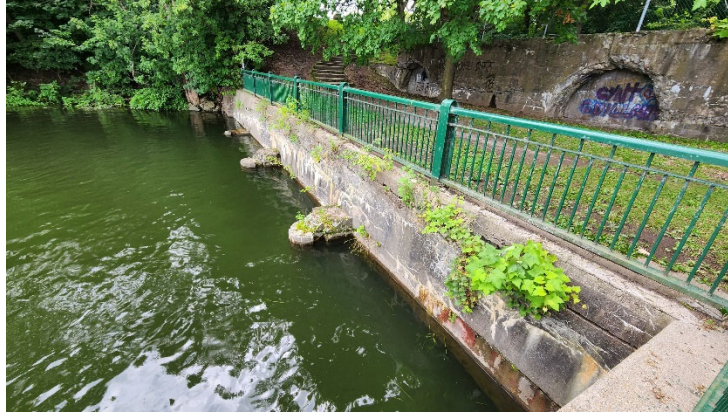
Photo 28. Trois « butées » de béton sont présentes le long du parement externe du mur 2A4. Leurs fonctions exactes n'ont pu être déterminées, vue vers le sud-est (HYD2329-23-NUM4-043).
