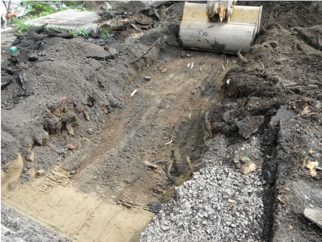
Photo 8. La sous-opération CeEt-534 2A en cours d'excavation, vue vers le nord-est (CeEt-534-23-NUM1-02)
