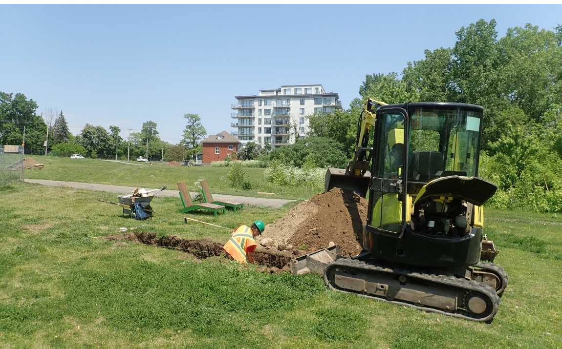
Photo 4.9 Travail d'excavation dans la sous-opération 2A, vue vers le nord-est ( PATR23N08_0251).
