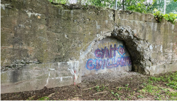
Photo 17. Le béton effrité montre plusieurs « moellons » subarrondis, vue vers l'ouest (HYD2329-23-NUM4-024)
