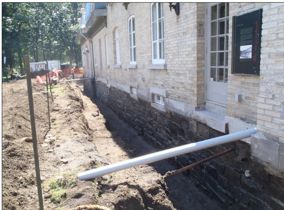
Photo 12. Mur de fondation est du corps central des anciennes écuries, vers le sud-ouest (TCI-CeEt-806-2023-036)
