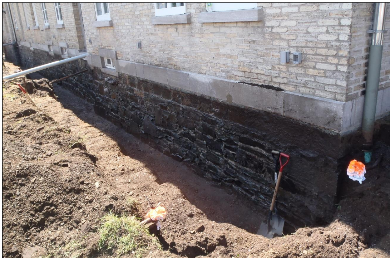
Photo 15. Vue d'ensemble du mur de fondation est de l'aile nord des anciennes écuries, vers le sud-ouest (TCI-CeEt-806-2023-038)
