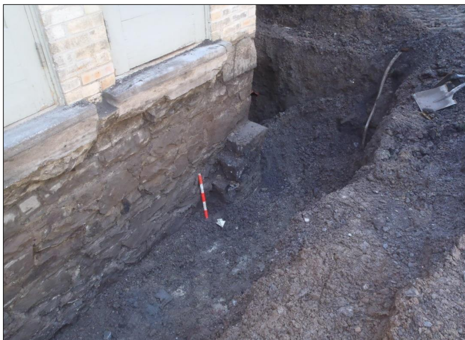
Photo 25. Assises inférieures du mur de fondation ouest de l'aile nord des anciennes écuries, près de l'angle sud-ouest du bâtiment, vers le sud-est (TCI-CeEt-806-2023-078)
