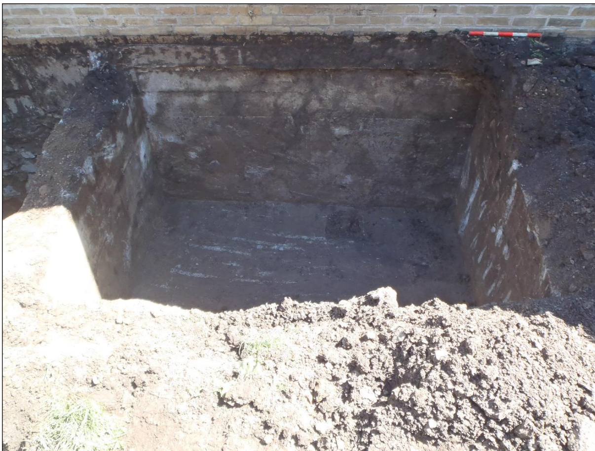
Photo 29. Possible entrée de cave en béton relevée dans le mur de fondation ouest du corps central des anciennes écuries, vers le sud-est (TCI-CeEt-2023-091)
