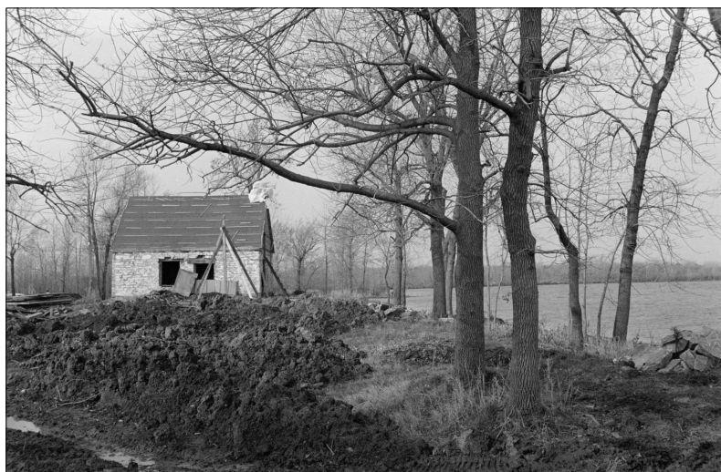
Photo 5.1 Restauration de la maison du meunier en 1977 (Langevin). On remarque la présence de nombreux tas de terre et des pierres en bordure de la rive.
