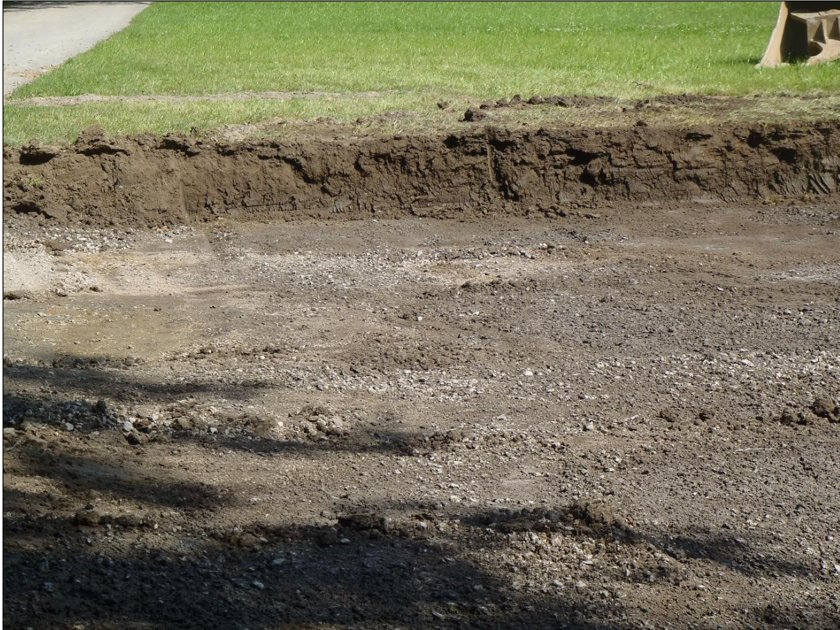
Photo 51. Paroi est de la sous-opération CeEt-806-28B, vers l'est (TCI-CeEt-806-2023-168)
