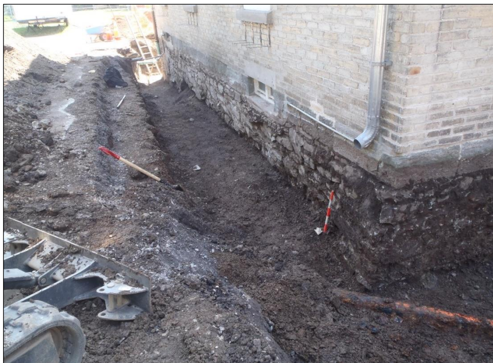
Photo 17. Vue d'ensemble du mur de fondation nord des anciennes écuries, vers le sud-est (TCI-CeEt-806-2023-050)
