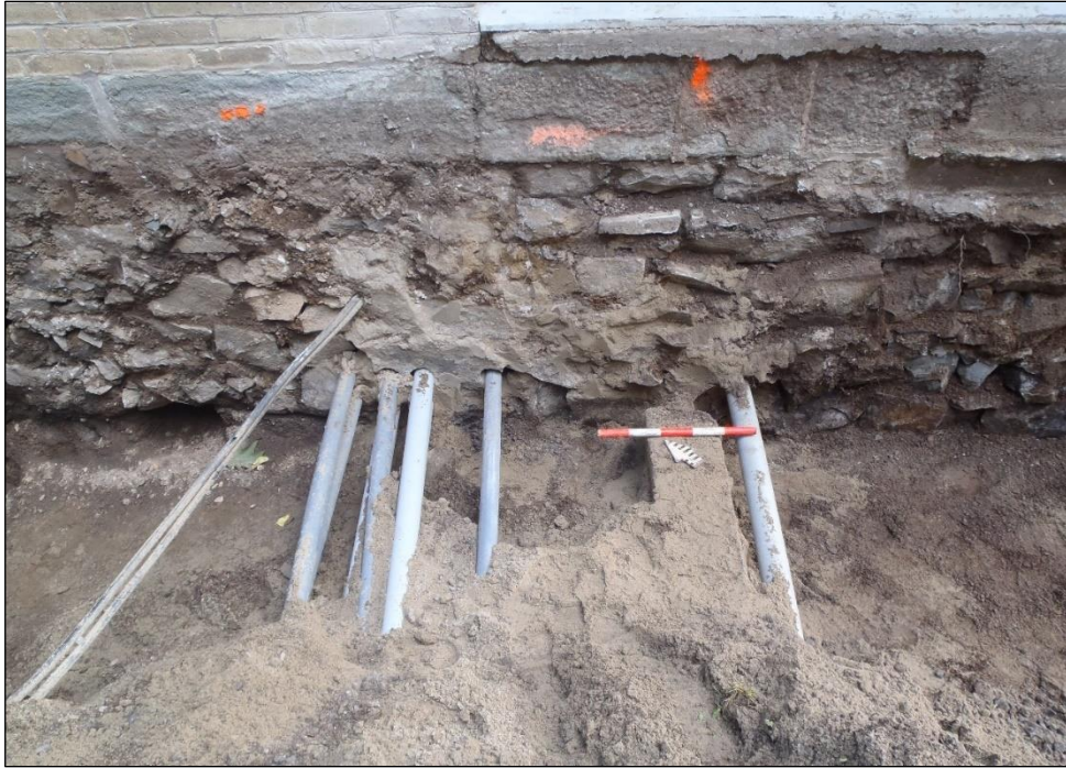
Photo 6. Conduits en PVC et massif bétonné présents dans le mur de fondation sud des anciennes écuries, vers le nord-nord-est (TCI-CeEt-806-2023-021)
