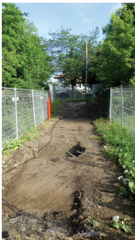
Photo 3 - Sous-opération 1D — Tranchée d'excavation mécanique 1D avant l'implantation de sondages manuels — Vue vers le nord (LVL23-07-N1-006)
