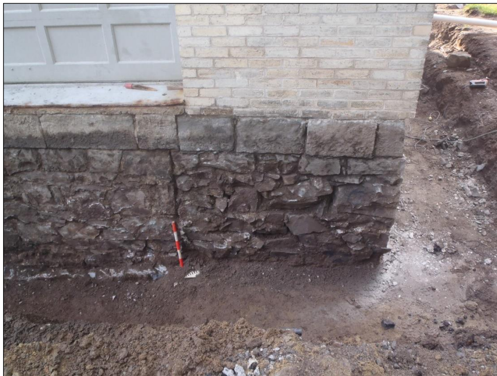
Photo 33. Limite sud du mur de fondation ouest de l'aile sud des anciennes écuries, vers le sud-est (TCI-CeEt-806-2023-099)
