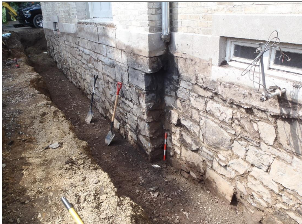
Photo 11. Détail du mur de fondation est des anciennes écuries, à la jonction de l'aile sud et du corps central du bâtiment, vers le sud-ouest (TCI-CeEt-806-2023-028)
