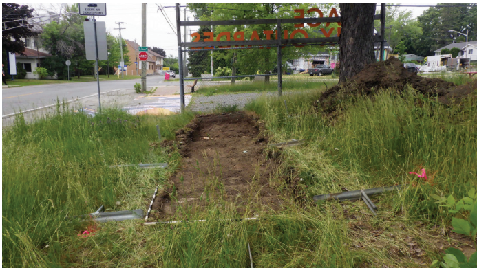
Photo 7 - Sous-opération 1F — Tranchée d'excavation mécanique 1F avant l'implantation de sondages manuels — Vue vers l'ouest (LVL23-07-N1-005)
