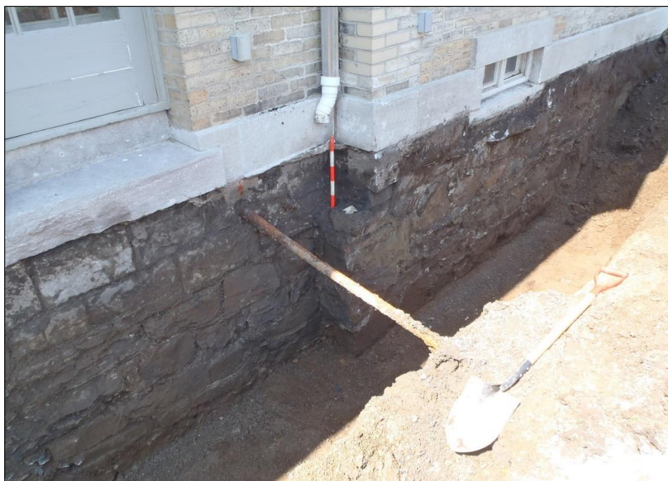
Photo 14. Détail du mur de fondation est des anciennes écuries, à la jonction du corps central et de l'aile nord, vers le nord-ouest (TCI-CeEt-806-2023-034)
