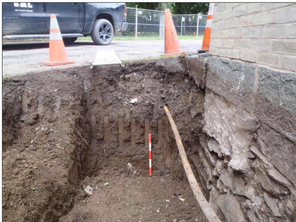
Photo 2. Paroi nord de la sous-opération 25A, vers le nord-ouest (TCI-CeEt-806-2023-010)
