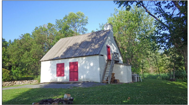
Photo 3.1 La maison du meunier telle qu'elle apparaît aujourd'hui après sa restauration Archéotec 2019, PMF19_VV1_148
