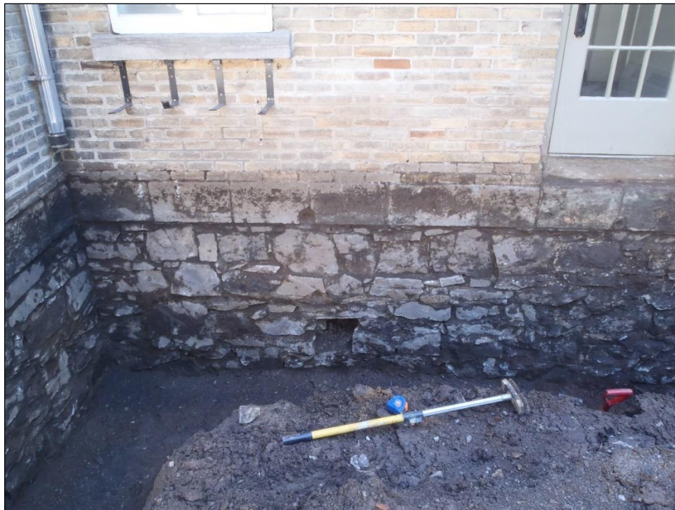
Photo 27. Portion nord du mur de fondation ouest du corps central des anciennes écuries, vers le sud-est (TCI-CeEt-806-2023-083)
