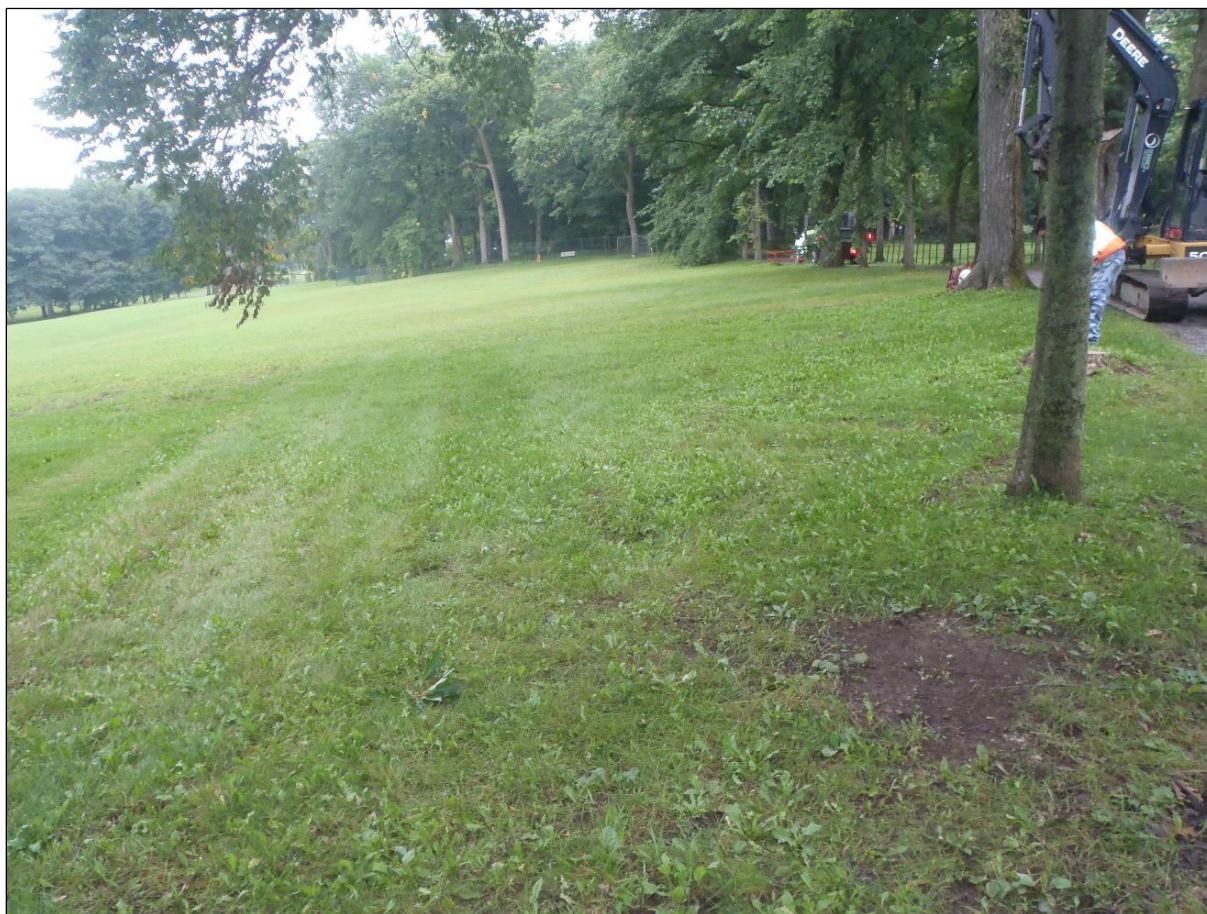
Photo 36. Vue d'ensemble de la zone de plantation d'arbres nord-est (sous-opérations CeEt-806-26W à 26RR), vers l'ouest (TCI-CeEt-806-2023-129)
