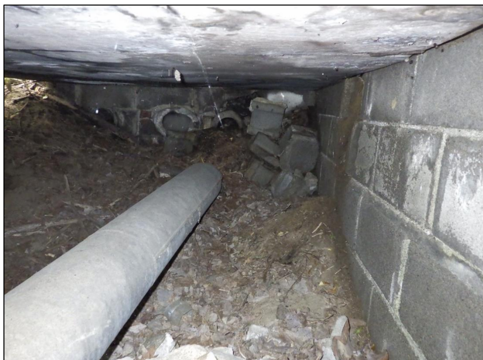
Photo 23. Vue de l'intérieur de la structure de béton, vers le nord (TCI-MTQ-BAT-23-143). À noter la présence d'une conduite traversant la structure.
