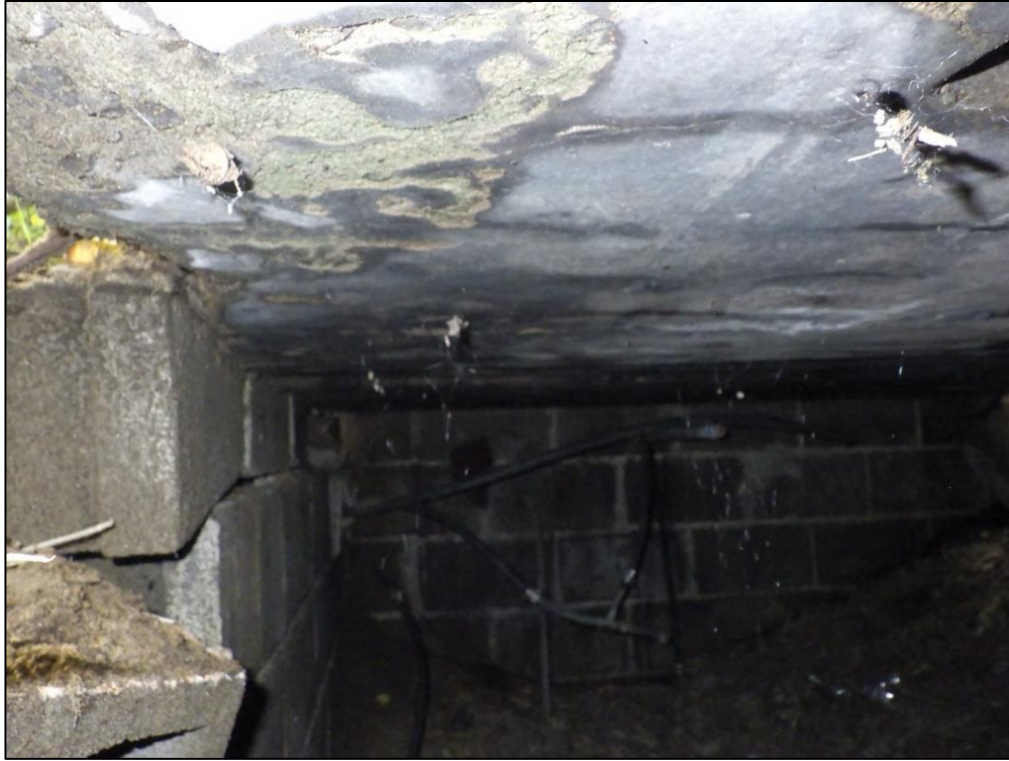
Photo 24. Vue de l'intérieur de la structure de béton, vers l'ouest (TCI-MTQ-BAT-23-141). À noter la présence de plusieurs tuyaux en plastique dans le coin sud-ouest de la chambre.
