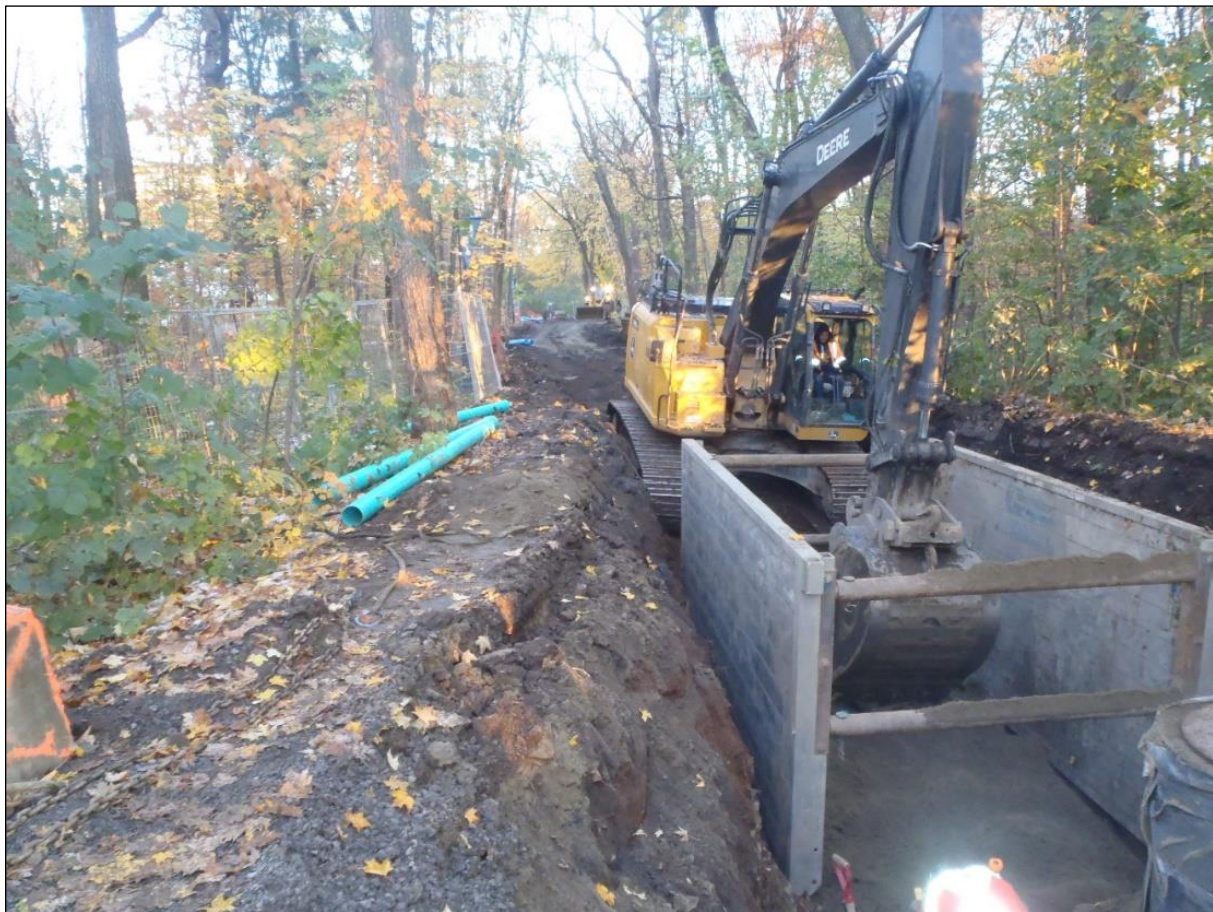
Photo 65. Vue d'ensemble de la sous-opération CeEt-806-29E, vers le nord (TCI-CeEt-806-2023-297)
