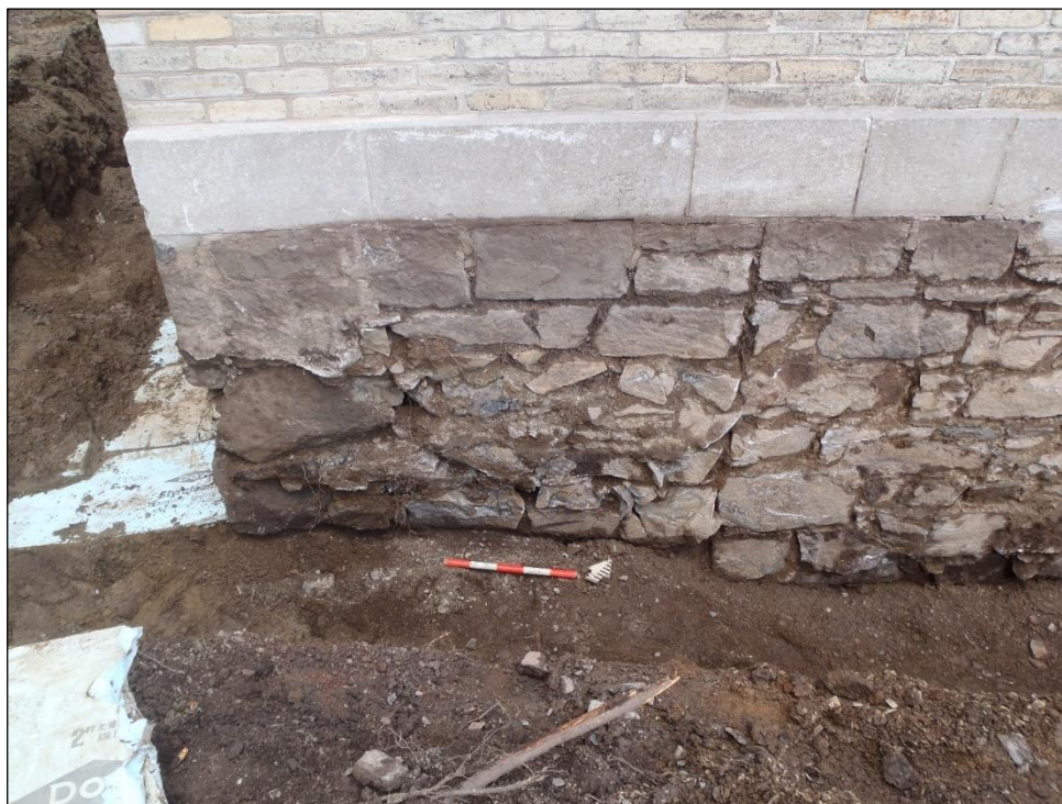
Photo 10. Joint vertical visible sur le mur de fondation est de l'aile sud des anciennes écuries, vers l'ouest (TCI-CeEt-806-2023-023)
