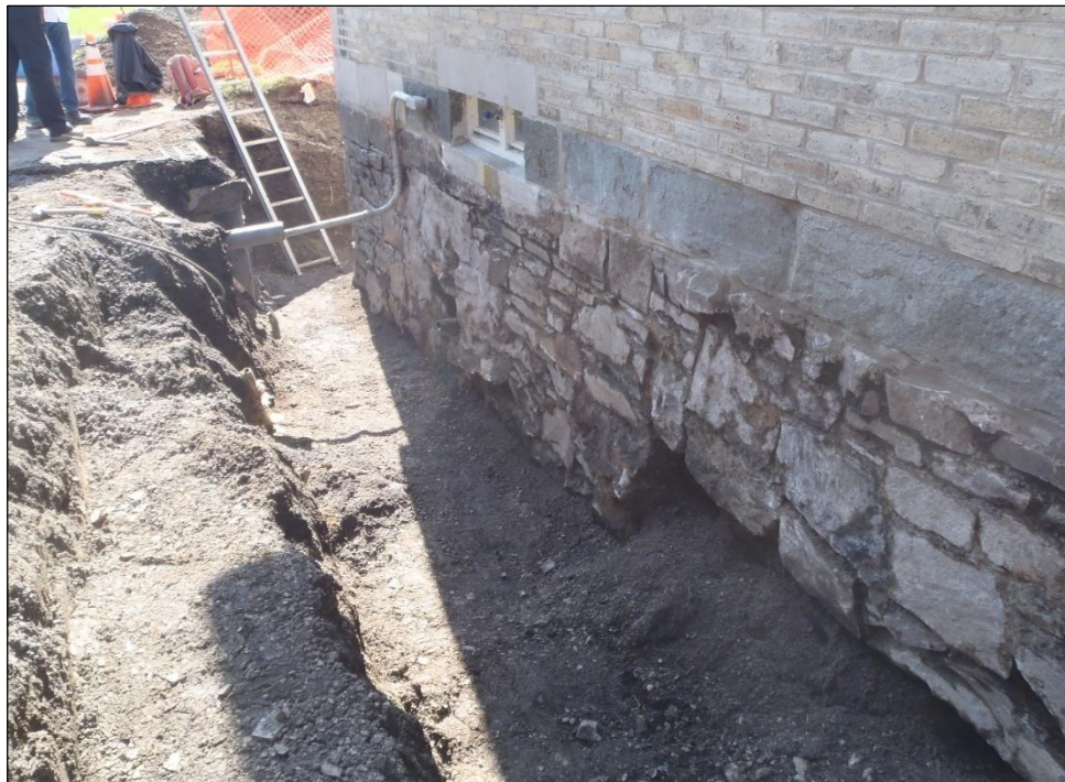
Photo 20. Différence de hauteur des portions est et ouest de la base du mur de fondation nord des anciennes écuries, vers le sud-ouest (TCI-CeEt-806-2023-045)
