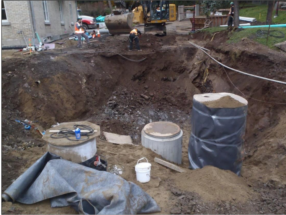
Photo 63. Vue d'ensemble de la sous-opération CeEt-806-29D, vers l'ouest (TCI-CeEt-806-2023-261)
