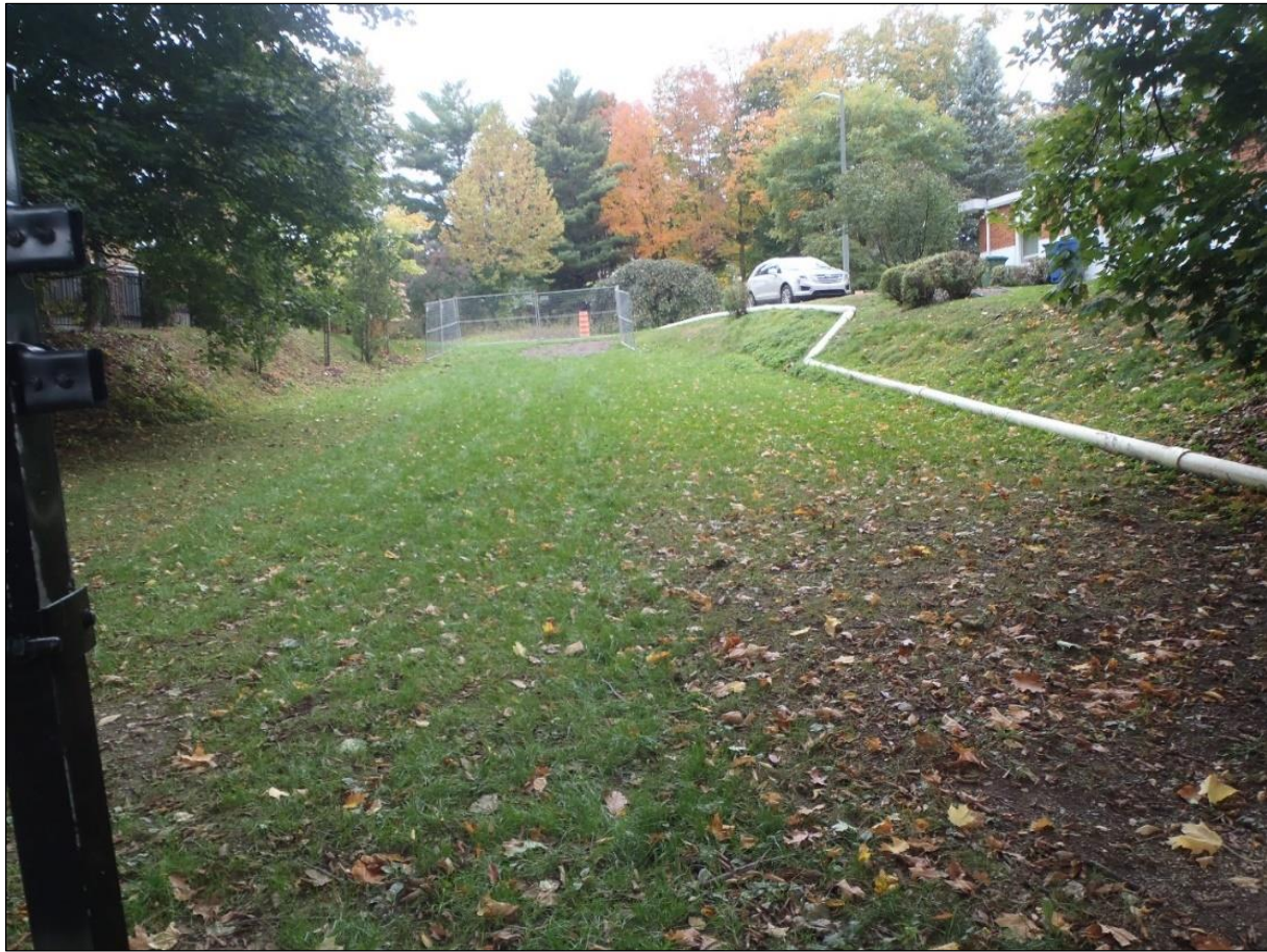
Photo 61. Vue d'ensemble de la sous-opération CeEt-806-29C, vers l'ouest (TCI-CeEt-806-2023-254)
