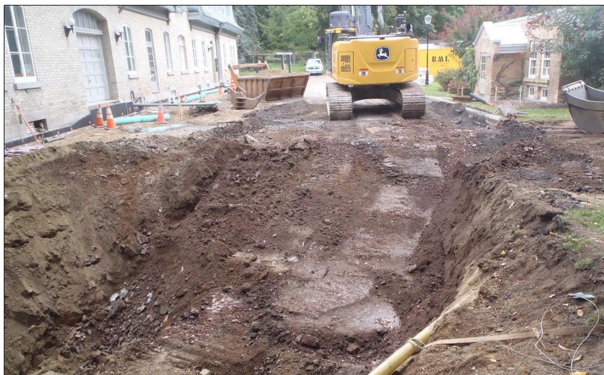
Photo 56. Vue d'ensemble de la sous-opération CeEt-806-29B, vers le nord (TCI-CeEt-806-2023-235)
