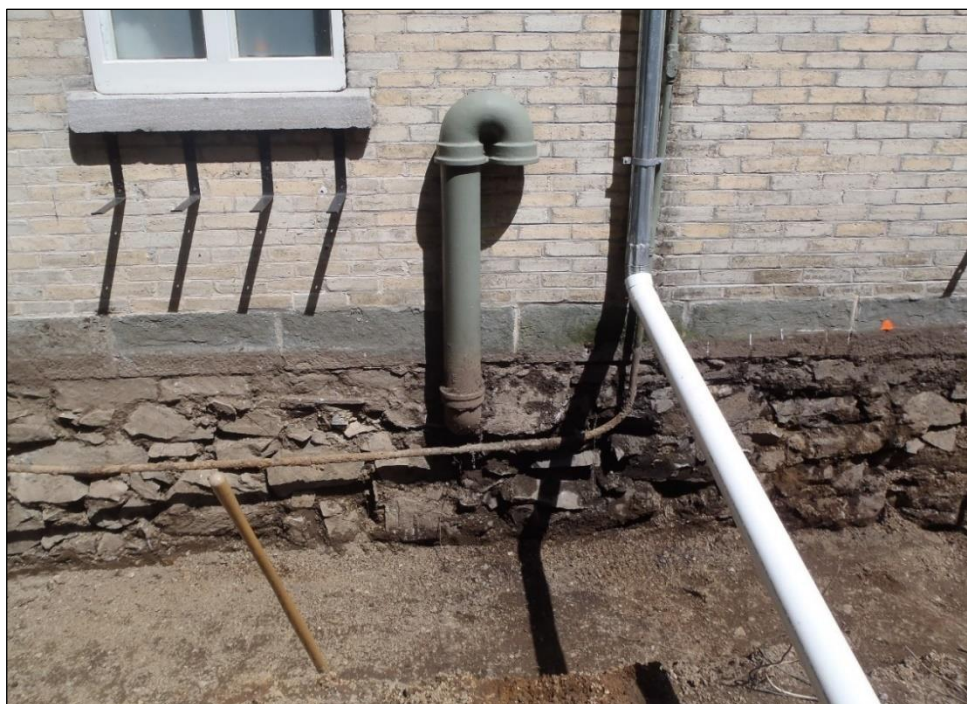
Photo 4. Conduit d'aération visible dans le mur de fondation sud des anciennes écuries, vers le nord-nord-est (TCI-CeEt-806-2023-015)
