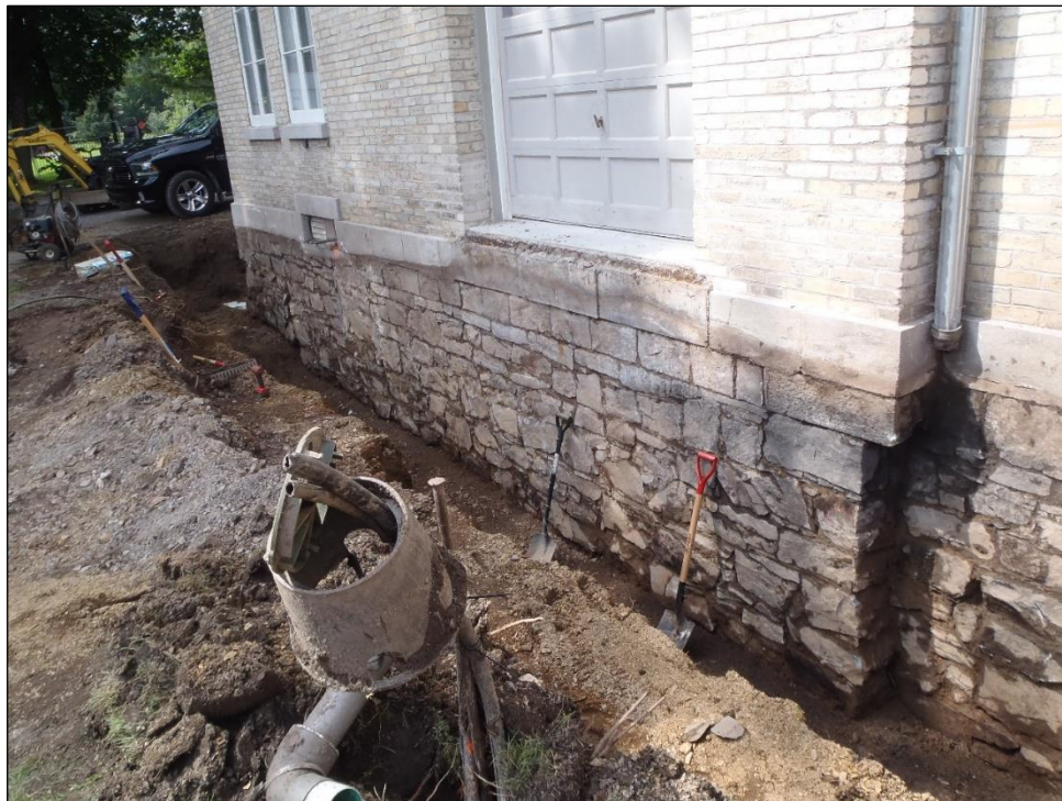
Photo 9. Vue d'ensemble du mur de fondation est de l'aile sud des anciennes écuries, vers le sud-ouest (TCI-CeEt-806-2023-026)
