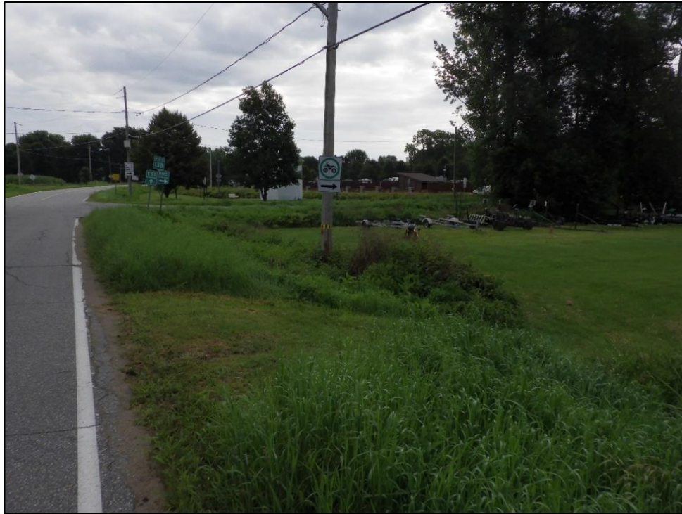
Photo 1. Vue générale de la zone 1, à l'intersection du rang Nord et de la route 138, vers l'est (TCI-MTQ-BAT-23-003)
