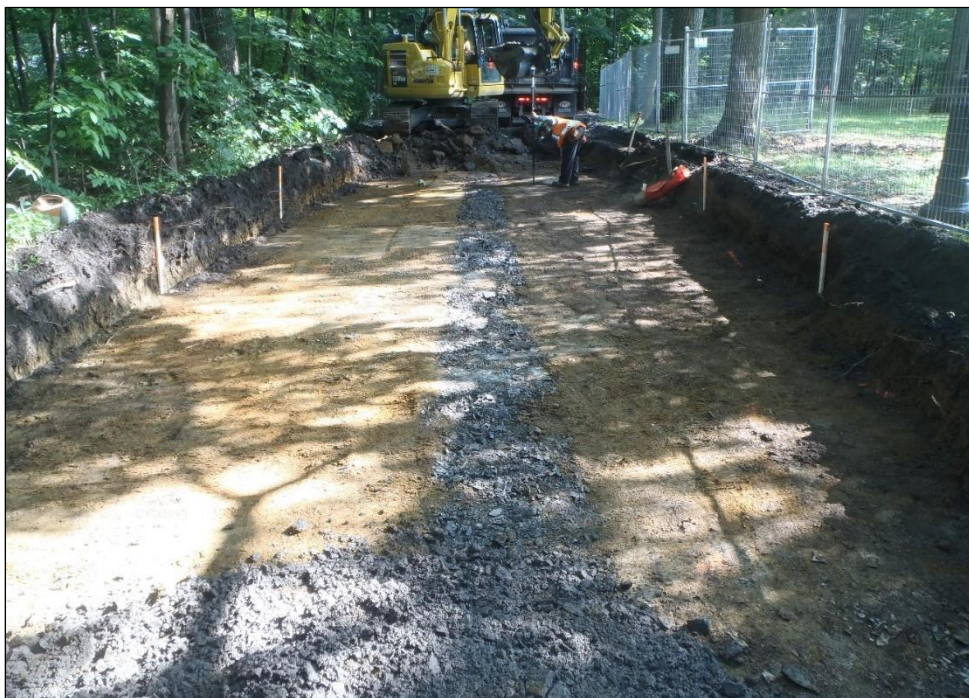
Photo 49. Tranchée de mise en place d'un égout pluvial au centre de la portion nord de l'allée du Comte-d'Elgin comblée au moyen d'un remblai d'éclats de schiste, vers l'est (TCI-CeEt-806-2023-206)
