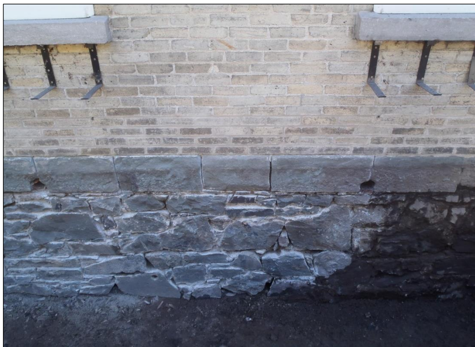
Photo 24. Ouvertures présentes à la base de l'assise supérieure du mur de fondation ouest de l'aile nord des anciennes écuries, vers l'est (TCI-CeEt-806-2023-080)
