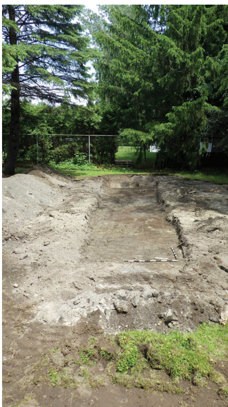
Photo 9 - Sous-opération 1A — Tranchée d'excavation mécanique 1A avant l'implantation de sondages manuels — Vue vers l'est (BkFj-18-23-N1-021)
