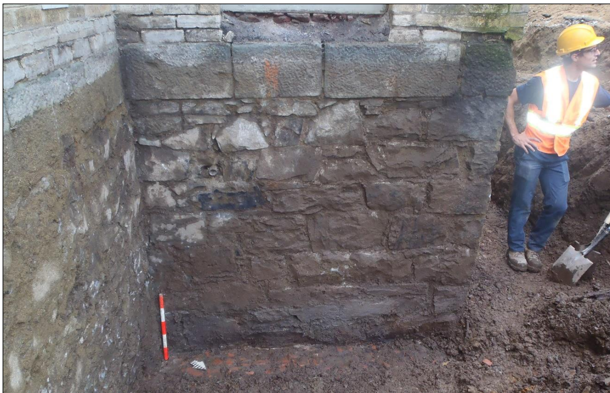
Photo 31. Mur de fondation nord de l'aile sud des anciennes écuries, vers le sud-ouest (TCI-CeEt-806-2023-110)
