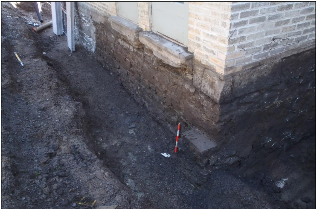
Photo 23. Vue d'ensemble du mur de fondation ouest de l'aile nord des anciennes écuries, vers le nord-est (TCI-CeEt-806-2023-077)
