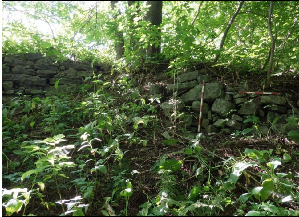
Photo 5. Parement nord du mur de soutènement d'un ancien chemin menant vers la maison. Ce chemin rejoignait la rampe d'accès au pont visible sur la gauche de la photo, vers le sud (TCI-MTQ-BAT-23-057)
