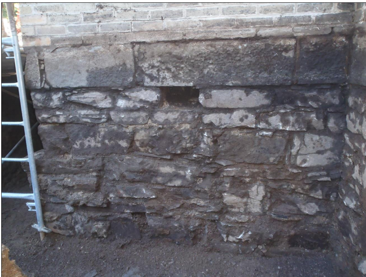
Photo 26. Mur de fondation sud de l'aile nord des anciennes écuries, vers le nord-est (TCI-CeEt-806-2023-081)
