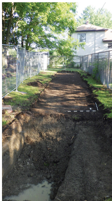
Photo 10 - Sous-opération 1C — Tranchée d'excavation mécanique 1C avant l'implantation de sondages manuels — Vue vers le nord (BkFj-18-23-N1-012)
