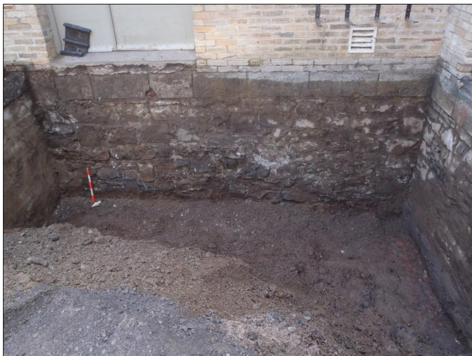
Photo 28. Portion sud du mur de fondation ouest du corps central des anciennes écuries, vers le sud-est (TCI-CeEt-806-2023-119)
