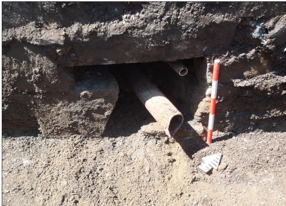
Photo 13. Détail de l'ouverture présente à la base du mur de fondation est du corps central des anciennes écuries, vers le nord-ouest (TCI-CeEt-806-2023-032)
