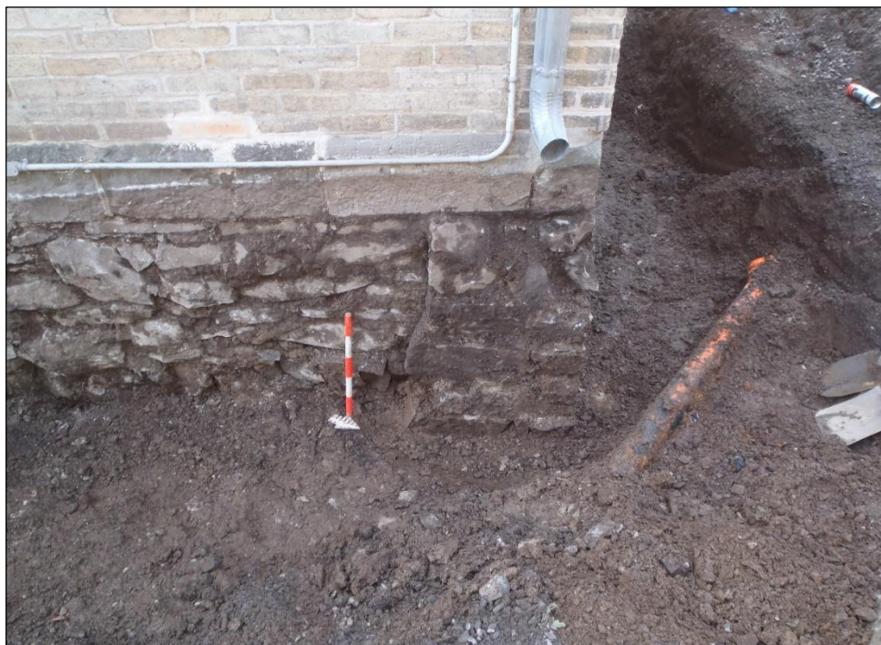
Photo 21. Extrémité ouest du mur de fondation nord des anciennes écuries, vers le sud (TCI-CeEt-806-2023-048)
