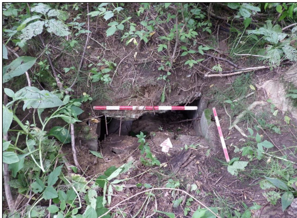
Photo 22. Ouverture de la structure de béton vue de l'extérieur, vers le nord (TCI-MTQ-BAT-23-136)
