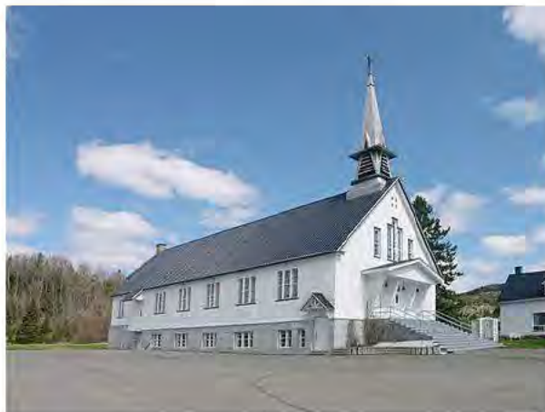
Angle façade principale et façade latérale gauche
