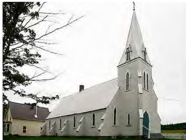
Angle façade principale et façade latérale gauche
