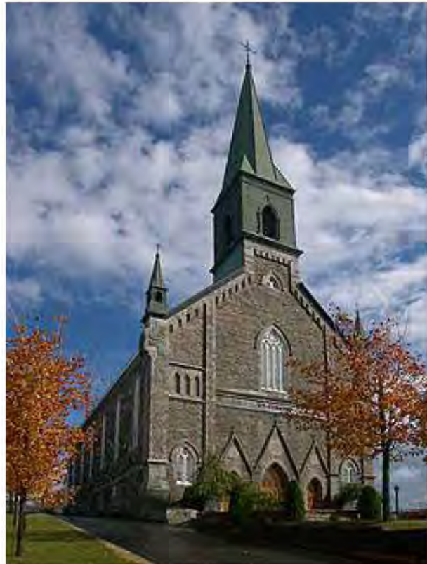
Angle façade principale et façade latérale gauche
