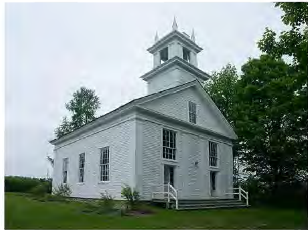
Angle façade principale et façade latérale gauche
