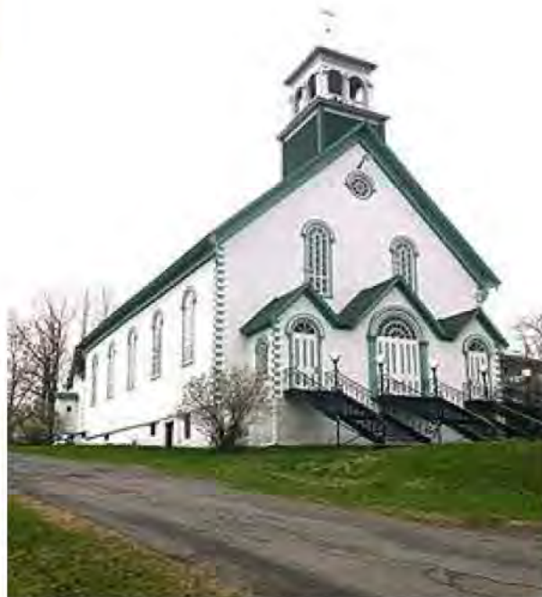
Angle façade principale et façade latérale gauche
