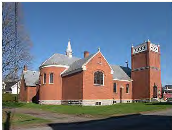
Angle façade principale et façade latérale gauche
