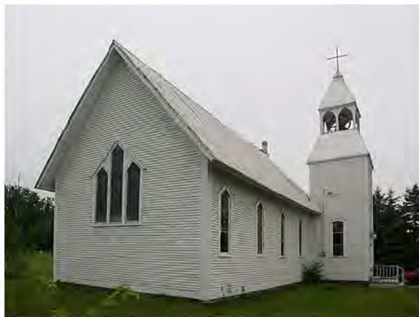
Angle façade principale et façade latérale gauche
