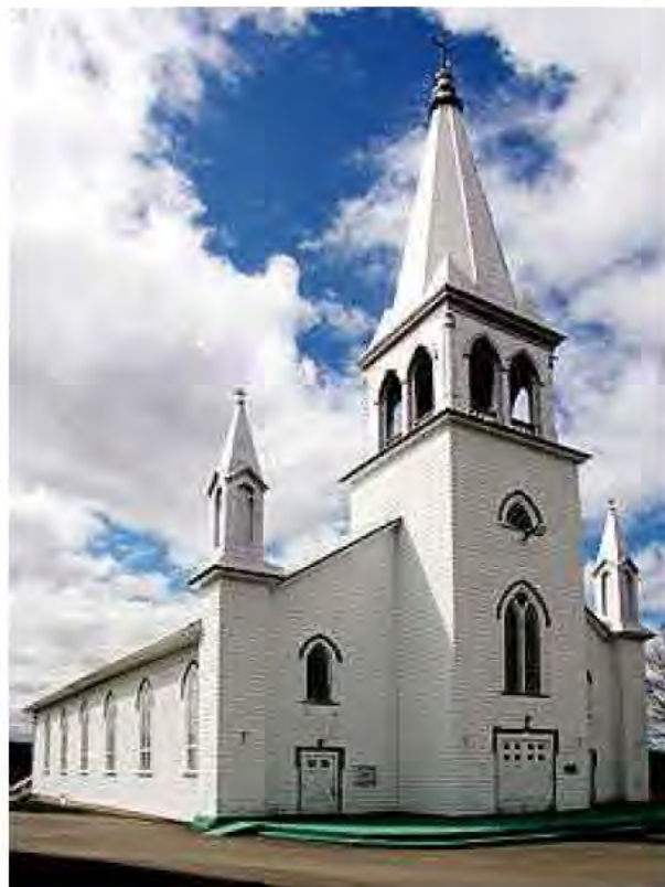
Angle façade principale et façade latérale gauche
