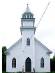
Église Way's Mills Union. Vue avant
