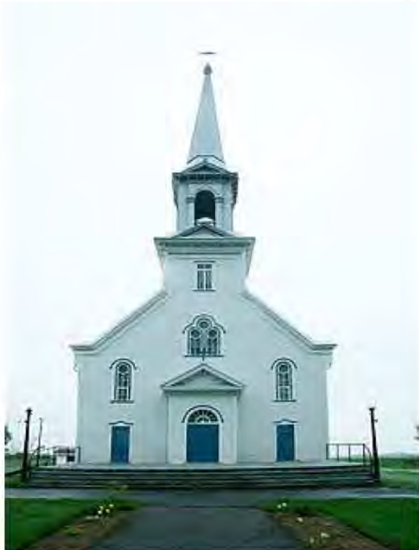
Vue frontale de la façade principale
