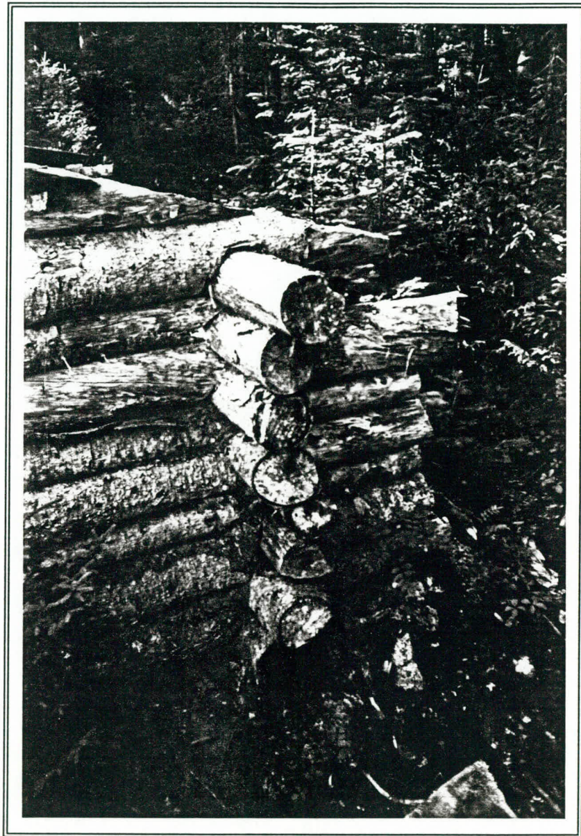
Photo 27. Détail d'assemblage du coin Nord-Ouest de la cabane (Photo 9114-11-19).
