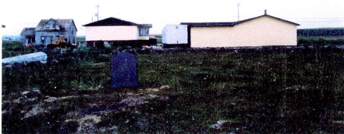
Figure 6 EiBh34: l'aire nord du site; à l'arrière du cimetière: les bâtiments de L. Hobbs (vers: est)
