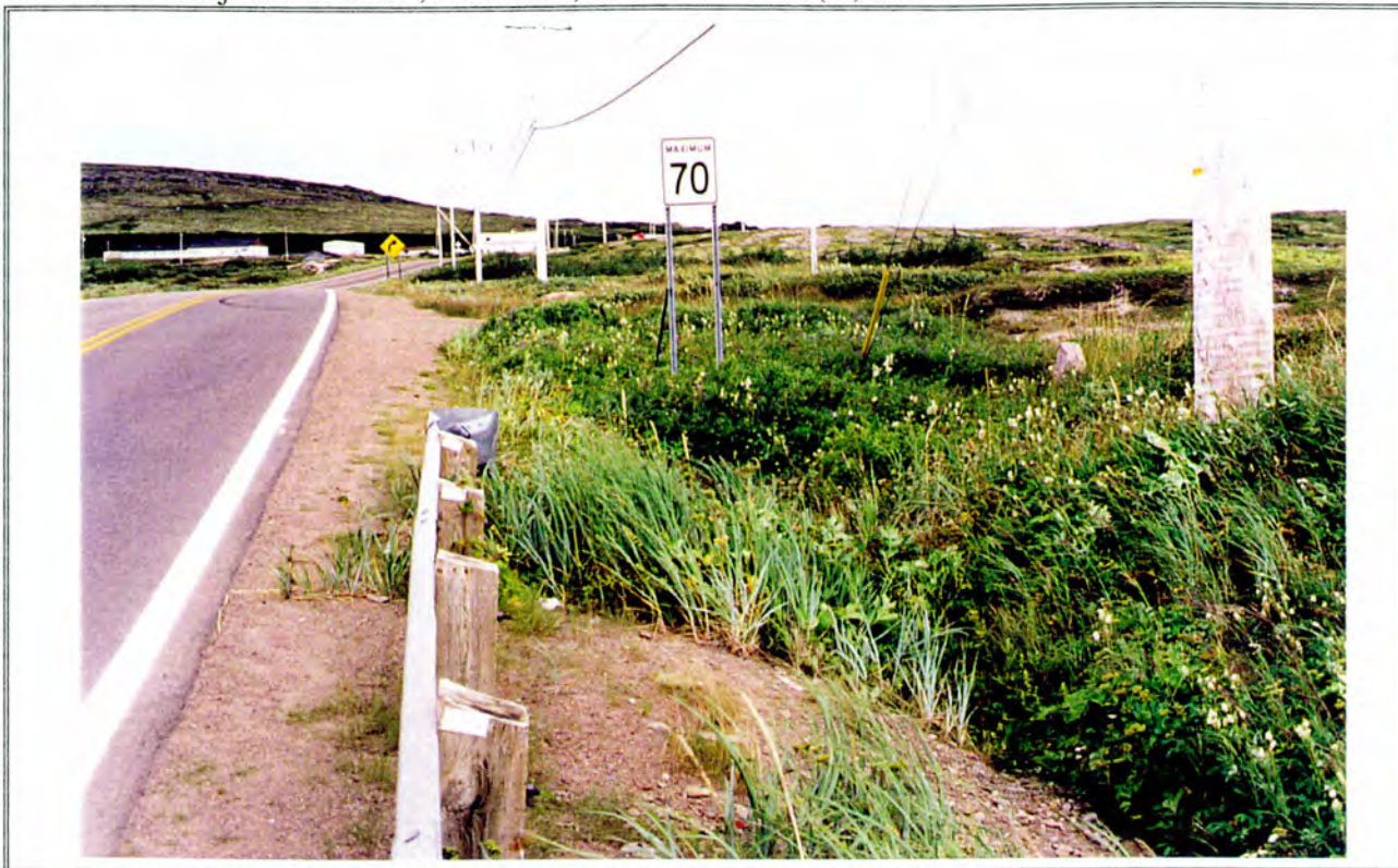
Photo 5 Projet 3571-9923, route 138, 1+000 – 1+100 (O)
