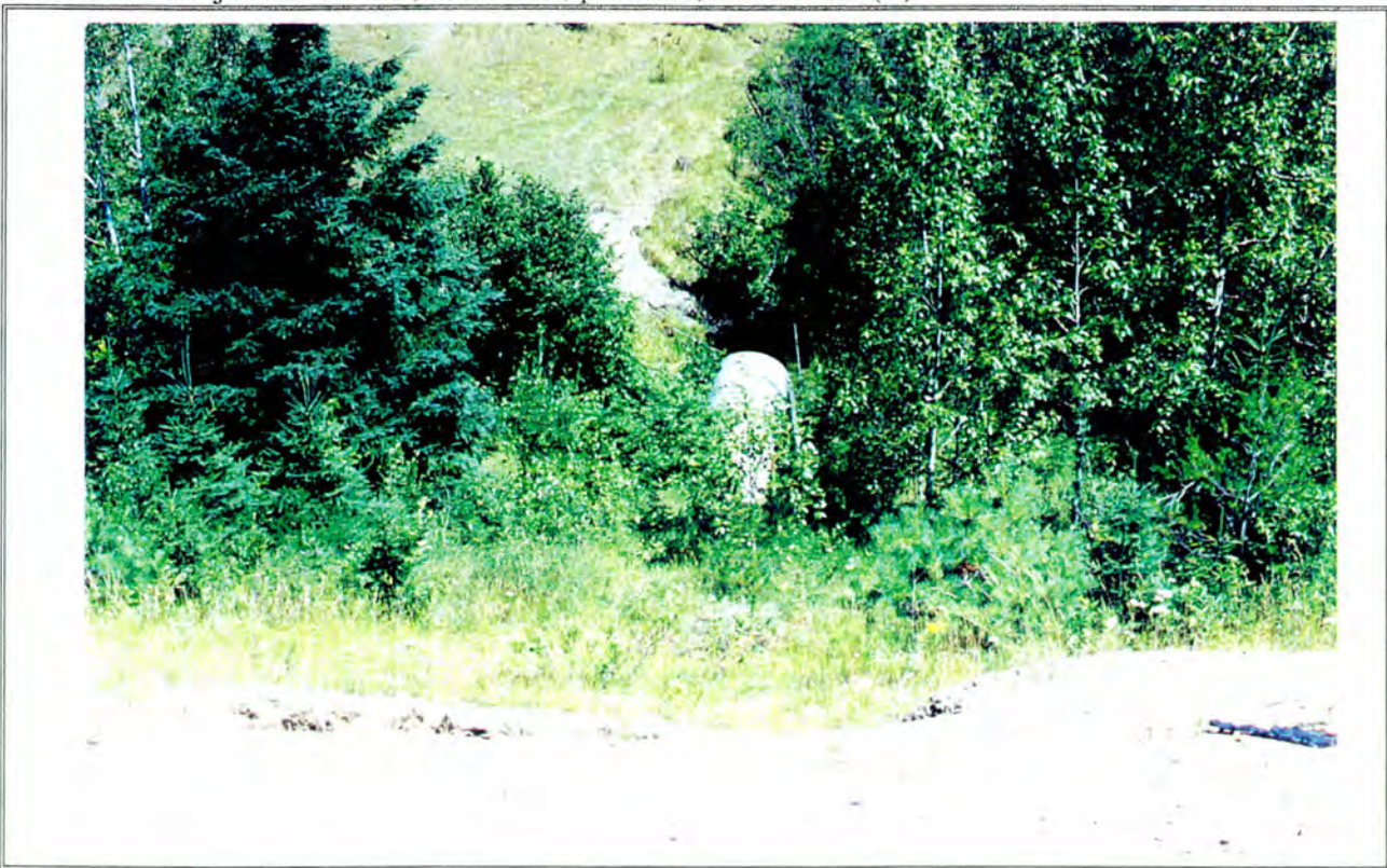
Photo 12 Projet 3574-9426, route 172, ponceau, versant est (E)
