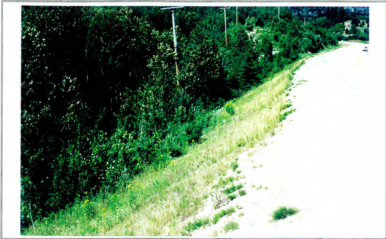
Photo 11 Projet 3574-9426, route 172, ponceau, versant ouest (N)
