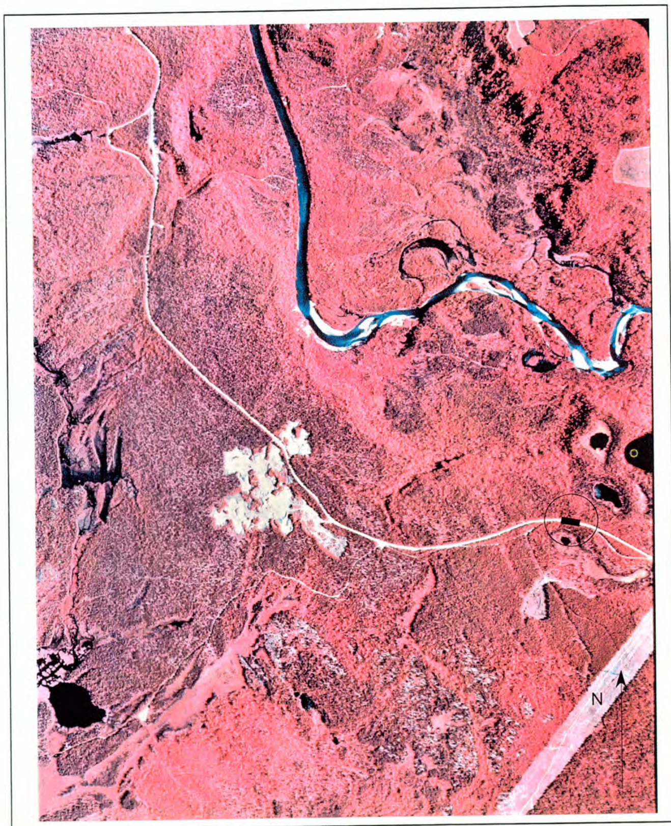
Figure 56 Localisation sur photo aérienne du projet 20-3574-0326, chemin Lac Castor 5+750 (ministère des Ressources naturelles, de la Faune et des Parcs, Q00105-111)
