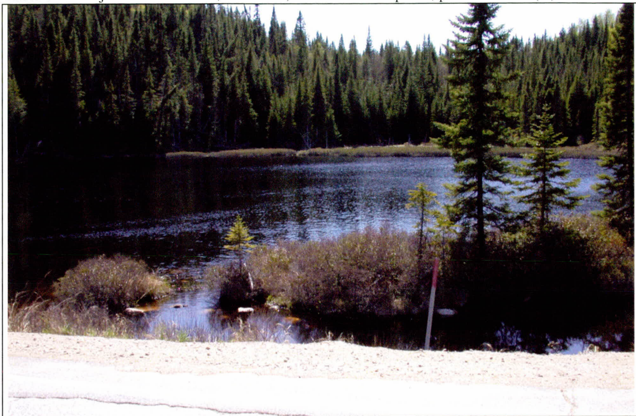
Photo 94 Projet n° 154-06 0-96, route 389, diverses municipalités, ponceau n° 31 (O)
