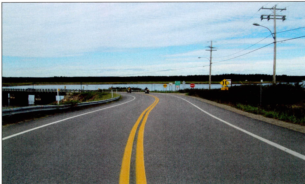
Photo 12 Projet n° 154-93-0591, secteur 2, chainage 9+887, vue vers l'ouest
