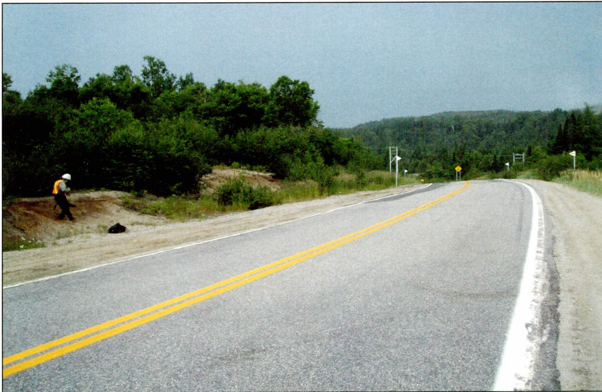
Photo 4 Projet n° 154-04-0354, secteur 2, chainage 0+460, vue vers le sud-ouest
