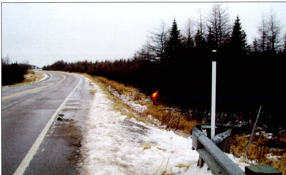
Photo 9 Projet n° 154-10-1187, secteur 1, chainage 6+100, vue vers l'ouest
