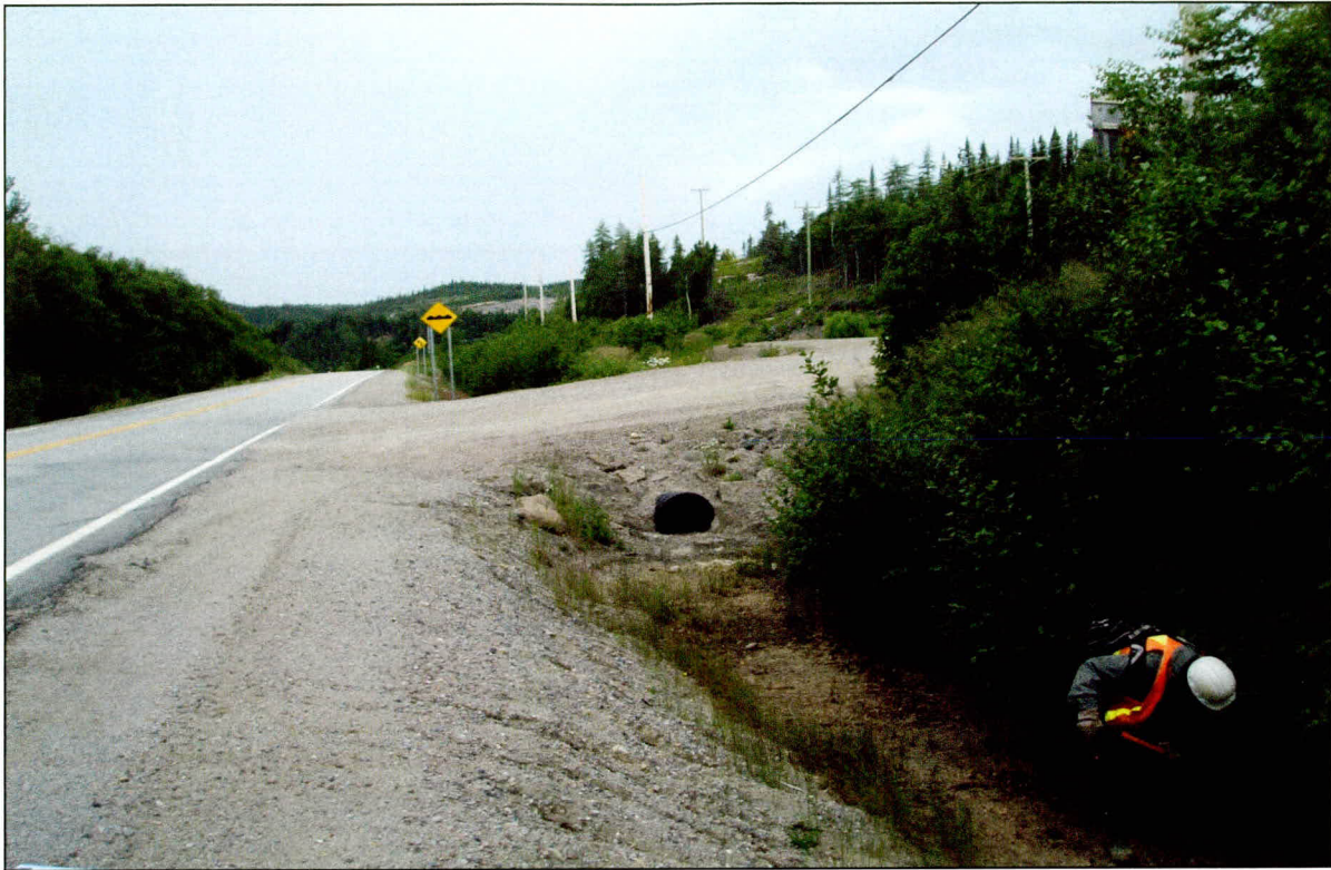
Photo 3 Projet n° 154-04-0354, secteur 1, chainage 0+660, vue vers l'ouest
