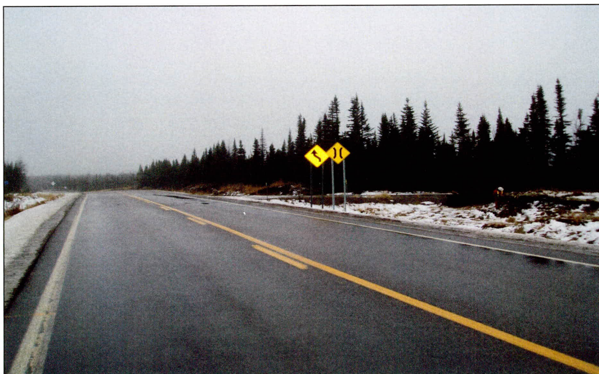
Photo 10 Projet n° 154-10-1187, secteur 2, chainage 6+350, vue vers l'ouest
