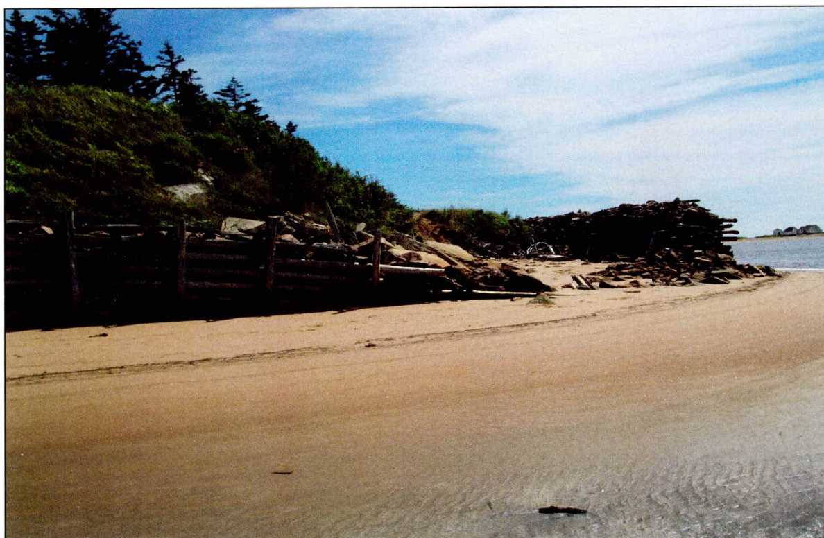
Photo 14 Projet n° 154-07-0845, secteur 1, chainage 0+140, vue vers le nord-est
