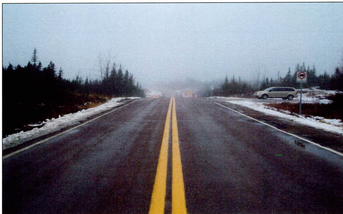
Photo 8 Projet n° 154-10-0610, secteur 2, chainage 4+640, vue vers l'ouest
