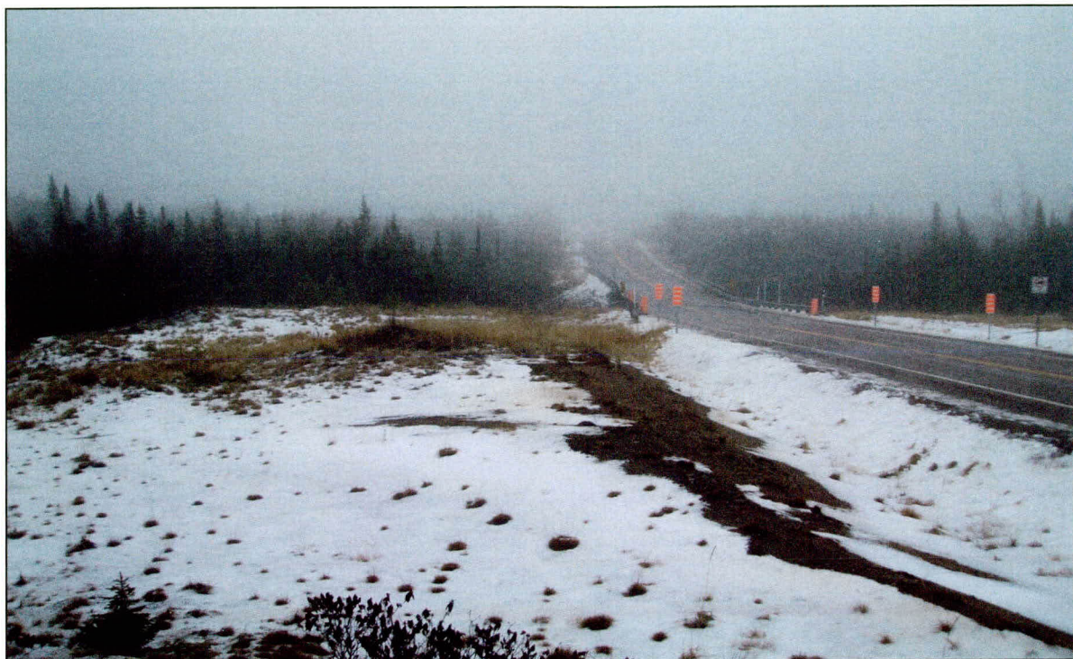
Photo 5 Projet n° 154-10-0610, secteur 1, chainage 4+440, vue vers l'est
