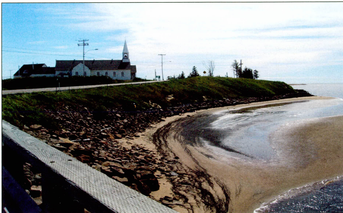
Photo 13 Projet n° 154-07-0845, secteur 1, chainage 0+000, vue vers l'est
