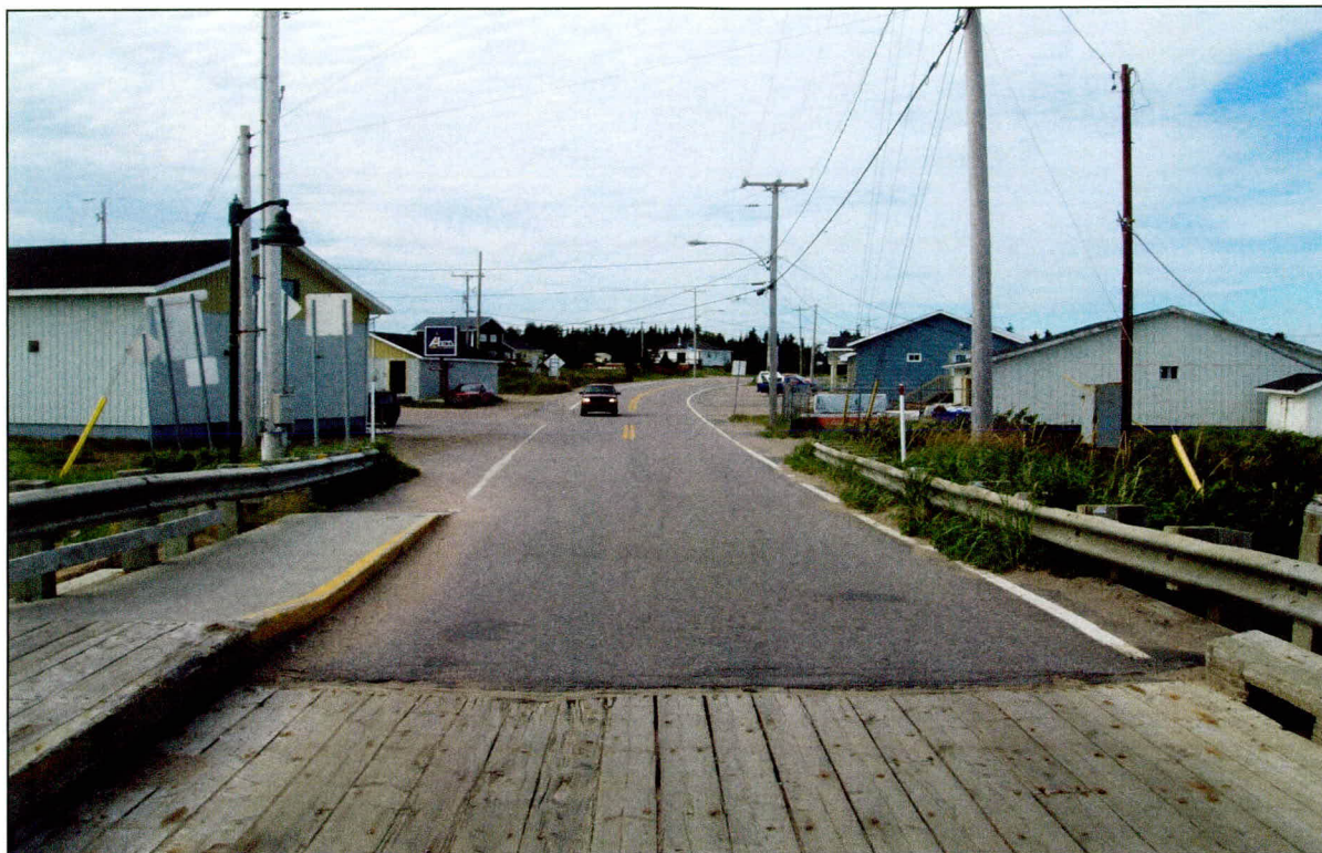
Photo 11 Projet n° 154-93-0591, secteur 1, chainage 9+680, vue vers l'ouest
