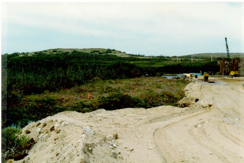
Figure 10 La route 138 en construction et son emprise nord défrichée
