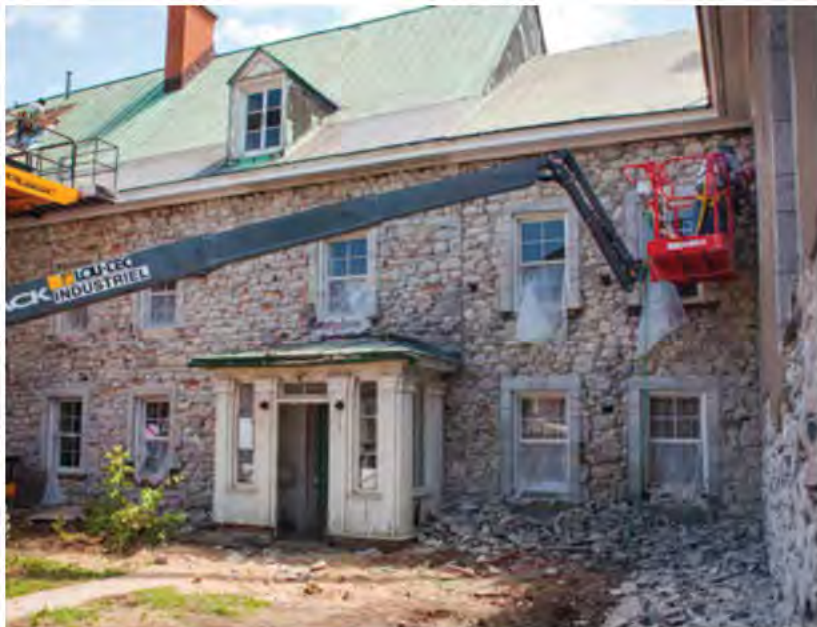
Travaux de restauration de l'enveloppe extérieure. Repéré sur la fiche « Des églises réinventées » de la CPRQ. Crédit photo : Ville de Trois-Rivières, 2016.
