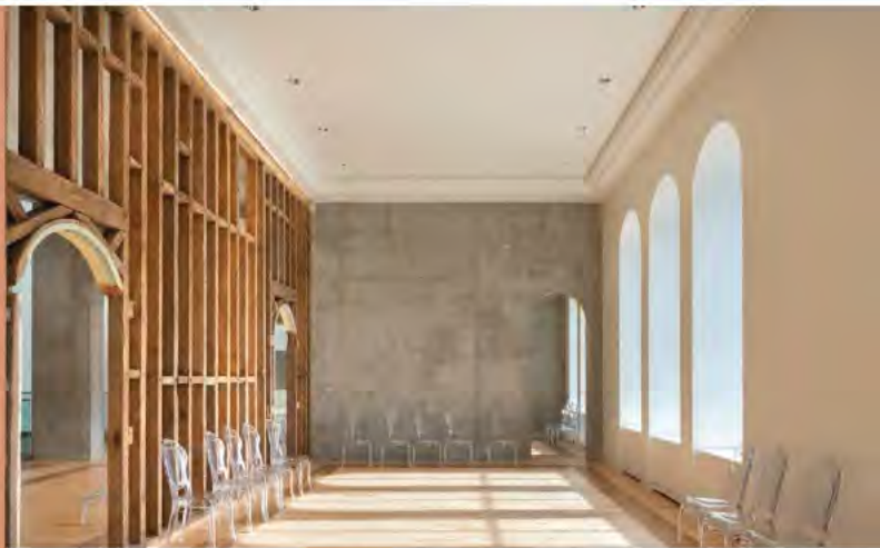
Arches de bois intérieurs et fenêtres de bois qui ont pu être conservées par demande de mesures différentes (ajout de gicleurs). Les gicleurs ne sont pas perceptibles car ils se trouvent sous le plafond de toile perforée tendue. Crédit : Stéphane Groleau
