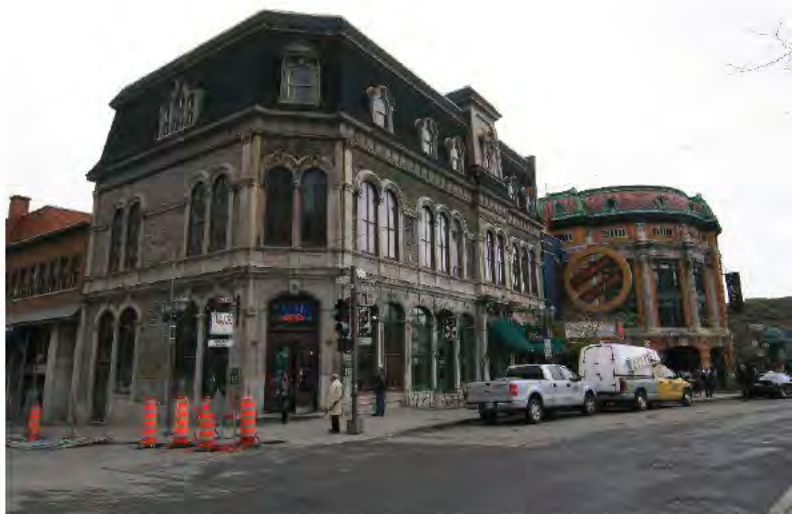
Vue extérieure du bâtiment avant les travaux. Crédit photo : Marie-Chantal Croft.
