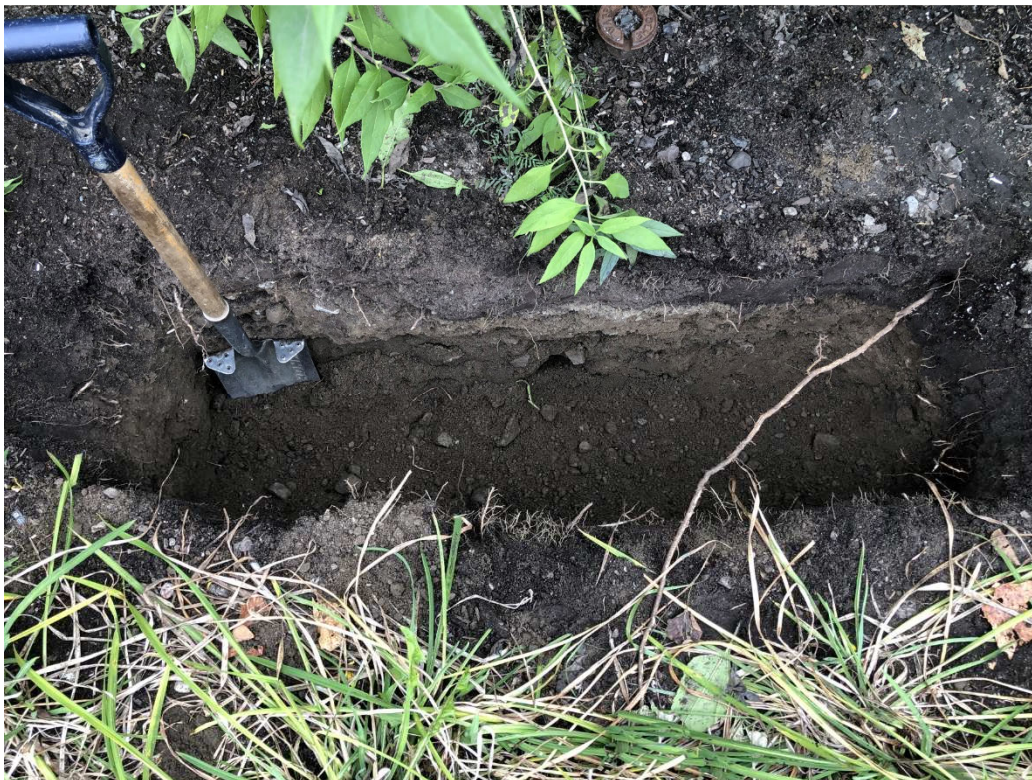
Figure 4 : Excavation en façade de la maison, sous-opération 8B
