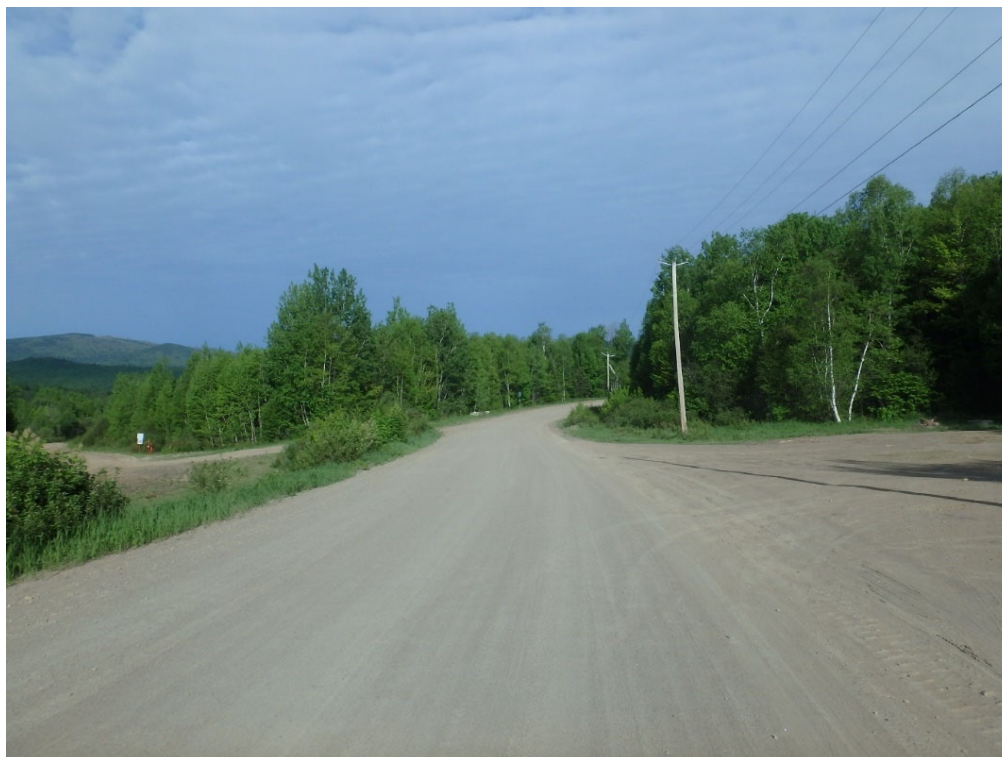
Photo 18. Zone H10, vue d'ensemble, vers le nord (HYD2401-2024-NUM1-66)
