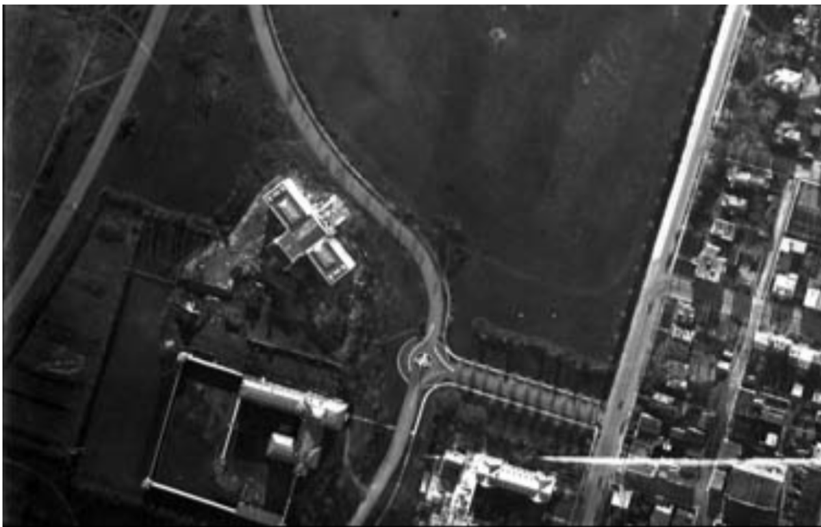
Figure 15. Photographie aérienne du secteur du Musée national des beaux-arts du Québec, 1929 (BAnQ E21,S110,SS1,SSS1,PK120-16)
