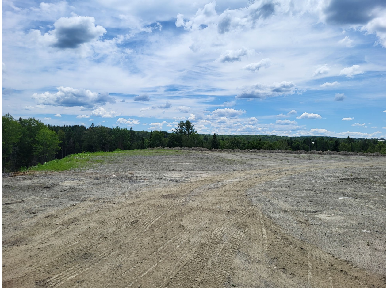
Figure 12 : Secteur remblayé au sud de la zone 1
