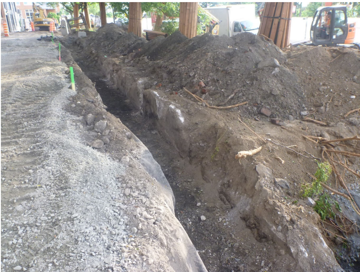
Photo 2. Vue générale de la sous-opération 6E avec le mur de béton 6C1/6E1, vue vers l'est (BjFj-17-2024-NUM1-32)
