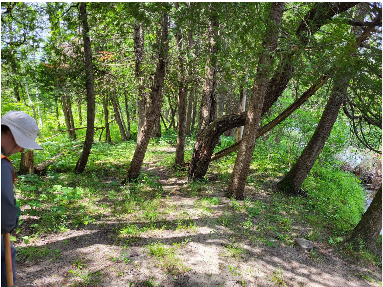
Figure 9 : Levée sur la rive gauche de Kik8ntegw (rivière Chaudière) sur la zone 1
