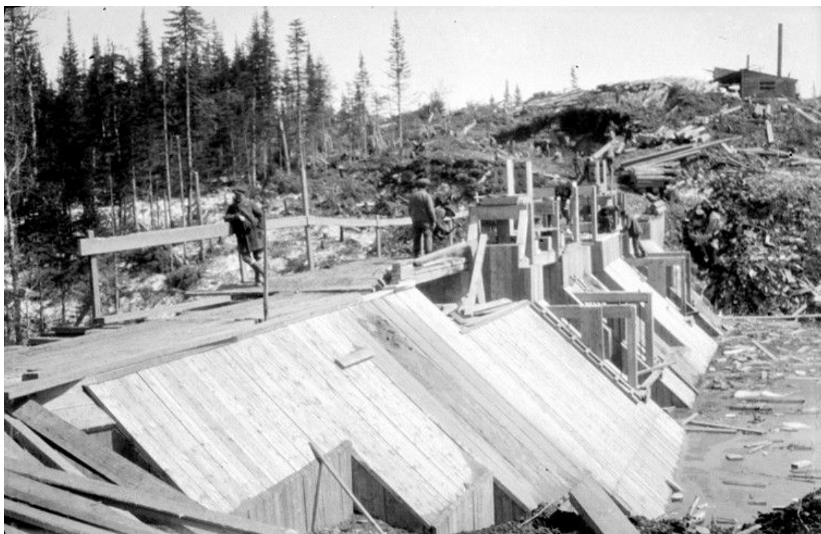
Figure 10. Construction du barrage du lac Brûlé ou Saint-Michel, 1919 (BAnQ 03Q_PB04_00072_002)
