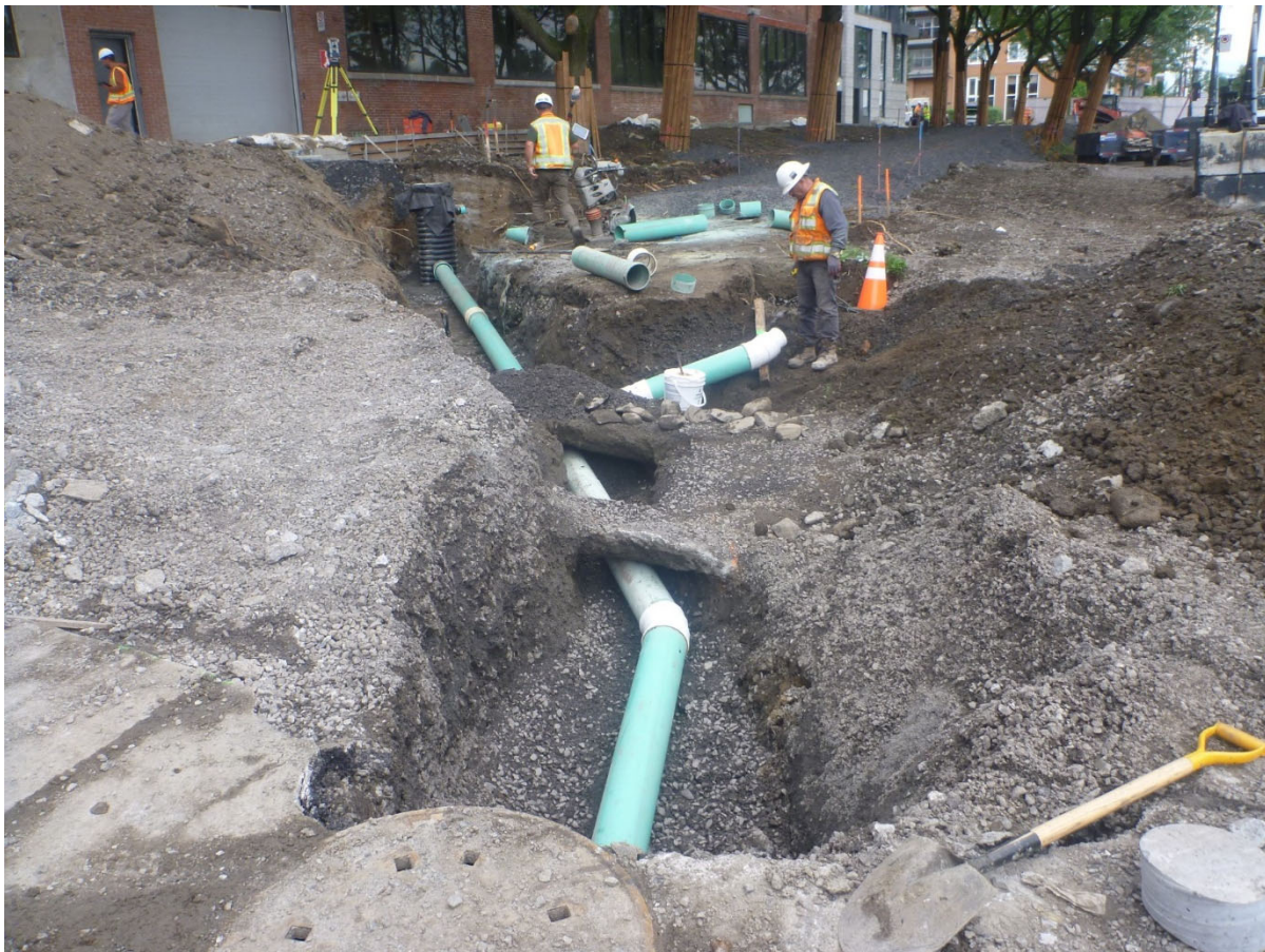
Photo 8. Vue générale de la sous-opération 6L, vue vers le nord-est (BjFj-17-2024-NUM1-77)
