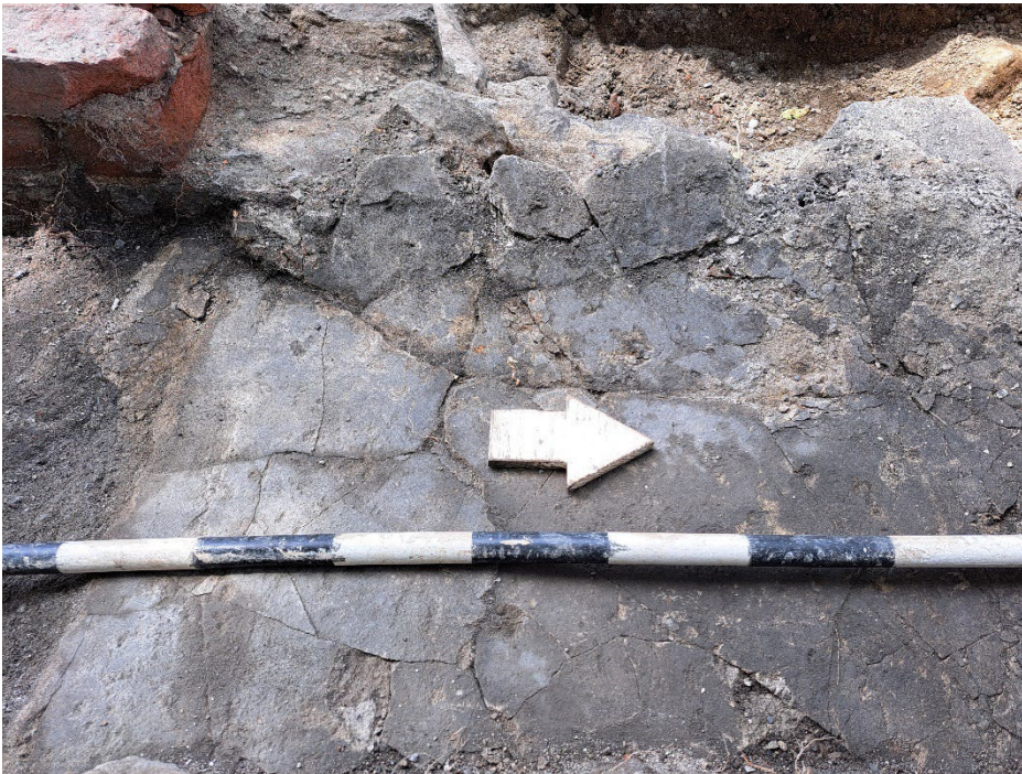
Photo 25. Détail du plancher de ciment (sous le prélart) (Photo BiFj-141-24-N1-148).
