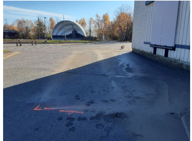
Figure 14 : Opération 2 – vue générale avant l'excavation, vers l'est
