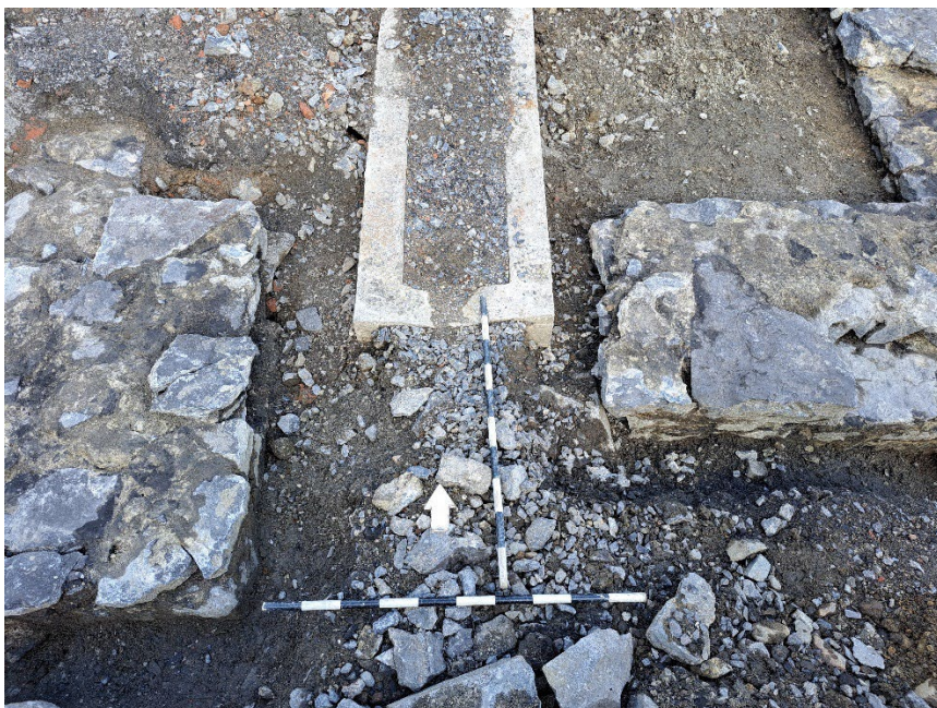
Photo 10. Perturbation de la fondation de la tour de clocher par une cuve de béton récente (Photo BiFj-141-24-N1-220)
