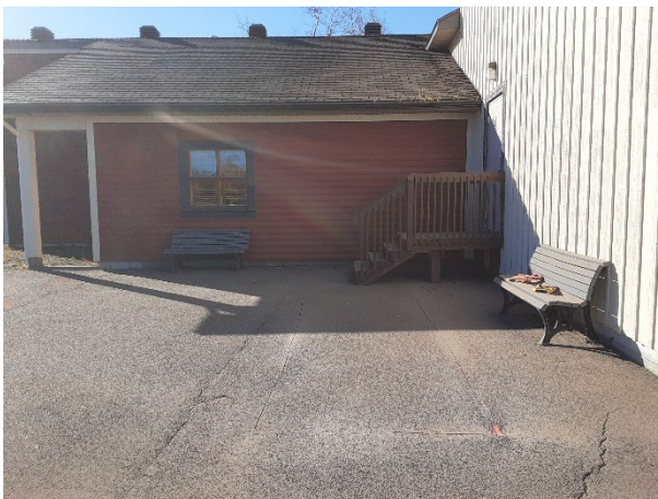
Figure 11 : Opération 1 – vue générale avant l'excavation, vers le sud-ouest
