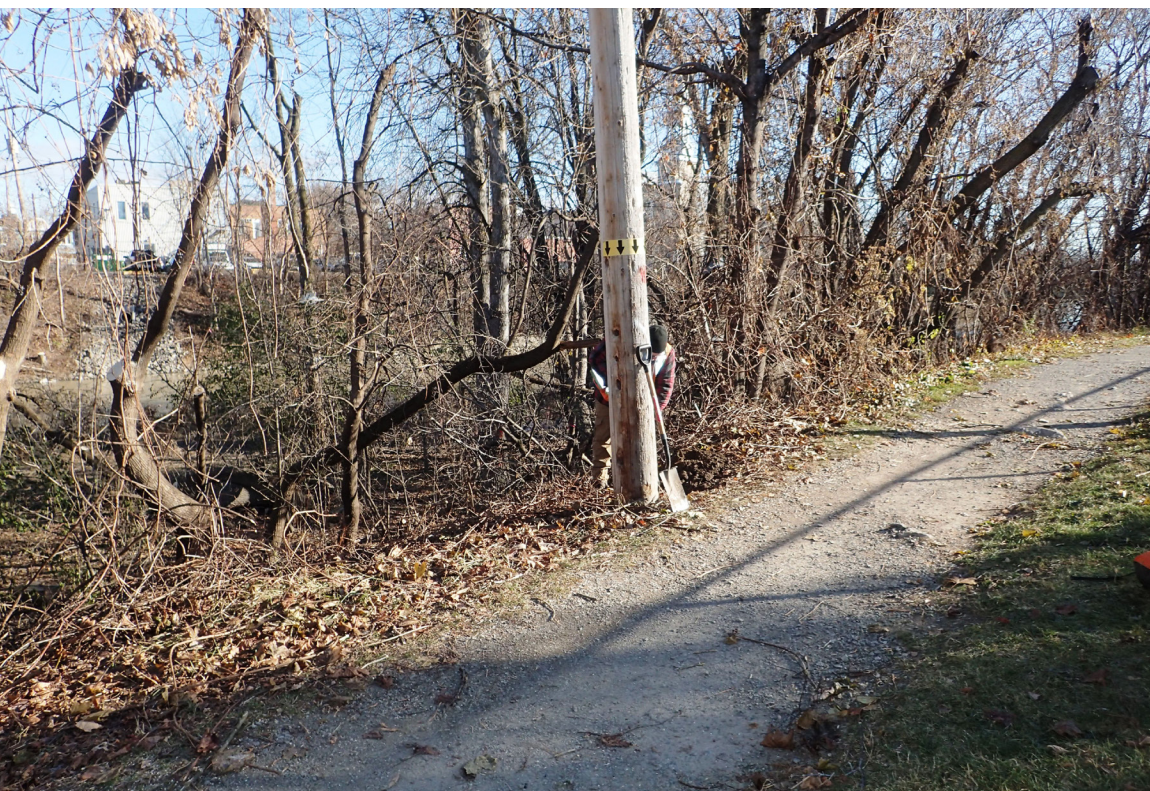
Photo 4.1 V u e générale vers l'est du poteau à remplacer dans le secteur 1 et du niveau de terrasse vers la rivière (PATR23N25-05).
