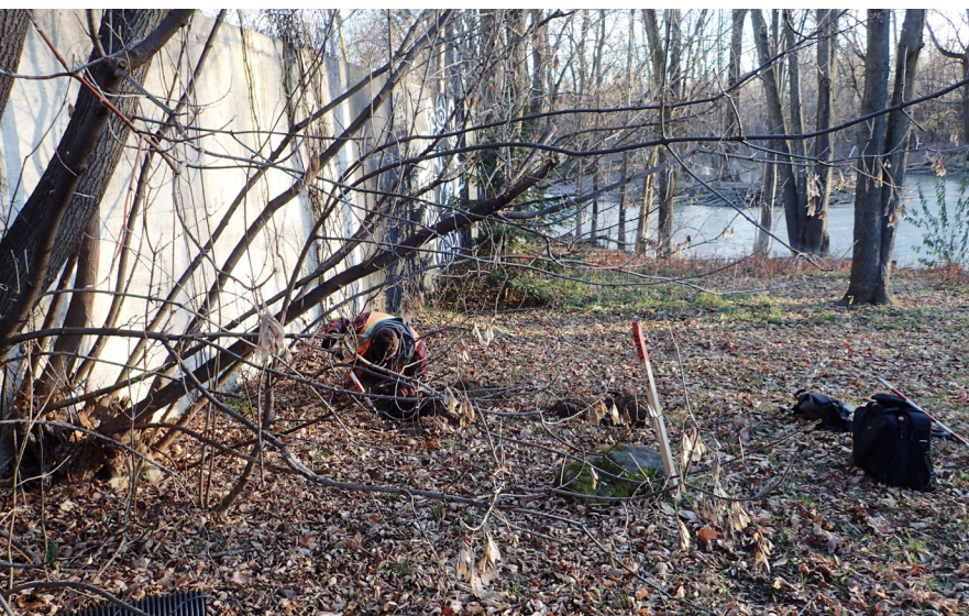
Photo 4.10 Vue générale vers le sud-est du niveau de terrasse sur lequel va se trouver la future attache (PATR23N25-23).
