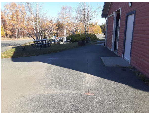
Figure 17 : Opération 3 – vue générale avant l'excavation, vers le nord
