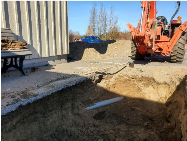
Figure 13 : Opération 1 – conduit passant au coin nord, vers le nord
