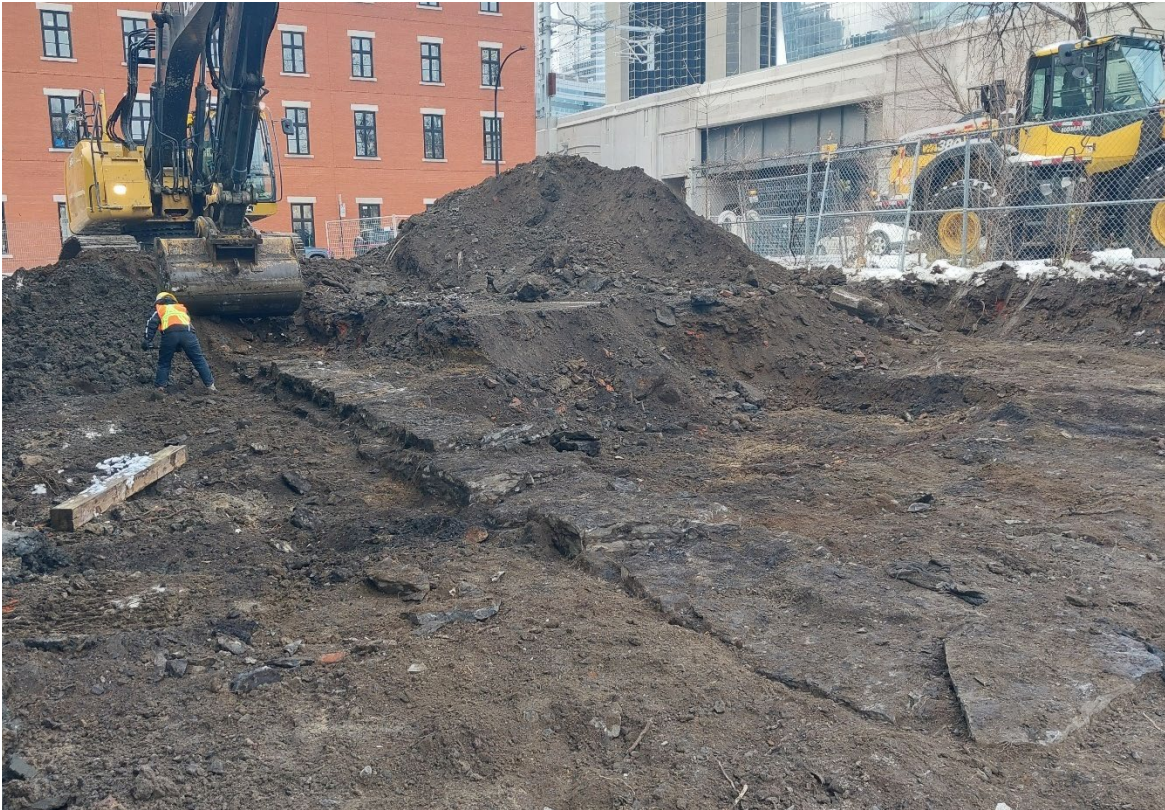
Photo 34. Section du mur ST-1 mis au jour pendant la supervision. Correspond au mur de fondation est de la patinoire et de l'église Sainte-Hélène. Vue vers le sud-ouest (Photo Bifj-141-24-N3-16).
