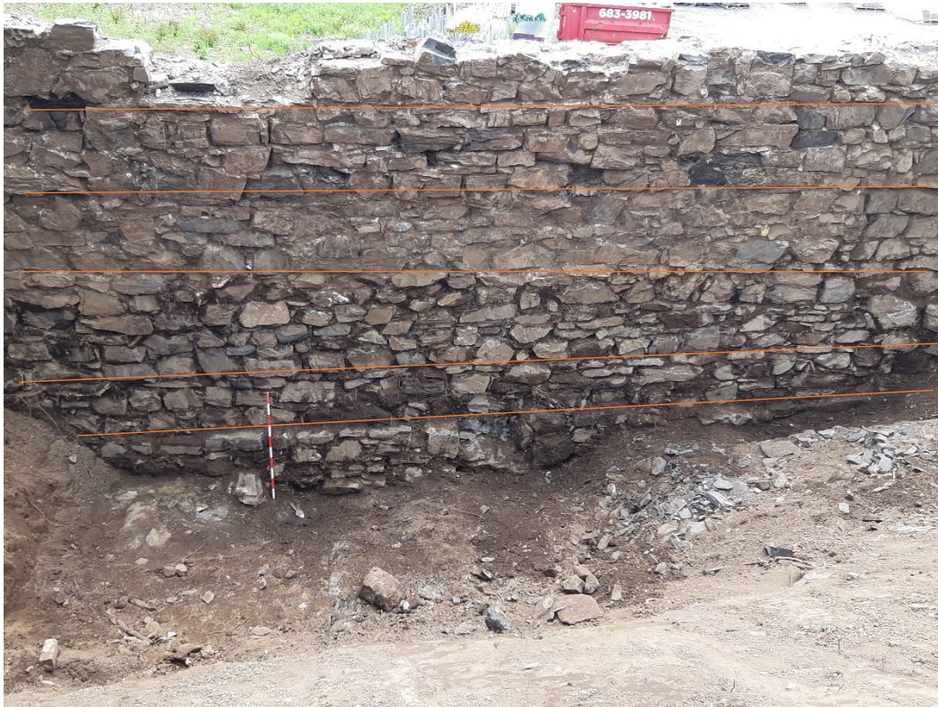
Photo 1. Parement est du mur CeEt-19-9A100 (K) et ces phases de construction (lignes orange), vue vers le sud-ouest (CeEt-19-24-NUM1-139)
