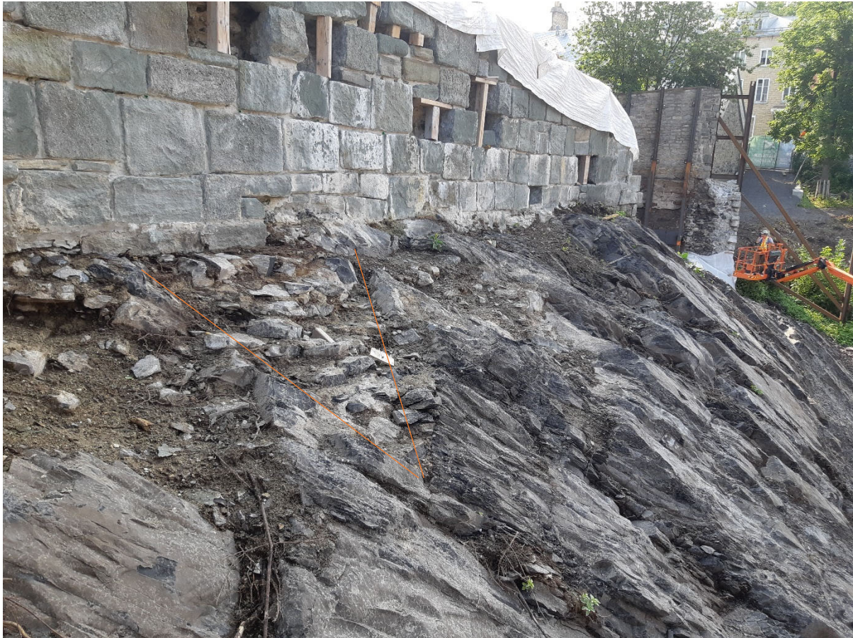
Photo 37. Trace d'aménagement dans le cran rocheux au pied du mur I (faille présumée dans les lignes orange), vue vers le nord-est (416G24R06E-23)
