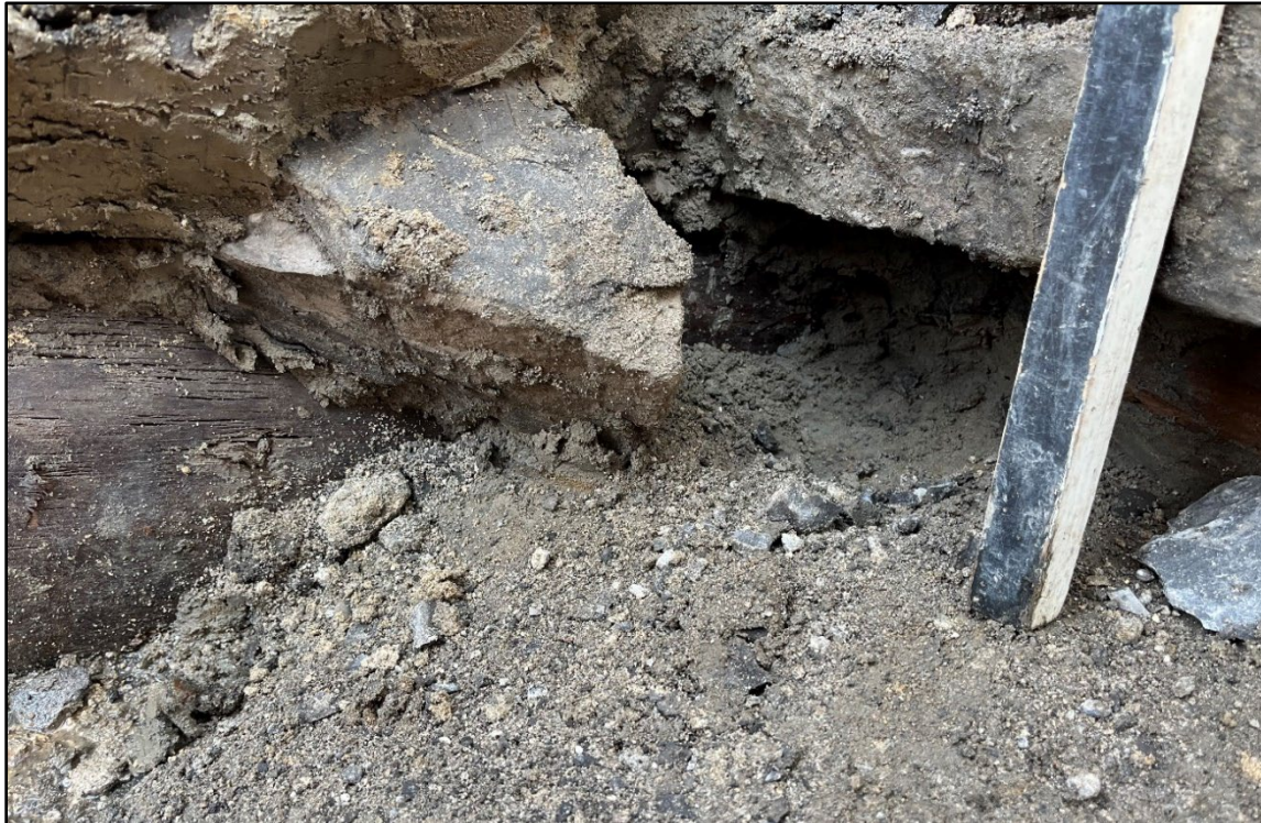
Photo 21 : Pièce de bois (A) à la jonction entre le mur de refend 1B100 (à gauche) et le mur de fondation sud (3F100, à droite). Elle se trouve simultanément sous les deux vestiges
