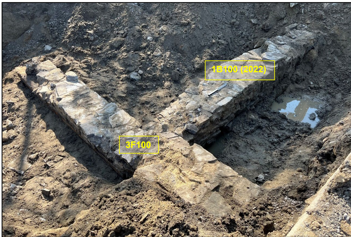
Photo 14 : Mur sud (3F100) et mur de refend (1B100) de la filature de la corderie Brown
