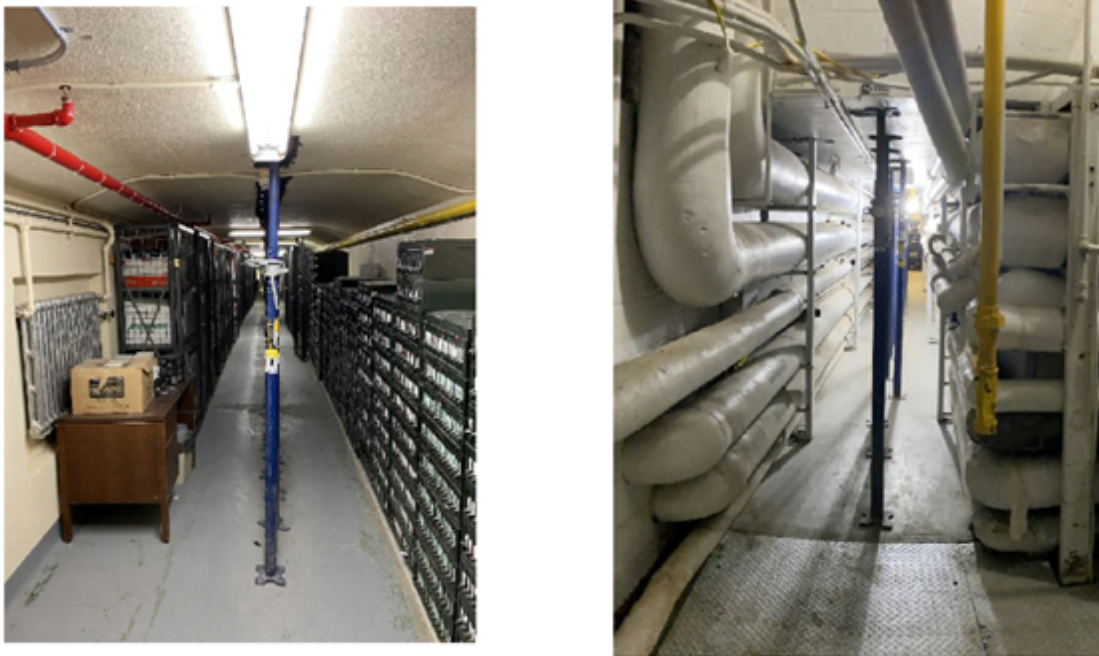
Figure 7: Gauche : Photo de l'intérieur du tunnel souterrain 17, Droite : Photo de l'intérieur du tunnel souterrain 56. Les deux photos montrent la présence de supports verticaux pour supporter des charges véhiculaires
