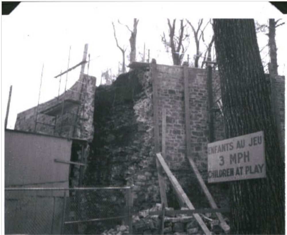
Figure 44. Photographie des travaux à la jonction du mur D et E prise le 27 mai 1970 (Tiré du dossier du ministère des Affaires culturelles 1970)
