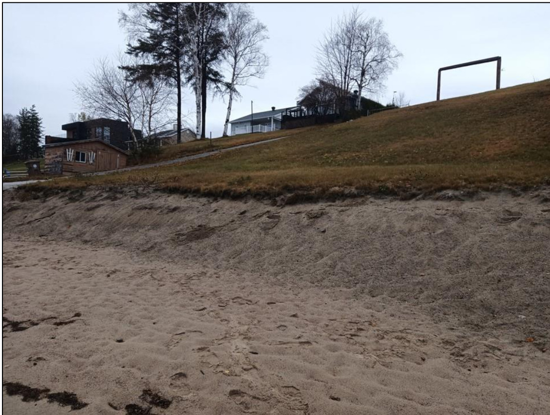
Figure 14: Zone inspectée visuellement, Dolbeau-Mistassini (86.11.01)
