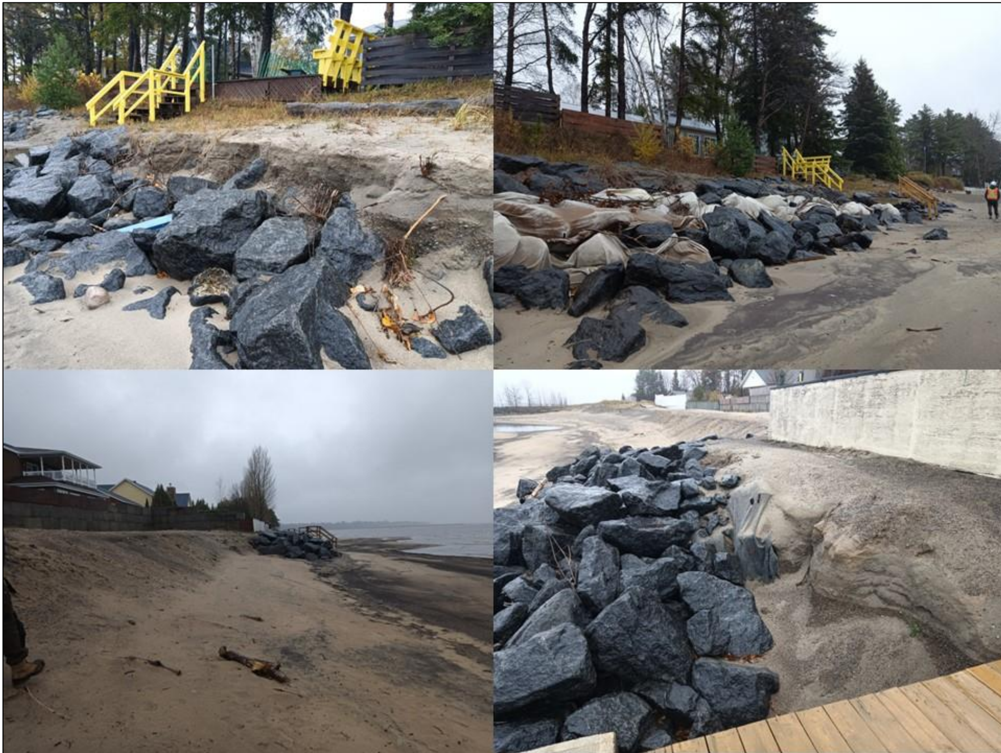
Figure 12:Projet 93.02.02 (25). État du secteur.
