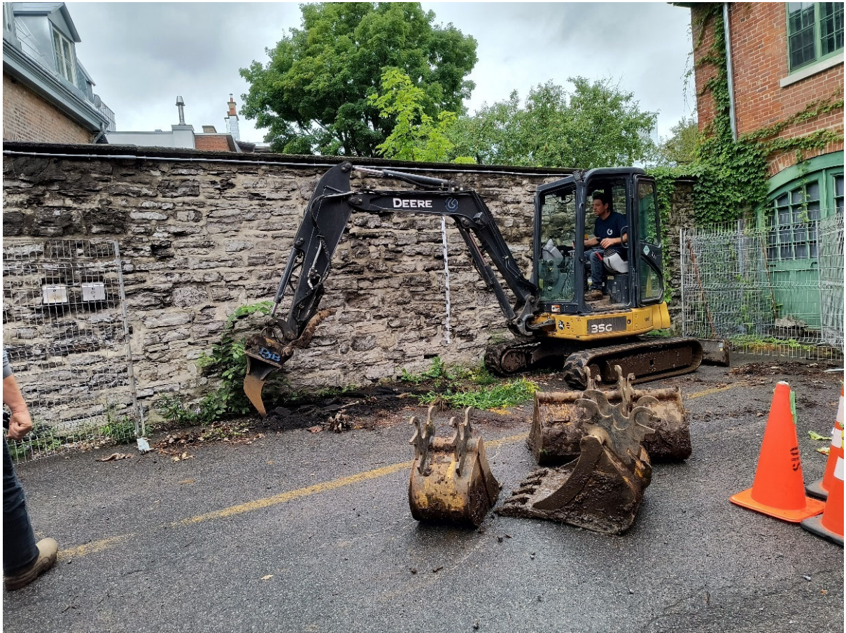
Photo 38. Début de l'excavation le long du mur de cour arrière du Conservatoire d'art dramatique de Québec, vue vers le sud-sud-ouest (CeEt-105-NUM1-2)
