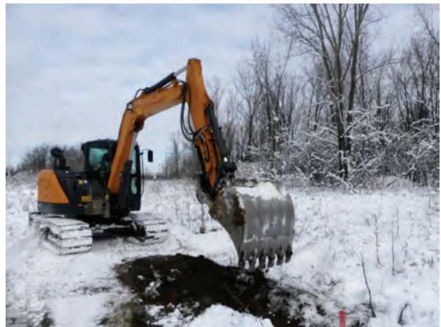
Photo 33 - MTL23-16-1-9E, zone P-02 — Machinerie en action, tranchée TR-15 (MTL23-16-1-N3-028)
