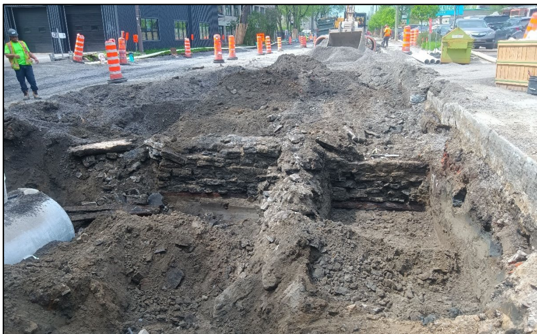
Photo 19 : Parement sud du vestige 3A100, et vue d'ensemble lors de la surveillance archéologique (4A99) Photo : Stéphane Noël, 2024-CeEt-975.158, 21 mai 2024
