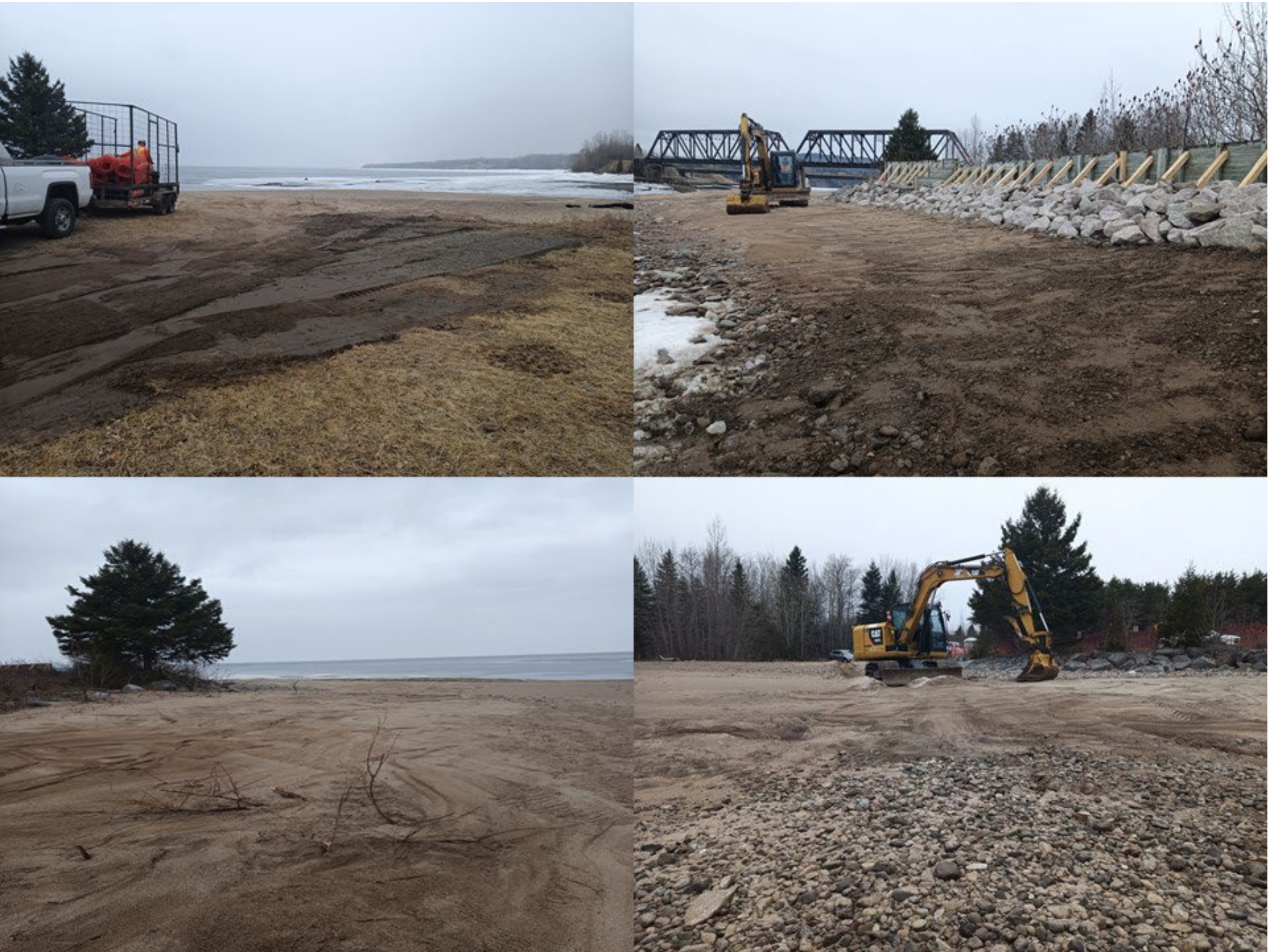
Figure 15 : Mise en état du site après les travaux de réfection.
