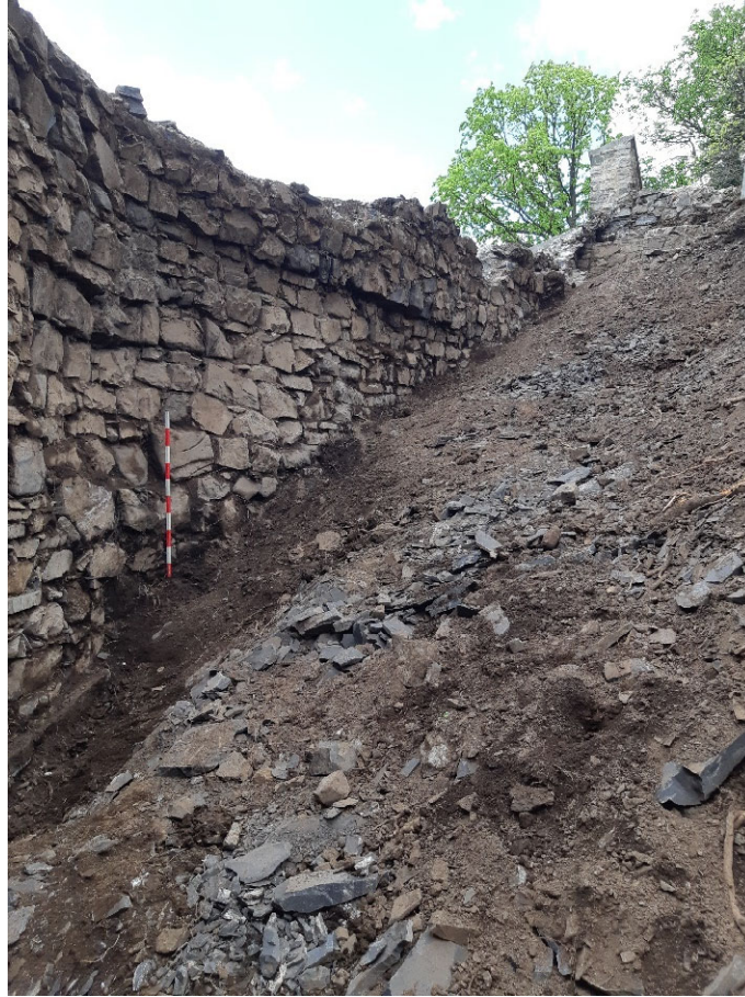
Photo 2. Parement est du mur CeEt-19-9A200 (J) et son décroché dans la partie supérieure, vue vers le nord-ouest (CeEt-19-24-NUM1-154).
