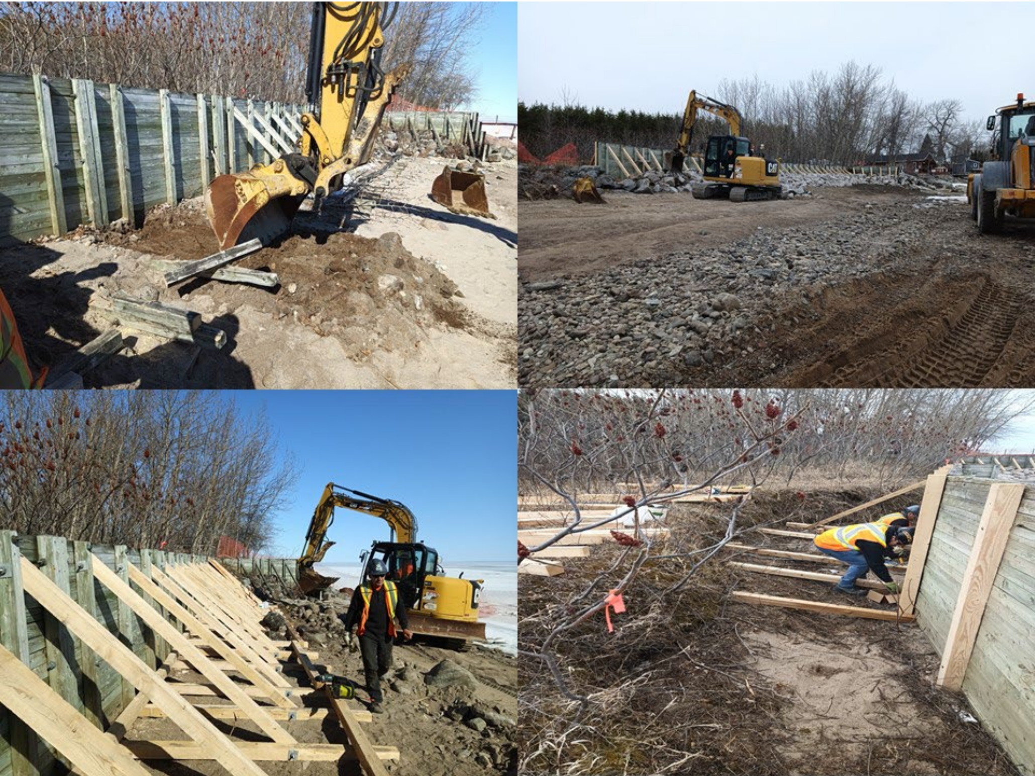
Figure 13 : Installation du muret de bois pour protéger le site DcEx-1 de l'érosion.
