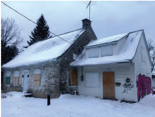
Photo 10 - MTL23-16-1, zone H-01 (sous-zone H-01b) — Maison Augustin-Brisebois, corps principal et cuisine d'été — Vue vers le nord-ouest (MTL23-16-1-N4-019)
