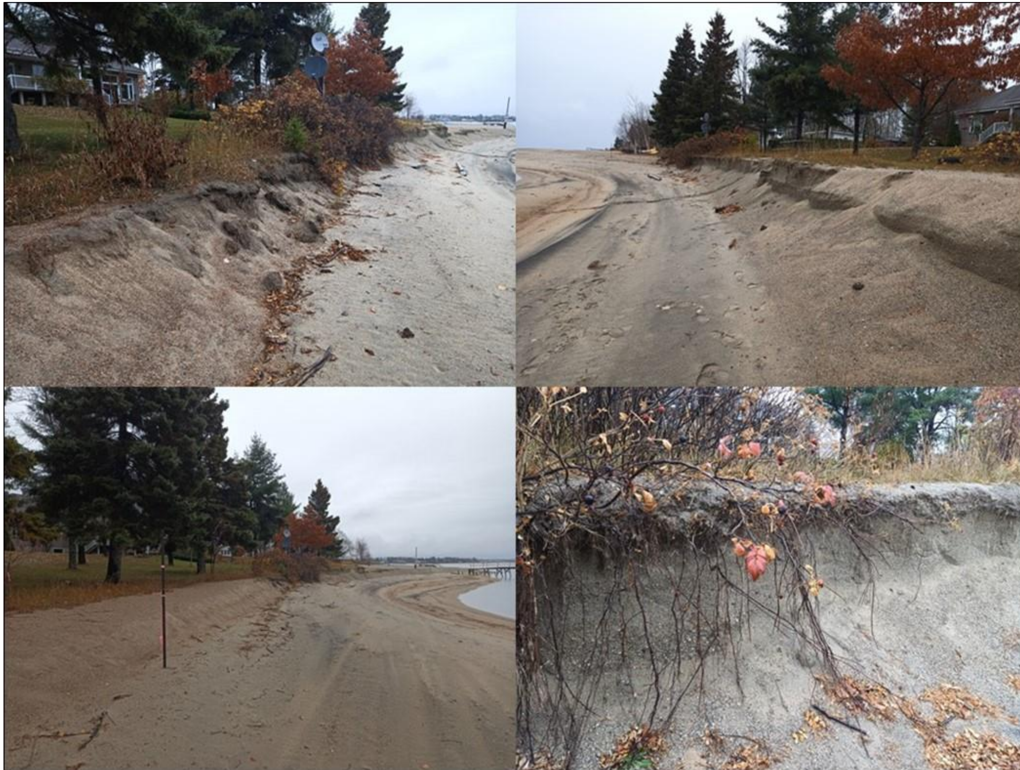
Figure 15: Zone inspectée visuelle, Dolbeau-Mistassini (92.11.01)
