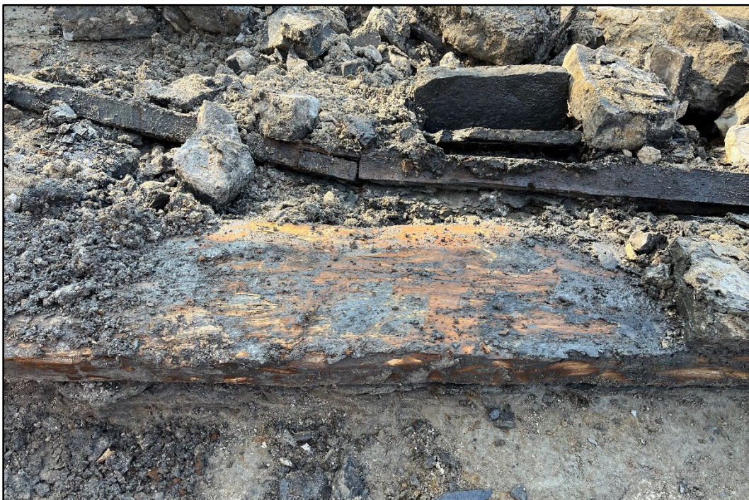
Photo 16 : Sole de bois sous la maçonnerie de 3F100, après le démantèlement du mur, vue vers le nord Photo : Stéphane Noël, 2024-CeEt-975.222, 16 mai 2024
