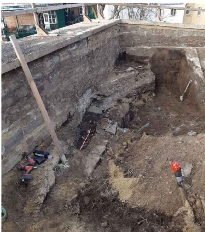
Photo 15. Mur E en lien avec le vestige 9F100 et 9F200, vue vers le nord (CeEt-19-24-NUM-308)
