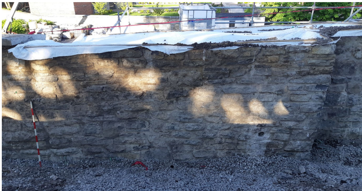
Photo 8. Parement est du mur H (CeEt-19-24-NUM1-172)
