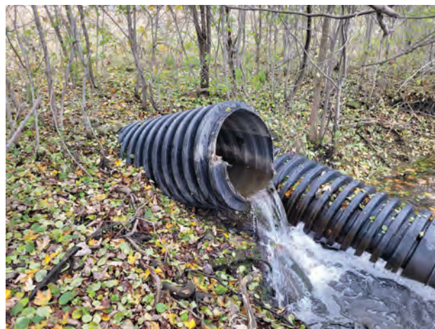
Photo 20 - MTL23-16-1, zone H-01 (sous-zone H-01a) — Sortie de la canalisation de drainage dans la rivière des Prairies, à la mitoyenneté de la pointe de terre et de la propriété sur laquelle se dresse la maison Augustin-Brisebois — Vue vers l'ouest (MTL23-16-1-N1-083)
