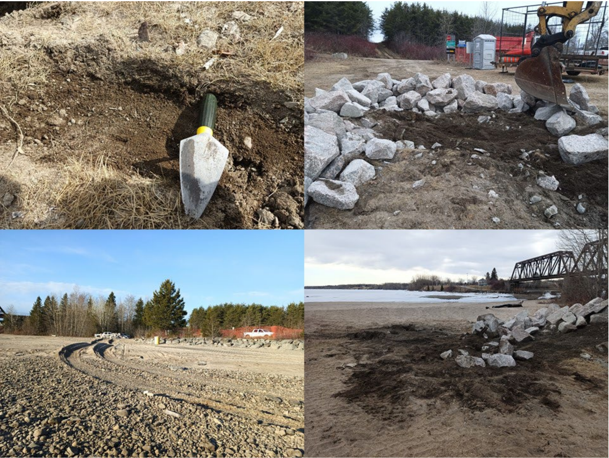
Figure 14 : Les légères perturbations laissées par les travaux de réfection.
