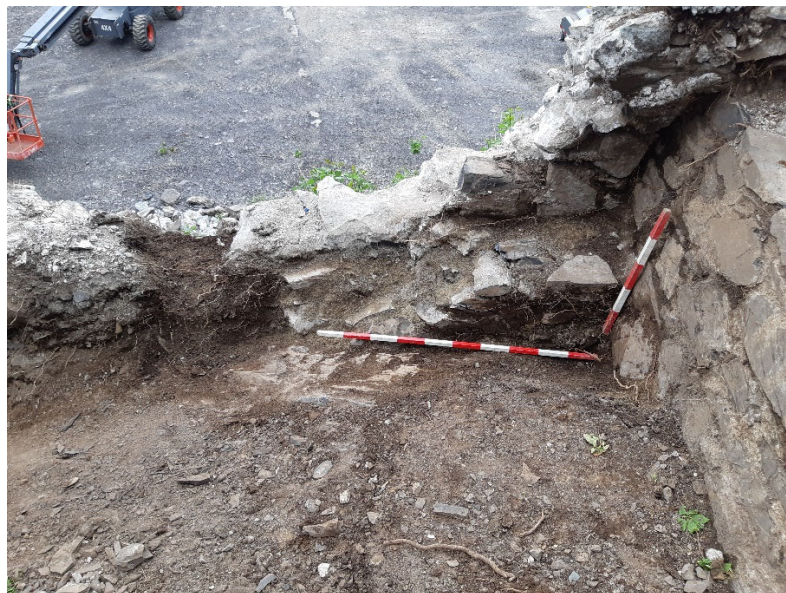
Photo 3. Décalage dans l'alignement du mur 9A200 (J) à son extrémité nord butant sur le vestige 9A300, vue vers l'ouest (CeEt-19-24-NUM1-162).
