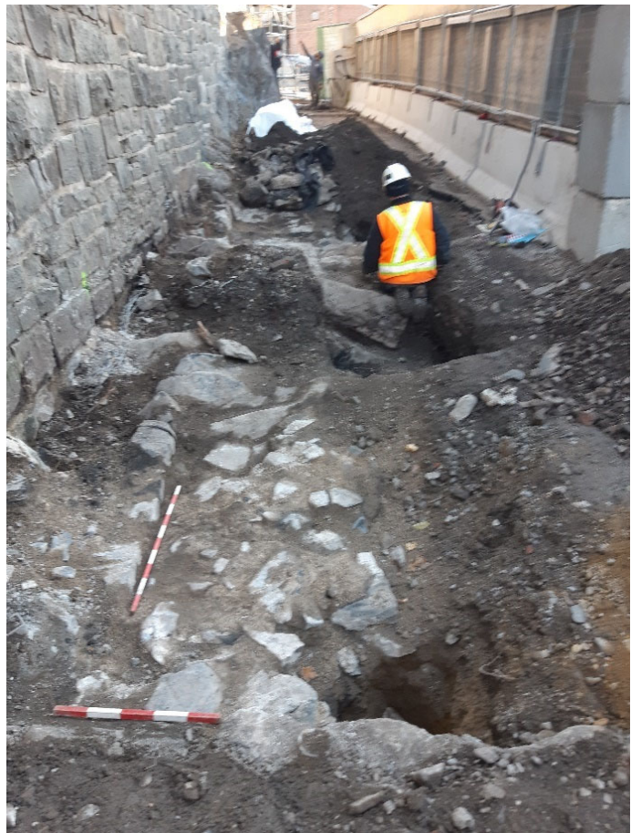
Photo 32. Ressaut (?) 416G16A100 au pied du mur E, vue vers le sud-ouest (416G24R06E-80)
