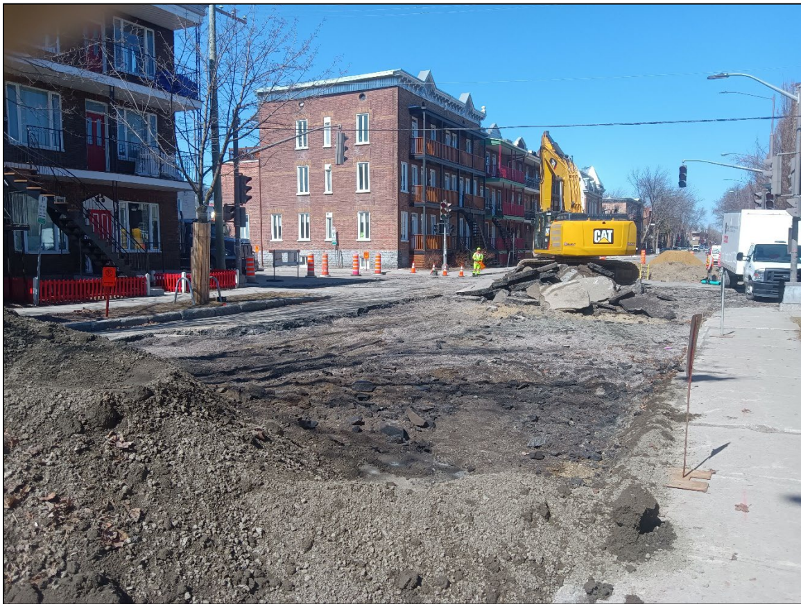
Photo 1 : Décapage mécanique sur le site CeEt-973, sur la 4 e Avenue à l'intersection de la 4 e rue, vue vers le nord-ouest
