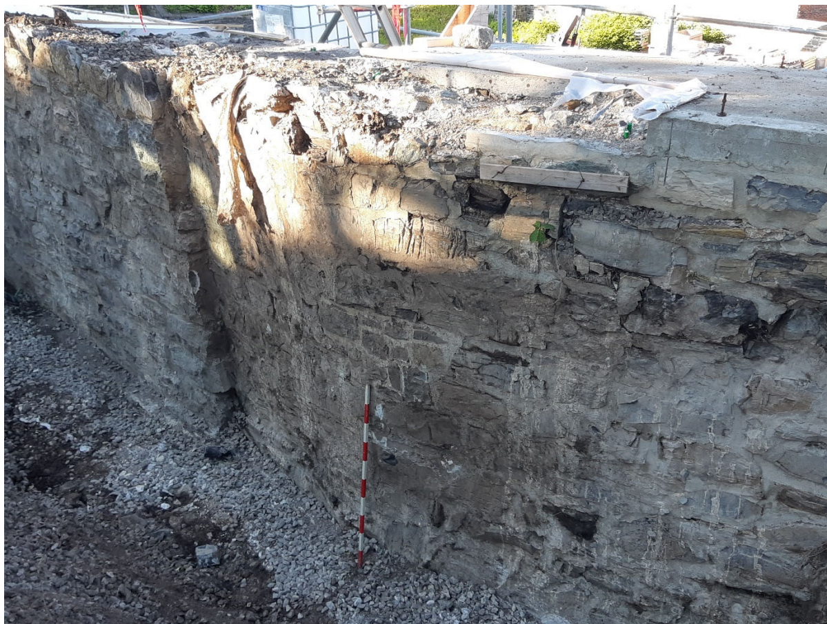
Photo 12. Parement est du mur F, vu vers le sud (CeEt-19-24-NUM1-178)
