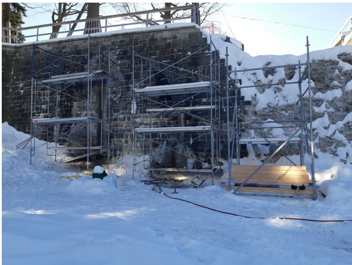
Photo 21. Forages en cours dans le mur C, vu vers le sud-ouest (CeEt-19-24-NUM1-371)
