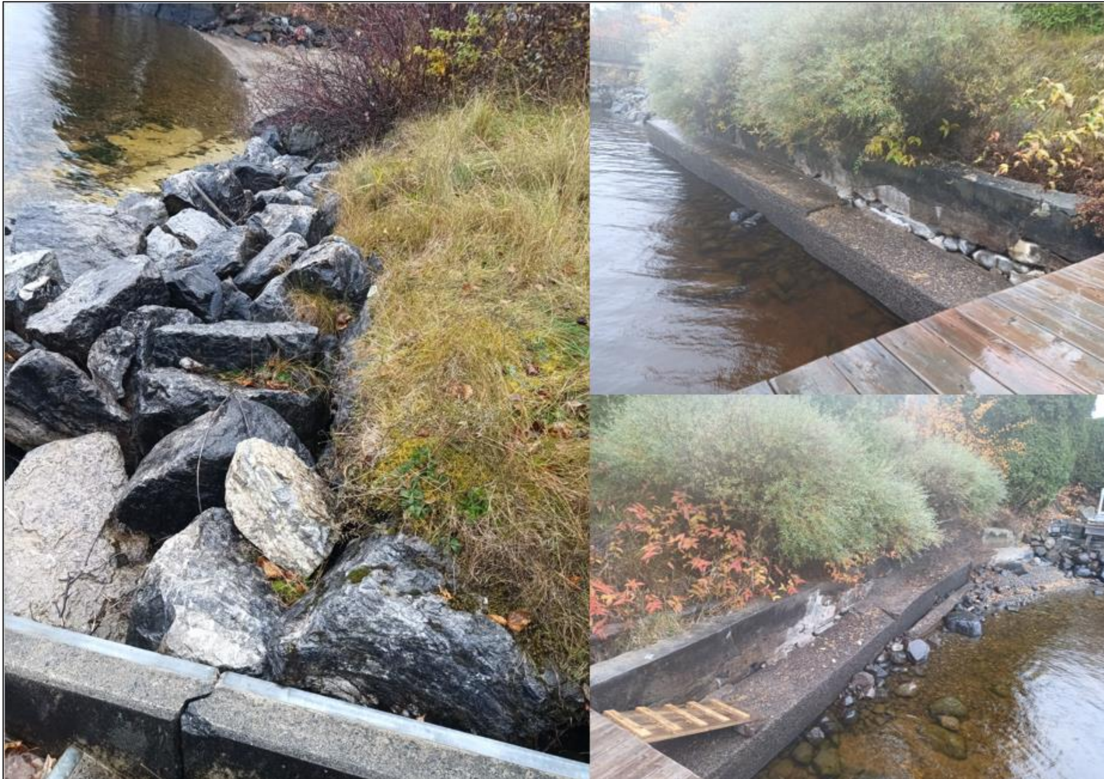
Figure 10 : Projet 96.01.01 (25). État du secteur.
