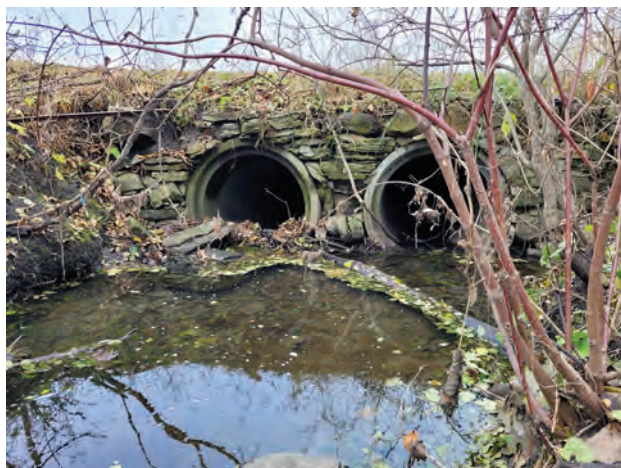
Photo 19 - MTL23-16-1, zone H-01 (sous-zone H-01d) — Canal de drainage et canalisations de béton sous la chaussée du boulevard Gouin Ouest — Vue vers le nord-est (MTL23-16-1-N1-096)
