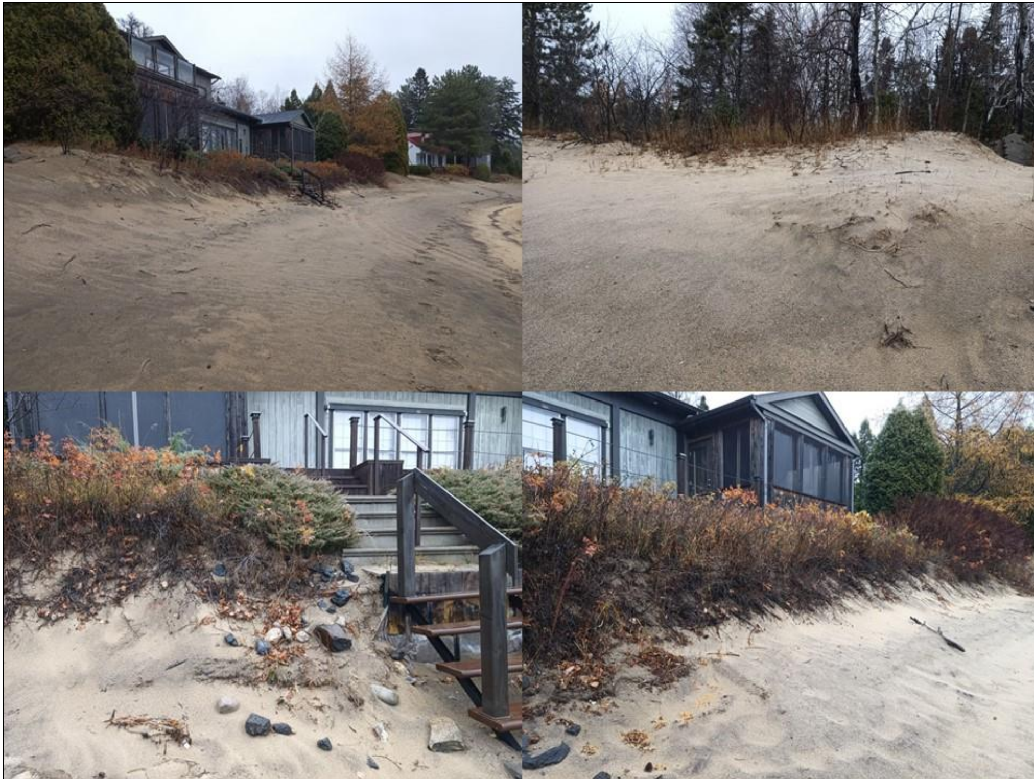
Figure 17:Projet 95.15.02 (24). État du secteur.
