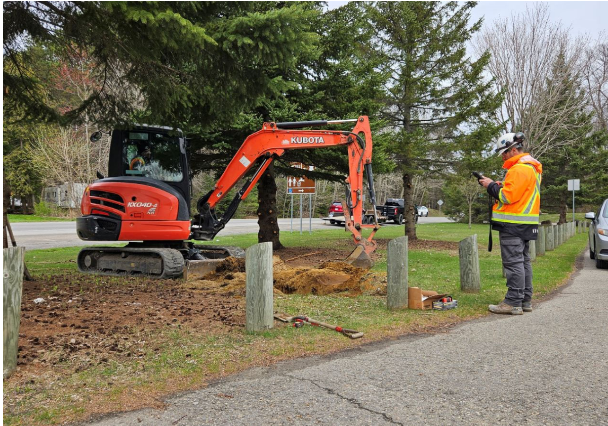
Photo 9. Réalisation de la tranchée HYD2329-LAC-1B, vue vers le nord-ouest (HYD2329-24-NUM2-011)
