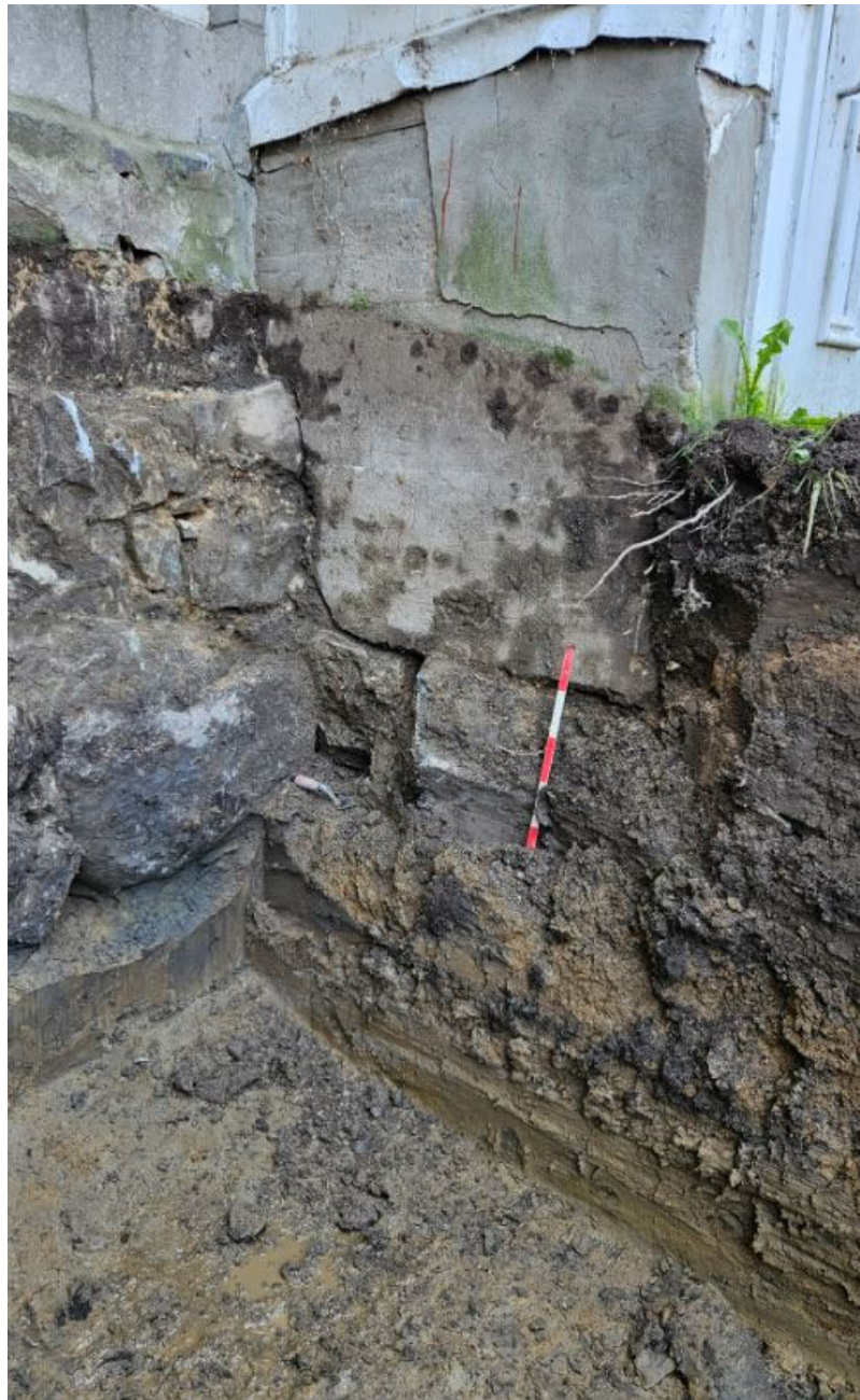
Photo 7. Aspect de la fondation du tambour; aucun liant n'est observé entre les pierres de la première assise, vue vers le sud-ouest (BjFi-20-NUM1-044)
