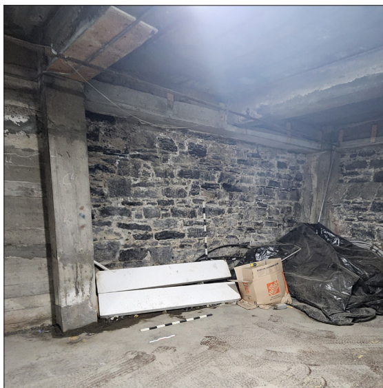
Photo 3.20 : Vue générale du mur 1B100, vue vers le nord-ouest. Extrémité sud cachée par un pilier et un mur en béton et angle nord caché par un pilier en béton. Photo N1-3.
