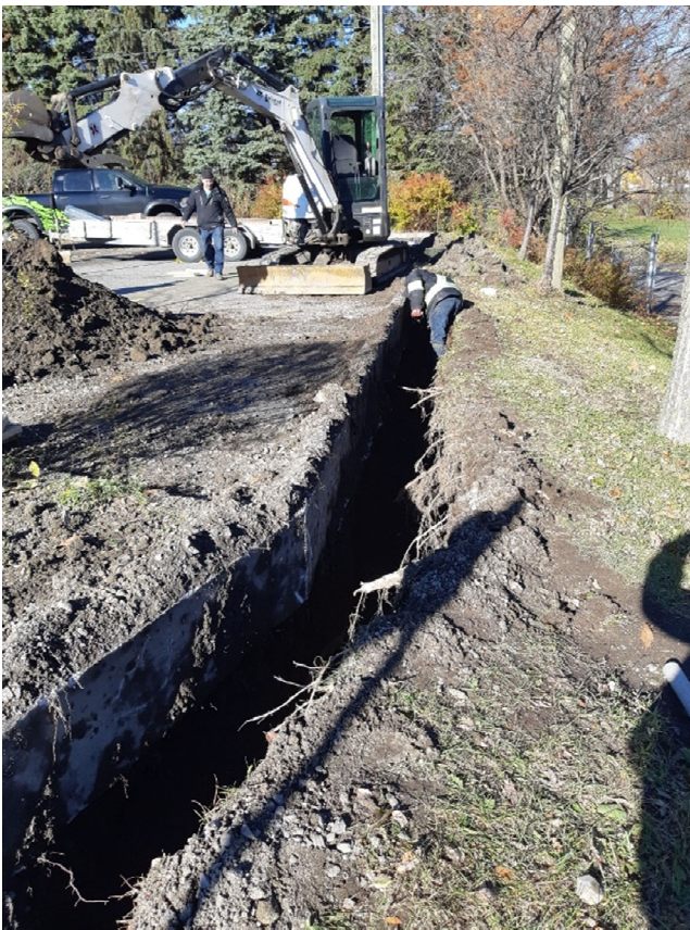
Photo 14. Tranchée 34C excavée à partir du poteau est, vue vers le nord (CeEt-600-24-NUM4-21)
