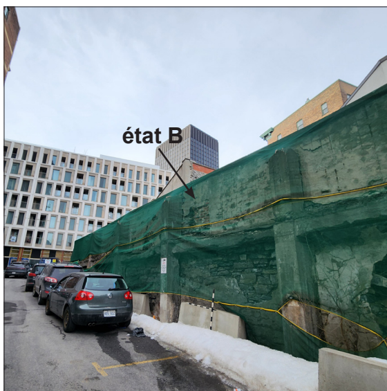
Photo 3.10 : Section 3, parement ouest, vue vers le nord-est. Photo N1-53.
