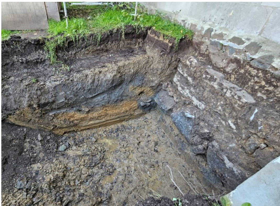
Photo 6. Le mur de fondation a été nettoyé, permettant d'observer son mode de construction et les détails de son assise inférieure, vue vers le sud-est (BjFi-20-24-NUM1-042)
