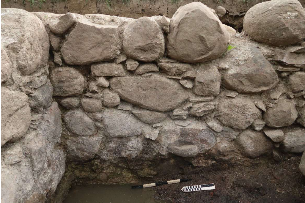
Figure 51 : Vue en élévation du parement ouest du vestige 19A200, soit l'intérieur de la structure 3 (24NU19A-13-26).
