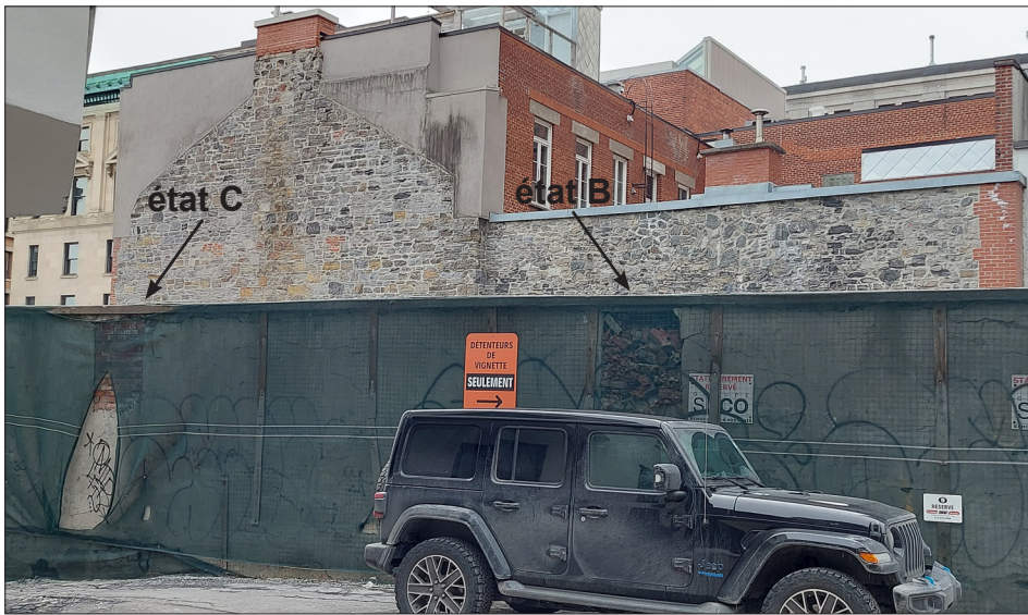
Photo 3.14 : Section 3, parement est. États B et C (en brique) visibles dans la portion supérieur du mur. Photo N2-50.
