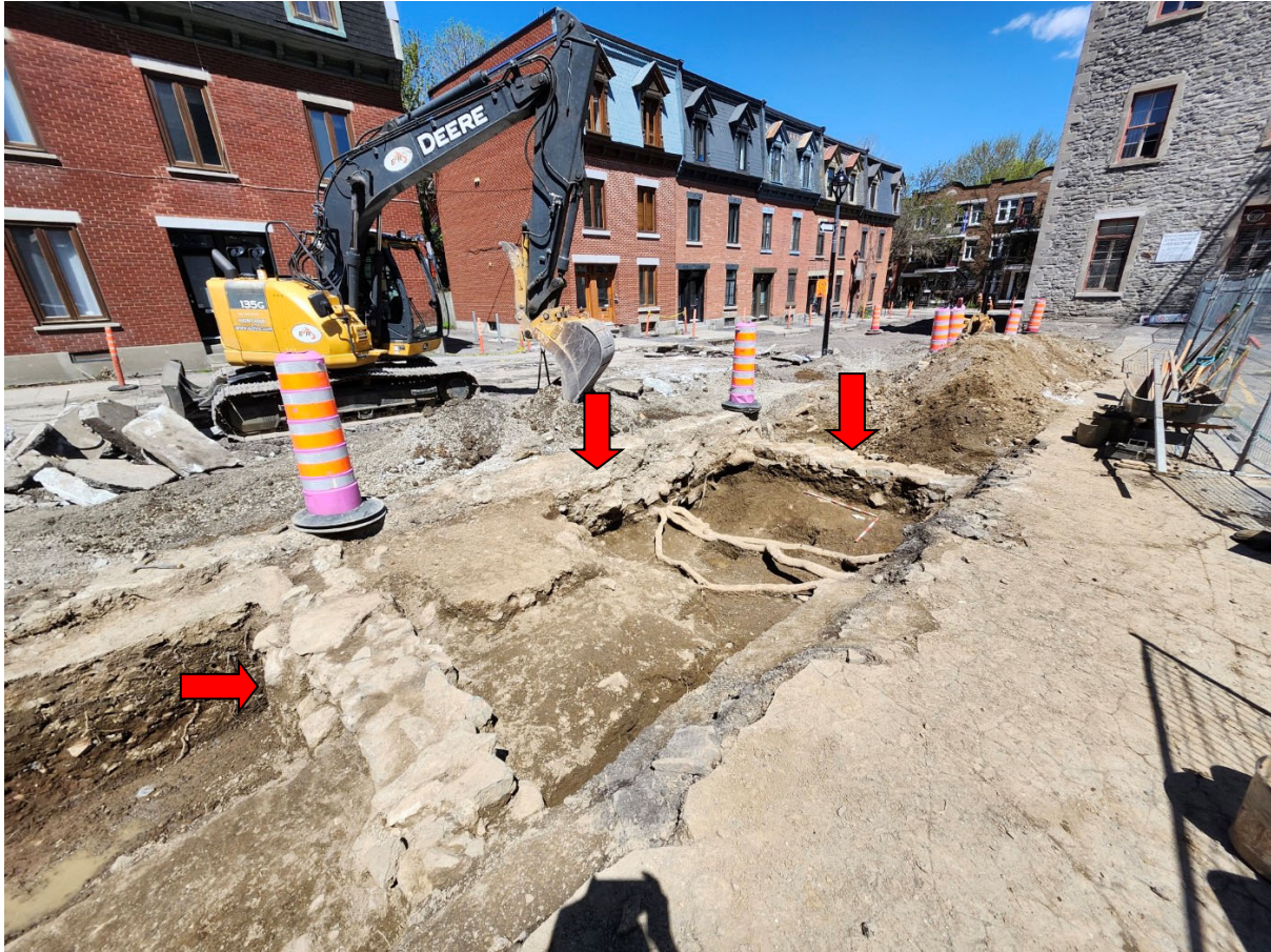
Photo 3. Vue générale des fondations 4A16 (à droite), 6L17 (au centre) et 4A17 (à gauche) de la maison Robert Dalglish, vue vers le nord-est (BjFj-165-2024-NUM1-457)
