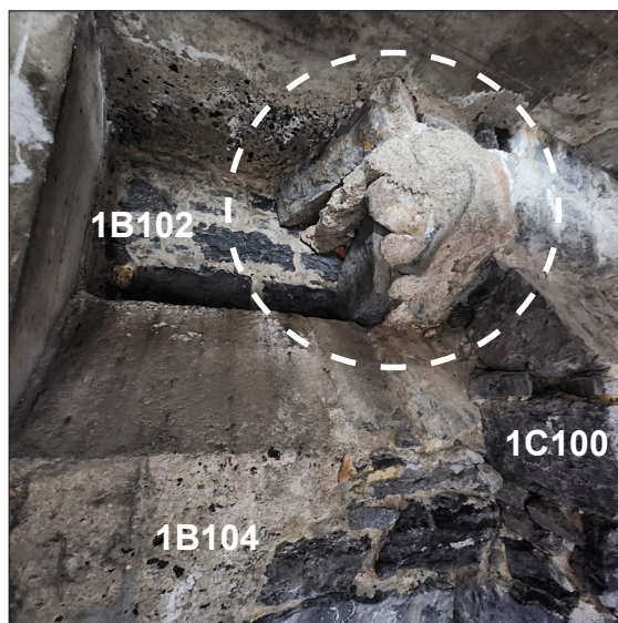
Photo 3.33 : Blocage cachant la liaison entre 1C100 (à droite) et 1B102 (à gauche), vue vers le sud-est. Photo N1-28.
