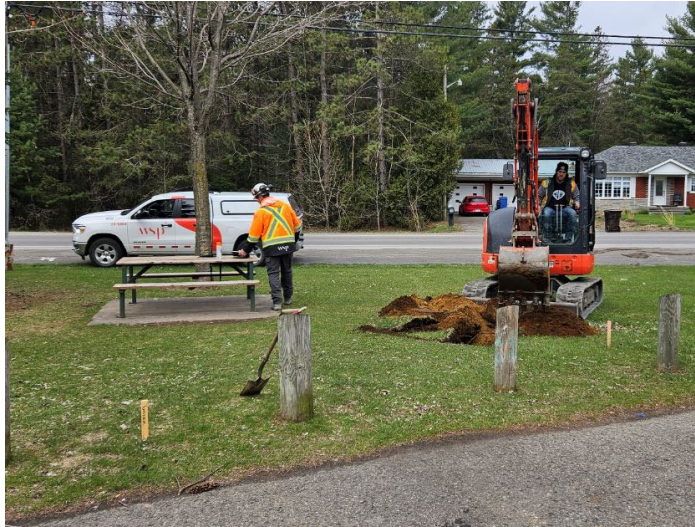
Photo 7. Réalisation de la tranchée HYD2329-LAC-1A, vue vers l'ouest (HYD2329-24-NUM2-006)
