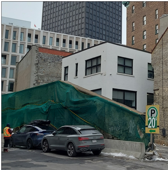
Photo 3.17 : Section 4, parement ouest, vue vers le nord-est. Photo N2-45.
