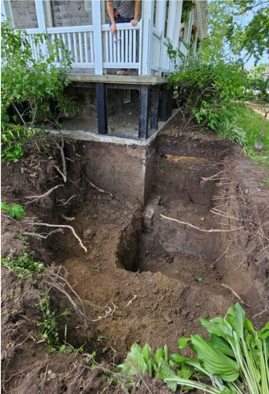
Photo 1. Située au coin nord-ouest du bâtiment, la tranchée 9B était adossée au mur de béton de la galerie, vue vers le sud (BjFi-20-24-NUM1-014)
