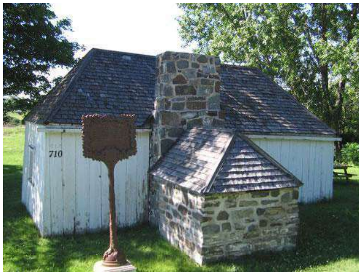
Figure 64 : Exemple de four à pain dans le contre-cœur d'une cheminée (Site patrimoniale Philippe-Aubert-de-Gaspé, à Saint-Jean-Port-Joli).
