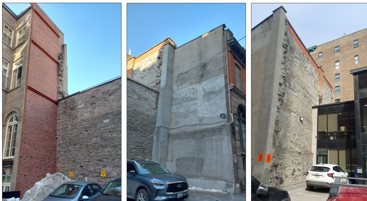
Photo 3.23 : Prolongement vers le sud du mur est de l'entrepôt (à gauche), angle nord-est (centre) et angle nord-ouest (à gauche). Ces photos montrent l'intégration des murs déjà existants de l'entrepôt dans la construction des bâtiments adjacents. Photos N2-2, N2-3, N2-20.
