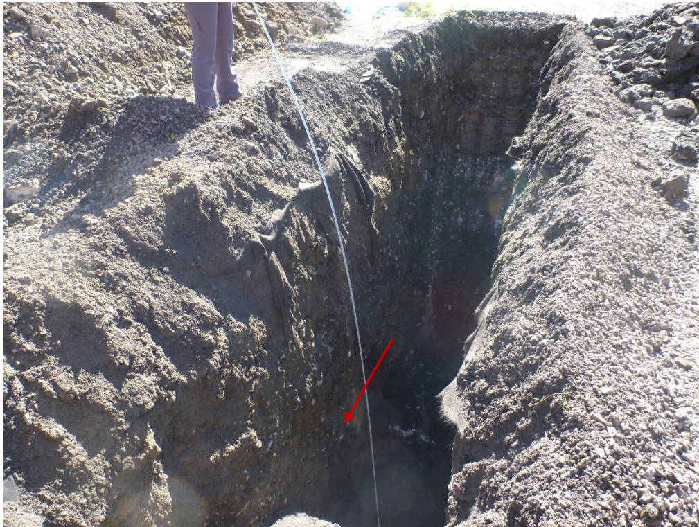
Photo 2. Sous-opération 14B, parois est et sud de la tranchée, vue vers le sud-est (Bifj-100-2024-NUM1-11). La flèche indique la masse de béton observée lors de l'excavation.
