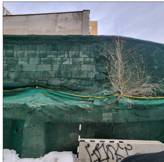
Photo 3.7 : Section 2, parement ouest. Vestiges de plancher de béton appartenant à un bâtiment disparu côté ouest. Photo N1-49.
