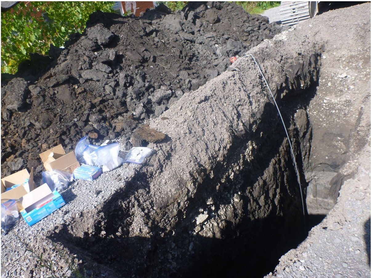
Photo 5. Sous-opération 14E, parois nord et est de la tranchée, vue vers le nord-est (BiFj-100-2024-NUM1-33).
