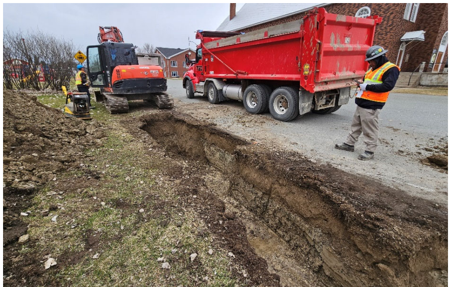
Photo 1. À l'extrémité nord de la tranchée 1B, une extension a été aménagée afin d'installer deux conduits à relier éventuellement, vue vers le nord-est (HYD2329-NDN-NUM1-019).
