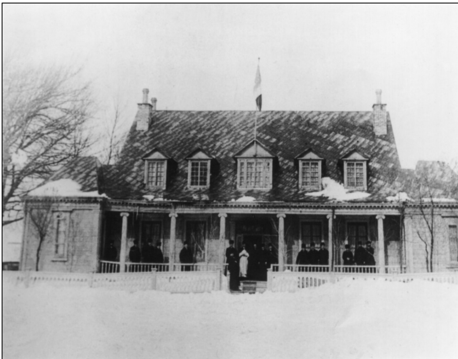
Figure 6. Le troisième presbytère (1832-1896), vers 1882 (Collection Chrétien Zaugg, SHIP). Selon un contrat de construction datant du 4 juillet 1832, le corps principal devra avoir des dimensions de 48 pieds x 36 pieds de dehors en dehors (Bureau et al. 1979 : 118)
