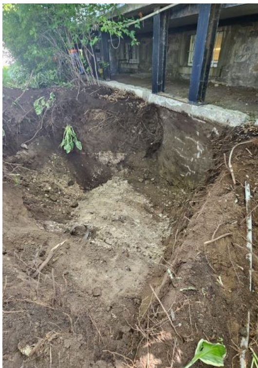
Photo 2. Aspect de la tranchée BjFi-20-9A; une couche de démolition est dégagée, vue vers le nord-est (BjFi-20-24-NUM1-003)
