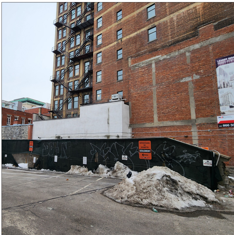
Photo 3.5 : Section 1, extrémité nord, parement est caché par une toile de protection, vue vers le sud-ouest. Photo N1-67.
