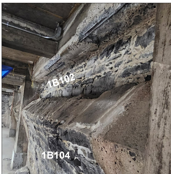
Photo 3.22 : Mur 1B102 partiellement visible au-dessus de 1B104, vue vers le nord-est. Photo N1-21.
