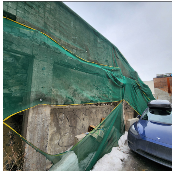
Photo 3.18 : Section 4, parement ouest, vue vers le sud-est. Photo N1-60.
