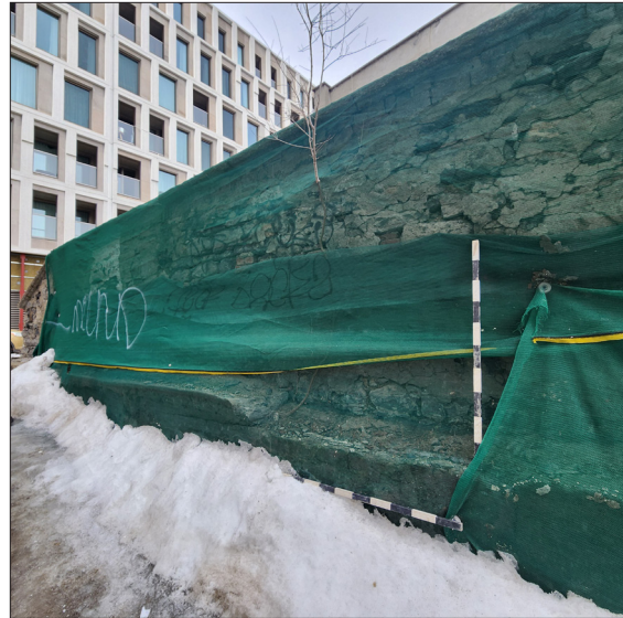
Photo 3.4 : Section 1, parement ouest et vestiges de plancher en béton appartenant à un bâtiment disparu, côté ouest. Photo N1-40.
