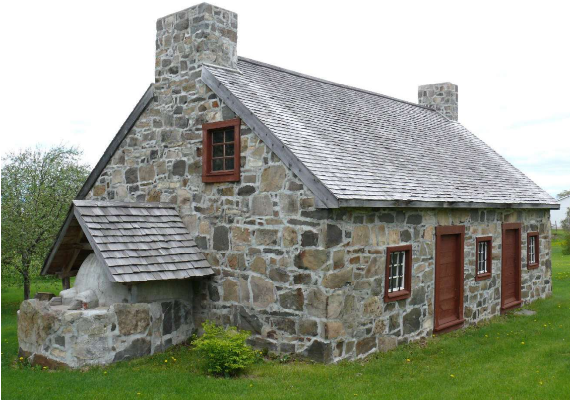
Figure 65 : Exemple de fournil (four à pain) dans la municipalité de l'Islet (Saint-Roch-des-Aulnaies).
