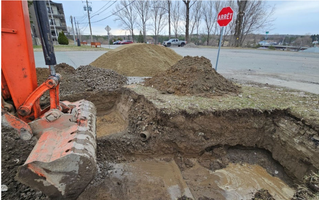
Photo 2. Dans l'axe nord-sud, un ancien fossé comblé de galets de rivière et contenant un tuyau de drainage de plastique, a été observé, vue vers le sud-est (HYD2329-24-NUM1-009)
