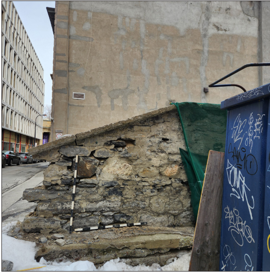
Photo 3.1 : Section 1, extrémité nord, parement ouest, vue vers l'est. Photo N1-36.
