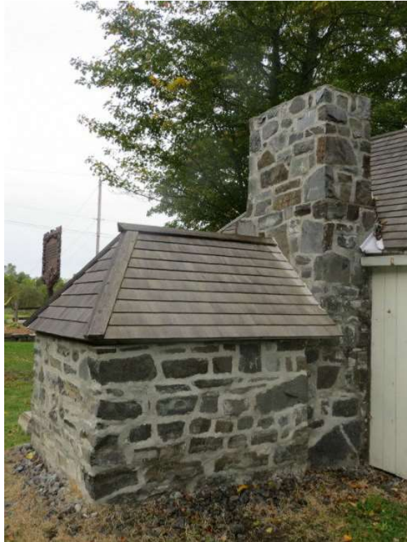
Figure 63 : Exemple de four à pain dans le contre-cœur d'une cheminée (Site patrimoniale Philippe-Aubert-de-Gaspé, à Saint-Jean-Port-Joli).
