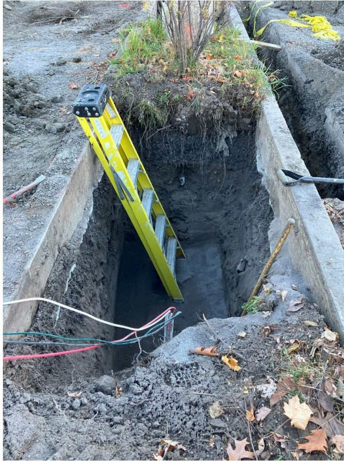
Photo 16. Tranchée pour la borne satellite, vue vers l'est (CeEt-600-24-NUM5-1)
