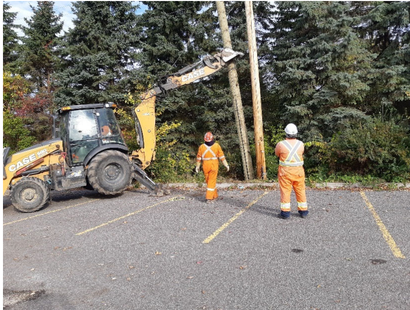
Photo 11. Nouveau poteau installé en bordure nord du stationnement, vue vers le nord (CeEt-600-24-NUM4-9)
