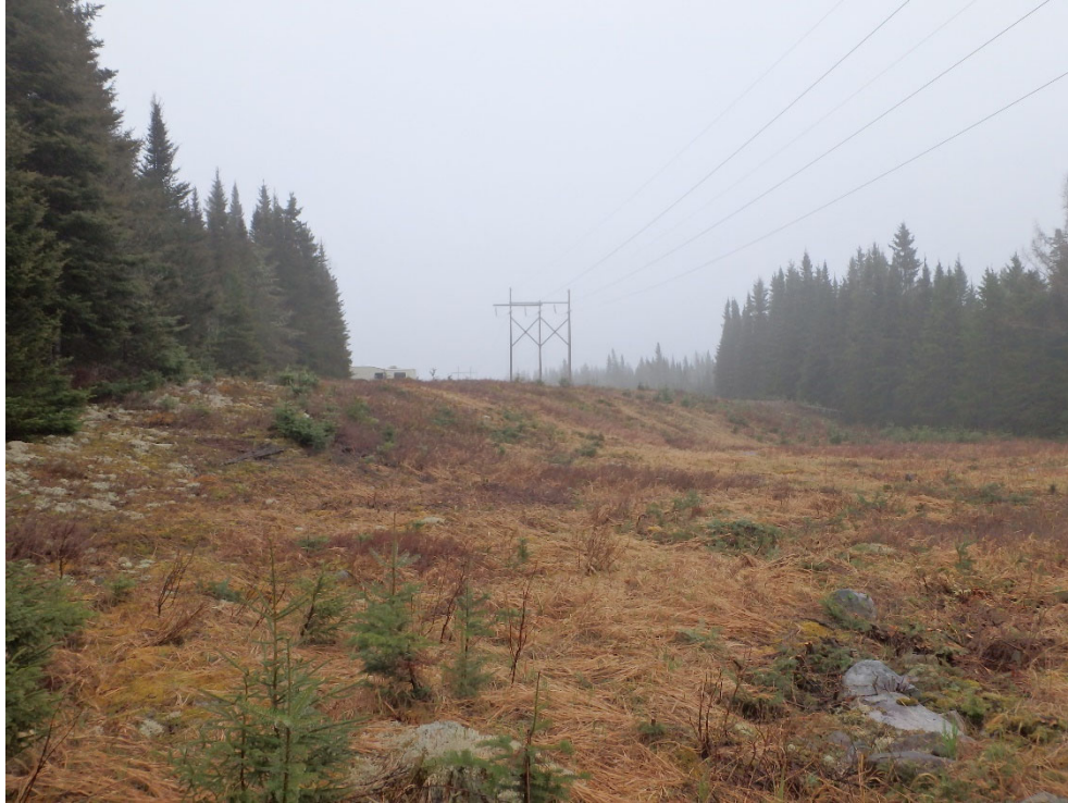
Photo 12. Zone P31, vue de la partie nord, vers le sud-est (HYD2356-2024-NUM1-71)
