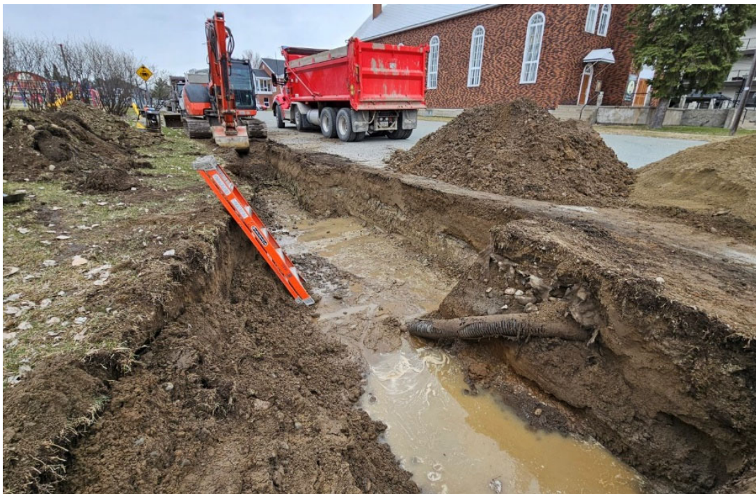
Photo 3. Aspect des excavations et du tuyau de drainage, vue vers le nord-est (HYD2329-24-NUM1-015)
