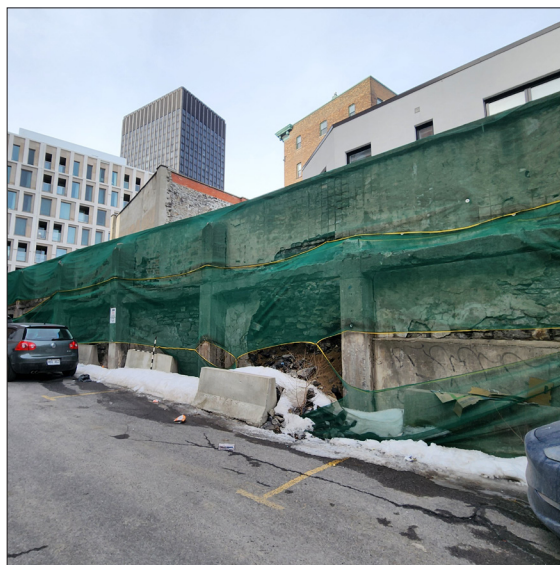
Photo 3.11 : Section 3, parement ouest, vue vers le nord-est. Photo N1-55.
