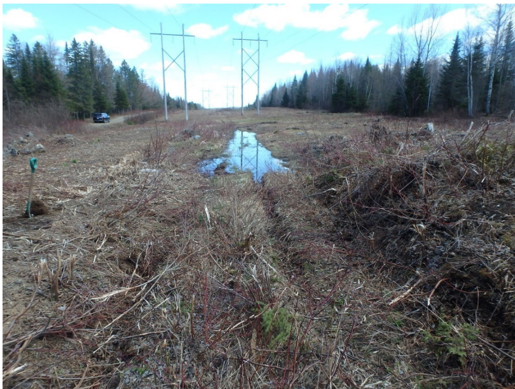
Photo 23. Zone P49, vue d'une portion décapée et inondée, vers le nord-est (HYD2356-2024-NUM1-25)
