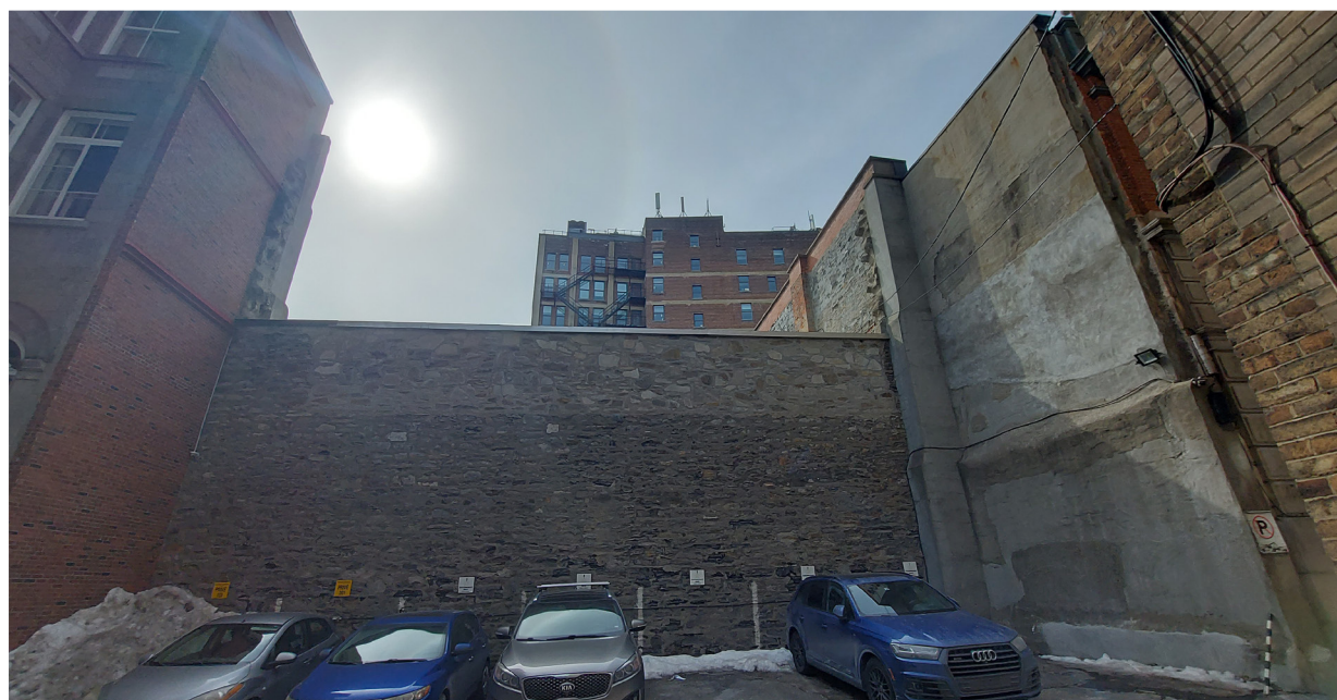
Photo 3.24 : Parement est du mur est de l'entrepôt, vue depuis le terrain voisin à l'est. Photo N2-25.
