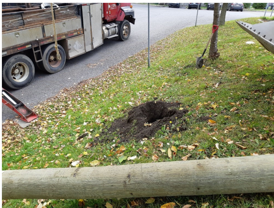
Photo 13. Localisation du trou de poteau 34B, vue vers le sud (CeEt-600-24-NUM4-12)
