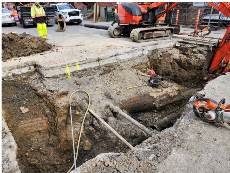
Photo 21. Égout en brique dans la rue Sainte-Rose, vue vers le nord-est (BjFj-165-2024-NUM1-11)
