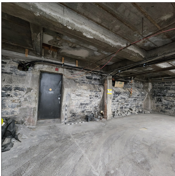
Photo 3.25 : Vue générale du mur 1B103, vue vers le nord-est. Photo N1-6.
