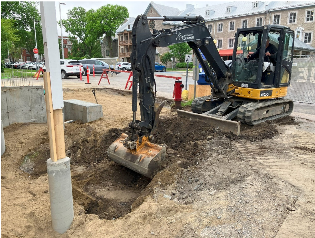
Photo 11. Début de l'excavation de la sous-opération 33H, vue vers le sud-sud-ouest (CeEt-600-24-NUM3-4)
