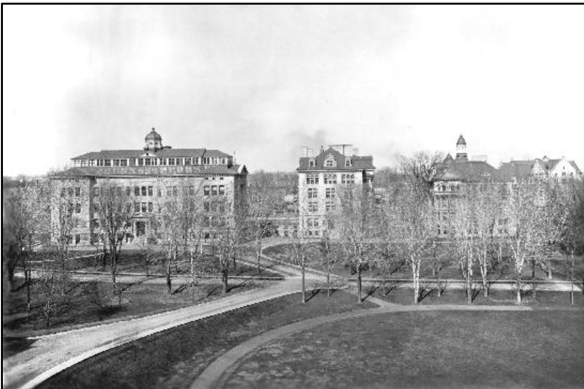
Figure 14: Photo de l'allée centrale prise avant 1907. Site web de l'université McGill. Archives Notman.
