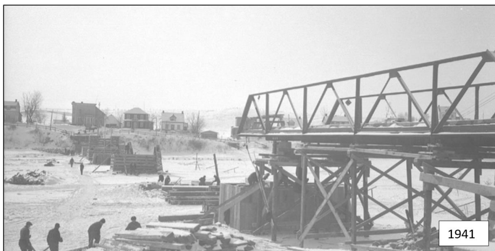
Figure 11. Photographie datée de 1941 de la construction du troisième pont de Sainte-Geneviève-de-Batiscan, vue vers le sud (BANQ, Pont permanent à de Sainte-Geneviève-de-Batiscan, comté de Champlain, 1941, E6, S7, SS1, D2, P5623)
