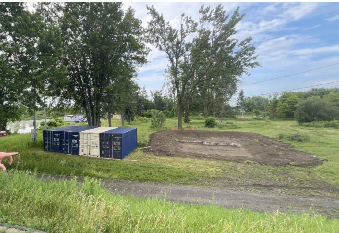
Figure 1.1 Photo du bassin de décantation excavé le 30 juin 2023, vue vers le sud-est. (source: avis de découverte).
