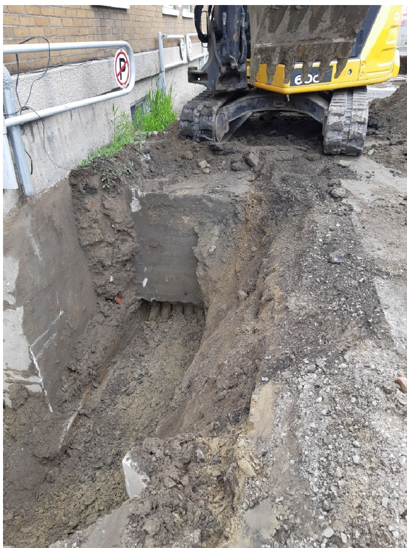
Photo 7. Massif de béton dans la sous-opération CeEt-600-33D (CeEt-600-24-NUM1-36)
