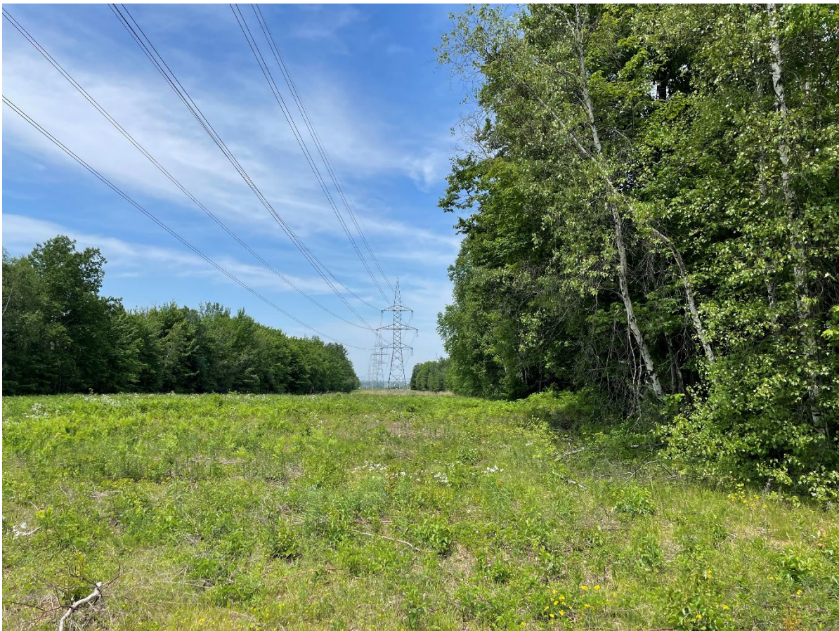
Figure 37 : Environnement général de la zone W-2, vers le Nord
