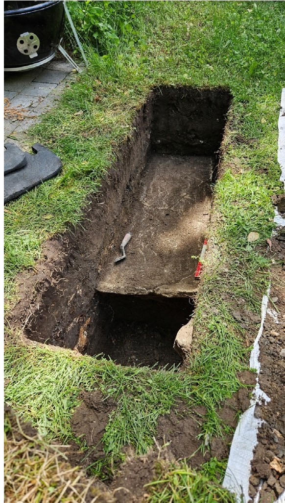
Photo 3. Dalle de béton dans le sondage 1B, vue vers le sud-est (VDB2408-24-NUM1-09)
