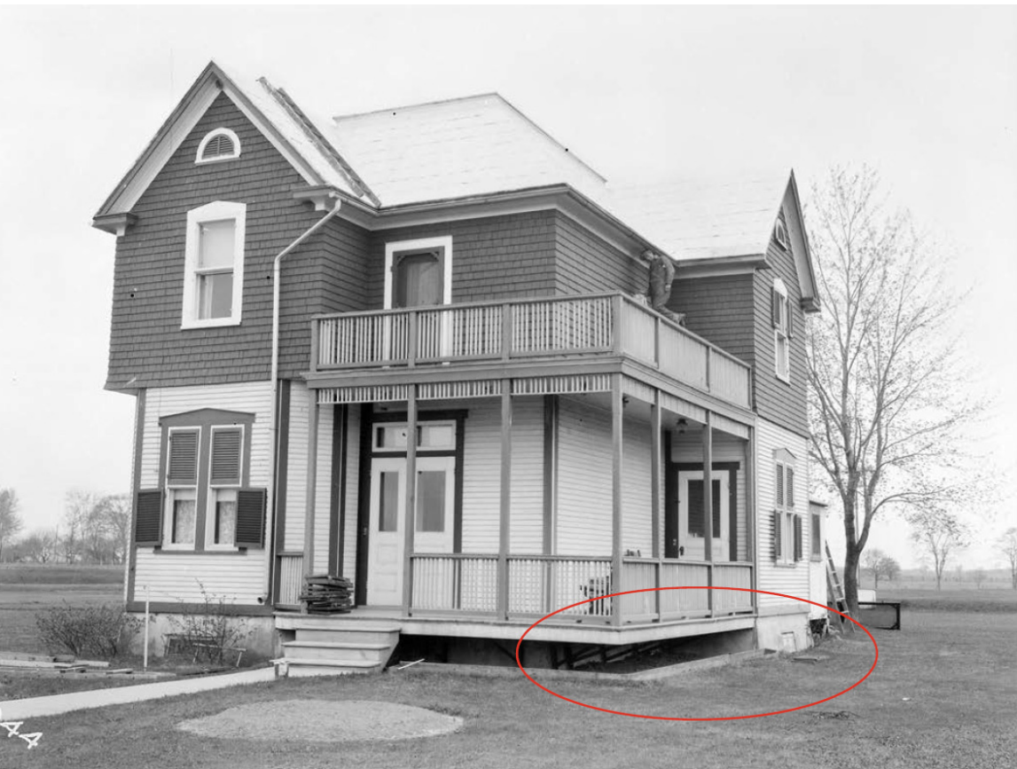
Figure 5.2 Section des fondations découverte indiqués sur la photo d'un cottage en bois de la centrale, photo prise le 14 mai 1930. (BAC-LAC, C-063813).
