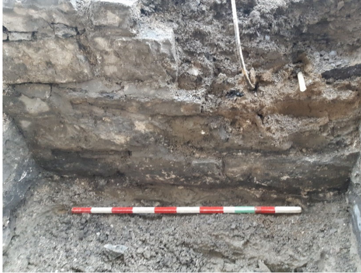
Photo 4. Mur nord du vestige 33B100 (CeEt-600-24-NUM1-19)
