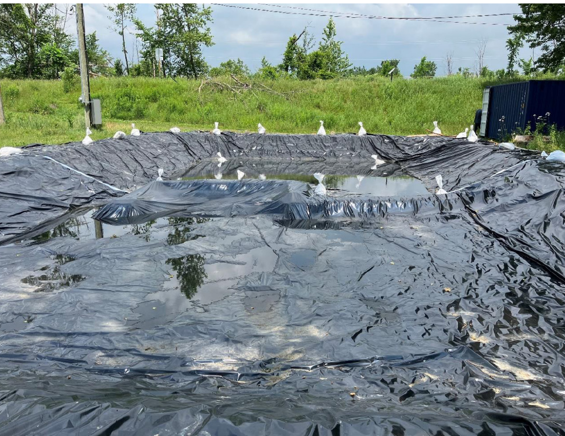
Figure 1.2 Photo de la membrane placée au dessus des vestiges au fond du bassin de décantation, vue vers le nord. (source: avis de découverte).
