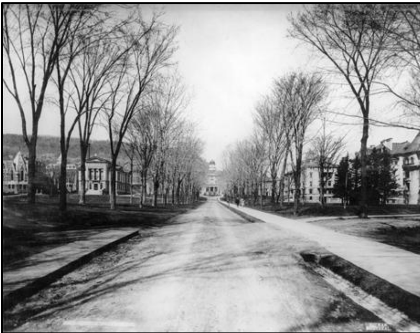
Figure 12: Photo de l'allée centrale prise avant 1907. Site web de l'université McGill. Archives Notman.
