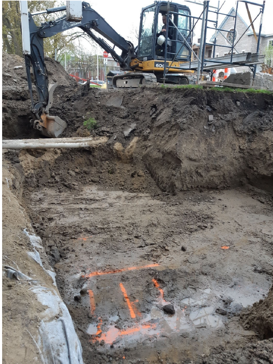
Photo 9. Excavation de la sous-opération CeEt-600-33F (CeEt-600-24-NUM1-62)
