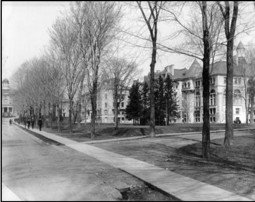
Figure 13: Photo de l'allée centrale prise avant 1907. Site web de l'université McGill. Archives Notman.
