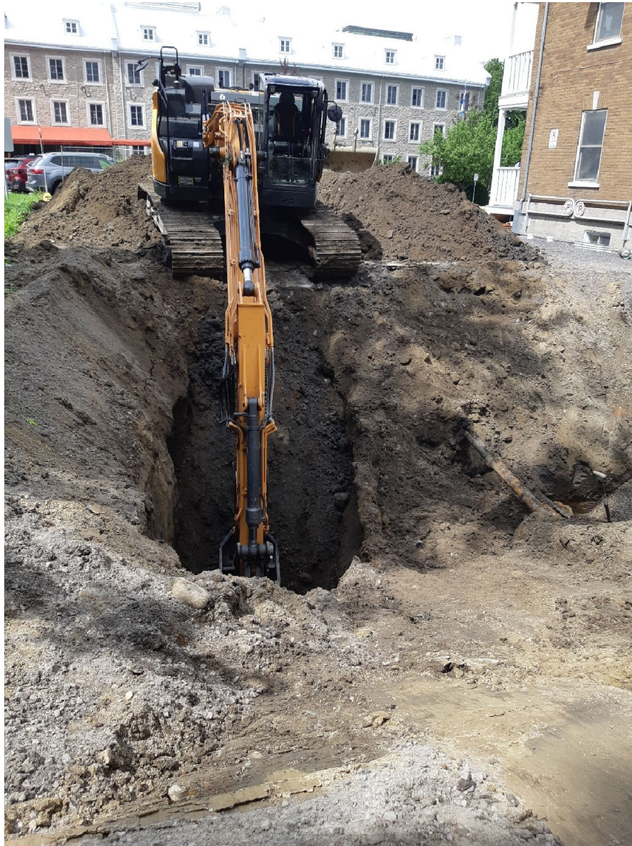
Photo 10. Excavation au-dessus de l'égout collecteur, vue vers l'ouest (CeEt-600-24-NUM1-81)
