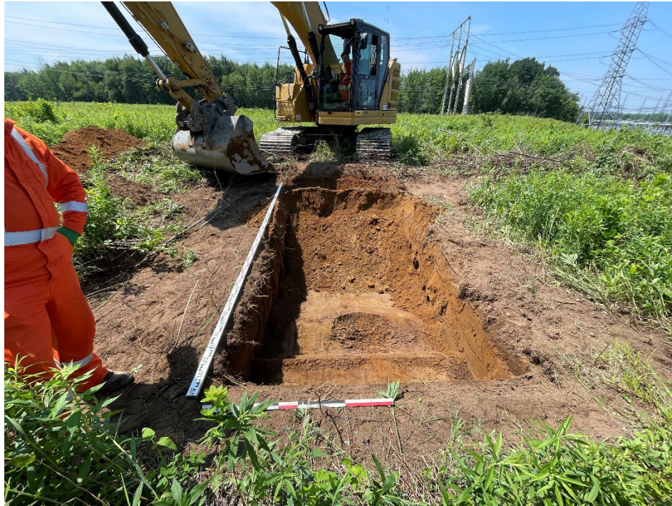
Figure 26 : Environnement de la tranchée TR-Coteau dans la zone P4-2, excavation en cours, vers l'ouest
