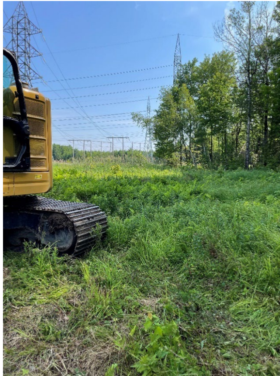
Figure 33 : Environnement général de la tranchée PU-T5-24 dans la zone P3-1
