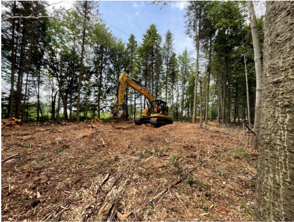
Figure 45 : Environnement de la tranchée PU-T3-24 dans la zone W-3, vers le nord
