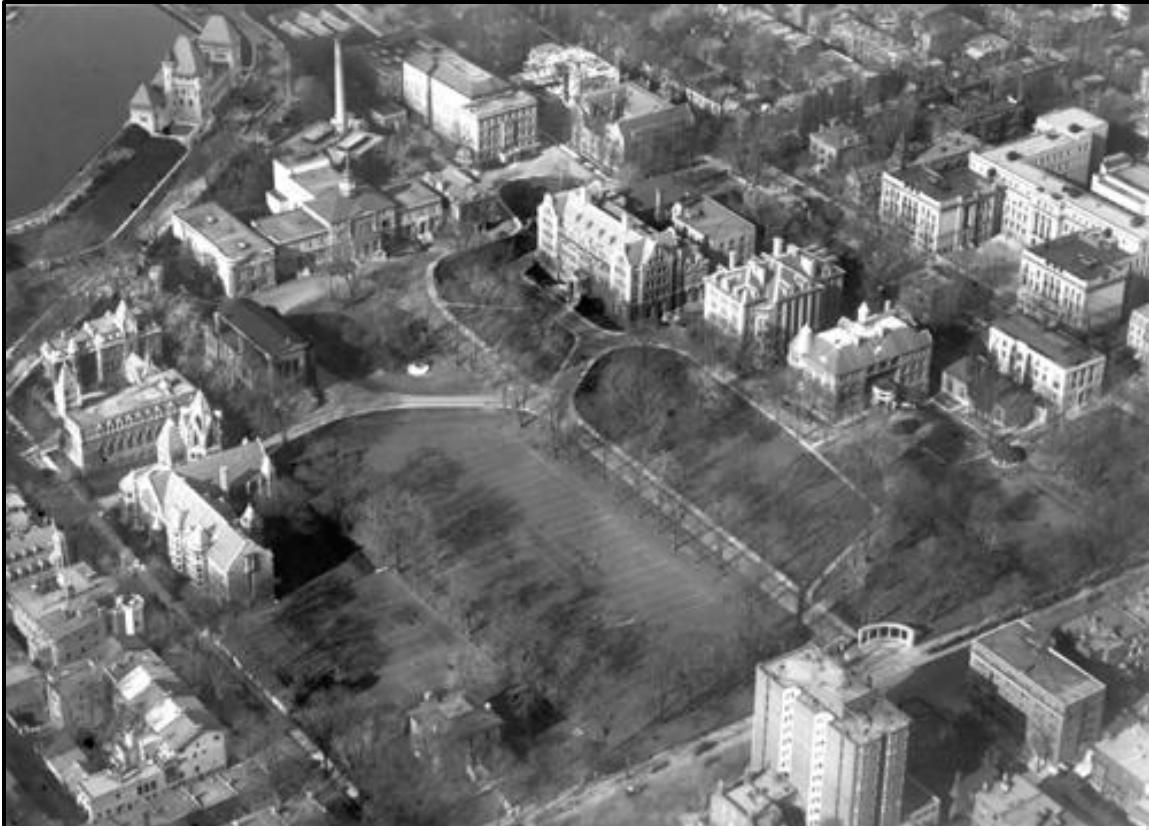
Figure 5 : Esplanade de l'université McGill en 1930. L'angle de la photo aérienne permet d'apprécier le relief. On observe le rehaussement au nord du pavillon Morrice et devant le pavillon des arts. Une pente abrupte semble suivre précisément le tracé de la rue en face du pavillon des arts en direction est. Passé ce pavillon, la pente forme un arc afin de contourner les bâtiments suivants. Ce tracé sinueux, mais gracieux, ne semble pas naturel. Il épouse trop bien les surfaces asphaltées.
