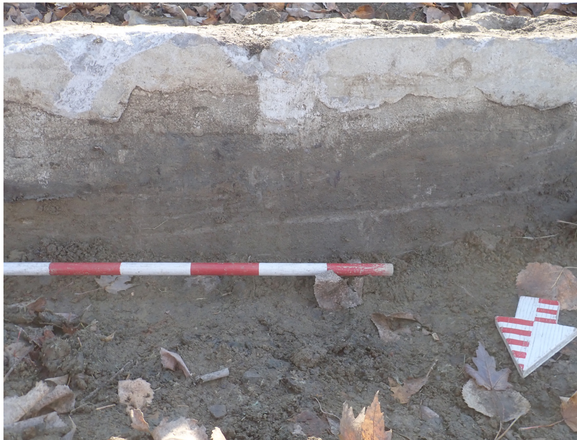
Photo 4.3 Crépigris et baveux couvrant partiellement le parement nord des sections 1A103 et 1A105, vue vers le sud (PATR23N18_0120).
