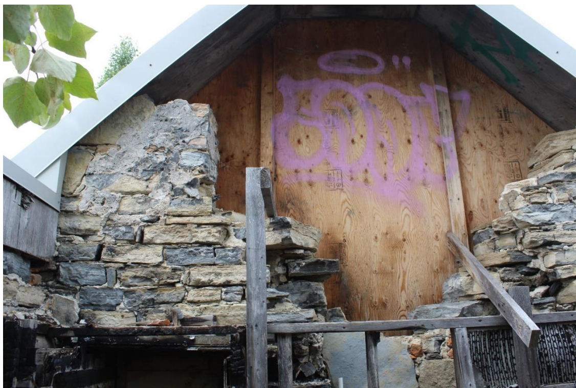
Photo 67 : Tableau d'une fenêtre dans le mur nord du fournil (6B500).
