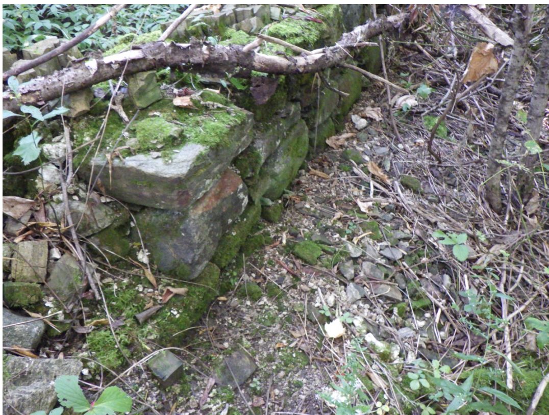
Photo 12 Vue extérieure du mur nord des fondations, photo prise vers le sud-ouest
