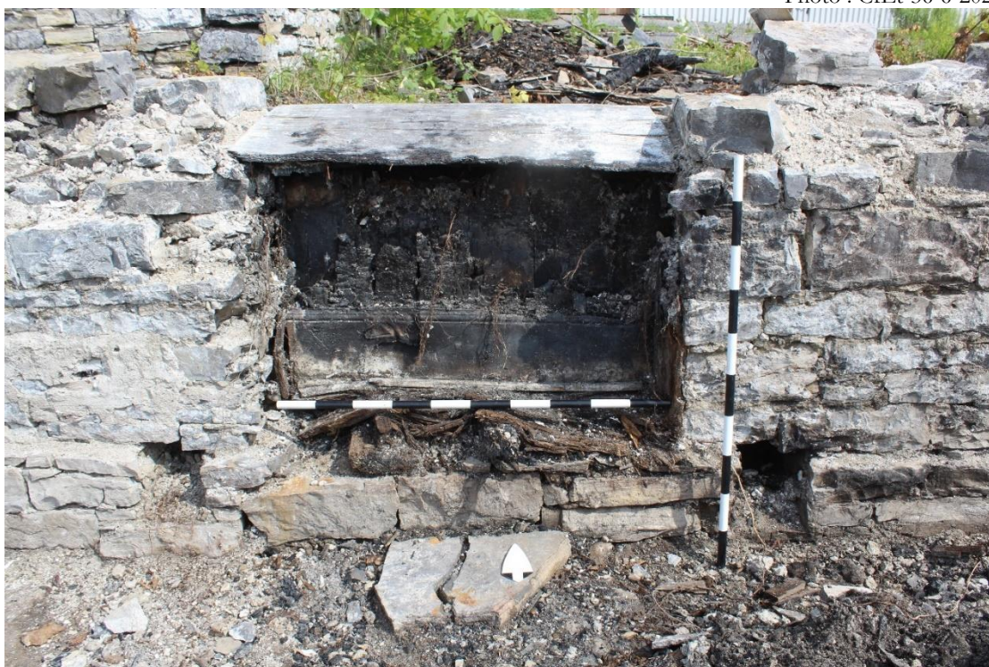
Photo 33 : Gros plan sur l'ouverture dans la portion est du mur nord 6A500.
