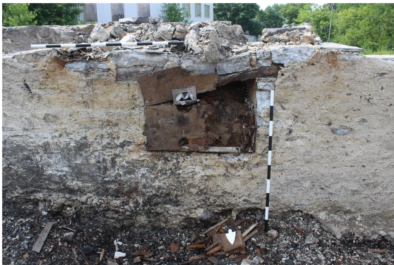
Photo 5 : Ouverture dans la partie centrale du parement nord du mur de fondation 6A300.
