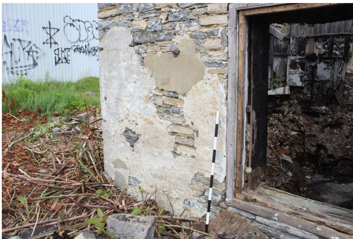
Photo 63 : Différents recouvrements du mur extérieur ouest 6B200.
