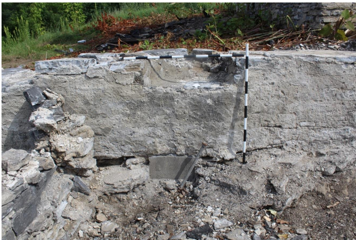
Photo 45 : Bloc de béton et tuyau de fer sous les fondations du mur nord 6A500.
