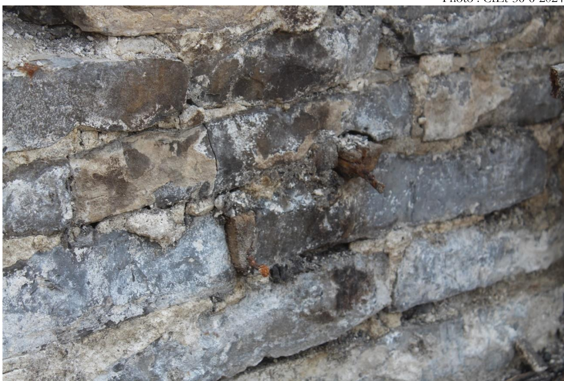
Photo 31 : Coins de bois fichés dans le parement intérieur du mur est de l'agrandissement de 1816, 6A400.
