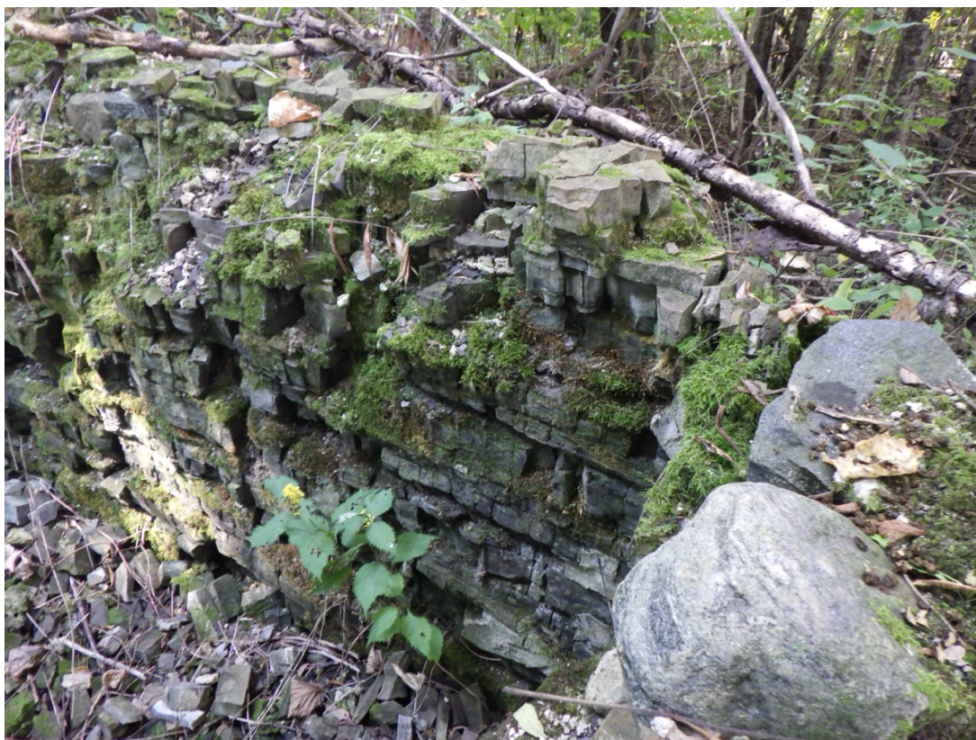
Photo 14 Mur ouest des fondations, photo prise vers le sud-ouest
