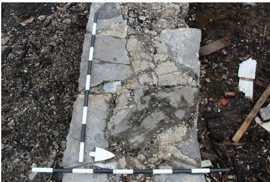
Photo 47 : Exemple de ciment utilisé pour renforcer l'assise des poutres des fondations de la portion de la maison bâtie en 1810.
