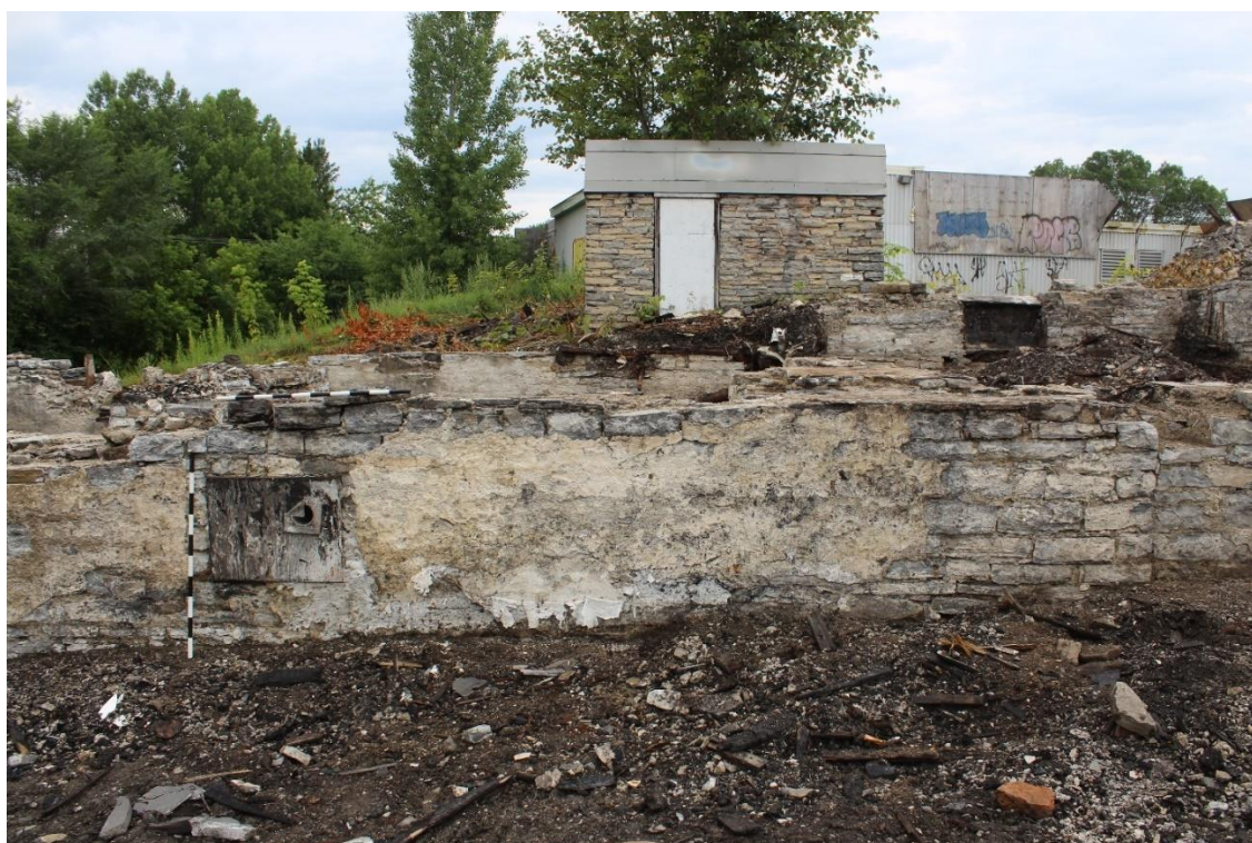
Photo 2 : Parement sud du mur de fondation 6A300. On peut voir, à droite sur la photo, la fin de l'état 6A300a et le début de l'état 6A300b.
