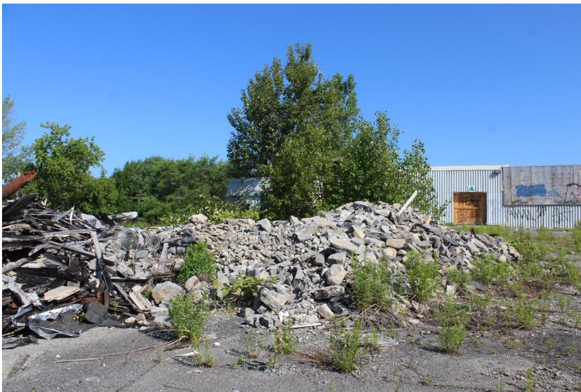
Photo 24 : Décombres de la maison dans la portion est. Vue vers le nord.
