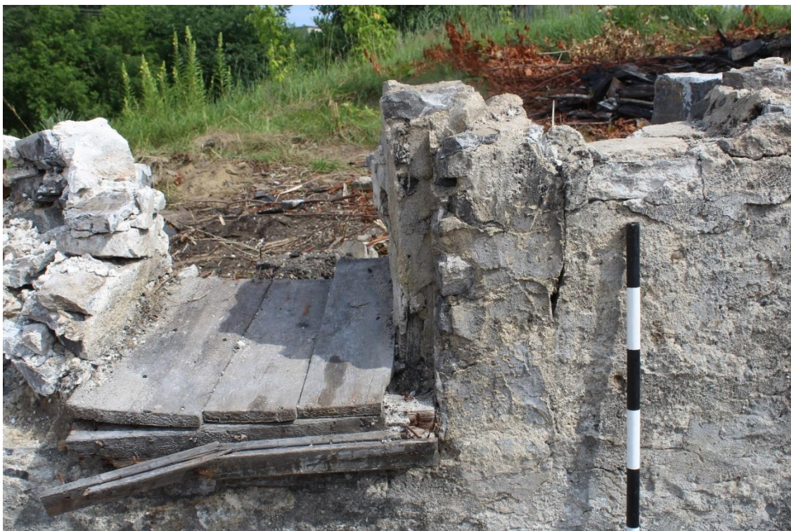
Photo 13 : Ouverture dans le mur 6A500. Vue partielle rapprochée du côté est, bouché par un assemblage de pierres. À droite de l'échelle photo, on peut voir la portion ajoutée pour réduire la largeur de l'ouverture.
