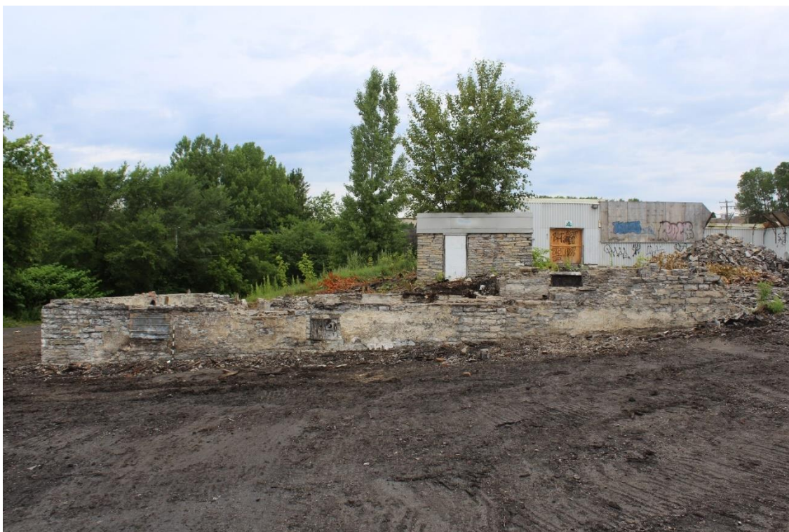
Photo 1 : Parement sud du mur de fondation 6A300.
