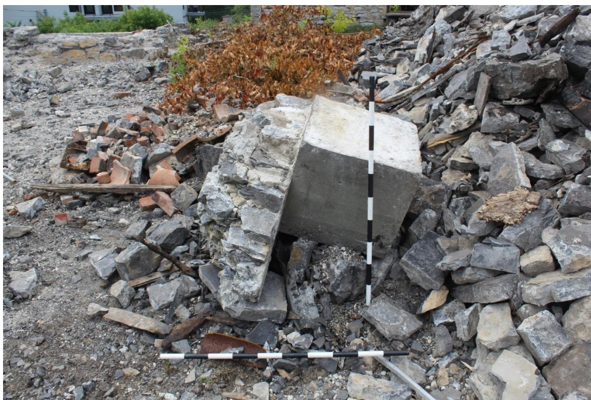
Photo 23 : Bloc de béton lié à un pan de maçonnerie, hors de son contexte.
