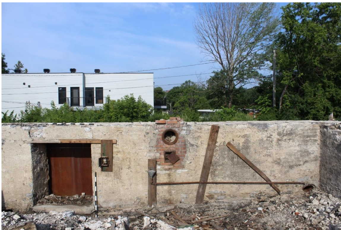
Photo 36 : Parement intérieur du mur ouest de la maison, 6A200.
