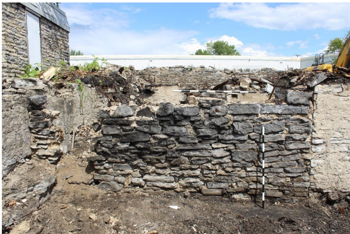
Photo 39 : Parement ouest du mur transverse 6A600.
