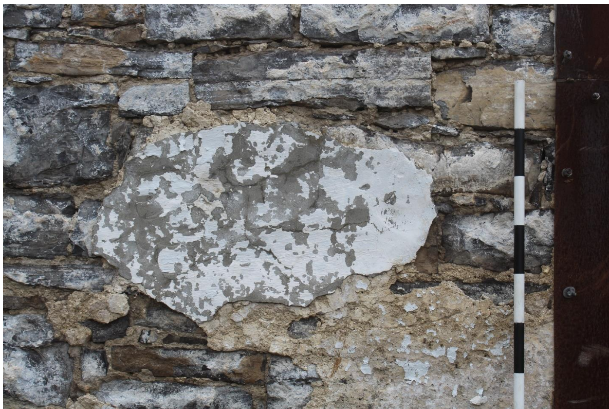
Photo 56 : Placage de ciment sur le parement extérieur du mur ouest 6A200.
