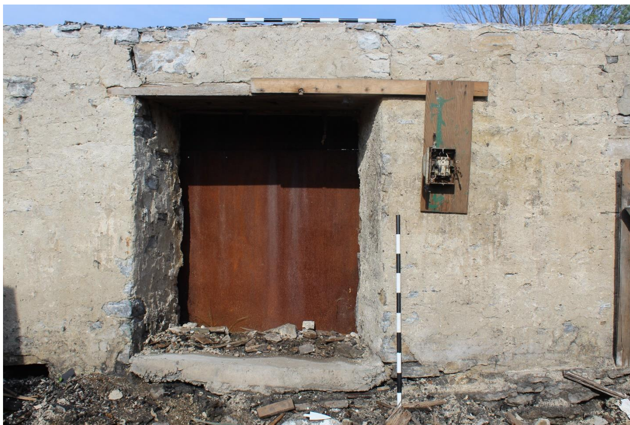
Photo 11 : Ouverture pour une porte dans le mur 6A200. Vue de l'intérieur.
