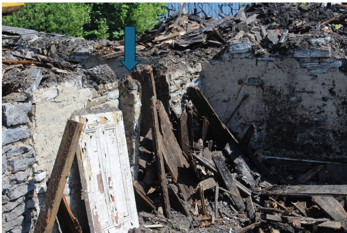
Photo 42 : Mur transverse 6A800 avant que ne soit arraché le cadre de la porte. La flèche pointe vers la portion nord du cadre de la porte, démolie par la pelle mécanique. Vue vers le sud-est.
