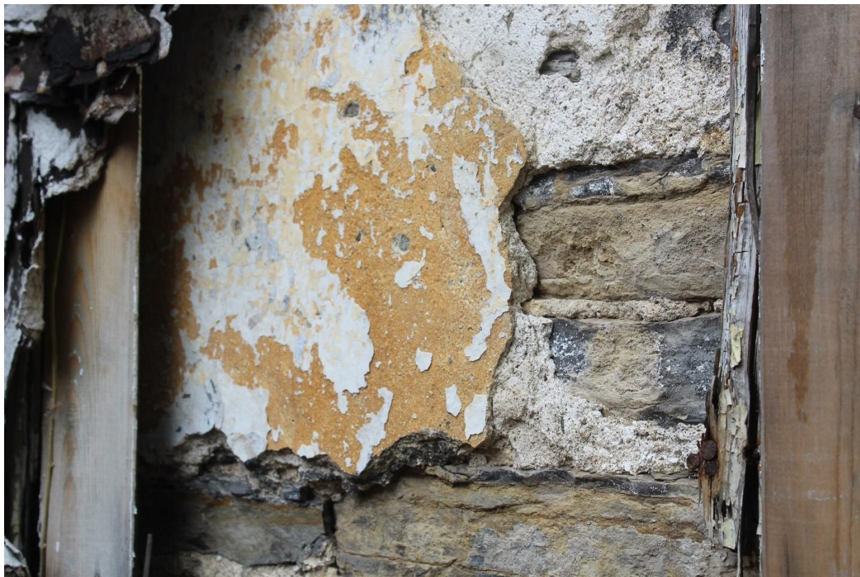
Photo 64 : Gros plan du crépi et de l'enduit sur un parement intérieur du fournil.
