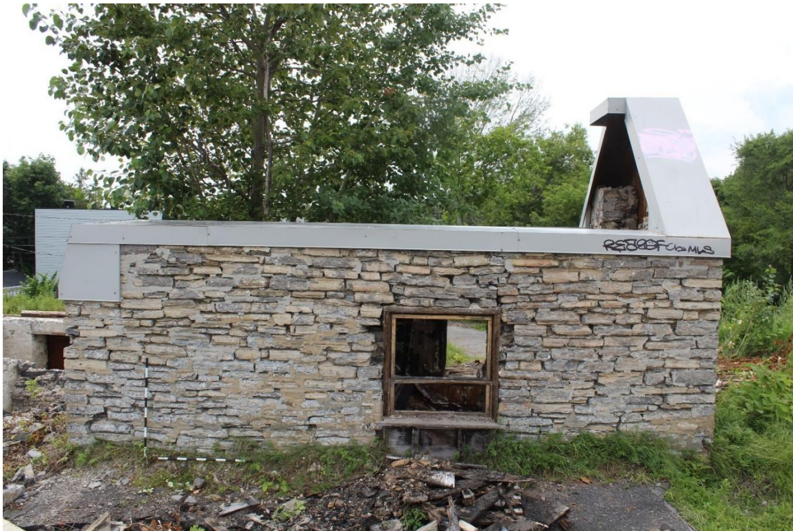
Photo 61 : Parement extérieur du mur est (6B400).
