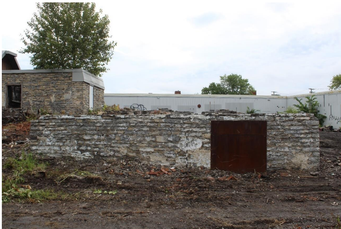
Photo 7 : Parement ouest du mur 6A200.
