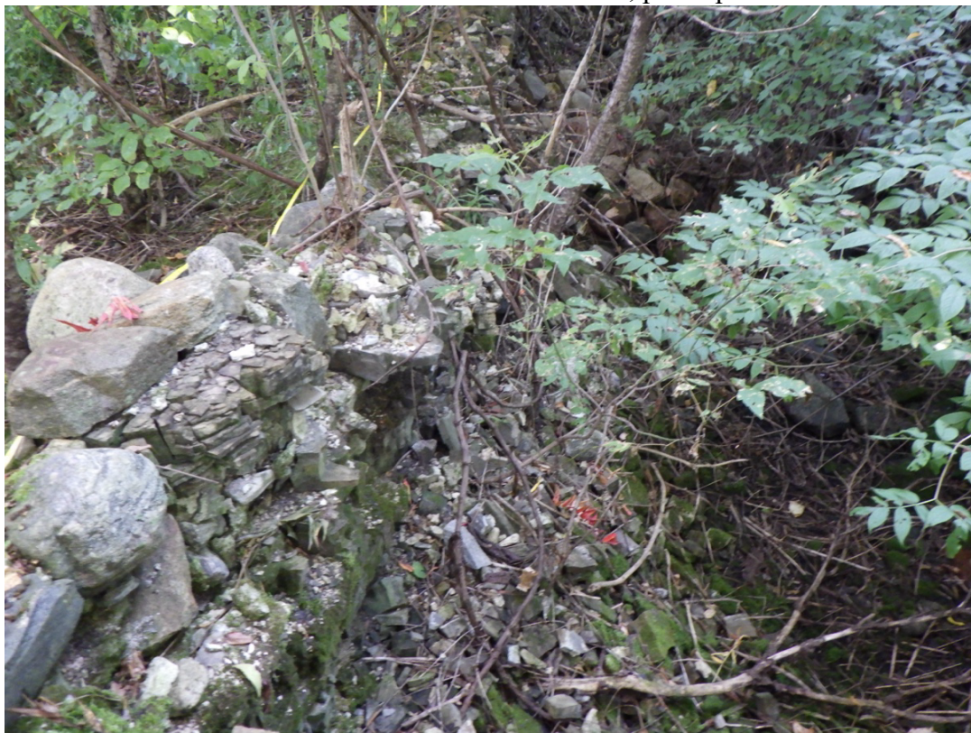
Photo 13 Vue intérieure du mur nord des fondations, photo prise vers le nord-est
