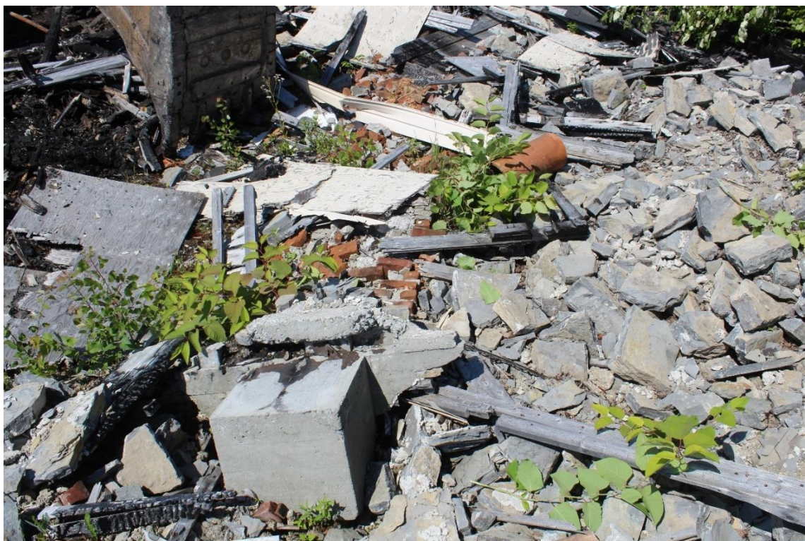
Photo 22 : Bloc de béton à l'extrémité de la concentration de brique correspondant à une cheminée. Vue vers l'ouest.
