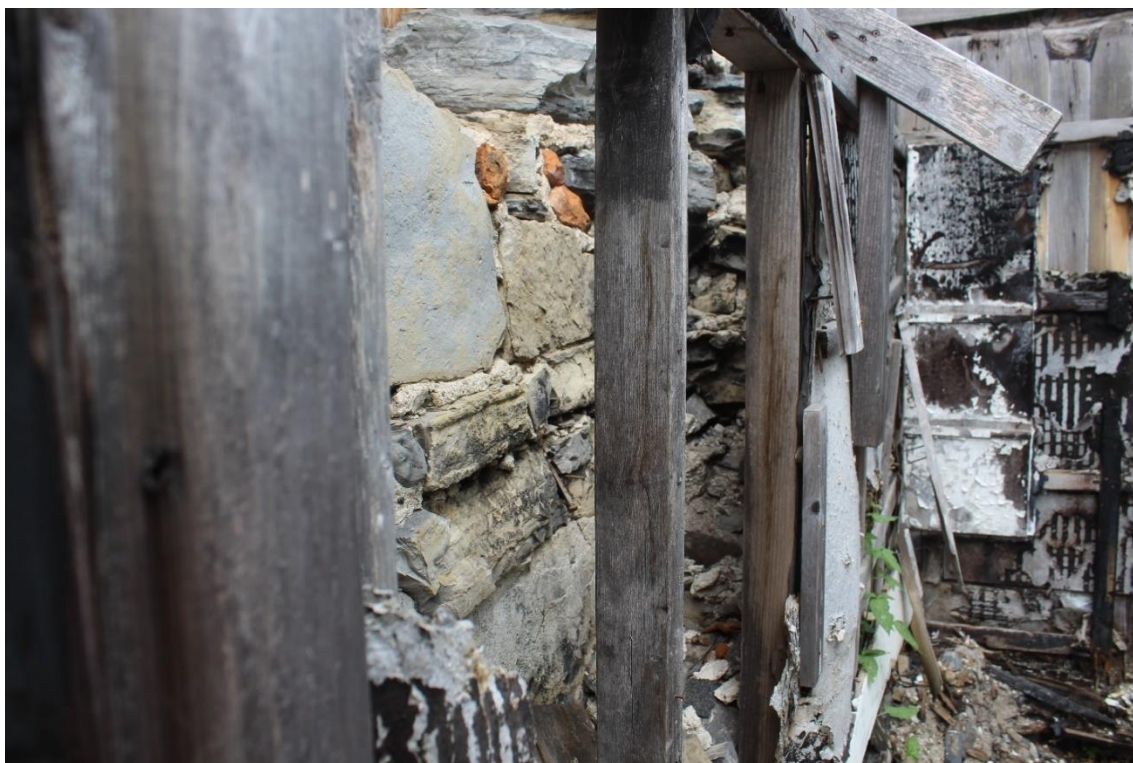
Photo 66 : Vue obstruée des briques présentes dans la forme creuse du parement intérieur du mur nord 6A500. Vue vers le nord-est.
