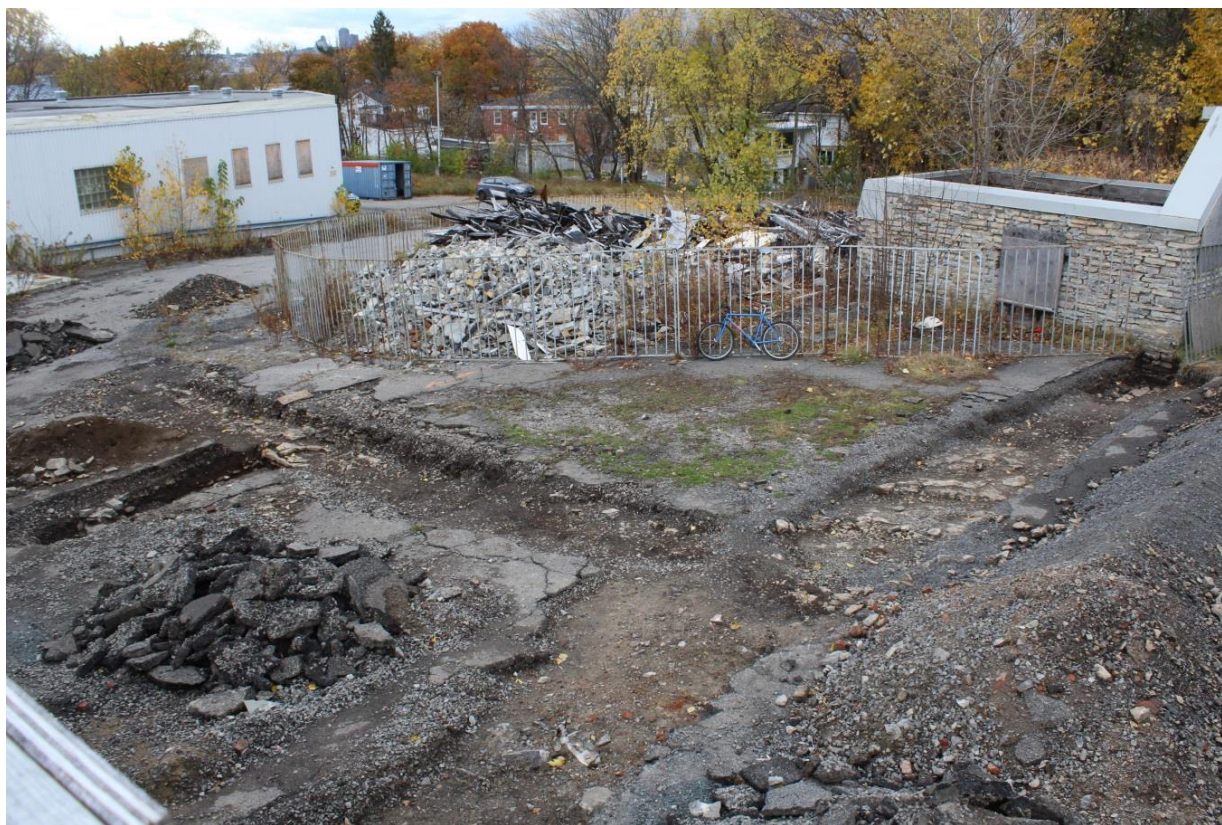
Figure 16 : Décombres de la maison Salaberry-Juchereau-Duchesnay à l'automne 2022.
