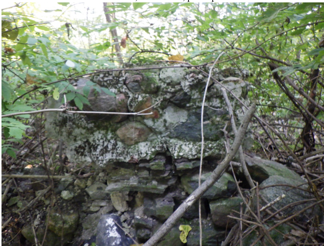
Photo 16 Vestiges de la cheminée, photo prise vers l'ouest
