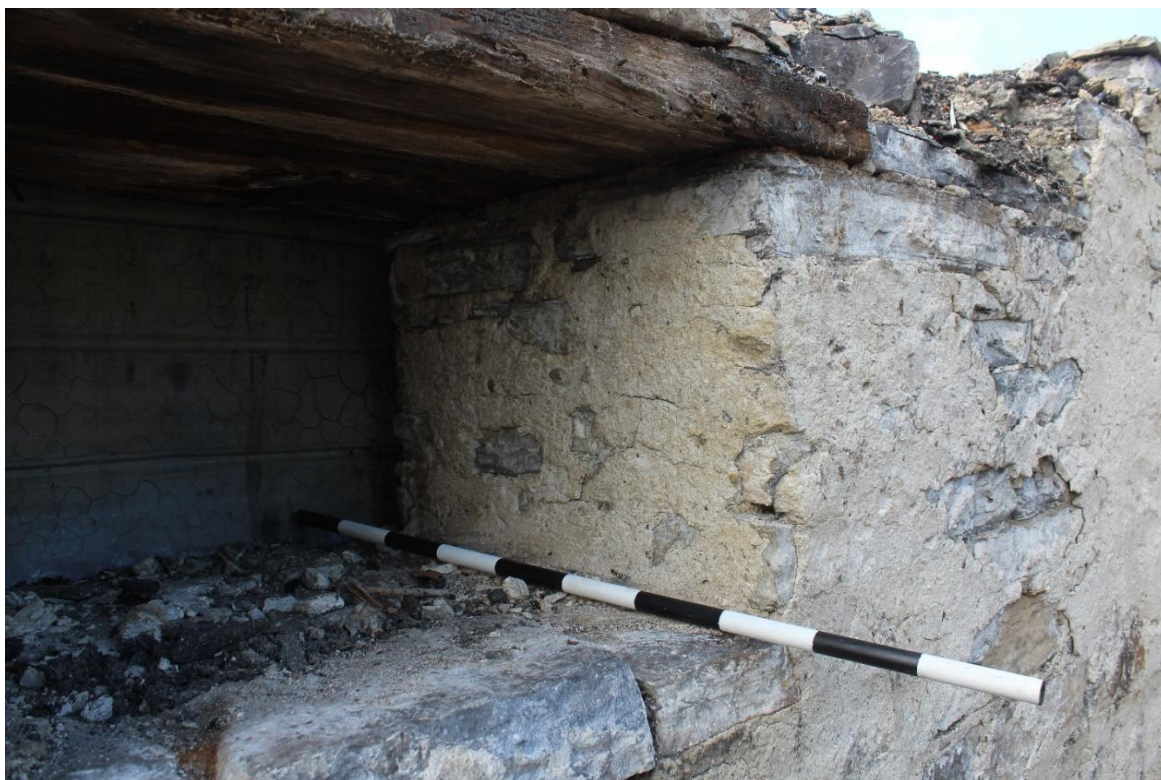
Photo 35 : Exemple de crépi dans une des ouvertures du mur 6A300.
