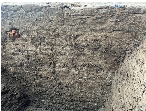
Photo 35 - BjFj-234 – Sous-opération 4C – Dégagement mécanique des fondations du mur ST-05, vue vers le sud (BjFj-234-24-N5-190)
