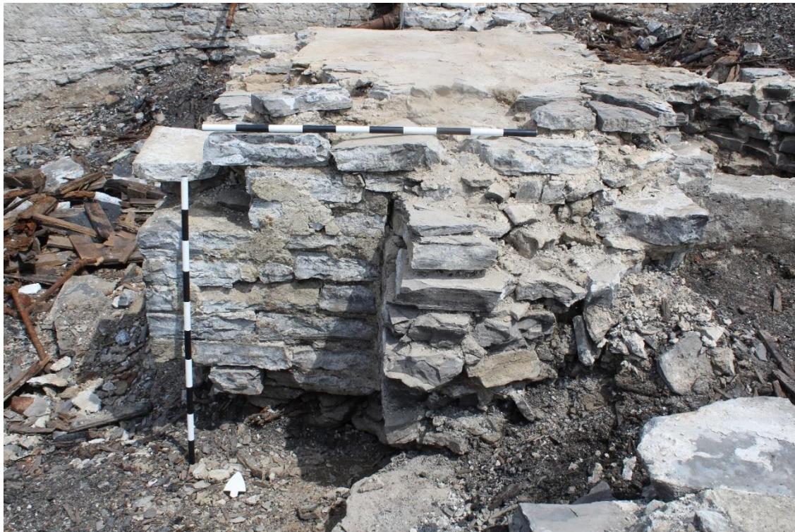
Photo 8 : Parement sud de la base 6A1000. La base en question n'est pas imbriquée au mur de fondation 6A900, à l'ouest, mais ils forment la base carrée d'une cheminée.
