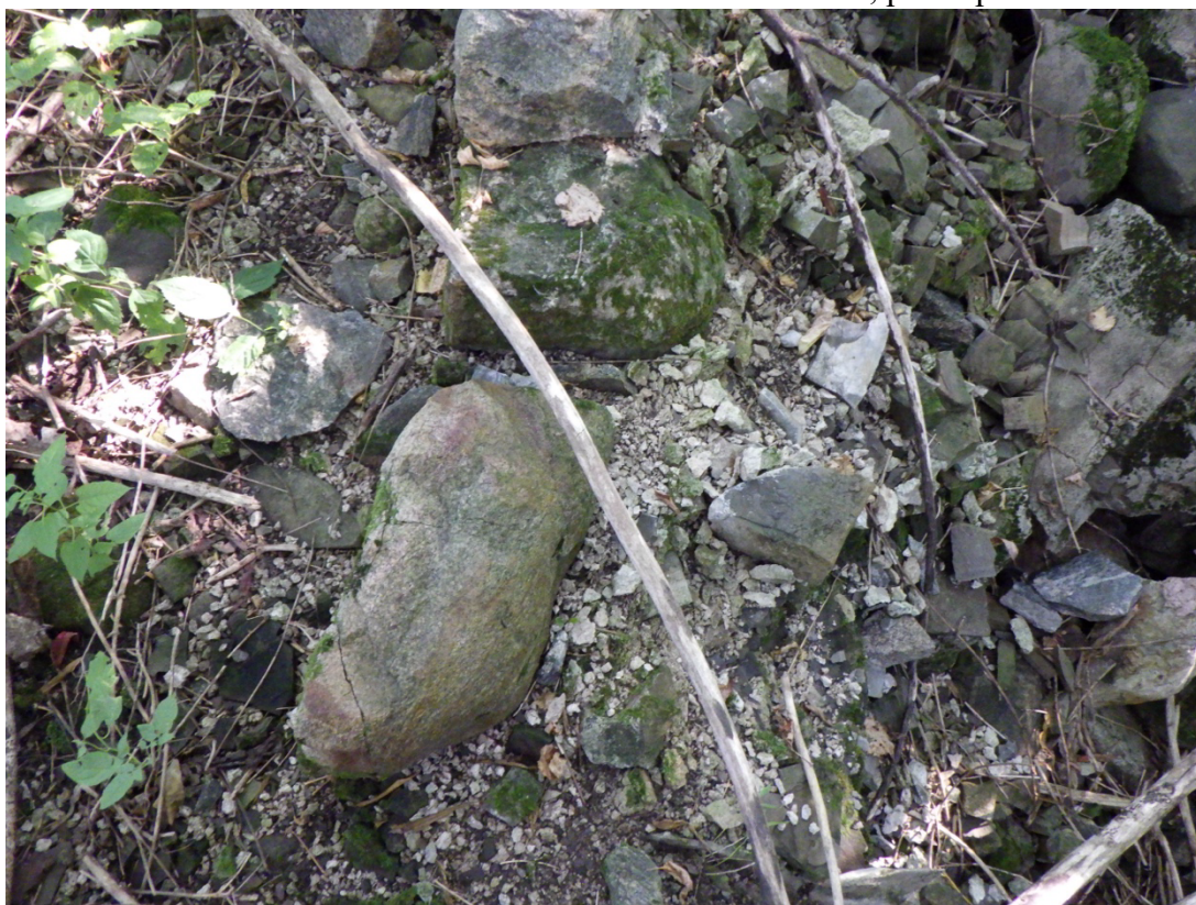
Photo 11 Composition du mur nord des fondations, photo prise vers l'ouest
