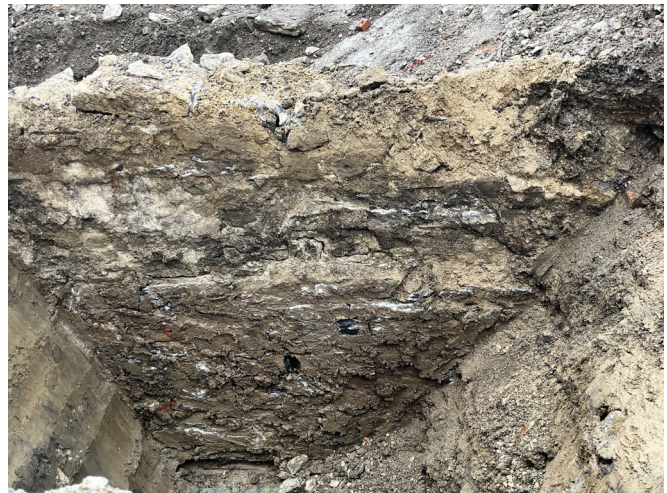
Photo 27 - BjFj-234 — Sous-opération 4E — Dégagement mécanique des fondations du mur ST-40, vue vers l'est (BjFj-234-24-N5-214)
