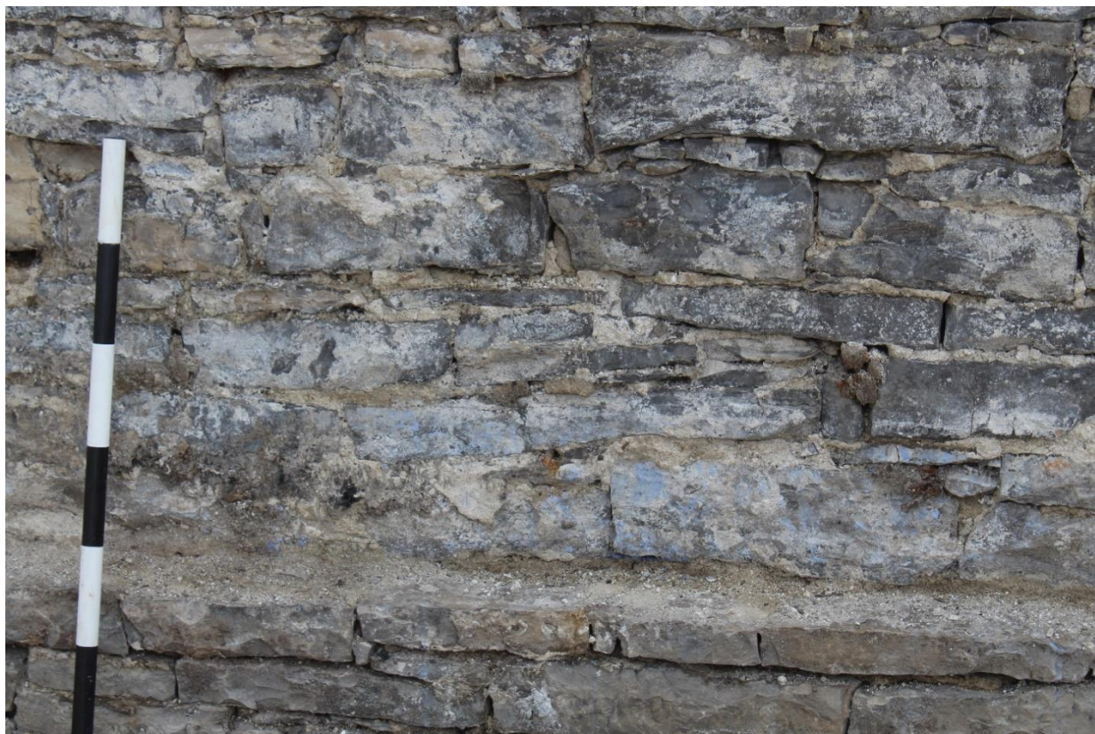
Photo 55 : Traces de peinture bleue sur les pierres du parement intérieur du mur 6A400.
