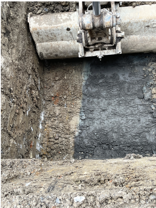
Photo 28 - BjFj-234 — Sous-opération 4E — Dégagement mécanique des fondations du mur ST-40, la tranchée de fondation se détache clairement du sol naturel non anthropisé, vue vers le sud (BjFj-234-24-N5-208)
