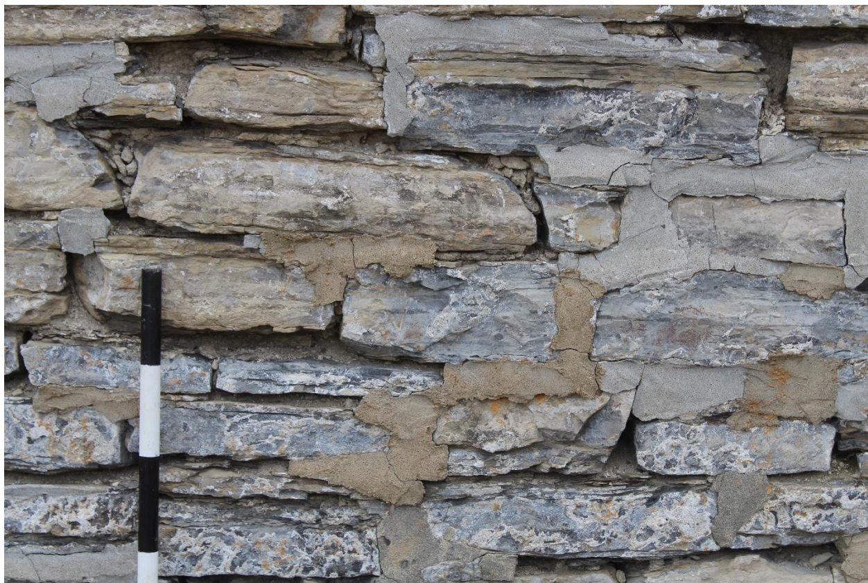
Photo 68 : Réparations du mortier sur le parement extérieur du mur est du fournil (6B400).
