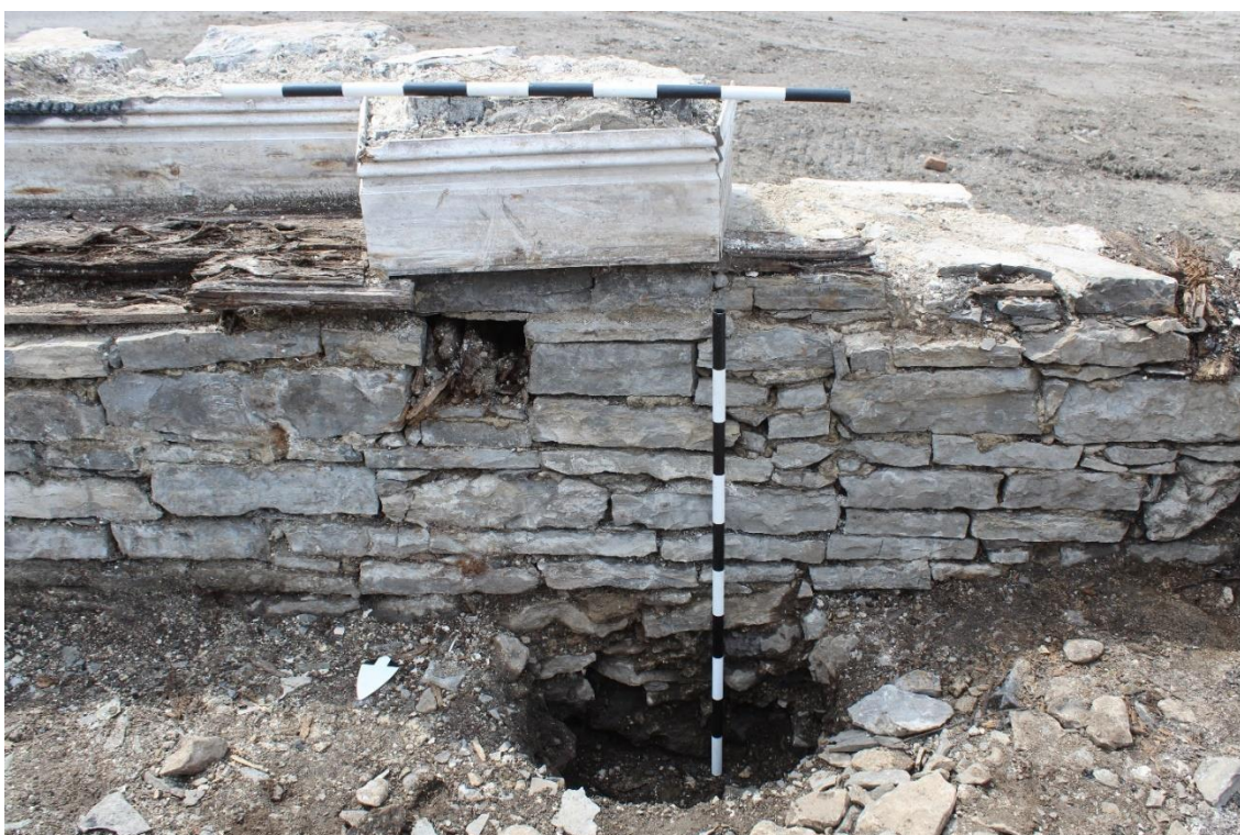
Photo 28 : Gros plan sur la portion est du parement nord du mur 6A300 au niveau du sondage creusé contre les fondations du vestige.
