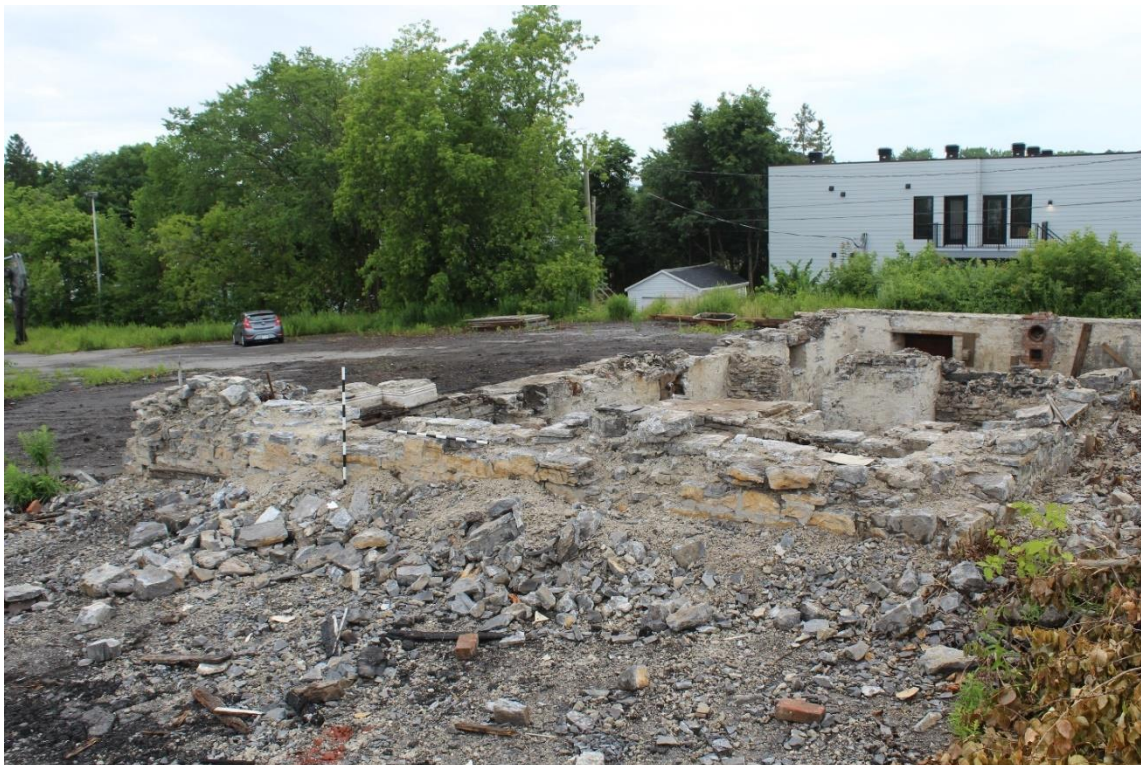
Photo 29 : Parement est du mur est 6A400.
