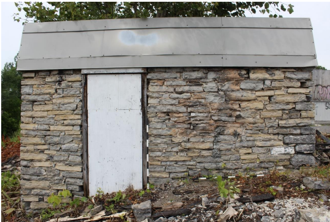
Photo 60 : Parement extérieur du mur sud (6B300).
