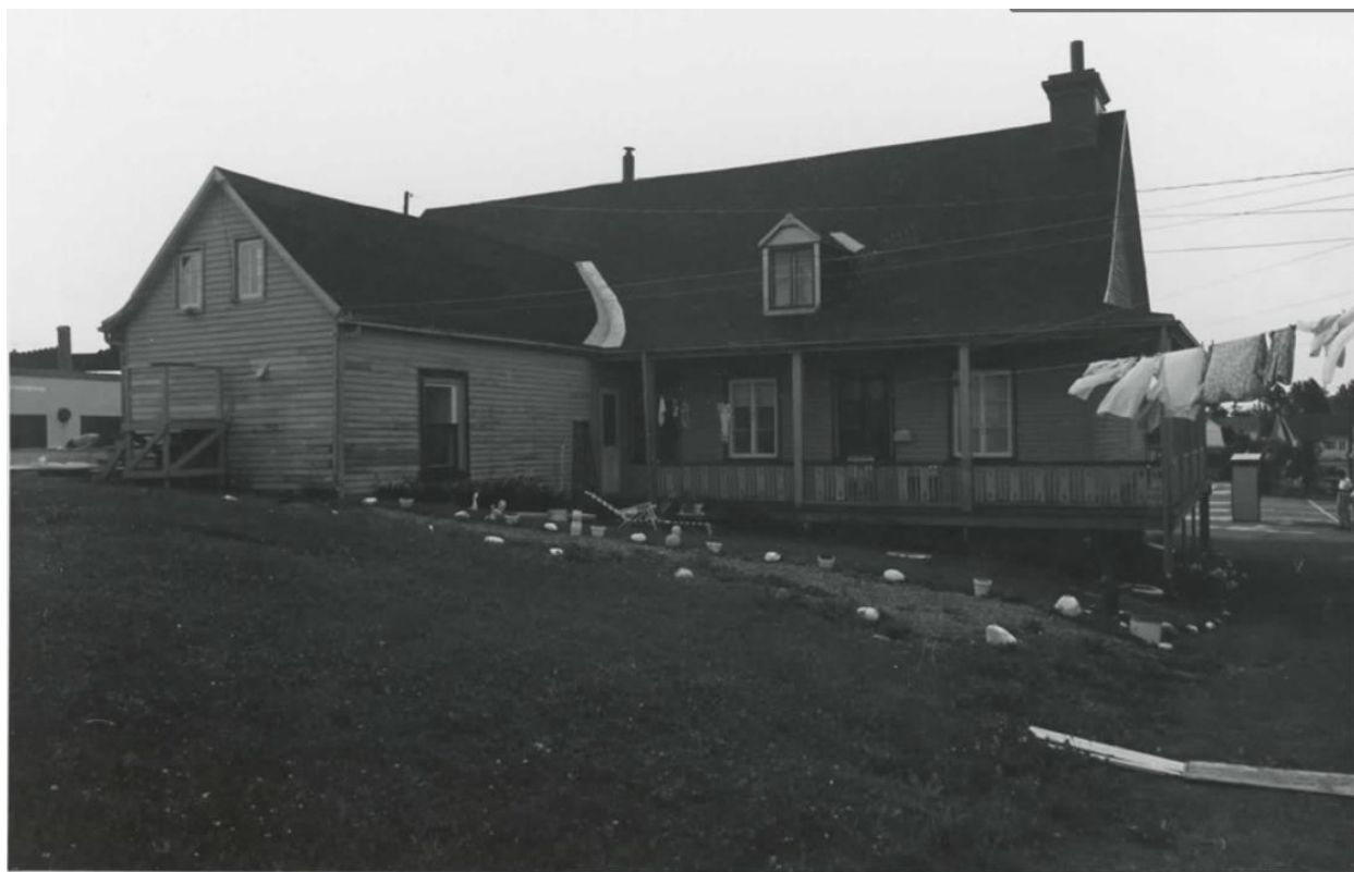
Figure 22 : Maison et fournil entre 1967 et 1970 vue vers le sud-est.
