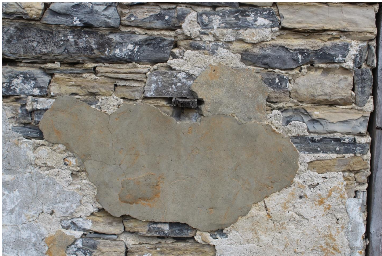
Photo 69 : Réparations du mortier sur le parement extérieur du mur ouest du fournil (6B200).
