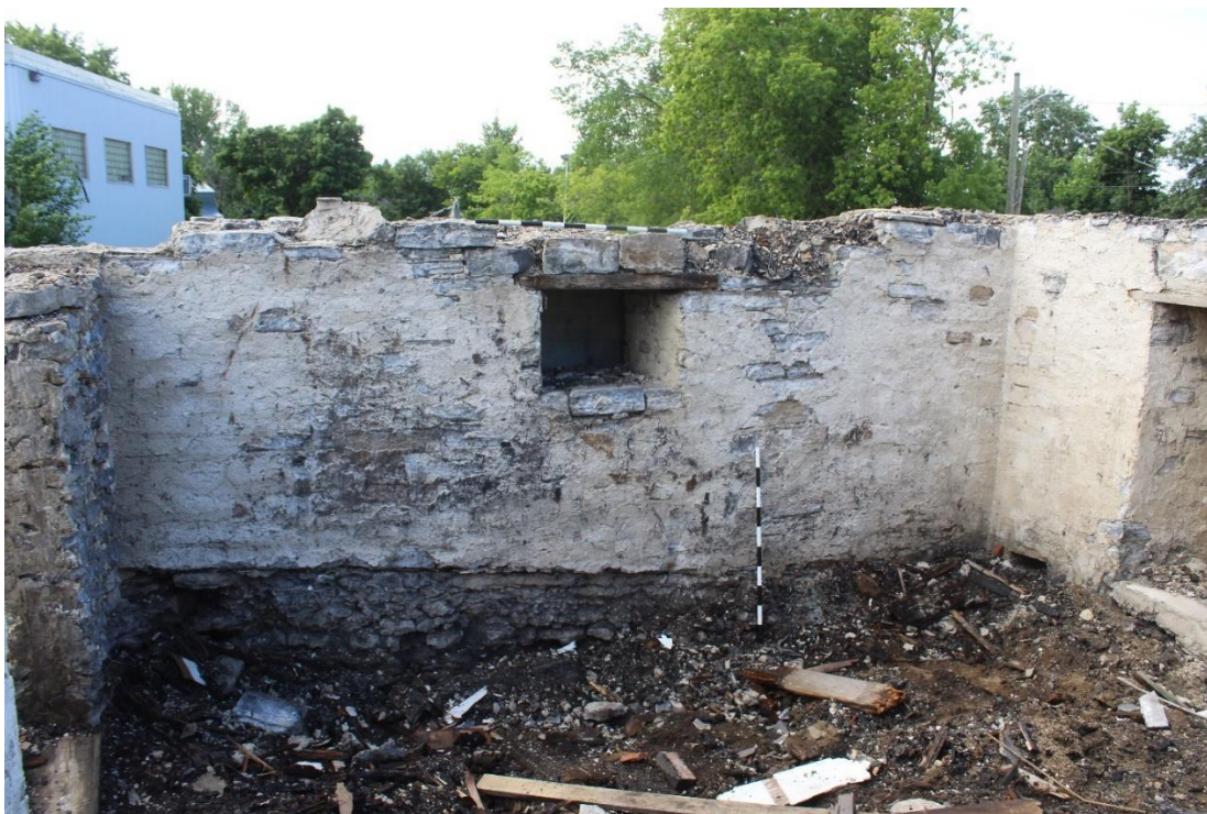
Photo 3 : Portion ouest du parement nord du mur de fondation 6A300b, posé au sommet de la roche-mère.
