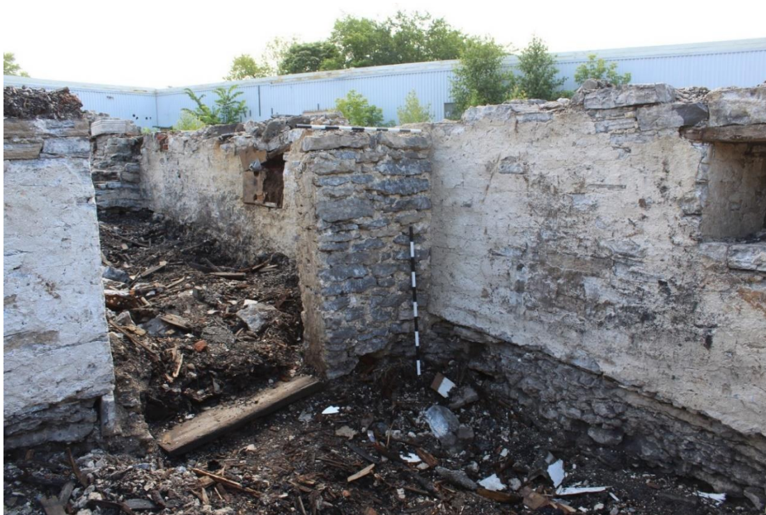
Photo 41 : Parement ouest du mur transverse 6A800.
