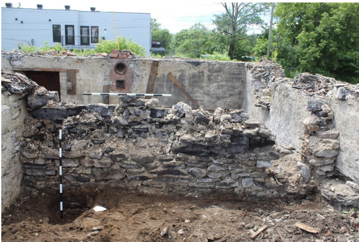
Photo 40 : Parement est du mur transverse 6A600.
