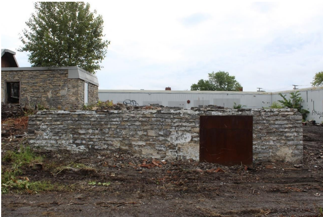
Photo 37 : Parement extérieur du mur ouest de la maison, 6A200.
