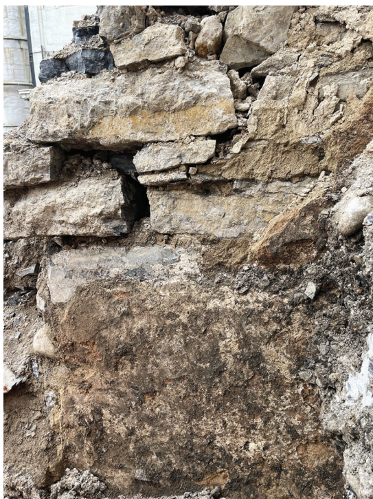
Photo 30 - BjFj-234 — Sous-opération 4A — Détail des traces de chaulage du mur ST-41, vue vers le sud (BjFj-234-24-N5-055)
