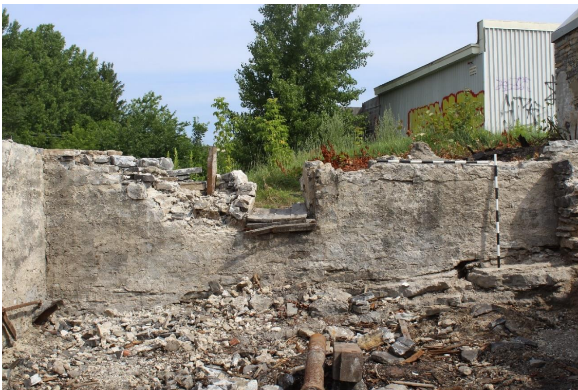
Photo 12 : Ouverture dans le mur 6A500, vue de l'intérieur, vers le nord.
