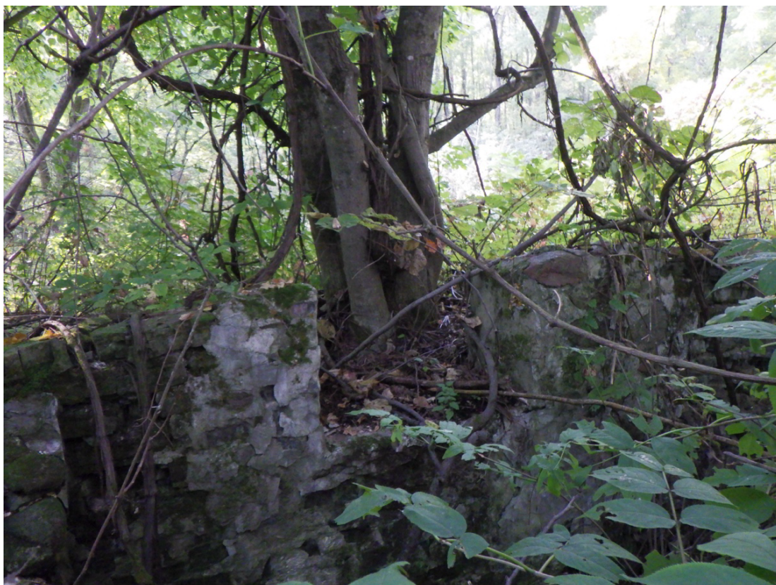
Photo 17 Ouverture le long du mur sud des fondations, photo prise vers le sud-ouest
