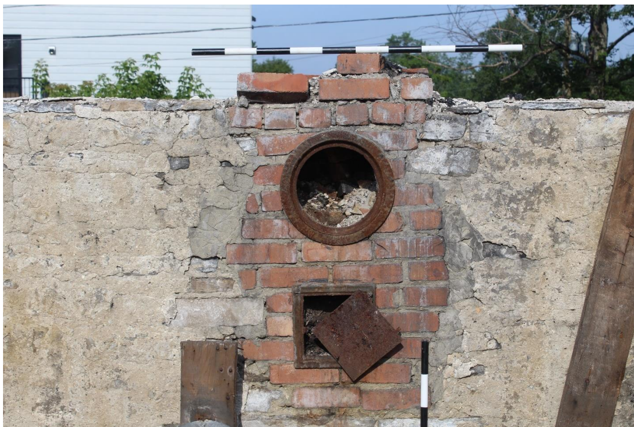
Photo 51 : Trou pour la cheminée et trappe à cendres.
