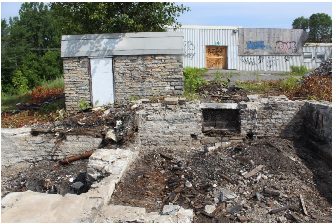
Photo 32 : Parement sud du mur nord 6A500.
