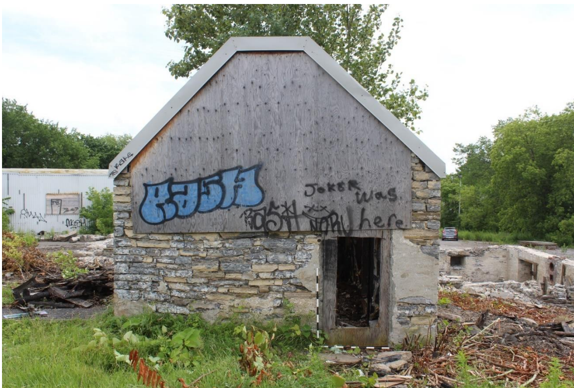
Photo 62 : Parement extérieur du mur nord (6B500).
