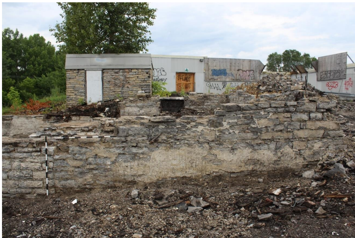
Photo 26 : Parement sud de la portion est du mur 6A300.
