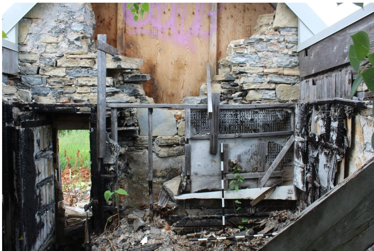
Photo 65 : Parement intérieur du mur nord 6A500.
