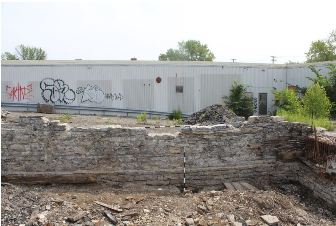
Photo 30 : Parement ouest du mur 6A400.
