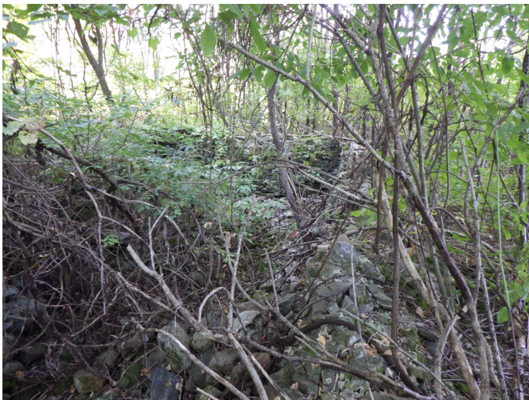
Photo 10 Paroi nord des fondations des ruines de l'« hôtel », photo prise vers l'ouest
