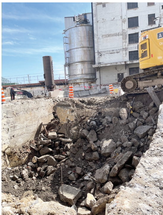
Photo 37 - BjFj-234 — Sous-opération 4B — Dégagement mécanique de la partie supérieure d'une section souterraine du bâtiment 100 à laquelle il était possible d'accéder au moyen d'escaliers, définie par les murs ST-42, ST-43, ST-08, ainsi que le mur ST-05, vue vers le sud-est (BjFj-234-24-N5-024)
