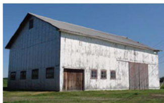
3157, avenue Royale. Grange. Vue d'ensemble
