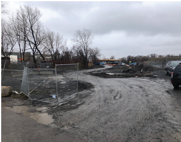
Photo 1 - Vue générale du terrain à l'étude à partir du tournebride en direction du nouveau viaduc en voie de réalisation – Vue vers l'ouest (MTL22-12-1-22-N1-67)
