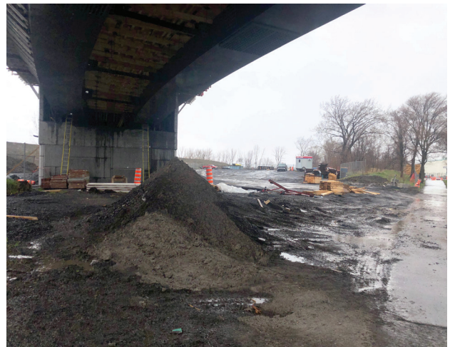
Photo 7 - Future tranchée 1D sous le nouveau viaduc routier, entre la piste cyclable et la culée nord – Vue vers l'est (MTL22-12-1-22-N1-70)
