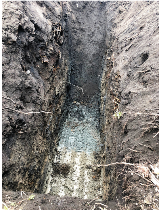
Photo 13 - Tranchée 1B – D'épais remblais sidérurgiques recouvrent l'argile marine – Vue vers le sud (MTL22-12-1-22-N1-10)
