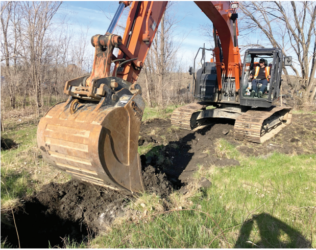
Photo 3 - Tranchée 1A1 – Début des travaux d’excavation – Vue vers le nord-ouest (MTL22-12-1-22-N1-1)
