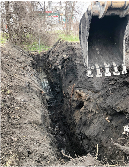
Photo 12 - Tranchée 1B – Portion sud de la tranchée 1B, niveau argileux atteint. Clôture en haut du talus – Vue vers le sud (MTL22-12-1-22-N1-14)
