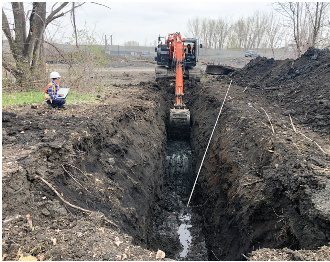
Photo 11 - Tranchée 1A2 – Niveau humique recouvrant l’argile marine dans la portion nord de la tranchée – Vue vers le nord (MTL22-12-1-22-N1-35)
