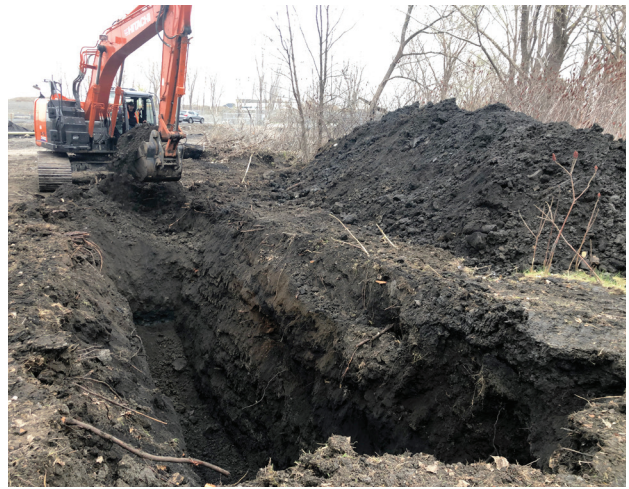
Photo 4 - Tranchée 1A2 – Creusement oblique rejoignant la tranchée 1A1 – Vue vers le nord (MTL22-12-1-22-N1-31)
