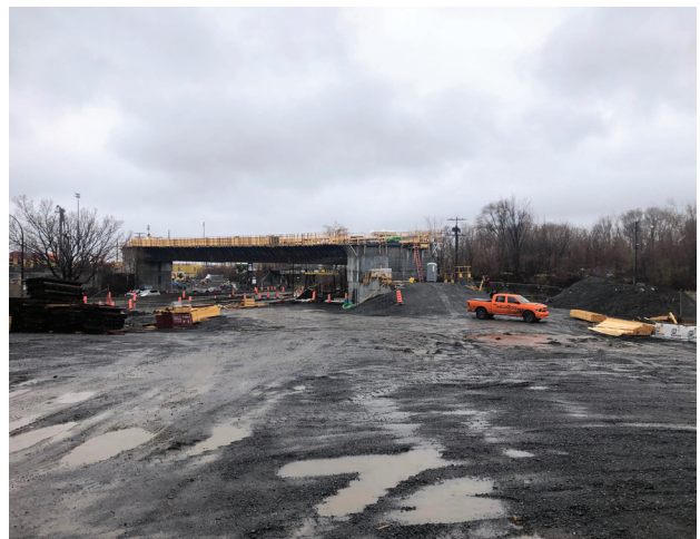
Photo 2 - Vue de l'aire de travail autour du viaduc – Vue vers le sud-ouest (MTL22-12-1-22-N1-68)
