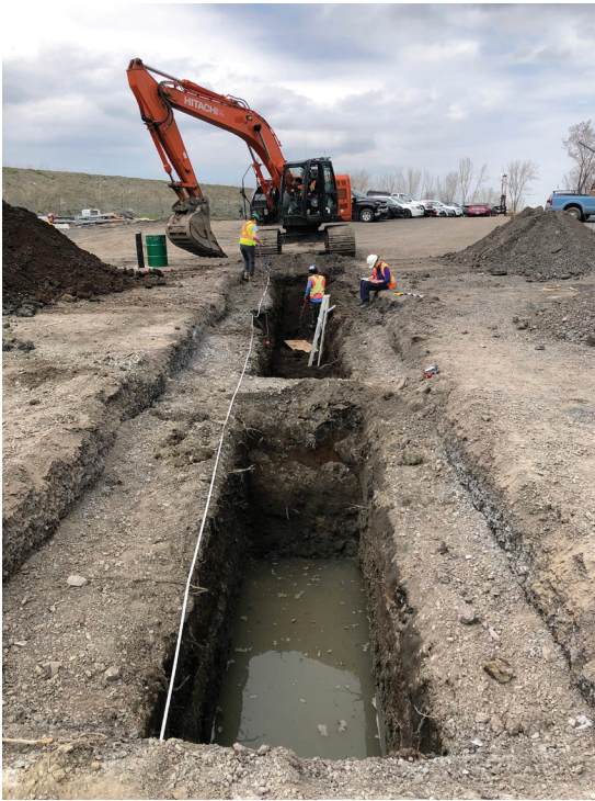
Photo 14 - Tranchée 1C — Vue générale de la sous-opération en cours d'excavation — Segment sud-ouest inondé (MTL22-12-1-22-N1-48)
