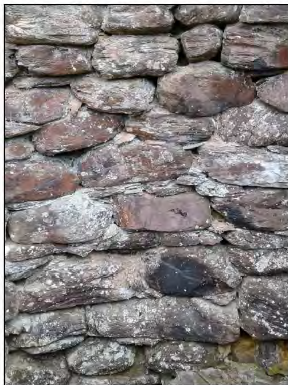
Photo 7 - Détail de la partie basse du parement intérieur du flanc sud du four (vers le sud).
