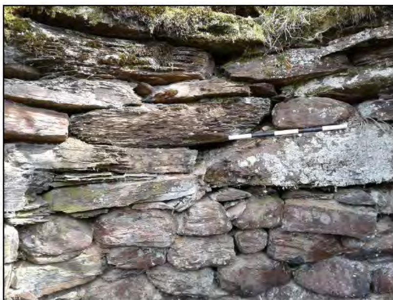
Photo 8 - Détail de la partie basse du parement intérieur du flanc sud du four (vers le sud).
