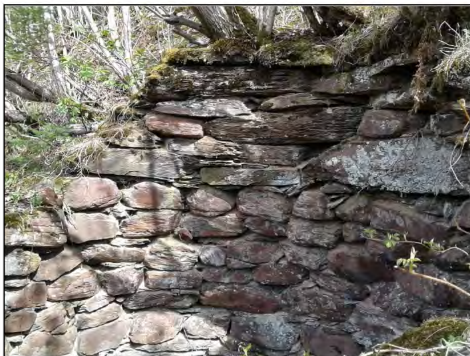
Photo 4 - Vue du parement intérieur du flan est du four (vers l'est).
