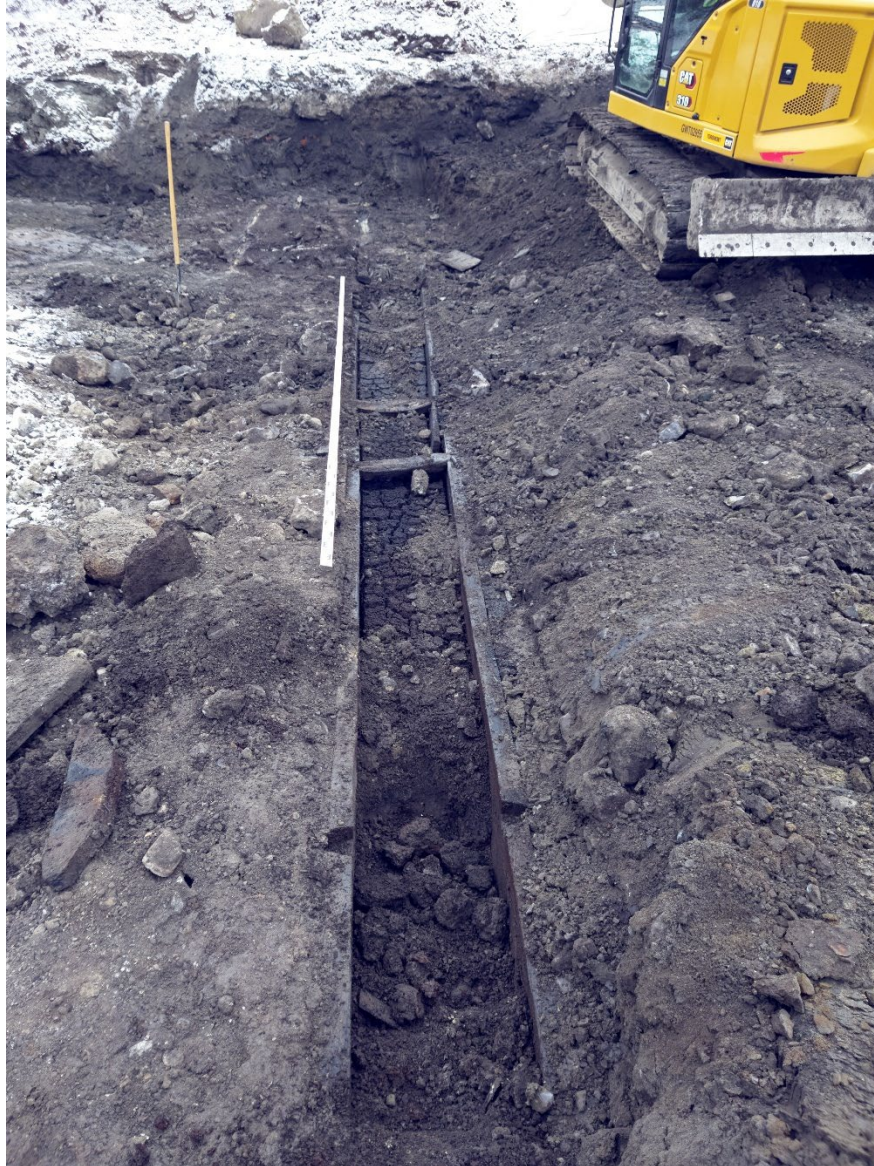
Photo 53. Drain en bois de section carrée ST-25 orienté nord-sud (Photo BjFj-241-25-N1-047).
