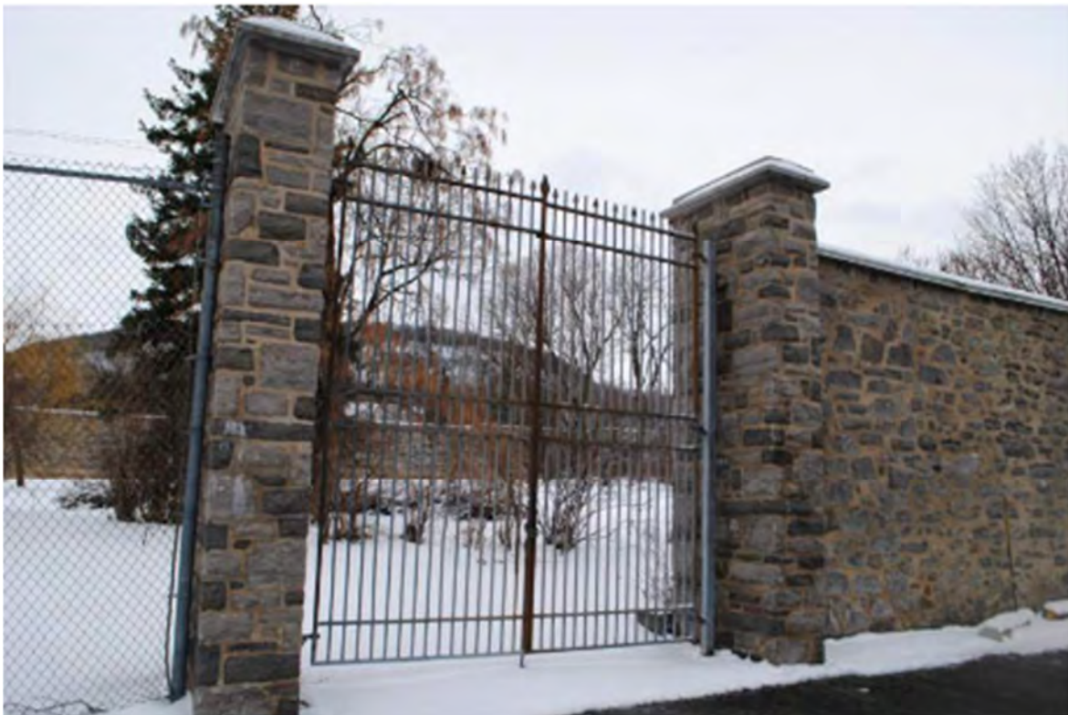
Figure 8: Photo du portail du mur de fortification de l'Hôtel-Dieu situé dans l'aire de stationnement P3, image tirée du Plan d'implantation de la firme Bouthillette Parizeau, feuille A001
