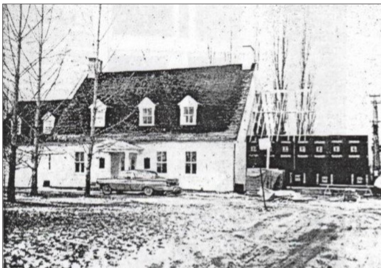
Figure 4.18 : Construction de l'annexe nord, en 1961. Tirée de Pelletier 1998.
