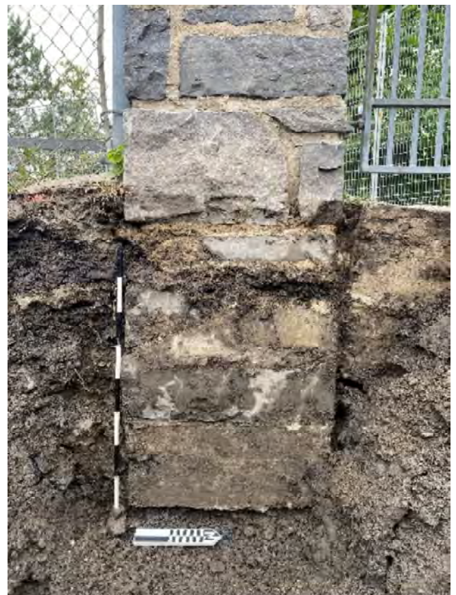
Figure 31: fondation en béton de la tour sud de l'ancien portail
