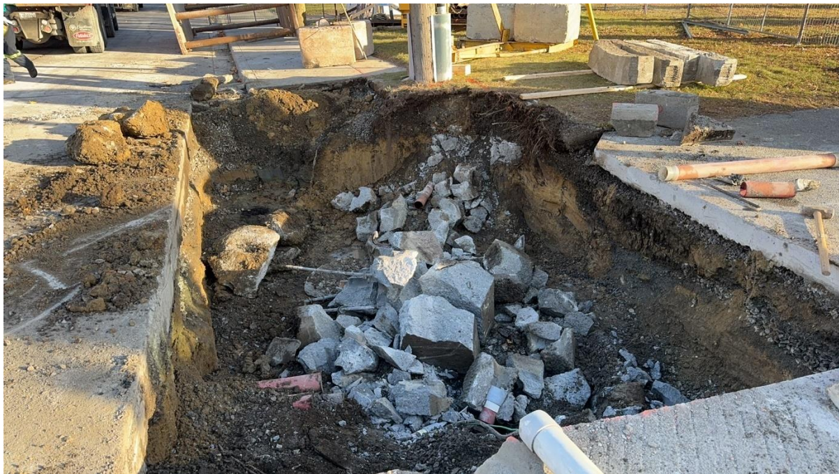
Photo 2. Aperçu des sols en place en paroi après la démolition des infrastructures existantes dans la sous-opération 15A/27A, vue vers l'est (BjFi-17-25-NUM1-025)
