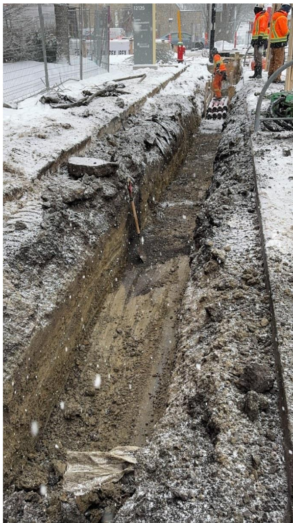
Photo 34. Tranchée 1A effectuée sous le trottoir est du boulevard Saint-Jean-Baptiste, vue vers le sud (MTL25-19-01-NUM1-013)
