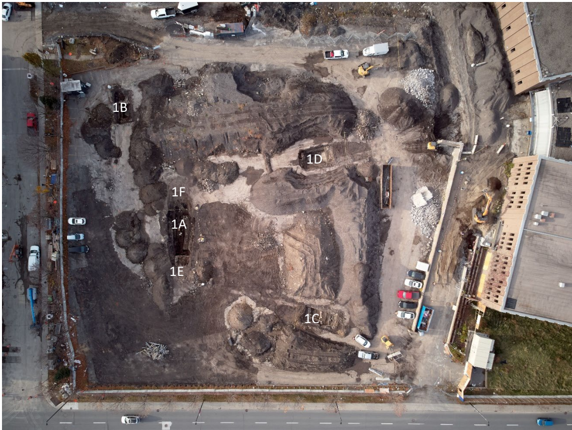
Photo 3. Vue aérienne par drone des quatre tranchées archéologiques dans l'aire d'étude. On remarque la présence de nombreux tas de terre au travers du terrain. (Photo M. Vaillancourt).
