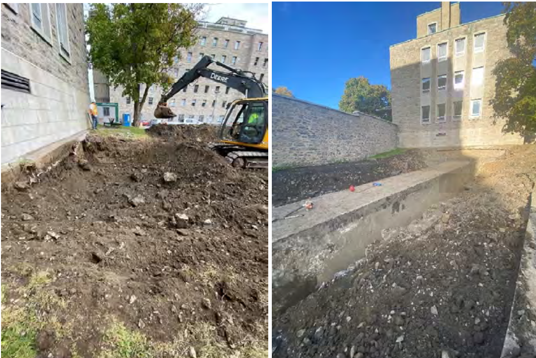
Figure 40: Excavation de la tranchée 10C en cours
