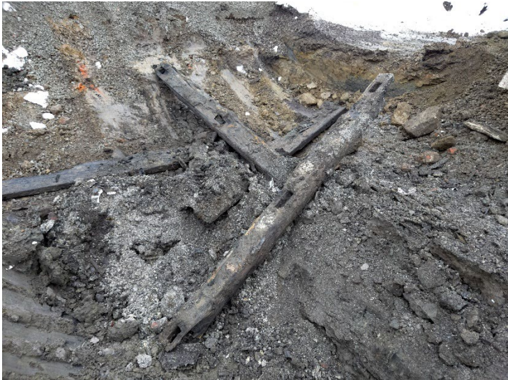
Photo 46. Pièces de bois ST-17 et ST-20 formant la fondation d'un bâtiment de cour arrière. (Photo BjFj-241-25-N1-023).
