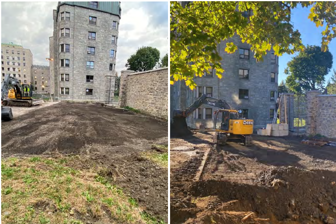
Figure 30: Retrait mécanique de l’asphalte dans l’aire de la tranchée 10B et sécurisation de la tour sud du portail du mur d’enceinte
