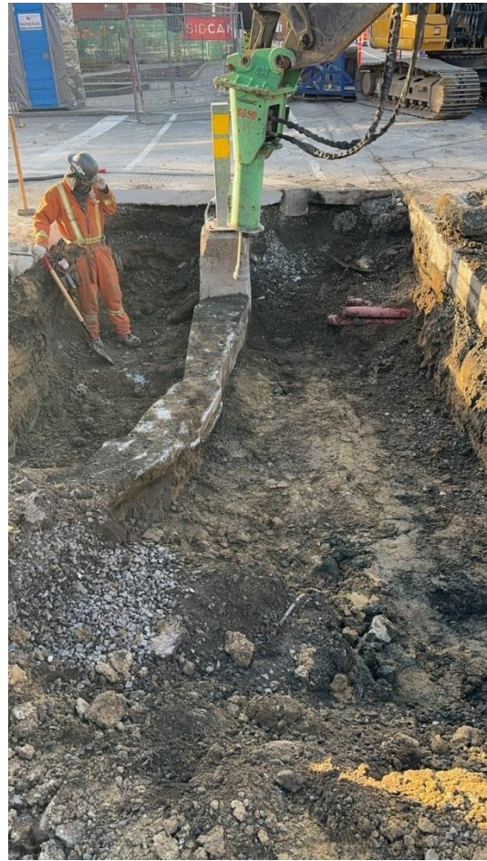
Photo 1. Démolition du massif et de la base du mât de circulation dans la sous-opération 15A/27A, vue vers l'ouest (BjFi-17-25-NUM1-022)
