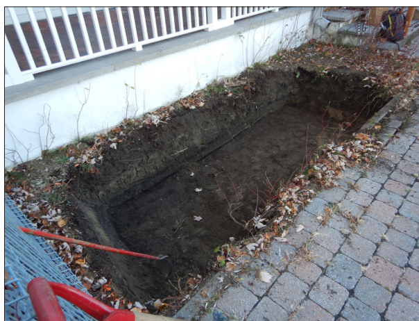
Figure 6.18 : Sous-opération 6E. Vue vers le sud-est. CaFg-9-24-N1 (37).
