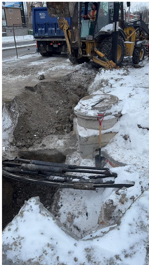
Photo 35. Services enfouis observés dans la sous-opération 1A sous l'intersection du boulevard et de la rue, vue vers le nord-ouest (MTL25-19-01-NUM1-004)
