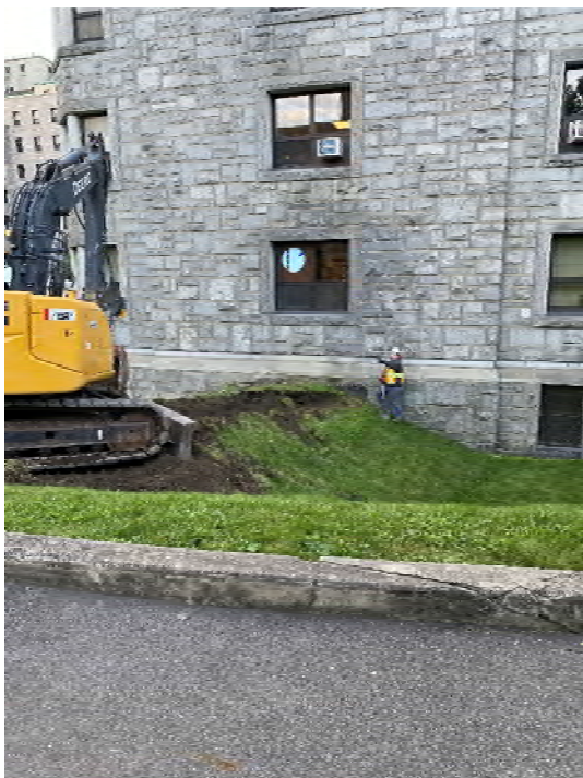
Figure 26: Tranchée 10A avant l'excavation, vue sud
