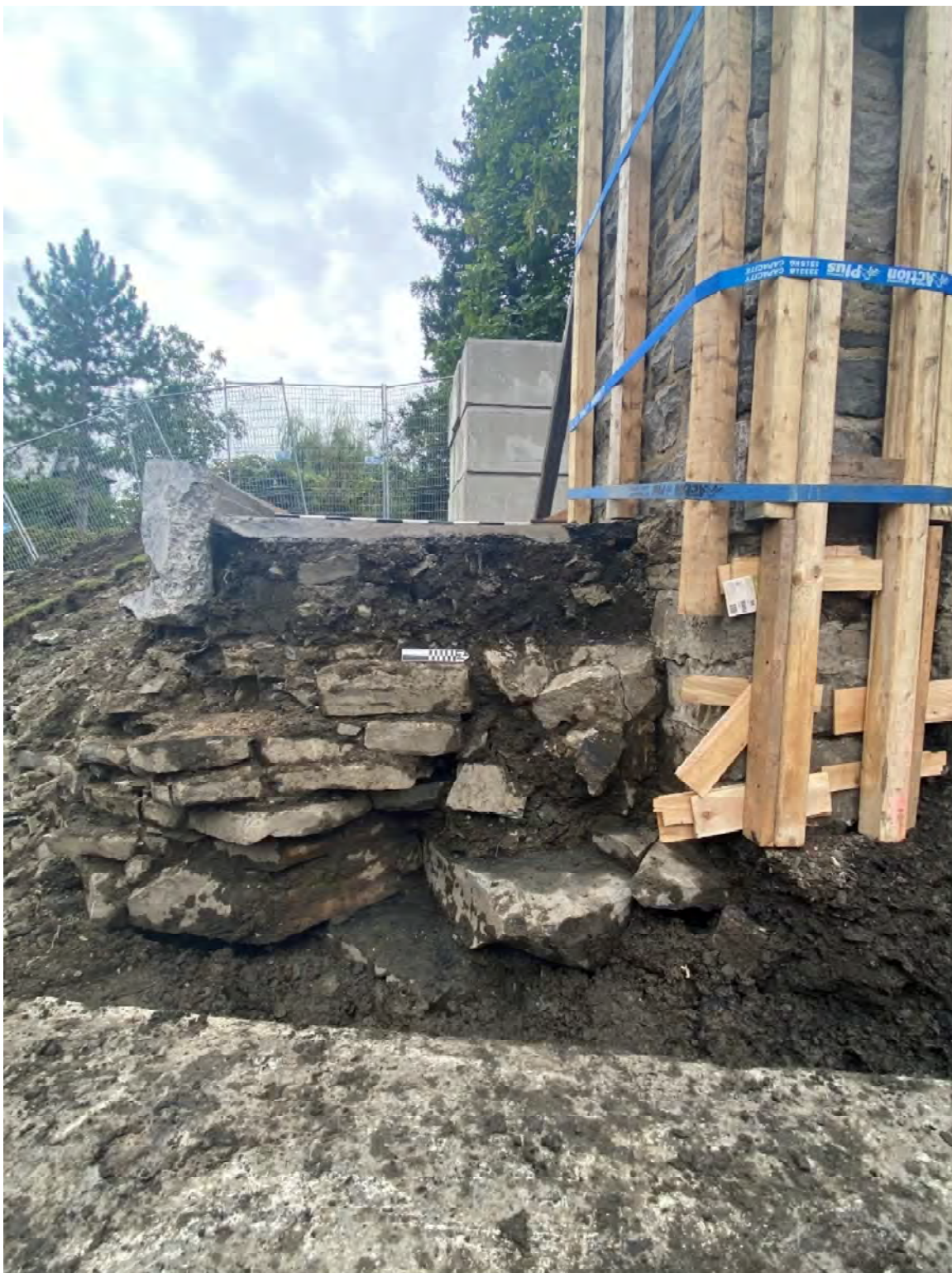
Figure 33: Vestige de l'ancien mur d'enceinte reposant sur le roc (7 assises) découvert dans la tranchée 10B entre la tour sud du portail et la partie nord de la tranchée 10A
