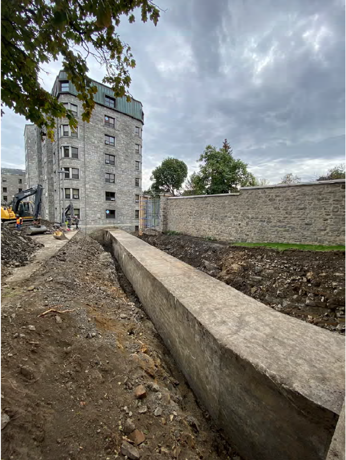
Figure 42: Excavation terminée, tunnel 18 complètement dégarni entre les pavillons Le Royer et Masson
