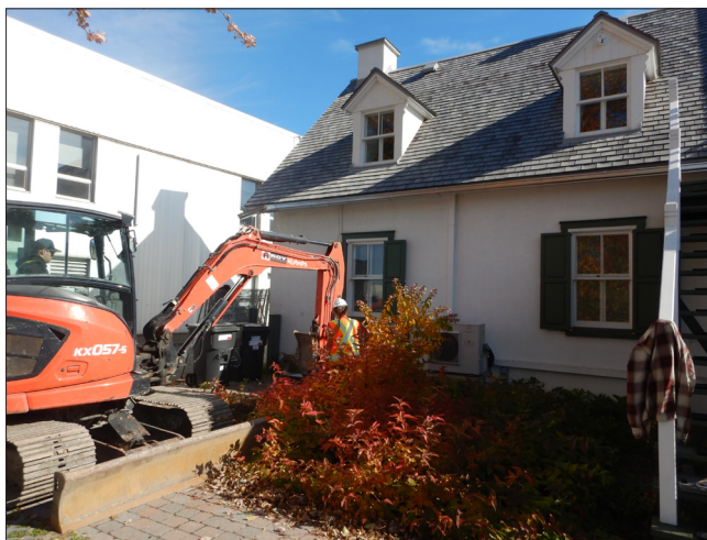
Figure 6.11 : Sous-opération 6D. Vue vers le nord-est. CaFg-9-24-N1 (25).
