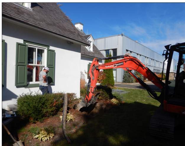
Figure 6.8 : Sous-opération 6C. Vue vers le nord-ouest. CaFg-9-24-N1 (20).
