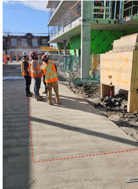
Photo 40. Un nouvel asphalte marque l'emplacement des travaux récents en lien avec le gaz, vue vers le nord (BjFi-16-25-NUM2-049)
