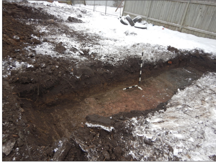
Figure 4.10. Photographie de la tranchée 1B. Vue vers le N-E. MTL25-19-02-24-N1-28.
