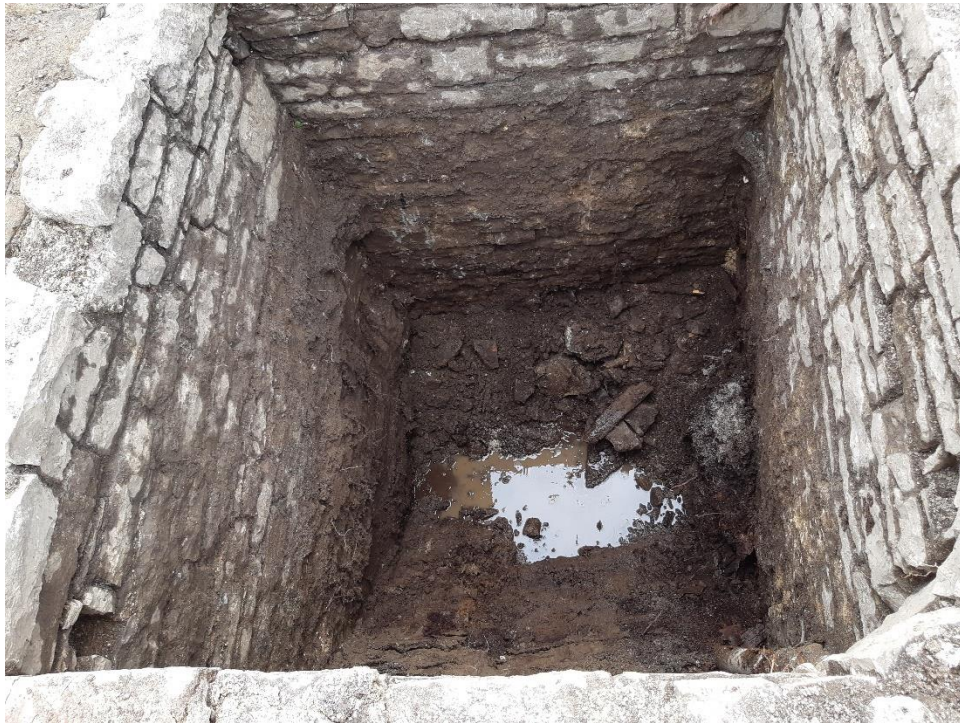
Photo 12. Mur sud-ouest du vestige 40B100 (CfEs-23-25-NUM4-22)
