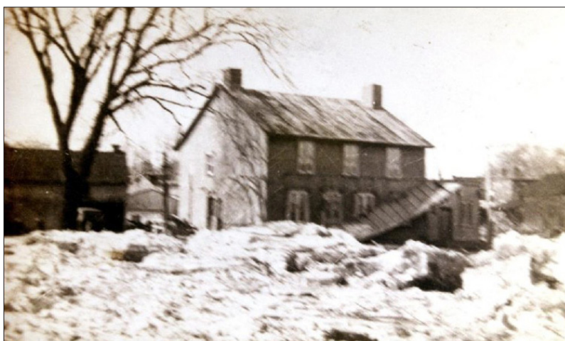
Figure 5.10 : Vue de la façade de la Maison Moïse-Prégent lors de la débâcle de 1935. On peut voir l'annexe du côté nord et la grange dans l'arrière-cour. Le toit de la galerie avant a été arraché. Tiré de SMGC, 2021, Fig. 6.
