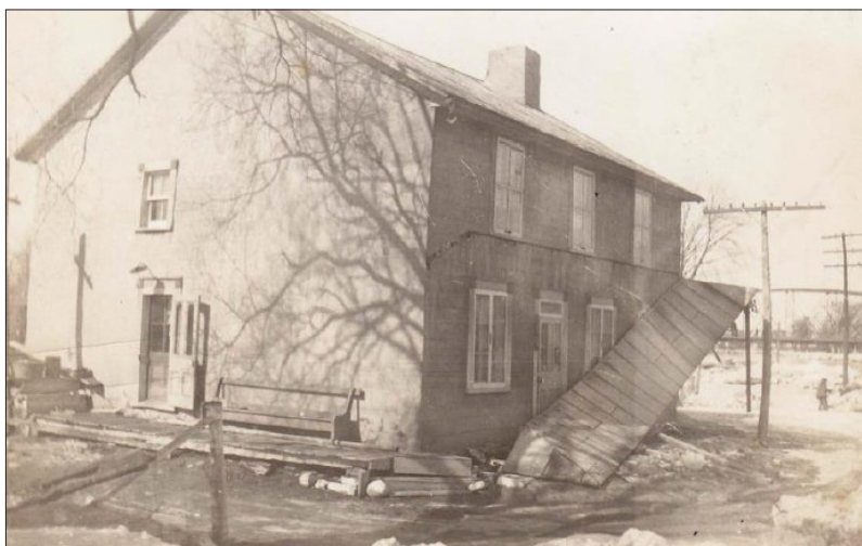
Figure 5.11 : Une autre vue de la façade de la Maison Moïse-Prégent lors de la débâcle de 1935. Tiré de SMGC, 2021, Fig. 5.
