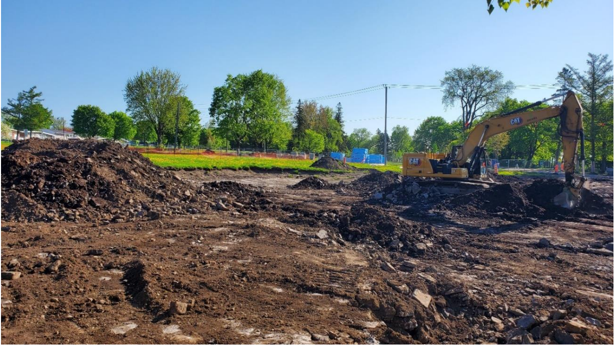
Photo 14. Excavation en cours au nord des vestiges de Poston House, vue vers le nord-est (CfEs-23-25- NUM3-5)
