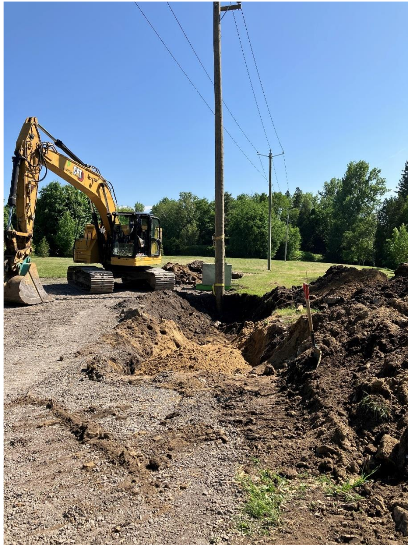
Photo 20. Sous-opération 43A, vue vers l'est (CfEs-23-25-NUM5-36)
