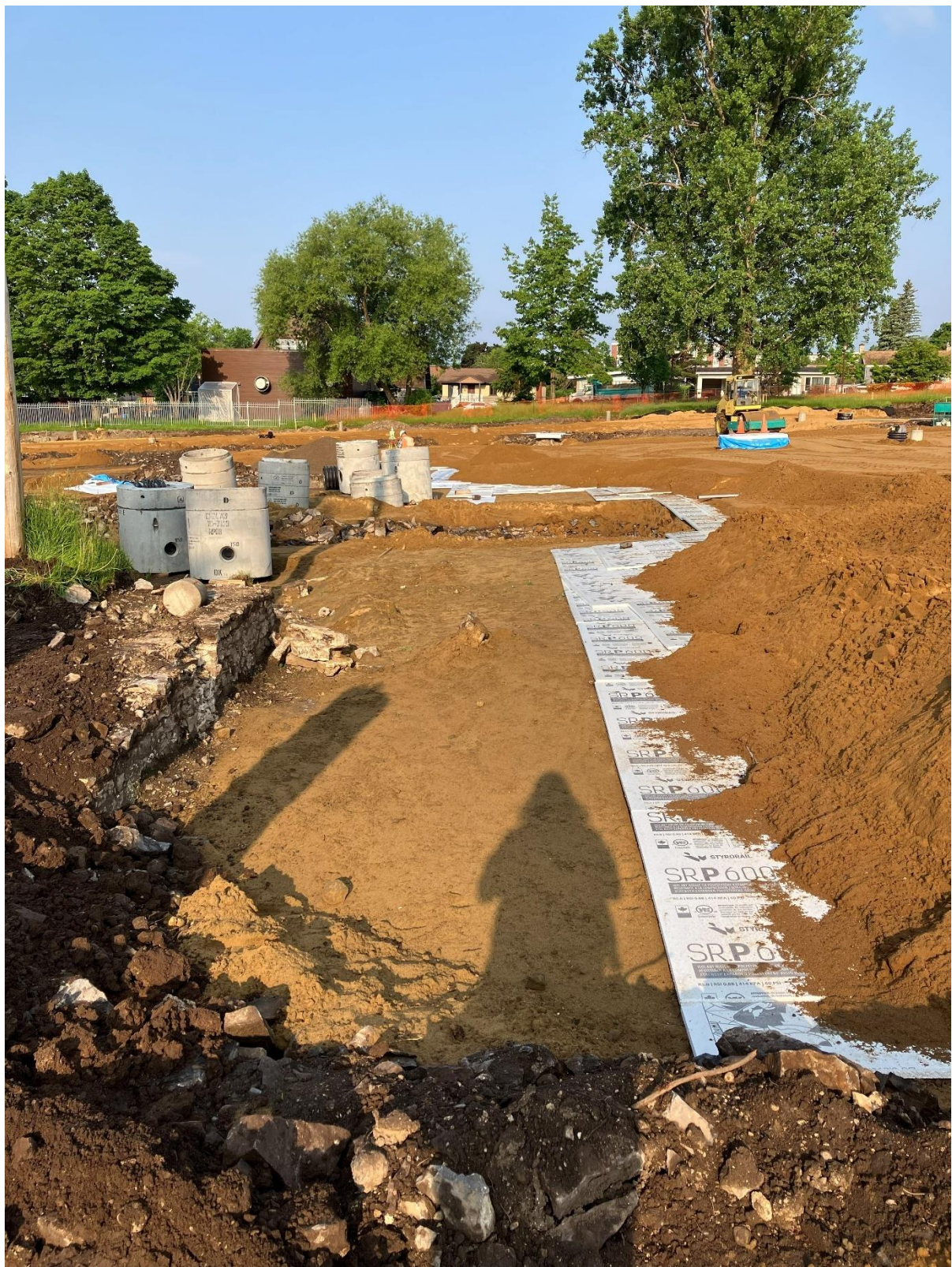
Photo 7. Site ensablé et vestiges recouverts d'un isolant rigide en polystyrène, vue vers l'ouest (CfEs-23-25-NUM5-24)
