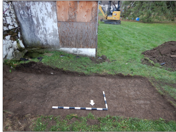
Figure 6.7 : Photographie sous-opération 1B. Vue vers le sud. BiFk-18-24-N1 (12).
