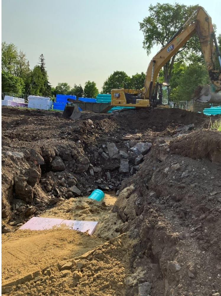
Photo 16. Excavation dans le roc à l'ouest du chemin nord-sud, vue vers l'est (CfEs-23-25-NUM5-29)
