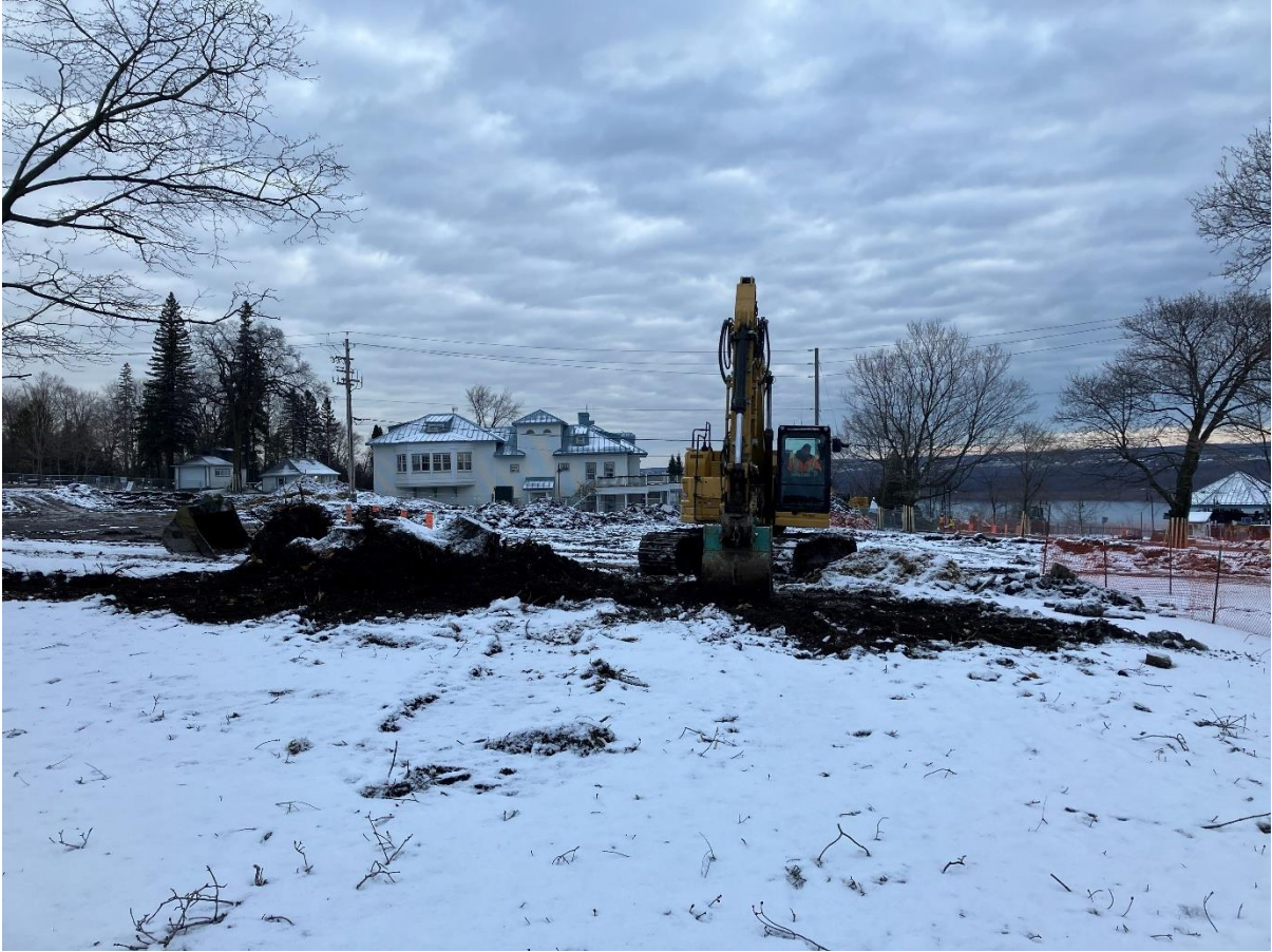
Photo 17. Essouchage au sud-est du stationnement de l'ancienne chapelle, vue vers l'est (CfEs-23-24- NUM2-16)
