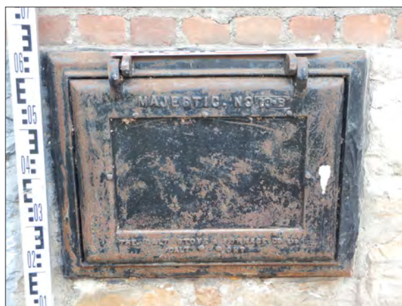
Figure 7.21 : Vue rapprochée de la porte de la chute à charbon. BjFr-33-25-N1 (38).
