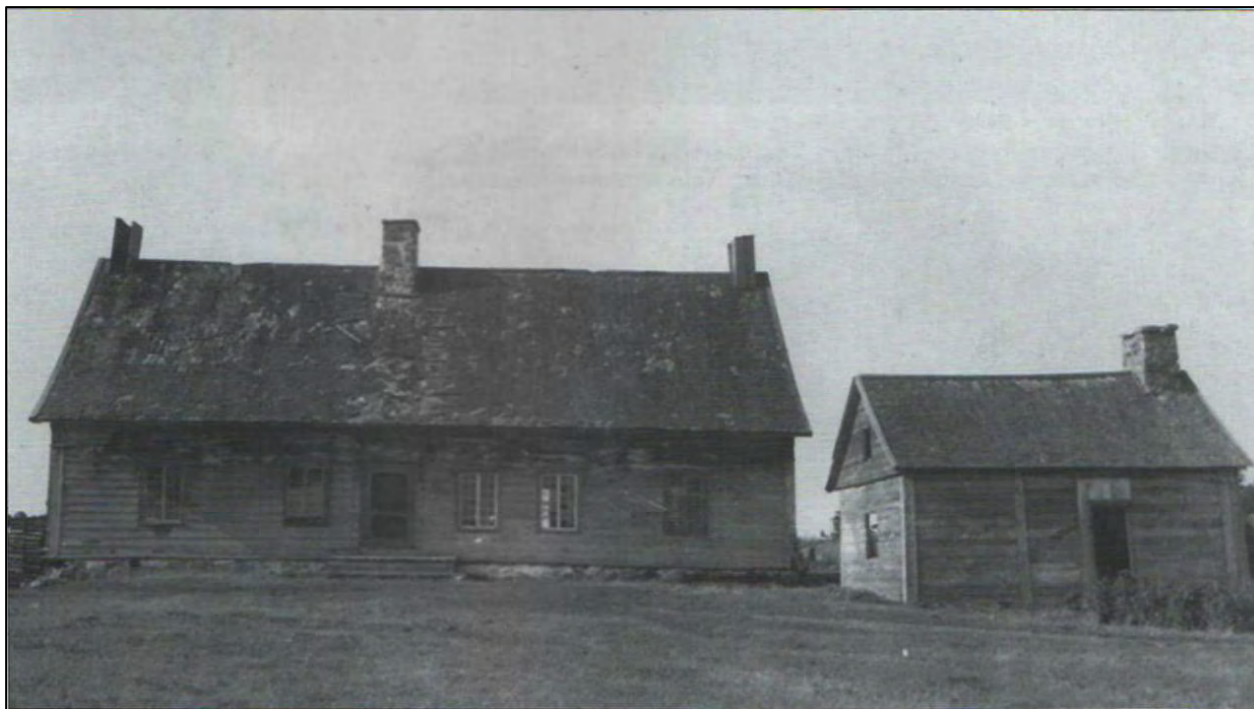
Figure 10. Vue générale vers le nord du manoir Rioux-Belzile et de son fournil vers 1927 (image partagée par la propriétaire). Notez l'orientation des planches et la position de la cheminée. Les débris de la structure de bois observables aujourd'hui se trouvent à l'est de la cheminée et ne pourraient donc pas être ceux illustrés. L'orientation des planches est un autre indicateur soutenant le caractère non contemporain des structures.
