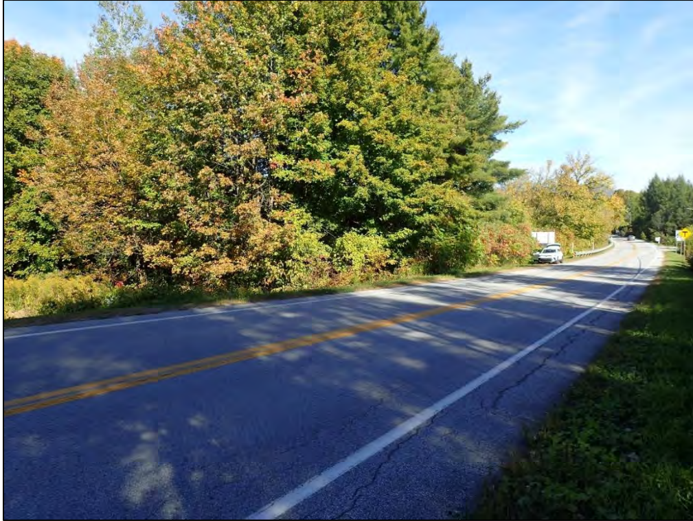
Figure 5 : Vue générale de l'emprise depuis son extrémité ouest, projet 154-20-0770, chemin de Saint-Armand, Frelighsburg (vue vers le nord-est, photo 154-20-0770 (23)).
