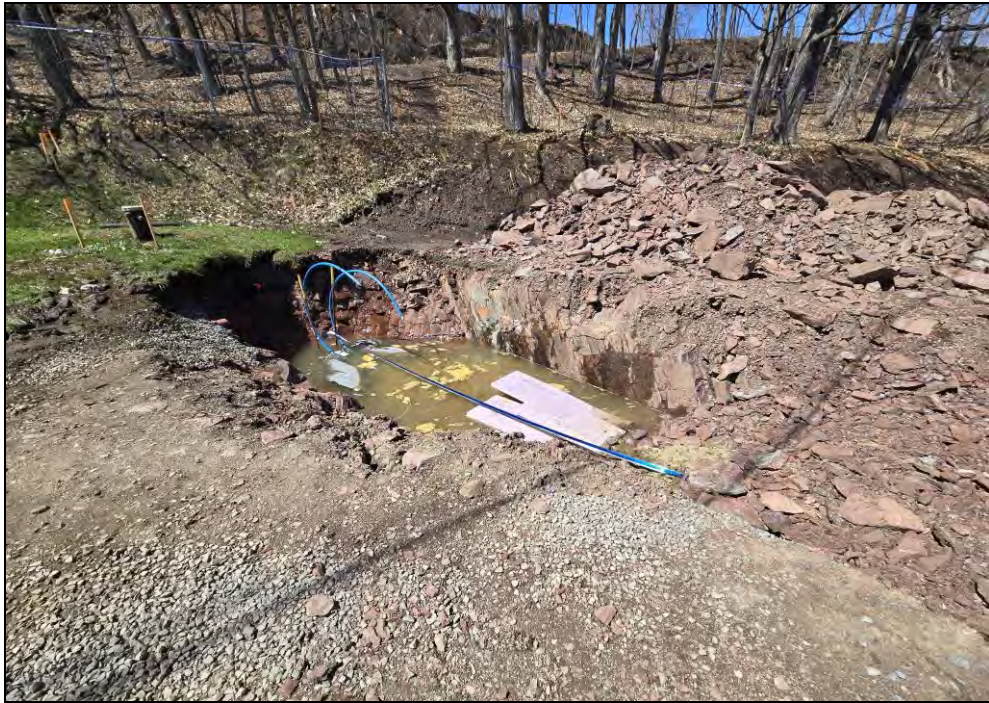
Photo 5. Vue générale de la portion ouest de la tranchée TCI-SLÎO-TDL-2025-1D excavée dans les limites du terrain des Loisirs, vers le nord-ouest (TCI-SLÎO-LOISIRS-2025-016)
