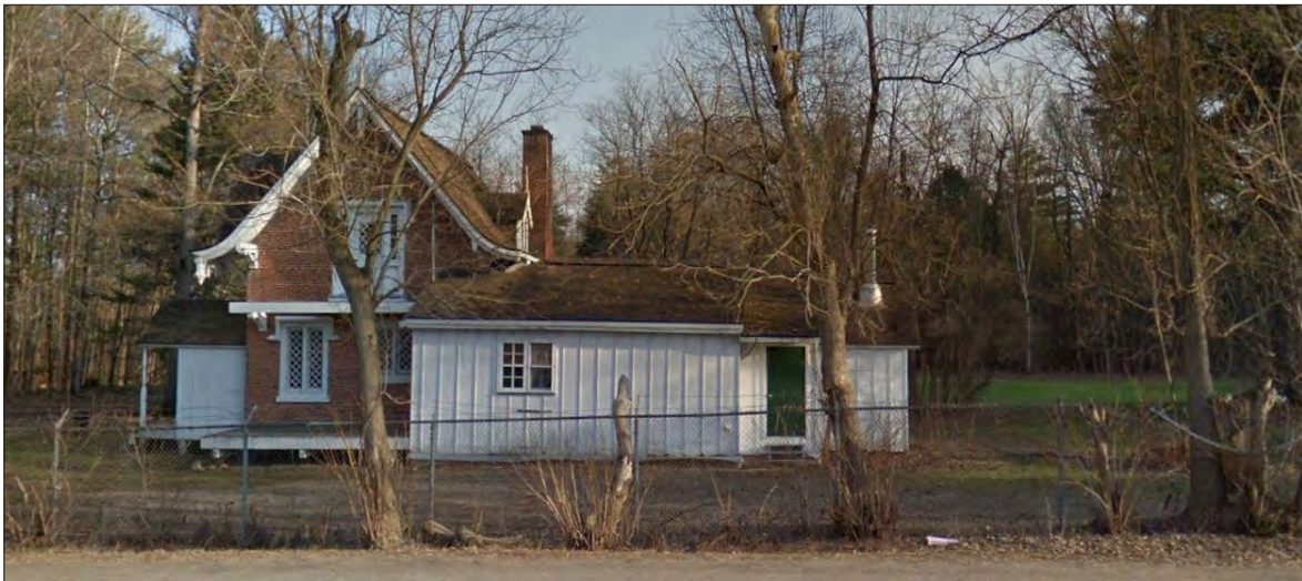
Figure 5.11 : La Maison du jardinier en 2018. Source : Google Street View.
