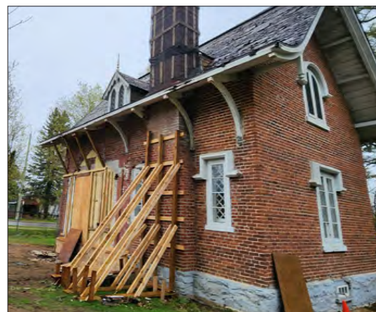
Figure 7.19 : Angle sud-ouest de la maison du jardinier. Photo Gina Vincelli, mai 2025.
