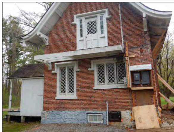
Figure 7.20 : Chute à charbon sur le mur nord. BjFr-33-25-N1 (39).
