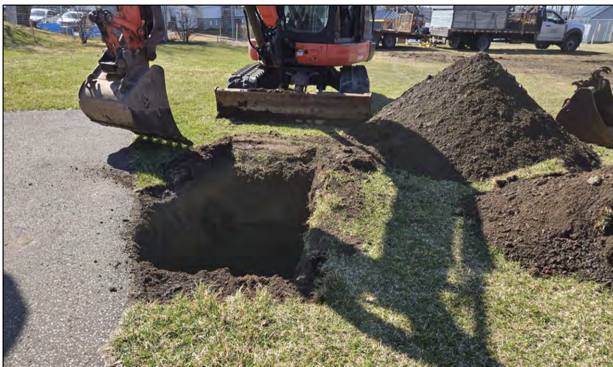
Photo 2. Vue d'ensemble de la tranchée exploratoire TCI-SLÎO-TDL-2025-1B effectuée en prévision des travaux de réaménagement du terrain des Loisirs, vers le sud-est (TCI-SLÎO-LOISIRS-2025-004)
