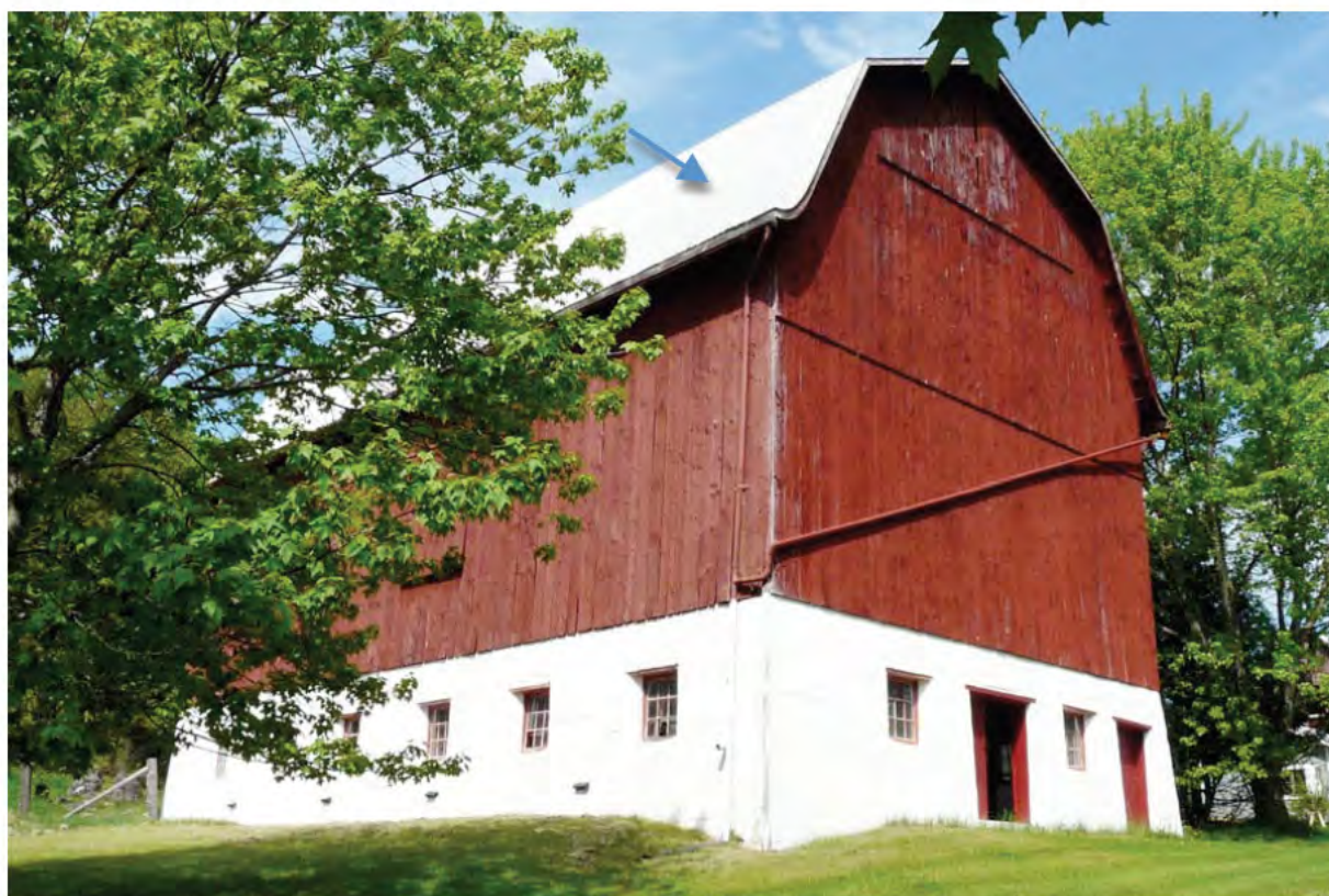
Grange avec étable au rez-de-chaussée, typique de la région outaouaise. À remarquer l'avant-toit retroussé (flèche) à la base du brisis (partie inférieure de la toiture), 449, route 105, Low. P1140758.jpg
