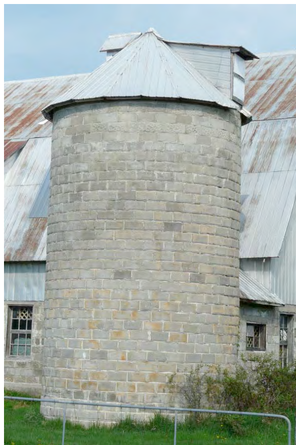
Silo en blocs de béton à couronnement conique, 218, chemin de la Rivière-Gatineau, Bouchette. P1140928.jpg
