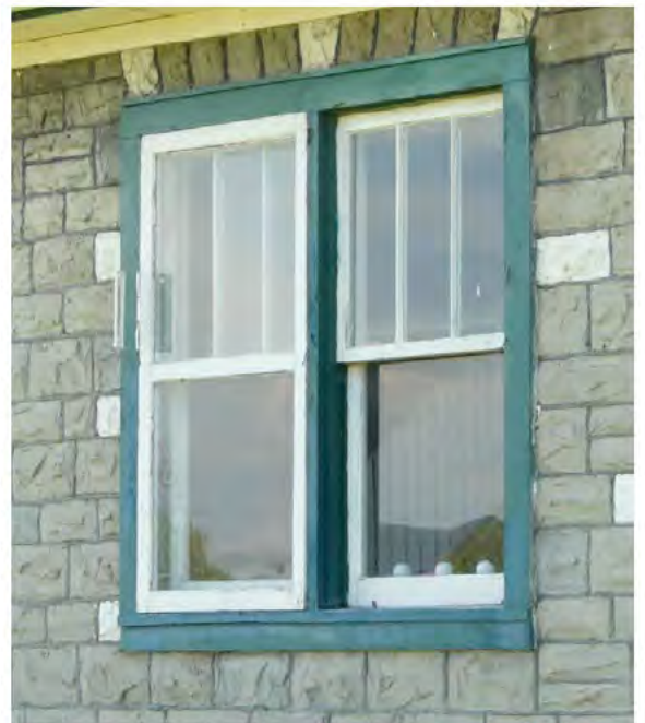
Fenêtres jumelées à guillotine, à petits-bois ou meneaux verticaux, 924, route 105, Low. P1140863.jpg
