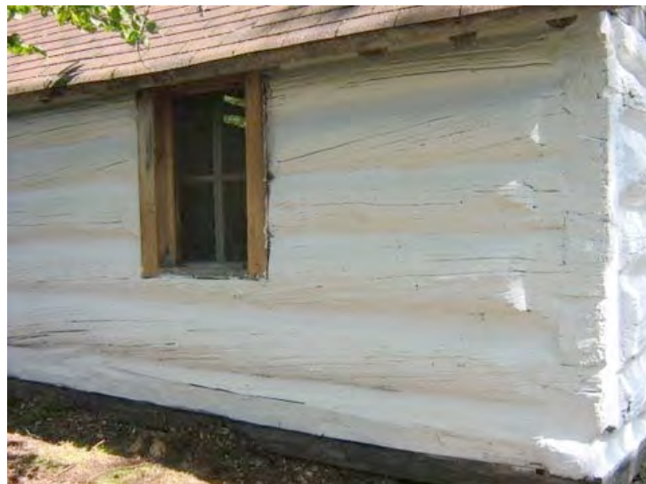
Détail du mur de l'ancien poste de traite de la Compagnie de la baie d'Hudson, formé d'imposantes pièces de bois assemblées à queue d'aronde. Extérieur côté.jpg
