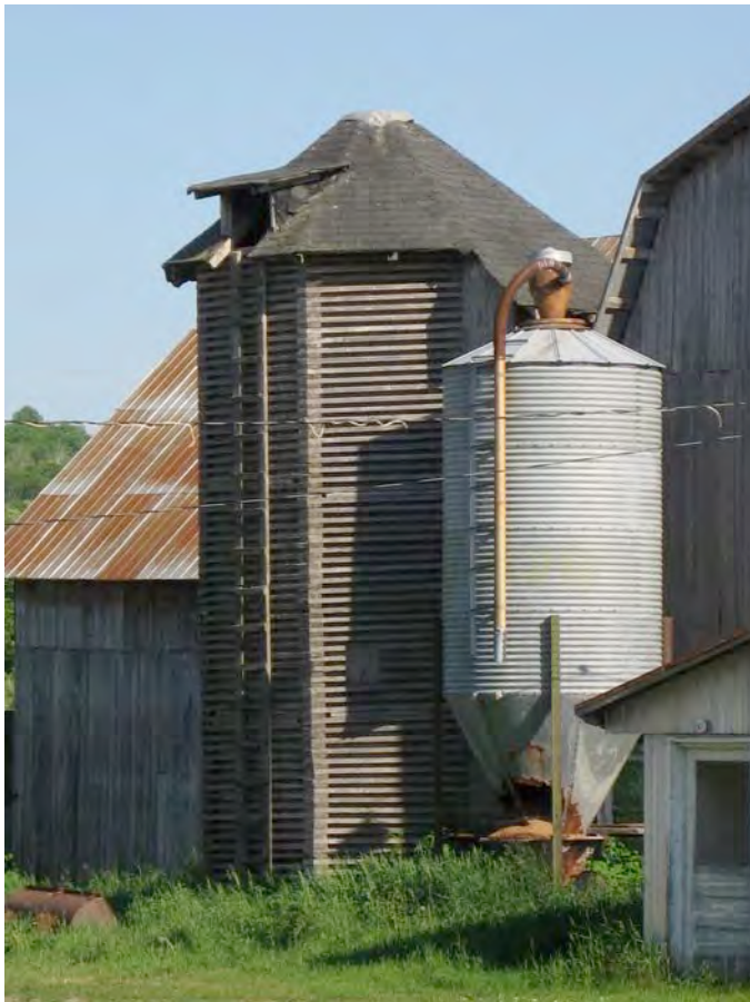
Un des très rares silos en bois qui subsistent encore dans la MRC, 364, route 105, Bois-Franc. 78D.jpg
