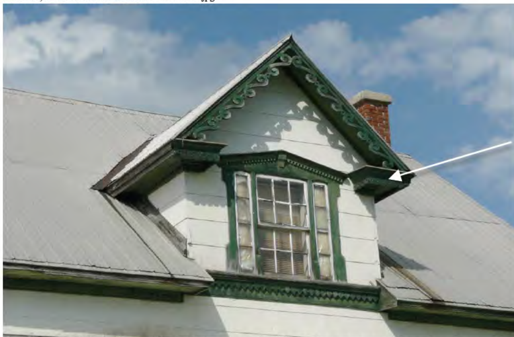
Lucarne à pignon, nantie de boiseries ornementales et, à sa base, de retours de l'avant-toit, 853, route 105, Low. P1140730.jpg
