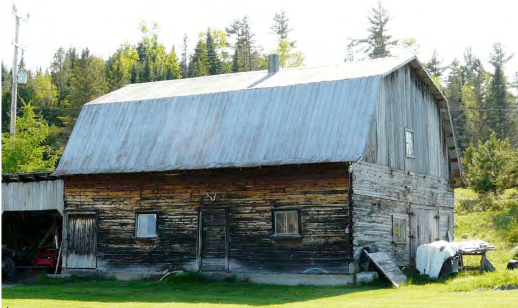
Écurie ou étable en pièce sur pièce construite vraisemblablement entre 1920 et 1930, rue Principale, Messines. Contrairement aux bâtiments plus anciens, les pièces sont simplement croisées aux angles (sans queue d'aronde). En outre, les traces de scie circulaire à la surface des pièces coïncident avec la période présumée de construction.
