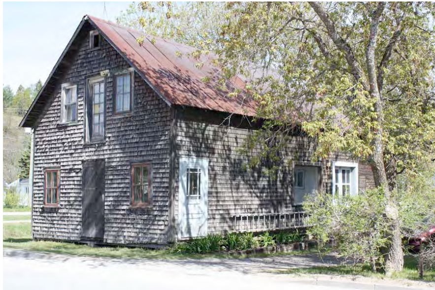
Exemple de bâtiment secondaire présentant un bon état d'authenticité, mais des carences au point de vue de l'état physique. Remise au 2, chemin de Blue Sea, Gracefield. IMG_7449.jpg
