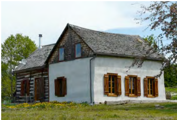
Le 50, chemin McDonald, Low, aurait été érigé vers 1840, ce qui en ferait l'un des plus anciens de la MRC. P1140802.jpg
