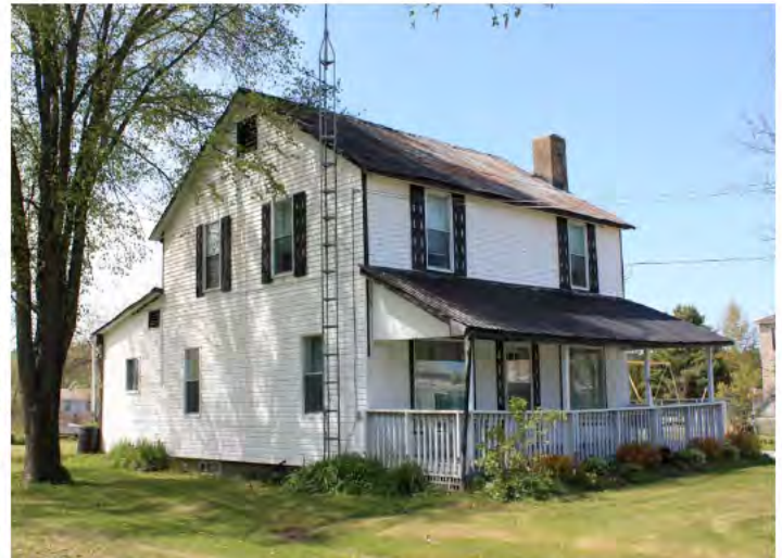
Chemin de Blue Sea Nord, Blue Sea, bâtiment principal sur lequel des changements ont été apportés aux revêtements et aux ouvertures; ils demeurent cependant en bonne partie réversibles. IMG_7930.jpg
