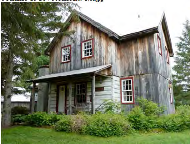
Chemin Savard, Aumond, bâtiment en pièce sur pièce dont le carré d'origine a été rehaussé. 56C.jpg
