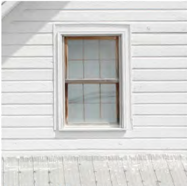
Fenêtre à guillotine à petits carreaux, le plus ancien des modèles de fenêtre à guillotine, 231, rue Principale Sud, Maniwaki. IMG_7236.jpg
