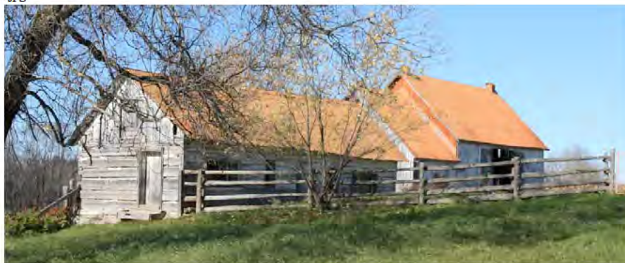
Poulailler et autre bâtiment secondaire de la ferme Gilmour-Nault. IMG_2798.jpg
