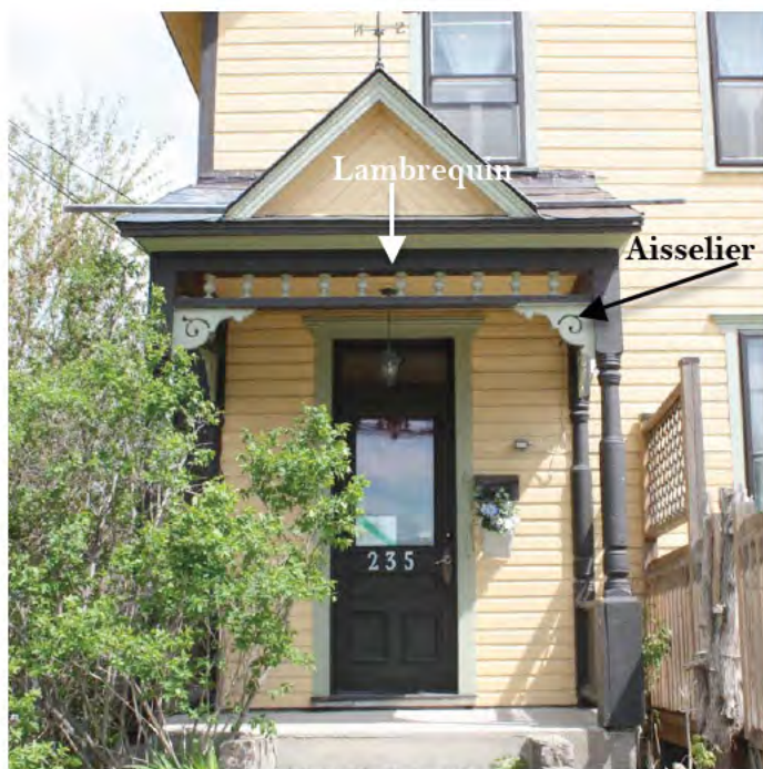
Portail plutôt rare dans la MRC. Des colonnes tournées surmontées d'aiseliers supportent le toit qui est mis en valeur par un fronton et, à sa base, un lambrequin à fuseaux, 235, rue Principale Sud, Maniwaki. IMG_7248.jpg
