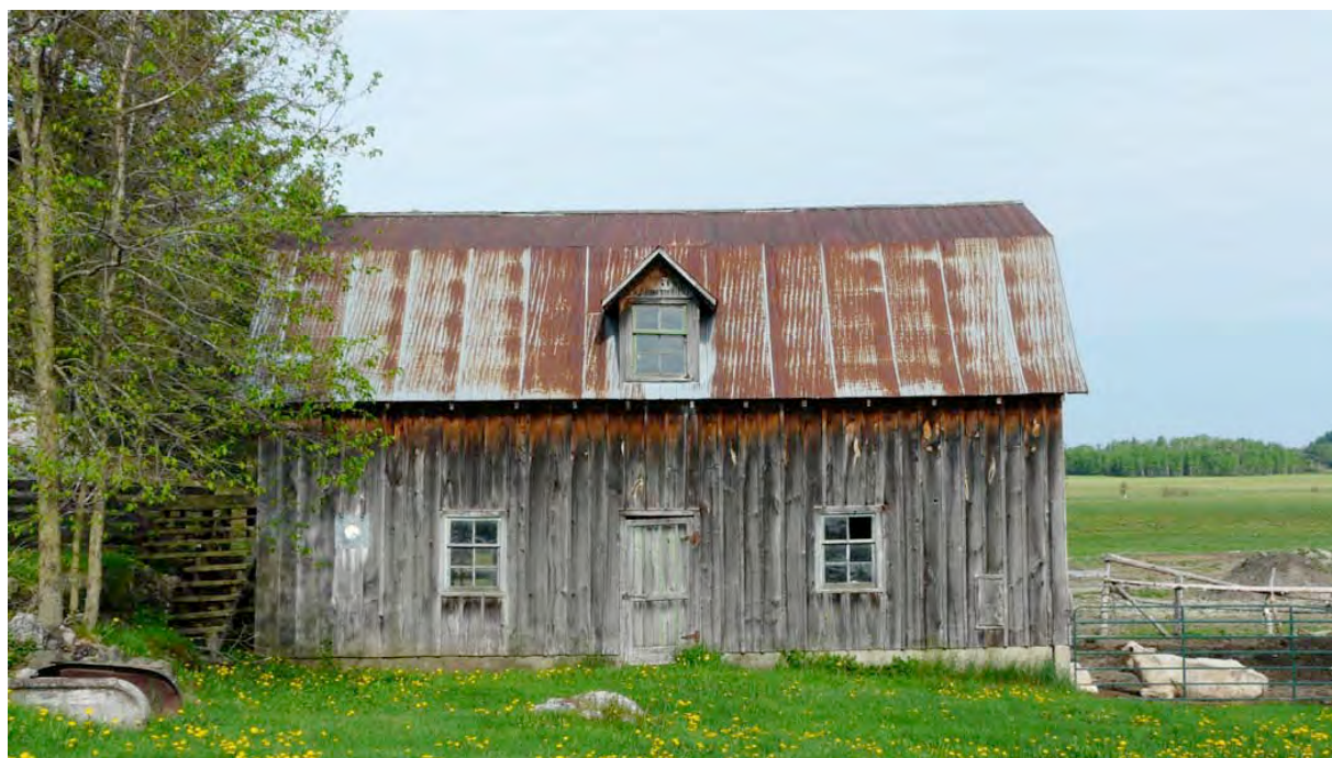
Étable recouverte de planches verticales, 81, rue Principale, Bouchette. P1140978.jpg
