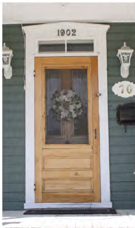
Sur cette porte ancienne, on remarque surtout la moustiquaire extérieure à double caisson. L'ensemble est mis en valeur par un chambranle, une corniche et une imposte à deux baies (au-dessus de la porte), 68, rue Roy, Maniwaki. IMG_7149.jpg
