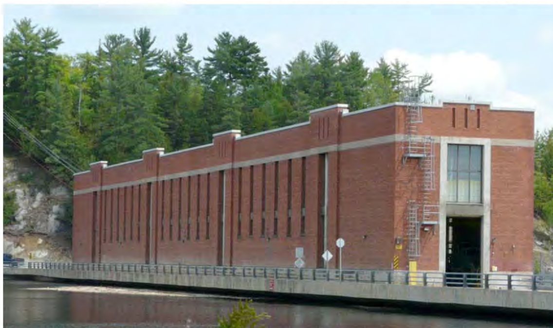
Centrale de Paugan, Low. P1150136.jpg
