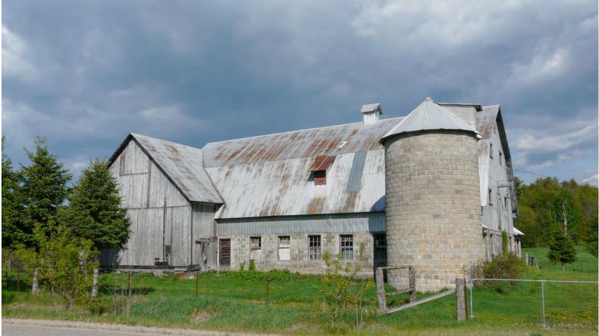
Le 218, chemin de la Rivière-Gatineau Nord, Bouchette. L'une des rares granges-étables répertoriées dans la MRC qui possèdent encore un silo (en blocs de béton dans ce cas-ci). P1140929.jpg
