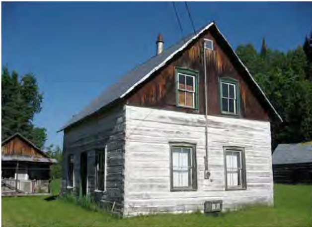
Maison du 3 e Rang Nord, Montcerf-Lytton, ayant conservé une parfaite intégrité architecturale. Les fenêtres à battants à grands carreaux et les murs en pièce sur pièce sont bien visibles. 85A.jpg
