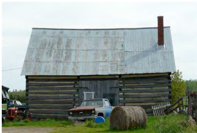
Remise en pièce sur pièce, 117, route 105, Kazabazua. P1140659.jpg
