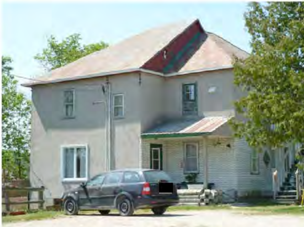
Édifice du chemin de la Rivière-Gatineau Sud, Bouchette, dont la volumétrie a été modifiée, tout comme le revêtement. 17A.jpg
