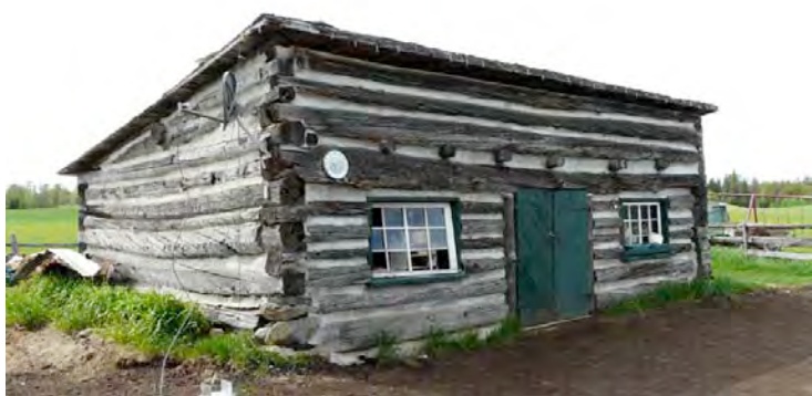
Remise au toit en appentis, 117, route 105, Kazabazua. P1140650.jpg
