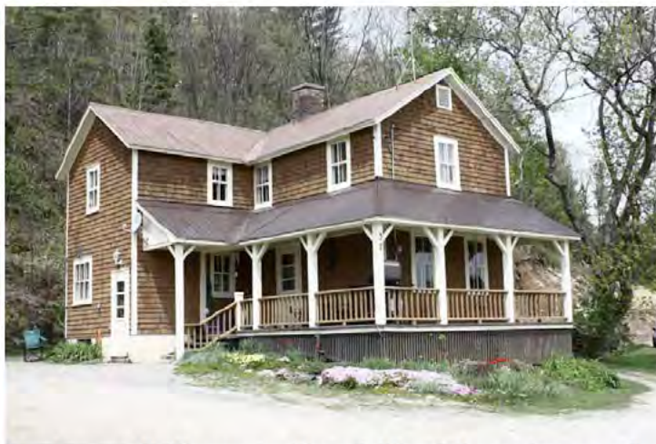
Le 37, rue Vaillancourt, Gracefield, où le revêtement de bardeau de bois, les fenêtres à grands carreaux et les garde-corps anciens ont été conservés. IMG_7539.jpg
