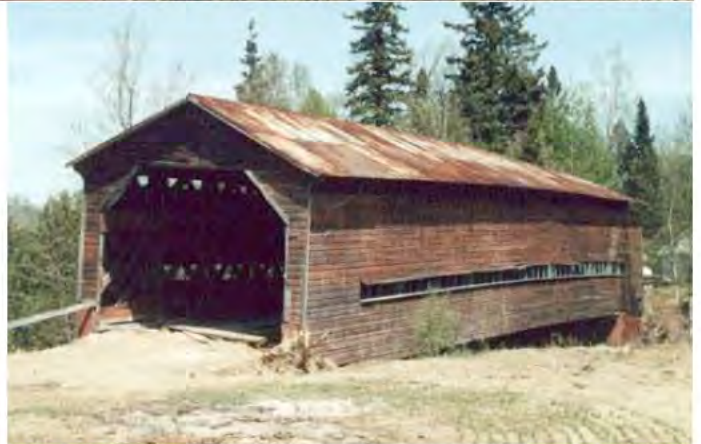
Pont Marois datant de 1933, route 105, Gracefield. Photo : RPCQ 1992, C92-140-28-35.jpg
