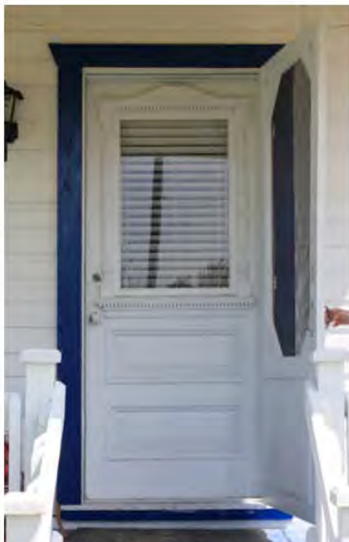
Porte à double caisson dont la partie vitrée est ornée de moulures, 2, rue Georges-Turnbull, Blue Sea. IMG_7894.jpg
