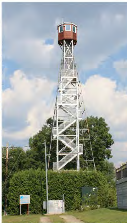
Tour à feu érigée vers 1945, Maniwaki. IMG_0718.jpg
