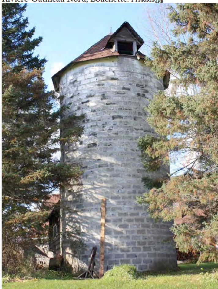
Silo en blocs de béton, jadis intégré à la ferme des Oblats, datant des années 1909-1910, 441, rue Guérette, Maniwaki. IMG_2809.jpg
