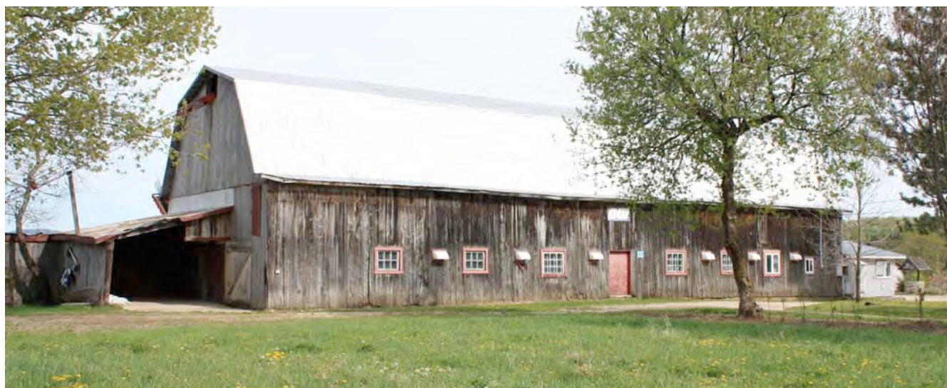
Revêtement de planche verticale sur une grange-étable. La planche verticale est un matériau souvent utilisé pour les bâtiments secondaires. Route 105, Messines. IMG_7979.jpg
