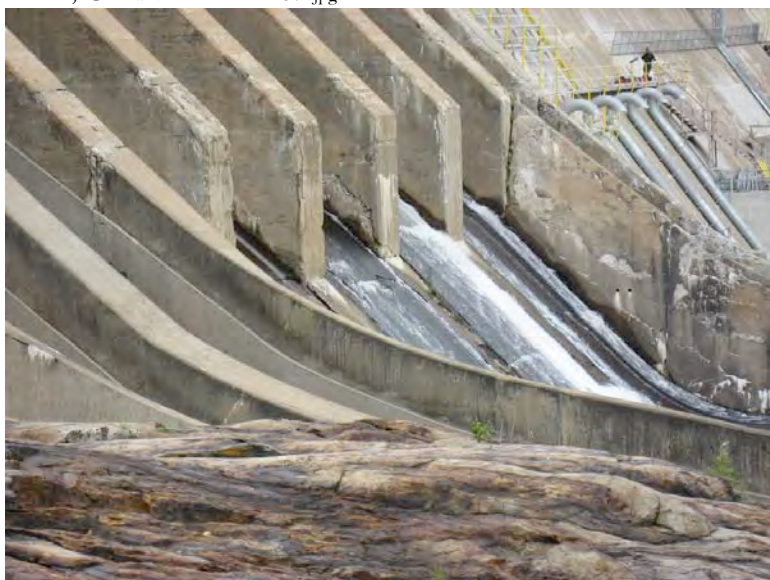
Détail des immenses évacuateurs de crue, barrage Mercier, Grand-Remous. 97B.jpg
