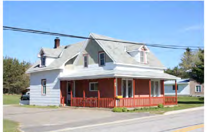
Rue Principale, Messines, un bâtiment qui a été rénové, notamment sa fenestration et ses revêtements. IMG_7754.jpg
