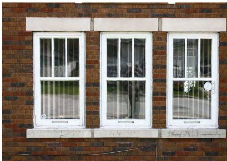
Linteaux et tablettes en béton disposés respectivement au-dessus et au-dessous des fenêtres à guillotine, 30, rue Principale, Bouchette. IMG_7567.jpg
