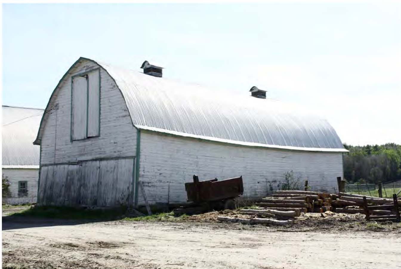
Un des bâtiments secondaires de la ferme des Six, caractérisé par un revêtement de planche à feuillure, la forme en arc brisé de la toiture et les lanternons de ventilation. IMG_7691.jpg
