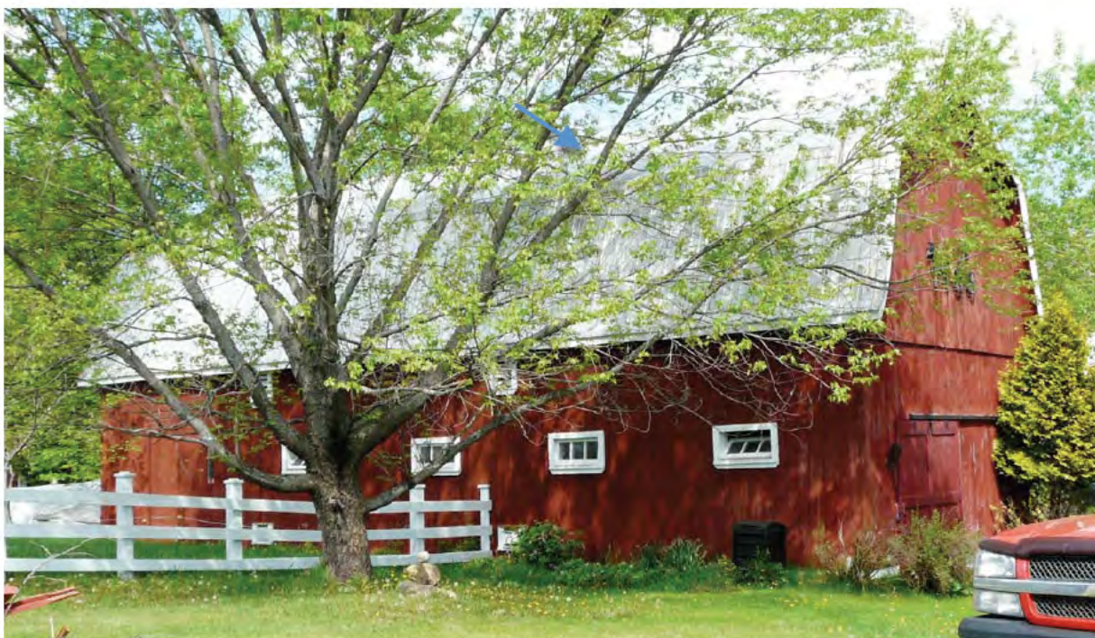
Ancienne écurie, revêtue de planches verticales, 449, route 105, Low. P1140766.jpg
