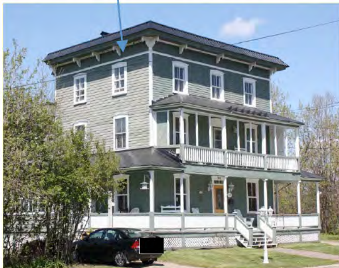
Maison Anastase-Roy, 68, rue Roy, Maniwaki. Cet édifice a connu une intéressante évolution architecturale si l'on compare la photo actuelle avec la photo ancienne. IMG_7147.jpg
