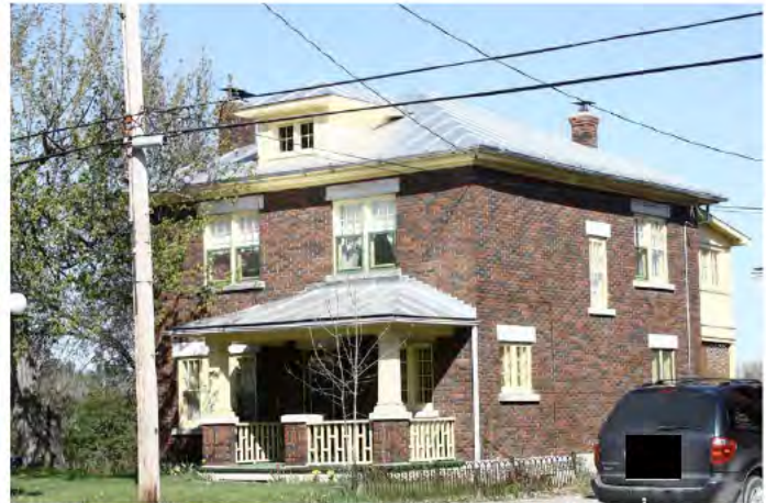
Le 218, rue Notre-Dame, Maniwaki. L'édifice présente une parfaite intégrité architecturale quant à ses matériaux, ses ouvertures et ses éléments décoratifs, dont le garde-corps de type stick style . IMG_7042.jpg
