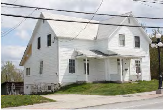
Le 231, rue Principale Sud, Maniwaki. IMG_7235.jpg
