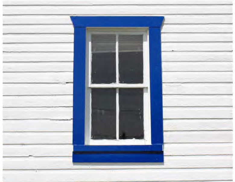
Fenêtre à guillotine à grands carreaux. Les chambranles ont été préservés, 2, rue Georges-Turnbull, Blue Sea. IMG_7889.jpg
