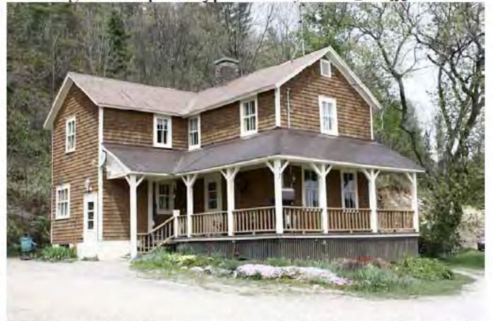
Le 37, rue Vaillancourt, Gracefield. Le revêtement de bardeau de bois, les fenêtres à grands carreaux et les garde-corps anciens ont été conservés. IMG_7539.jpg
