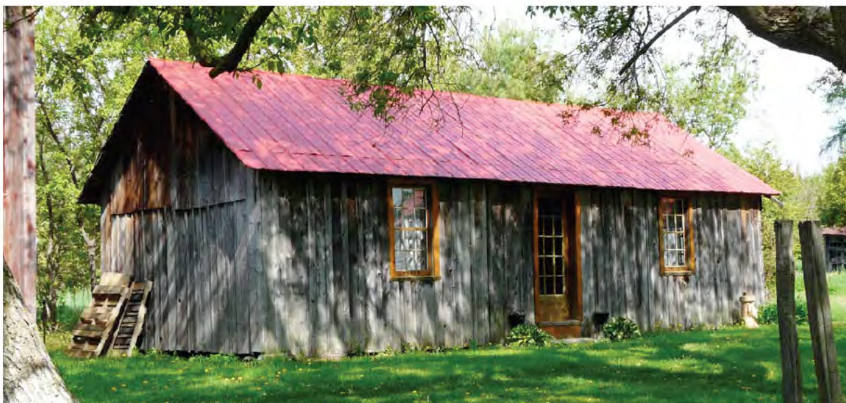
Remise, 13, chemin de la Gare-d'Aylwin, Kazabazua. P1150029.jpg
