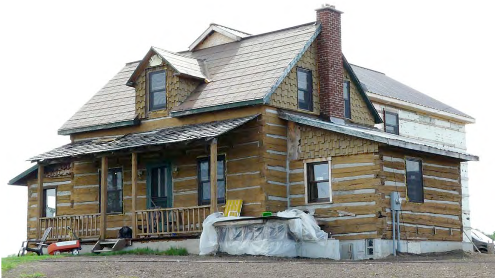
Le 117, route 105, Kazabazua, datant des années 1850, un bel exemple de bâtiment en pièce sur pièce. P1140642.jpg
