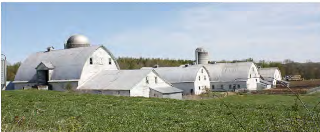
Vue d'ensemble de la Ferme des Six. IMG_7696.jpg
