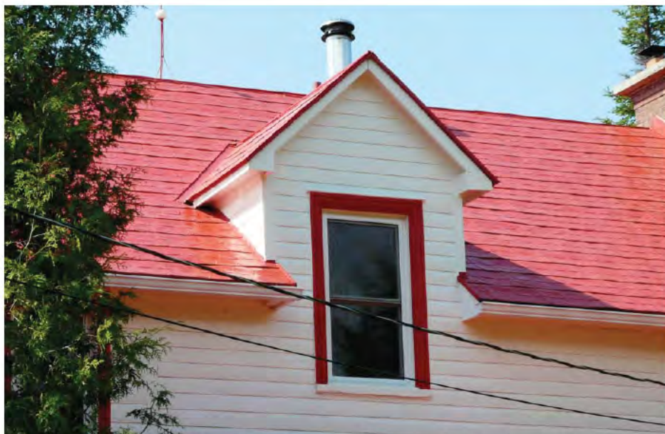
Lucarne à fenêtre pendante interrompant l'avant-toit, 13, chemin de la Gare-d'Aylwin, Kazabazua. P1150010.jpg
