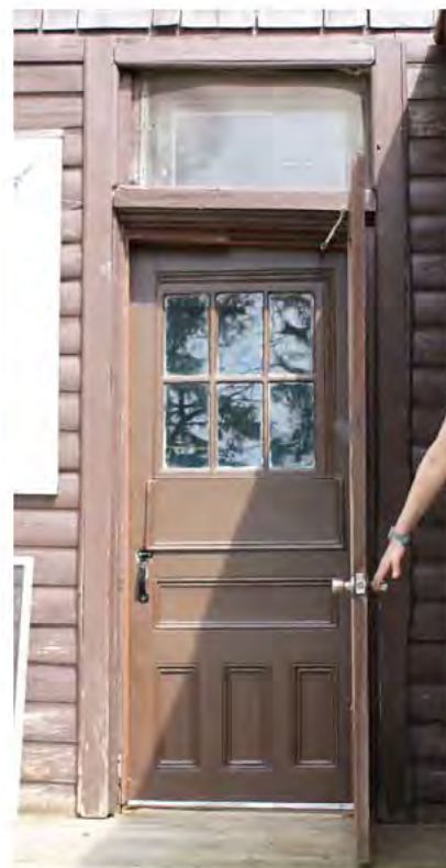
Porte à caissons et à vitrage à six carreaux. Elle est surmontée d'une imposte, 46, chemin d'Orlo, Blue Sea. IMG_7947.jpg
