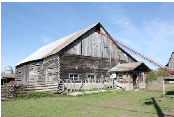
Grange-étable en pièce sur pièce, chemin de la Rivière-Gatineau Nord, Bouchette. IMG_7719.jpg
