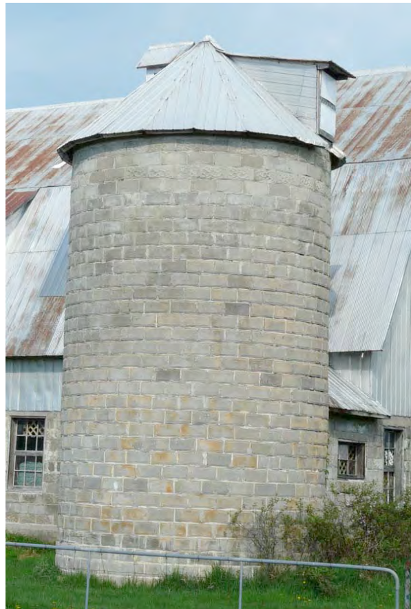
Silo en blocs de béton à couronnement conique, 218, chemin de la Rivière-Gatineau, Bouchette.
