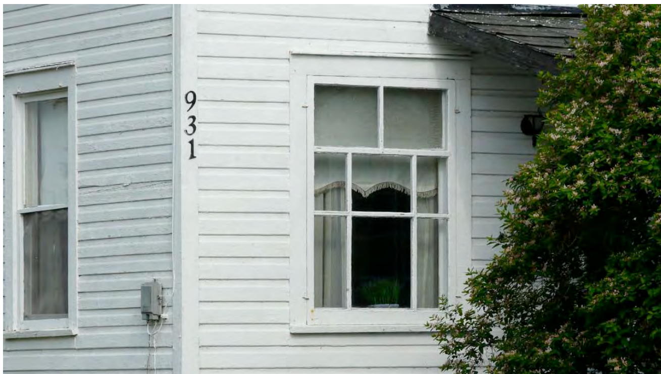
Les contre-fenêtres offrent parfois une configuration spécifique, comme c'est le cas ici, 931, route 105, Low. De tels types de contre-fenêtres sont devenus très rares dans la MRC. P1140714.jpg
