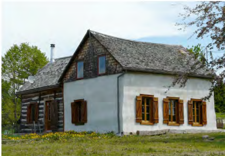
Le 50, chemin McDonald, Low, aurait été érigé vers 1840, ce qui en ferait le plus ancien bâtiment de la MRC. P1140802.jpg
