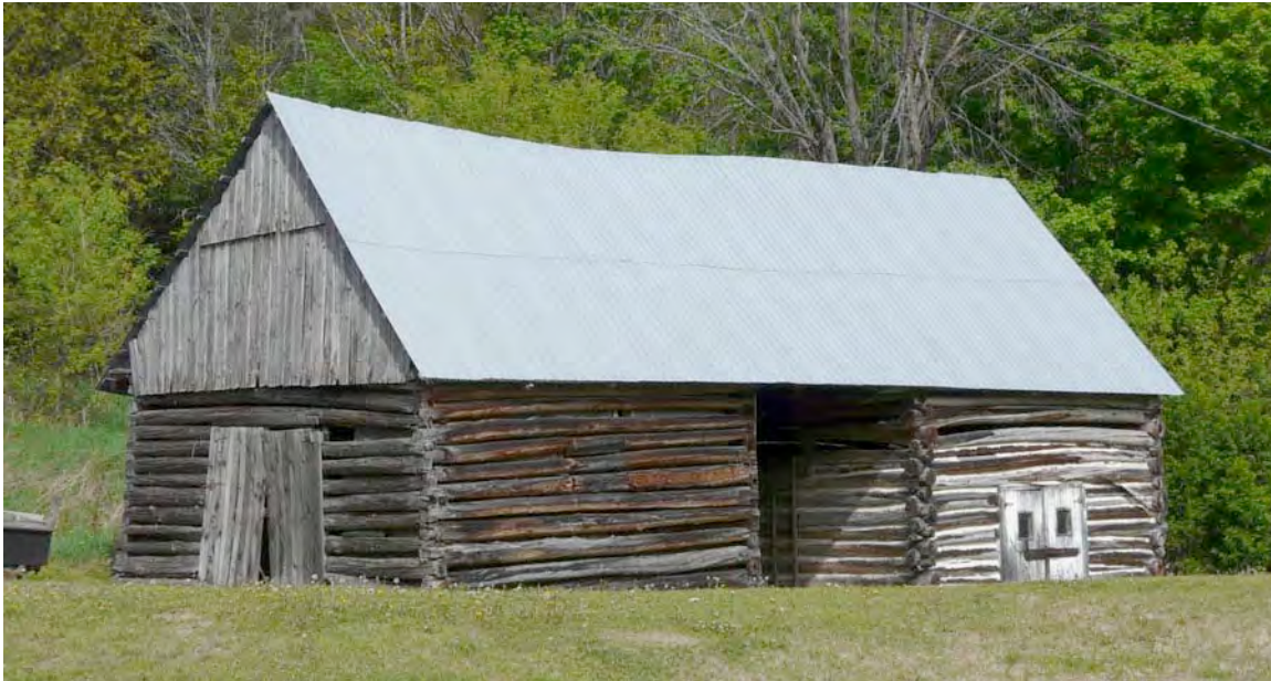
Le 35, chemin Lagarde, Lac-Sainte-Marie. Grange en bois rond, datant possiblement des années 1880 (ou avant). Ce modèle constitue une forme archaïque de toutes les granges au Québec : deux tasseries séparées par une batterie. P1140411.jpg
