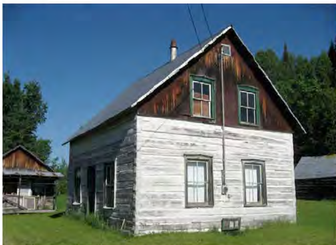
3 e Rang Nord, Montcerf-Lytton, maison ayant conservé une parfaite intégrité architecturale. Les fenêtres à battants à grands carreaux et les murs en pièce sur pièce sont bien visibles. 85A.jpg
