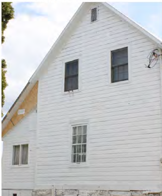
Revêtement de planche à feuillure, 231, rue Principale Sud, Maniwaki. Il s'agit d'une planche embouvetée posée à l'horizontale mais dont le joint est marqué d'une large rainure, la feuillure . IMG_7240.jpg
