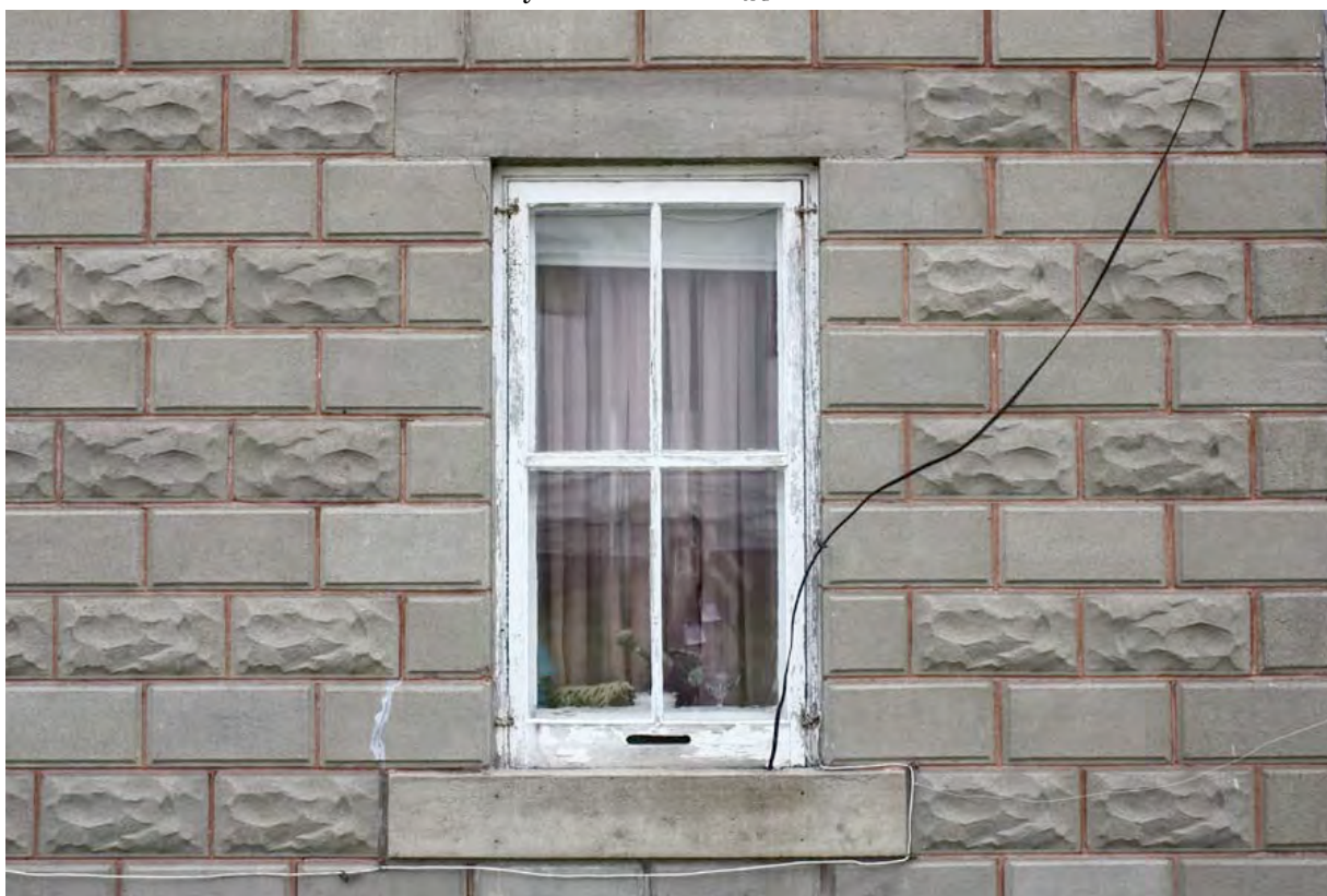
Revêtement de blocs de béton imitant la pierre taillée à bossage, 44, rue Principale, Gracefield. Ce type de revêtement est très répandu dans la MRC et constitue une particularité régionale. IMG_7240.jpg
