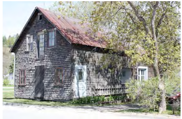
Le 2, rue Saint-Eugène, Gracefield. Remise présentant un bon état d'authenticité, mais un mauvais état physique. IMG_7449.jpg
