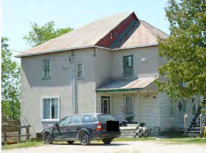
Chemin de la Rivière-Gatineau Sud, Bouchette, bâtiment principal dont la volumétrie a été modifiée, tout comme le revêtement et la majorité des ouvertures. 17A.jpg
