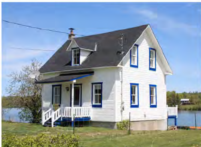
Le 2, chemin George-Turnbull, Blue Sea, maison où tous les éléments d'origine sont en place (revêtements, ouvertures, composants décoratifs). IMG_7885.jpg
