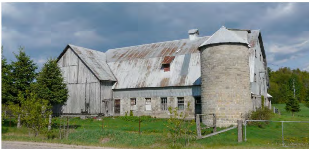
Une des rares granges-étables répertoriées dans la MRC avec un silo de béton, 218, chemin de la Rivière-Gatineau Nord, Bouchette. P1140929.jpg
