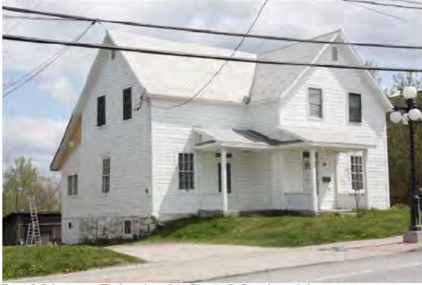
Le 231, rue Principale Sud, Maniwaki. IMG_7235.jpg
