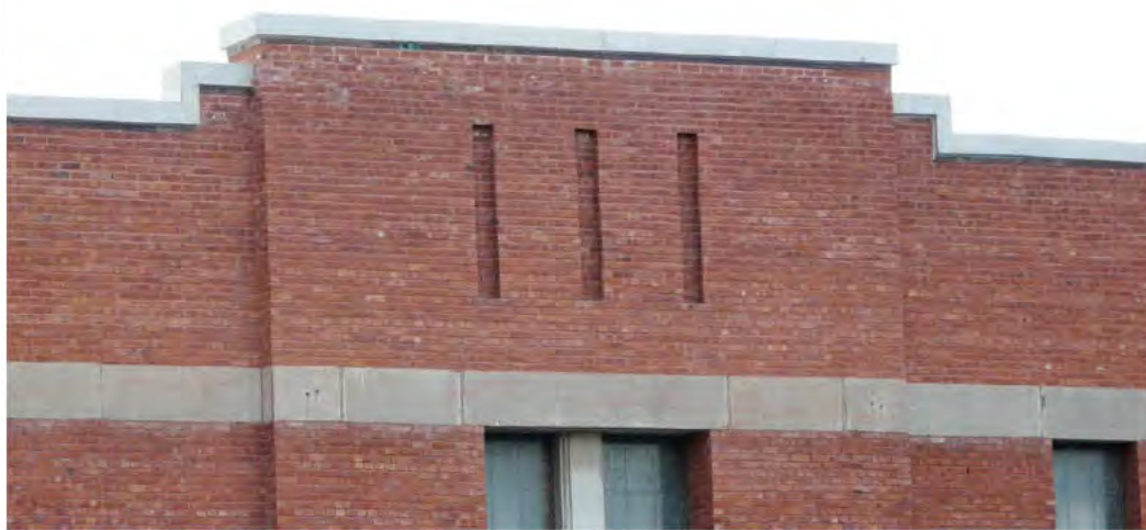
Détail du parapet en brique et du linteau en pierre, centrale de Paugan, Low. P1150117.jpg
