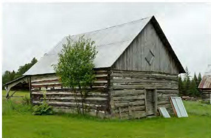
Bâtiment secondaire qui daterait de 1870 environ, 182, chemin de Sainte-Thérèse-de-la-Gatineau, Délage. 50D.jpg
