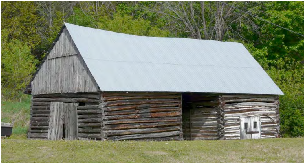
Grange en bois rond datant possiblement des années 1880 (ou avant), 35, chemin Lagarde, Lac-Sainte-Marie. Ce modèle constitue une forme archaïque de toutes les granges au Québec : deux tasseries séparées par une batterie. P1140411.jpg
