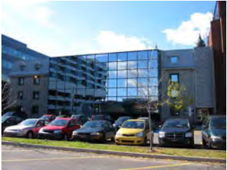
Immeuble René-Nicolas-Levasseur. Vue arrière
