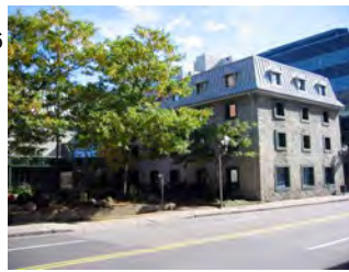
Immeuble René-Nicolas-Levasseur. Vue avant
