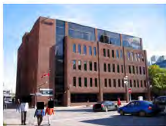
Immeuble Louis-Prat. Vue avant
