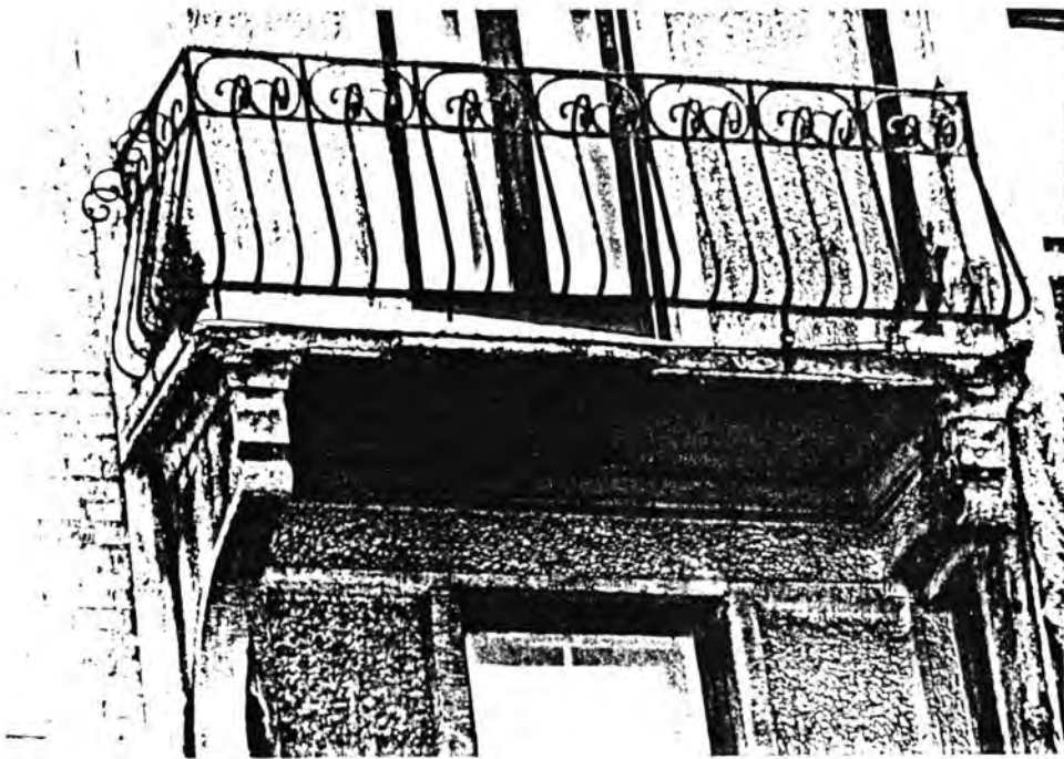
71. Balcon situé dans la section sud de la façade est, 2e étage.
