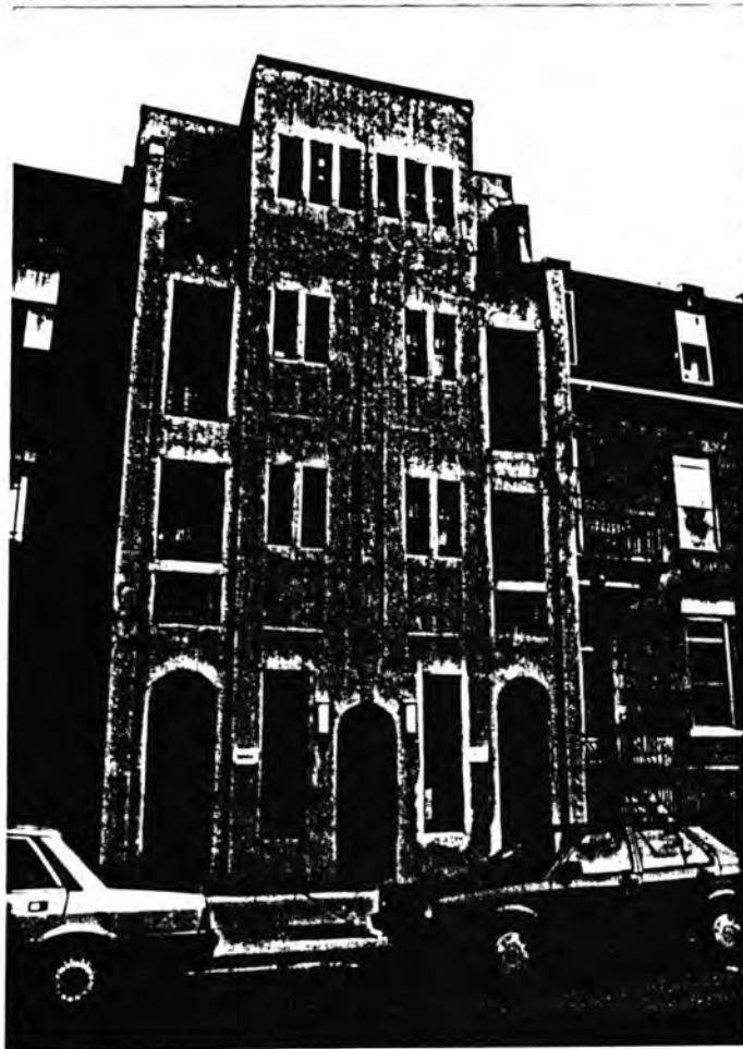
122. Edifice de rapport, 3903 Saint-Denis.
