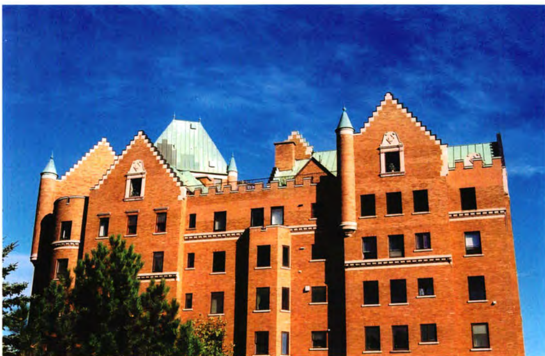
Les parties hautes de l'immeuble Trafalgar: en haut, sur la face nord; en bas, sur la face ouest.
