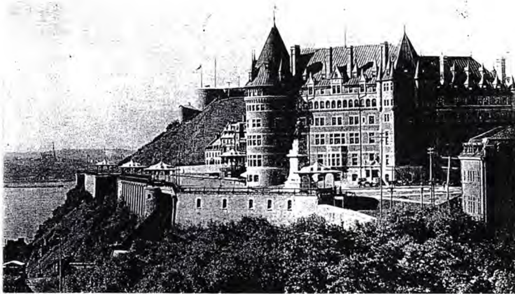
L'hôtel Château Frontenac à Québec. Premier état, Bruce Price, 1892-93.
