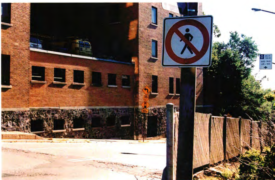
L'immeuble Trafalgar: deux vues de la face sud.
