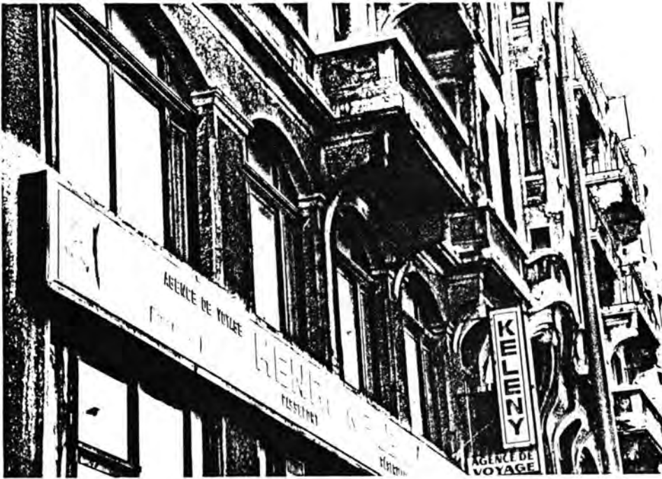
73. Balcons situés sur la façade est, premier étage.
