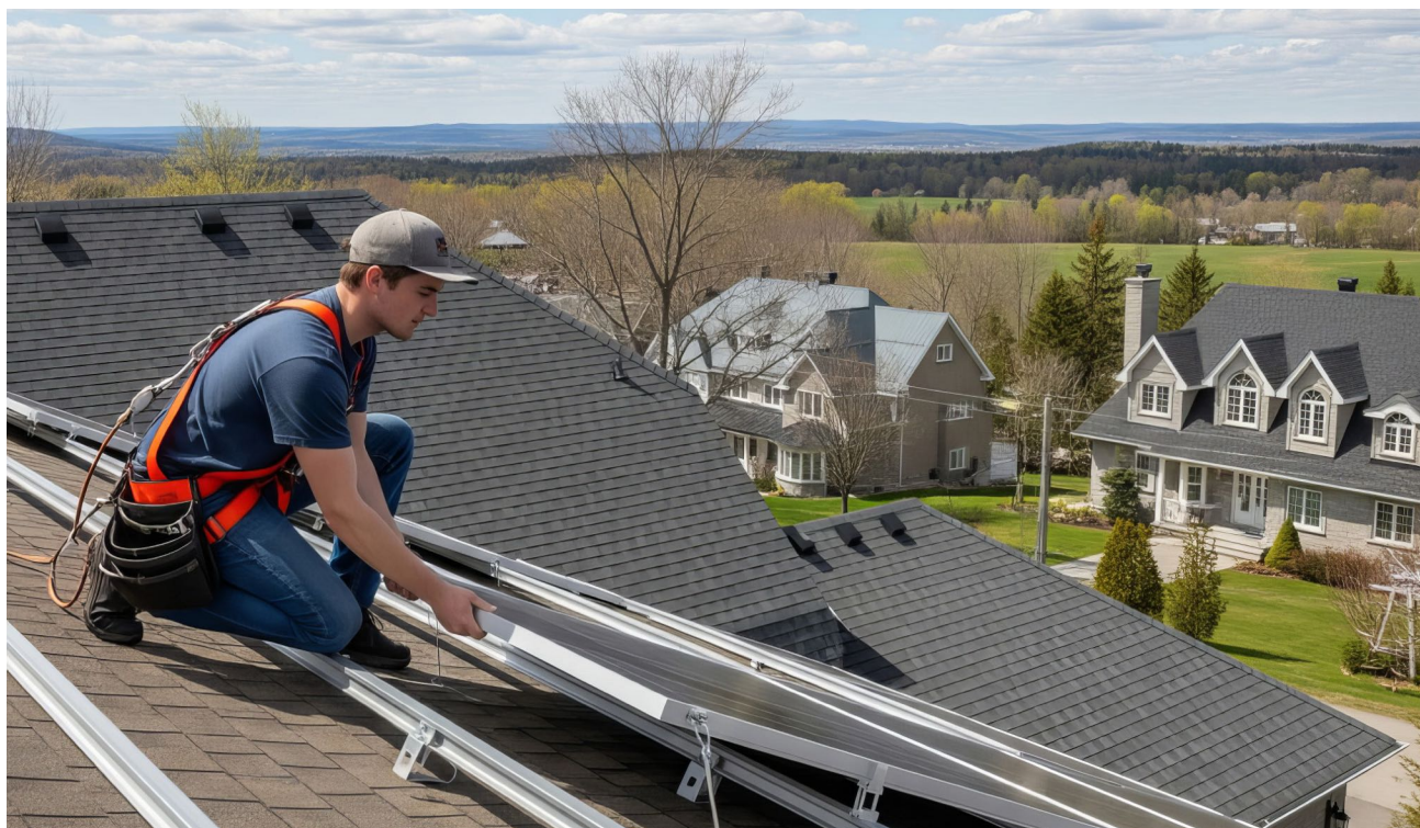
Installateur à l'œuvre : Crédit ESQ
