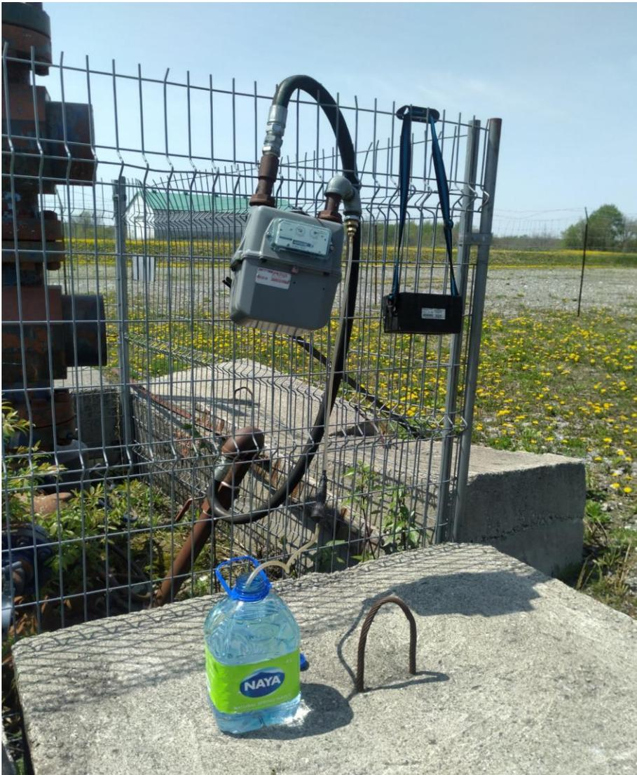
Photo 3 : test de bulle à l'évent du tubage de surface : aucune bulle
