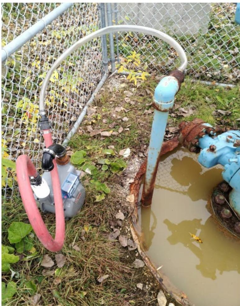
Photo 2 : Installation d'un débitmètre pour 24 heures
