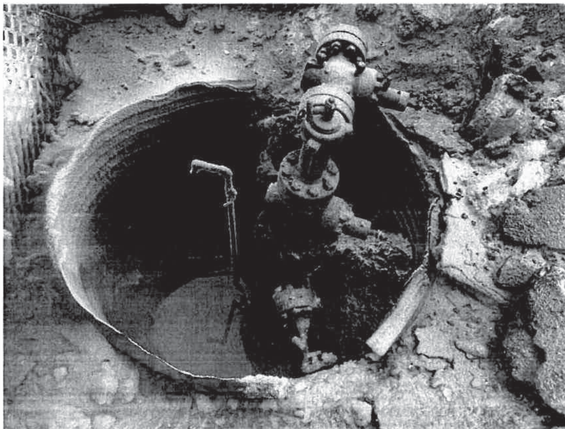
Figure 4 : Puits après l'incident (15 février 2020)
