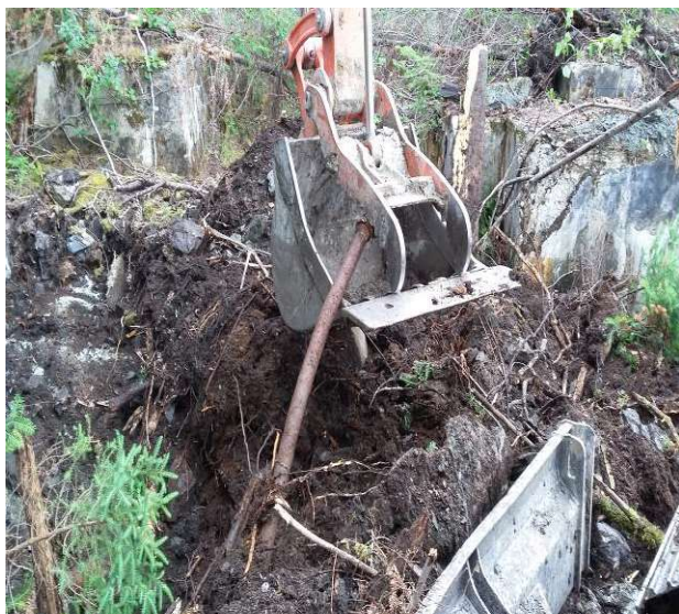
Photographie 31. Excavation de TR-29-17. Secteur industriel.
