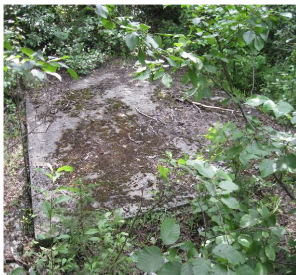
Photographie 16. Dalle du puits #1. Vue vers l'est.
