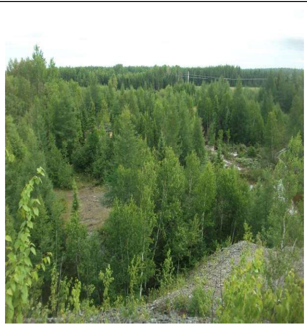
Photographie 10. Vue d'une partie de l'ancien secteur industriel. Vue vers le nord.
