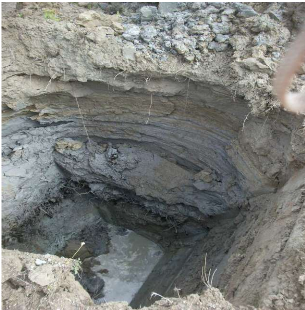
Photographie 25. Excavation de TR-13-17. Parc sud.
