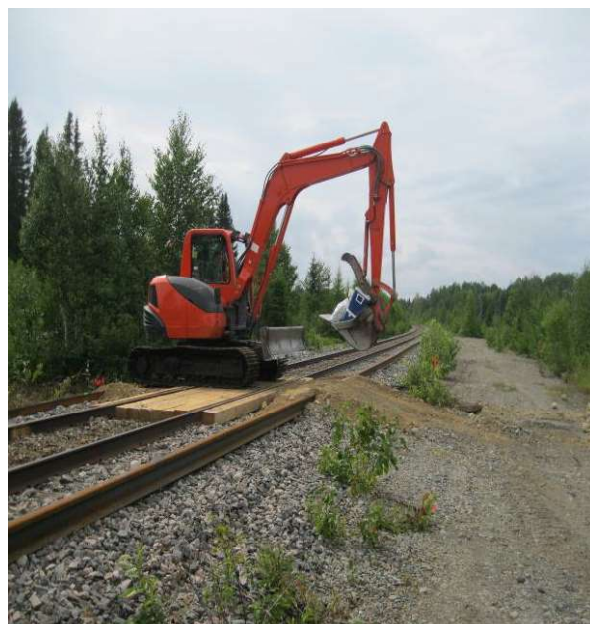
Photographie 42. Traverse de la voie ferrée. Vue vers l'ouest.
