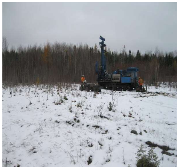
Photographie 32. Forage PO-10-17 en cours. Vue vers le nord- est.
