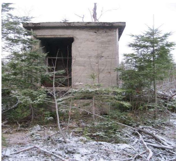
Photographie 19. Ancien entrepôt des explosifs. Secteur industriel.
