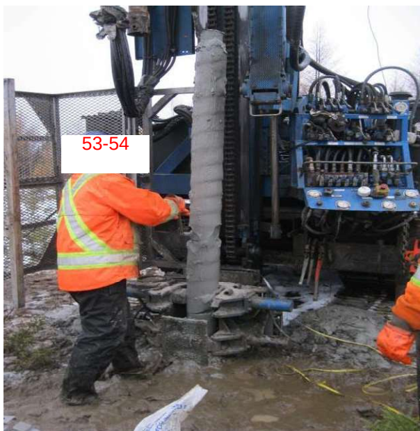
Photographie 33. Silt argileux issu du forage PO-09-17. Parc nord-ouest.
