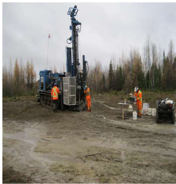
Photographie 34. Forage PO-12-17. Vue vers le nord-est.
