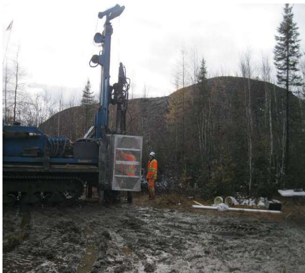
Photographie 35. Forage PO-15-17 en cours. Secteur halde. Vue vers le sud.
