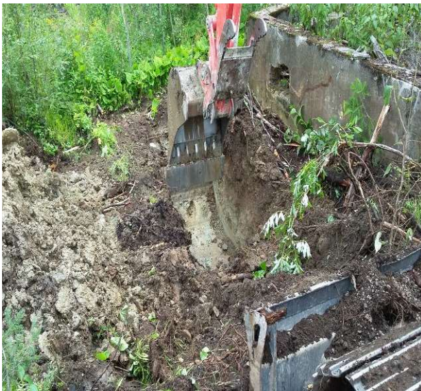
Photographie 27. Excavation de TR-20-17. Secteur industriel.
