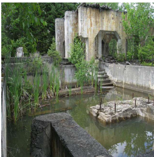
Photographie 13. Vestiges des fondations de l'ancien moulin. Emplacement de EFM-06-17. Vue vers le nord-ouest.
