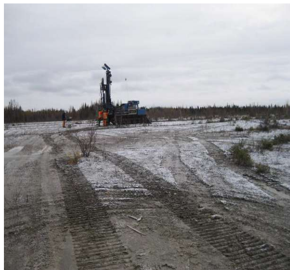
Photographie 36. Forage PO-03-17-B. Parc sud. Vue vers l'est.
