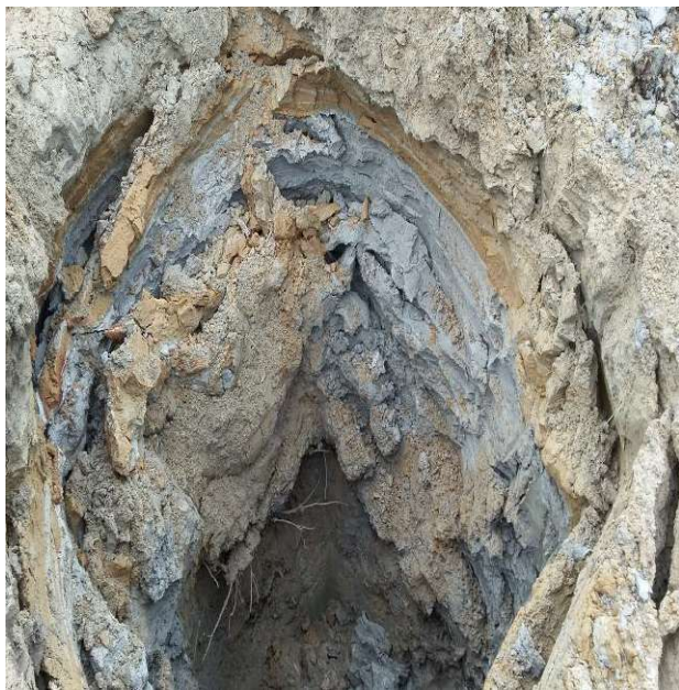
Photographie 29. Excavation de TR-24-17. Parc nord-ouest.
