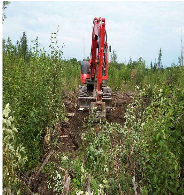
Photographie 26. Excavation de TR-18-17. Secteur industriel.
