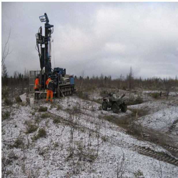
Photographie 37. Forage PO-04-17. Parc sud. Vue vers l'ouest.
