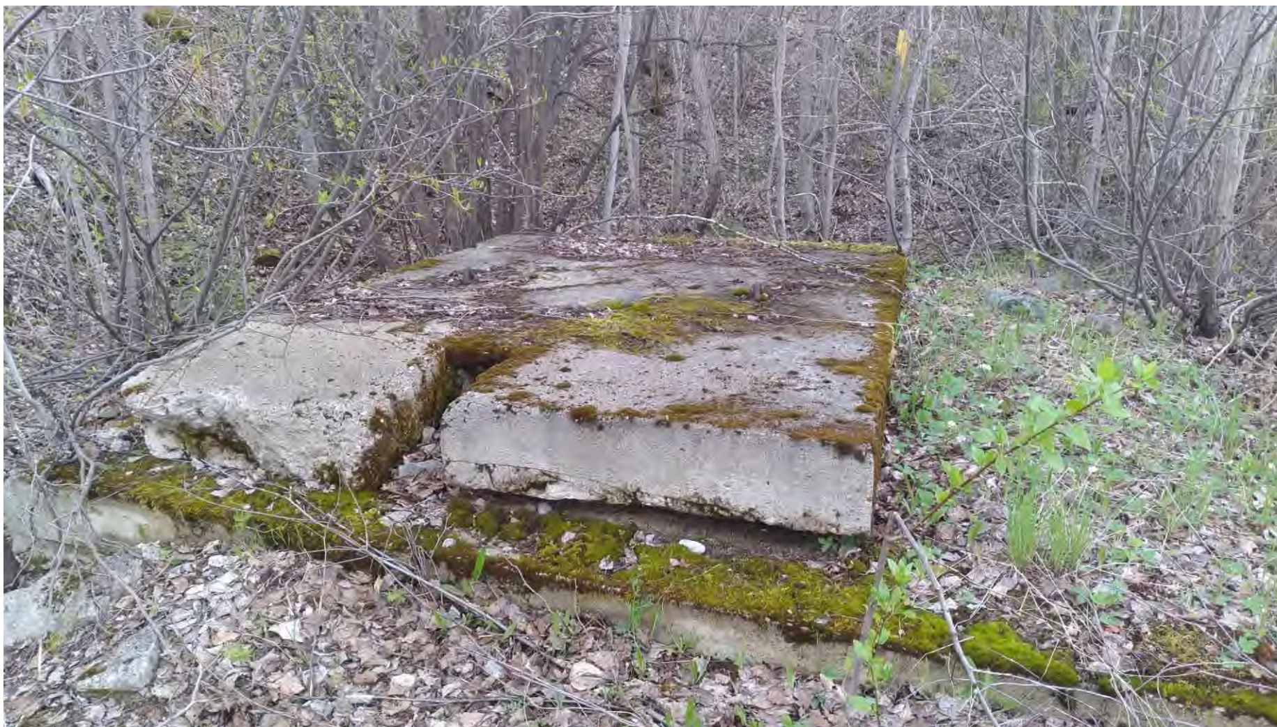
2021-05-20_CROI-010 : Seconde dalle de béton (cheminée de ventilation?)
