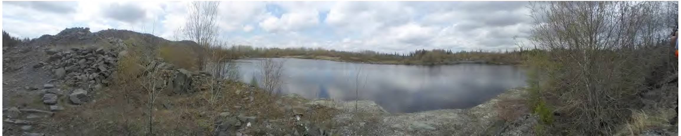
2021-05-20_CROI-022 : Halde à stériles Est et fosse Est – Vue du sud vers le nord
