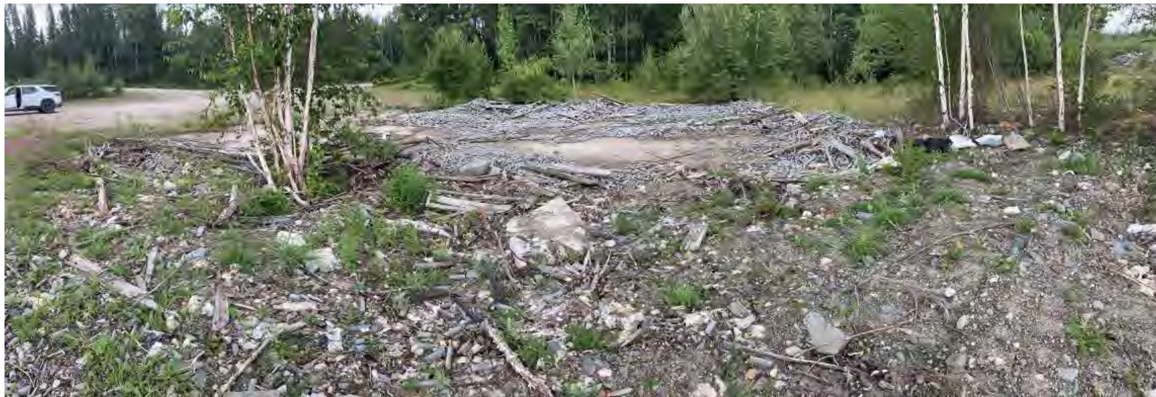
Photographie 2021-07-26_CROI-003 - Fondation du garage qui était présent à l'entrée du site UTM NAD 83 : 349558 Est / 5330294 Nord
