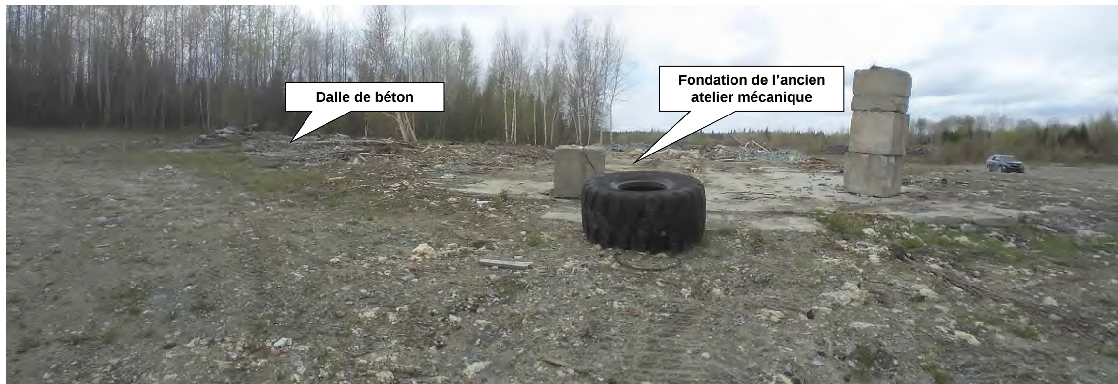
2021-05-20_CROI-019 : Dalle de béton et fondation de l'ancien atelier mécanique – Vue vers le Nord-Est
