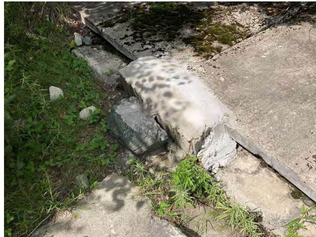
Photographie 2021-07-26_CROI-009 Bouchon de béton installé sur la dalle afin de la rendre sécuritaire UTM NAD 83 : 349745 Est / 5330493 Nord
