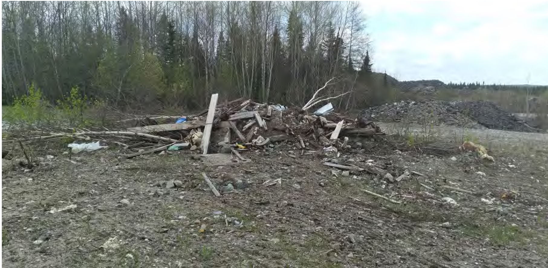
2021-05-20_CROI-020 : Débris de démolition au NE des fondations – Vue vers l'ouest
