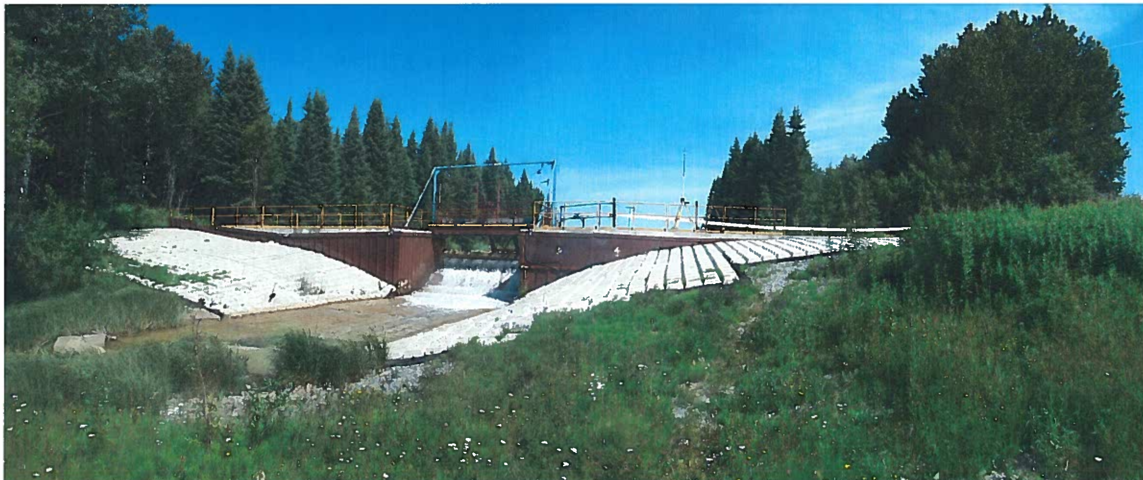
MLM-LW-2017-07-25-012 : Déversoir de l'effluent final à la station WLD.
