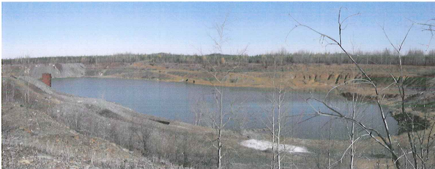
Photo 10 : La fosse MLM dont le niveau de l'eau est assuré par les pompes installées dans l'ancien puits.
