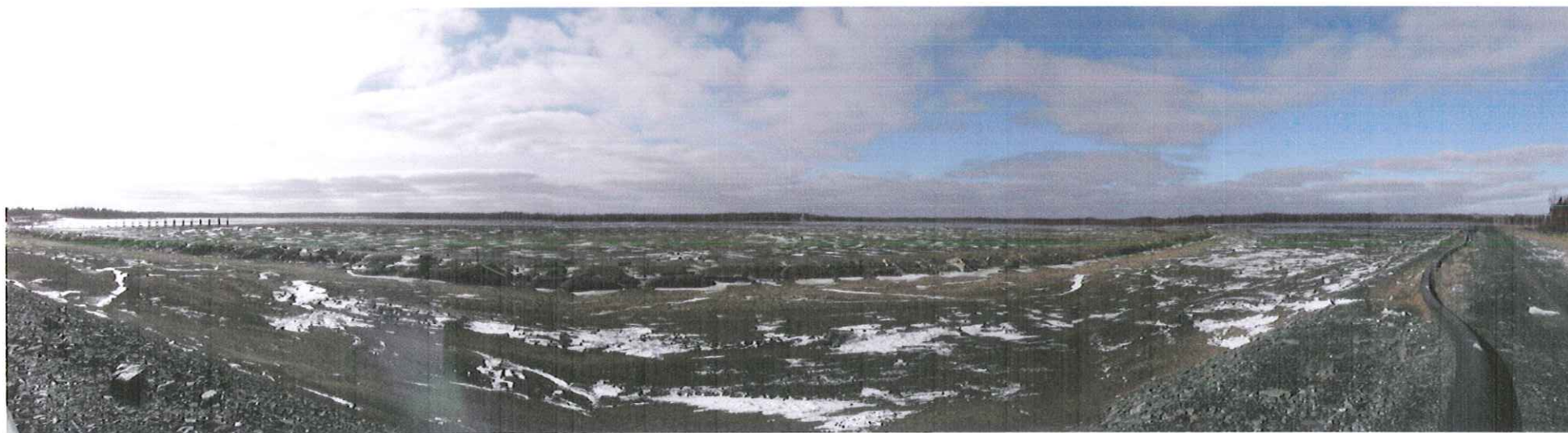
Photo 3 : Bassin Central et digue Lalanne
