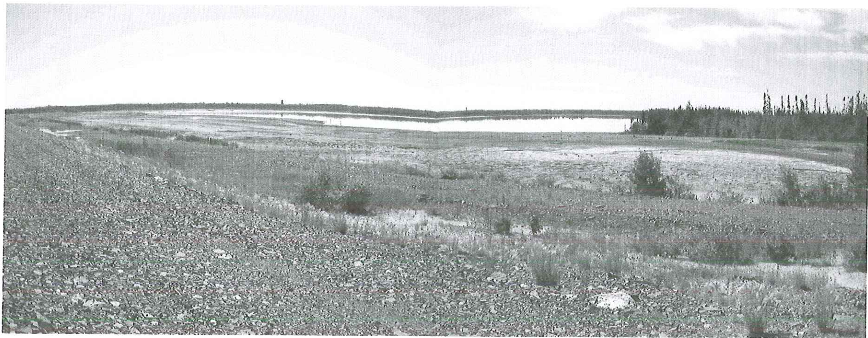
Photo 4 : Le bassin Sud vu de la digue centrale.
