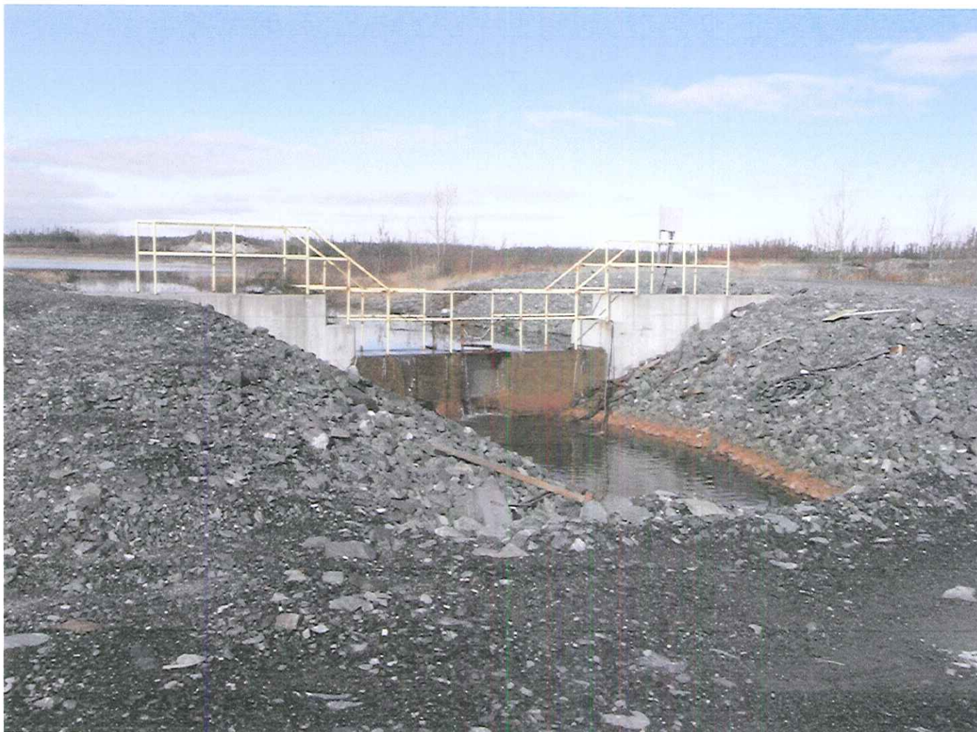
Photo 9 : Le déversoir du bassin Ouest dont le seuil est à sa hauteur finale.
