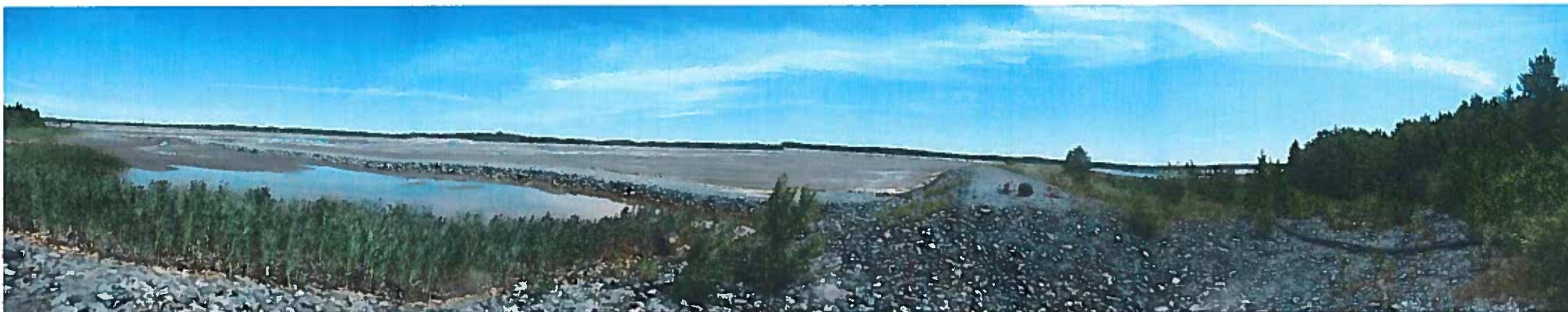
MLM-LW-2017-07-25-014 : Bassin central (à gauche) et bassin sud (à droite) du parc à résidus du Lac Watson vus de la digue centrale.
