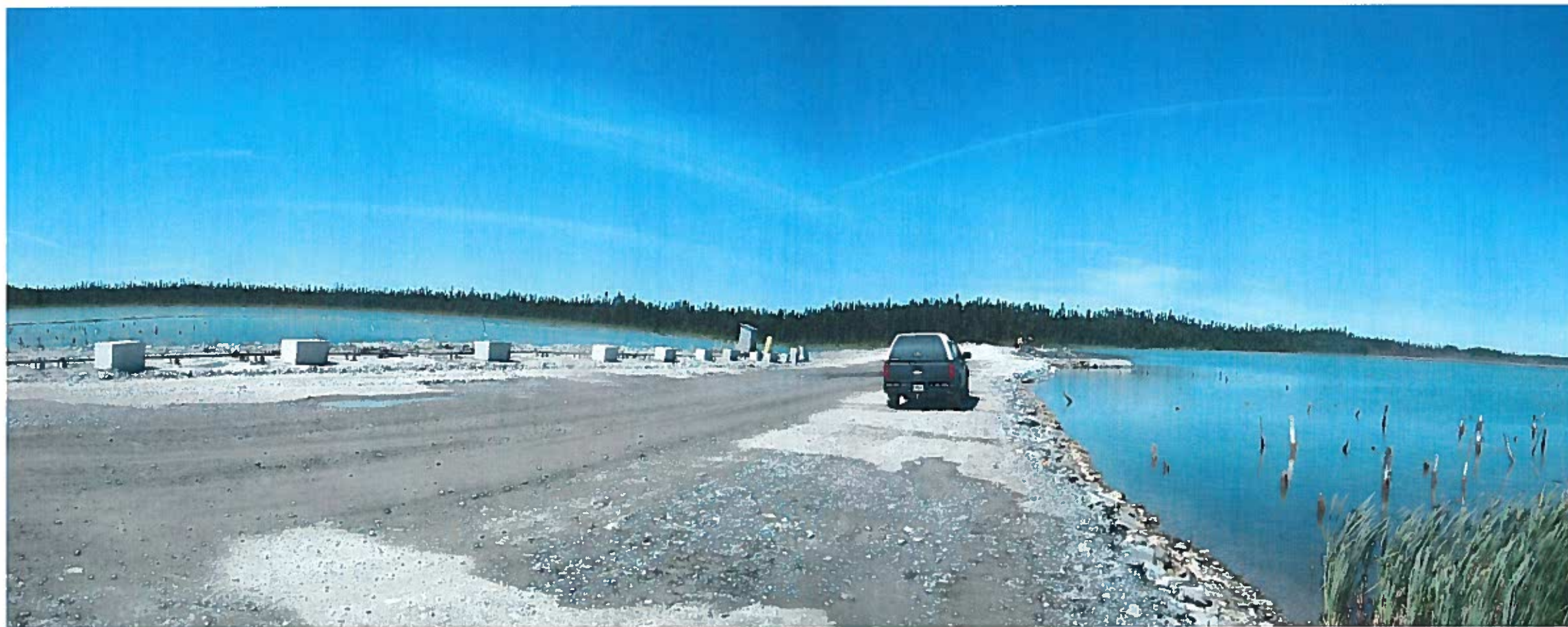
MLM-LW-2017-07-25-013 : Le berme filtrant au bassin sud du parc à résidus. Les stériles proviennent de la mine Persévérance. La portion gauche du bassin sud sert de bassin de polissage.
