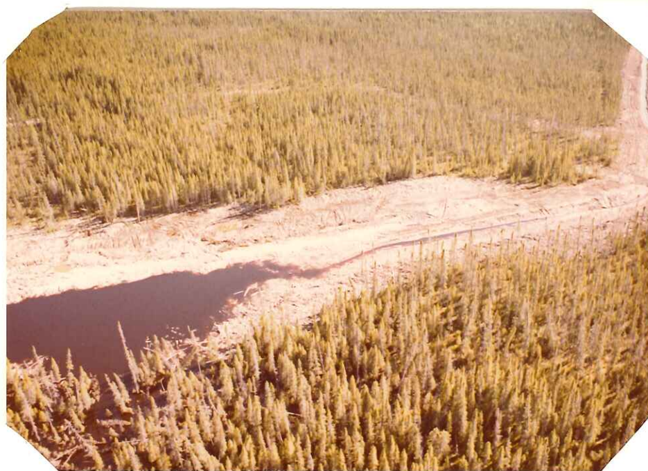
Canal de dérivation des eaux de surface du versant Ouest du bassin de drainage.
