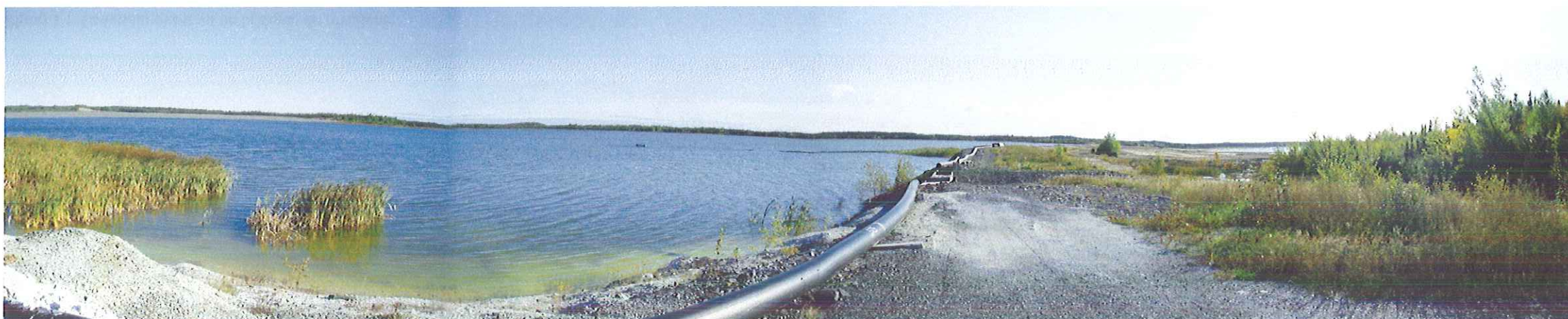
Photo 2 : À gauche le bassin central et à droite le bassin sud
