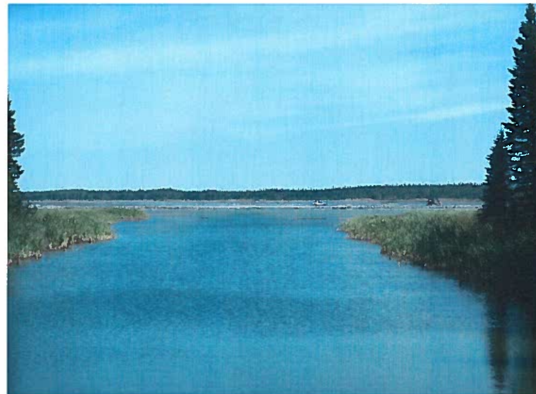
MLM-LW-2017-07-25-009 : Vue rapprochée (un peu) du berme filtrant au bassin sud du parc à résidus du Lac Watson.
