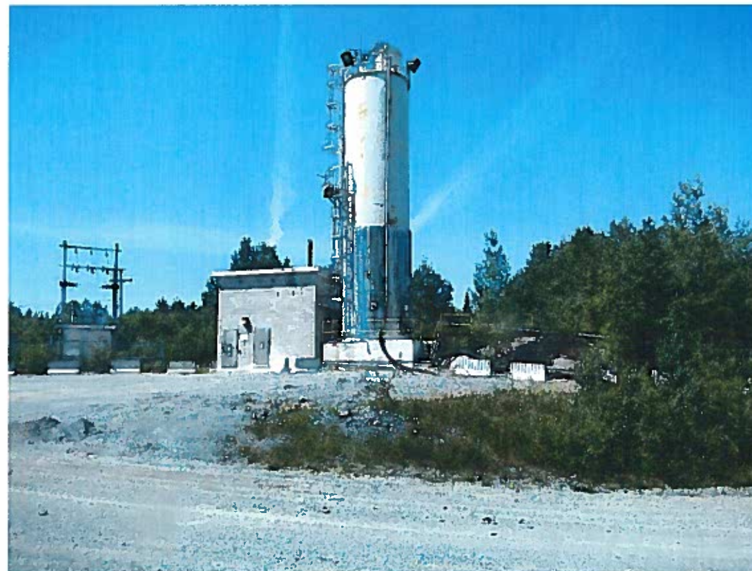
MLM-LW-2017-07-25-011 : Usine de chaulage au parc à résidus du Lac Watson.
