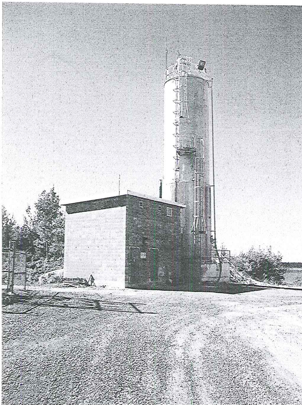
Photo 1 : L'usine de chaulage à l'extrémité sud-ouest de la digue centrale
