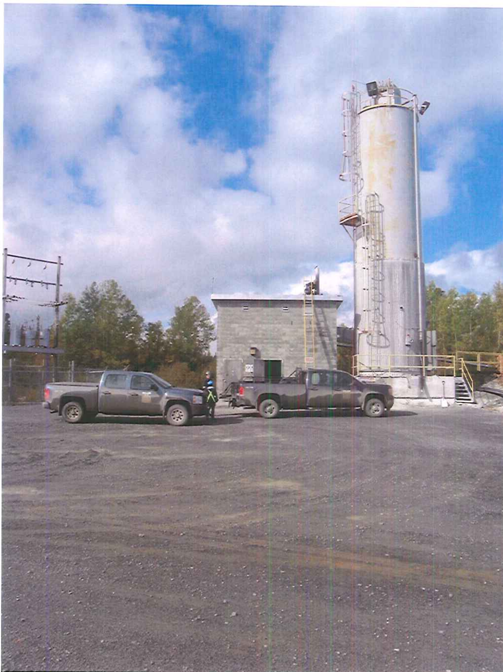
Photo 3 : L'usine de chaulage. Coordonnées UTM, 18U : 0299787E /5512886N.
