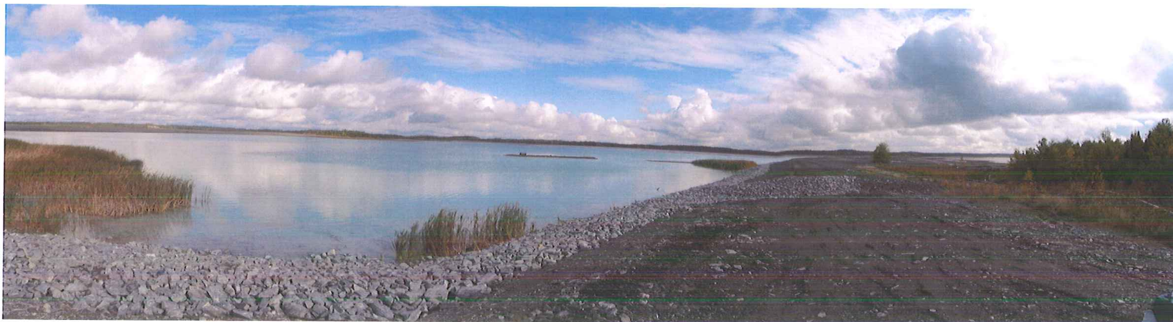
Photo 2 : Le parc à résidus vu de la digue sud. À gauche le bassin central et à droite une partie du bassin sud. Coordonnées UTM, 18U : 0299805E / 5512909N.
