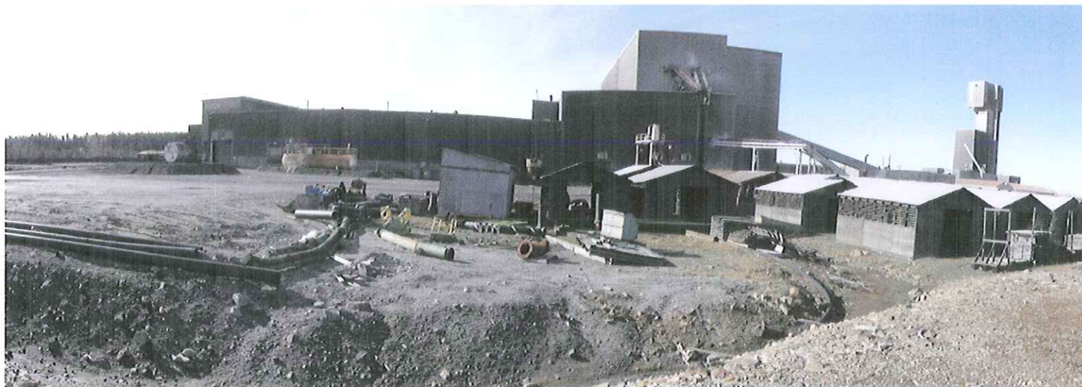
Photo 9 : Vue arrière du moulin et ancien chevalement de MLM.
