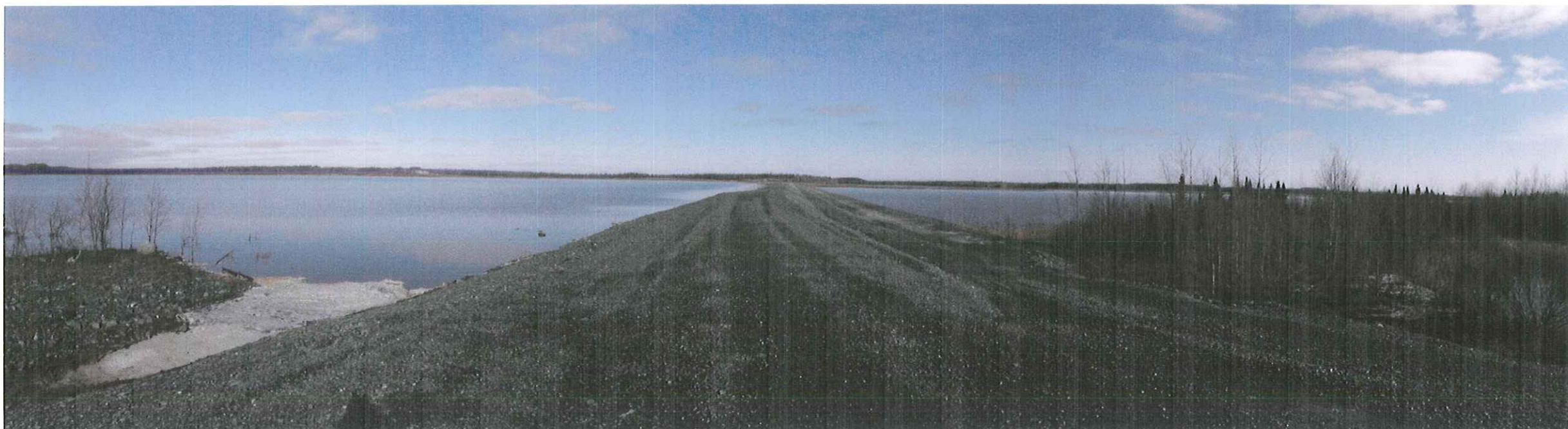
Photo 8 : Bassin Ouest à gauche, digue Nord-Sud et bassin Central à gauche.
