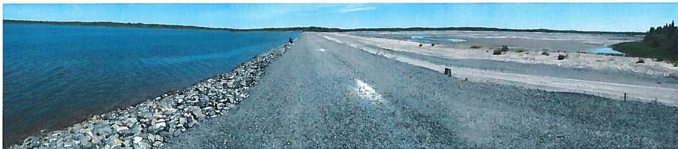
MLM-LW-2017-07-25-015 : Bassin ouest (à gauche) et bassin central (à droite) du parc à résidus du Lac Watson.
