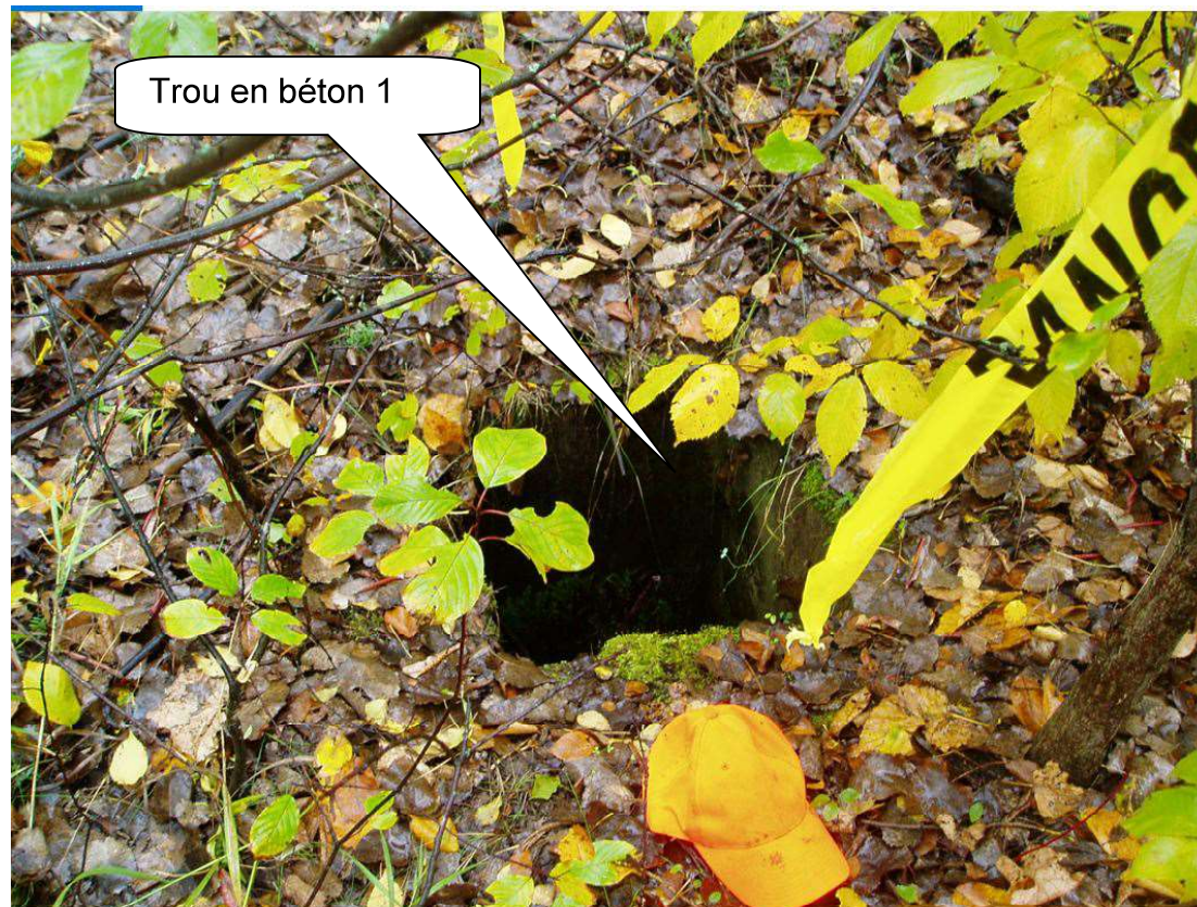
SLC-2009-10-09-131 – Trou en béton 1 (bac) à sécuriser par remblayage (vue du dessus) Coordonnées UTM Nad 83 : 575733 Est, 5039355 Nord
