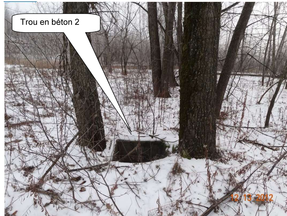
SLC-2012-12-13-005 – Trou 2 en béton (bac) à sécuriser par remblayage (vue vers le Sud-Est) Coordonnées UTM Nad 83 : 575786 Est, 5039204 Nord
