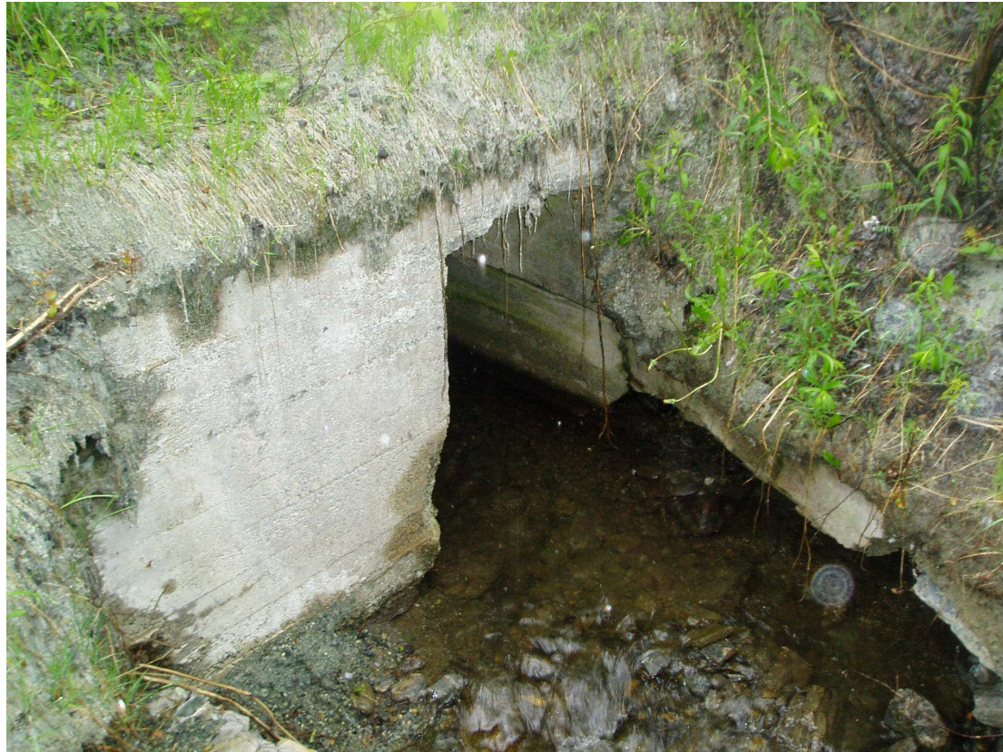
H : QA-2010-06-01-016 – Sortie du tuyau de drainage sous les résidus, l'entrée est la photo 20 (vue vers le nord-ouest)
