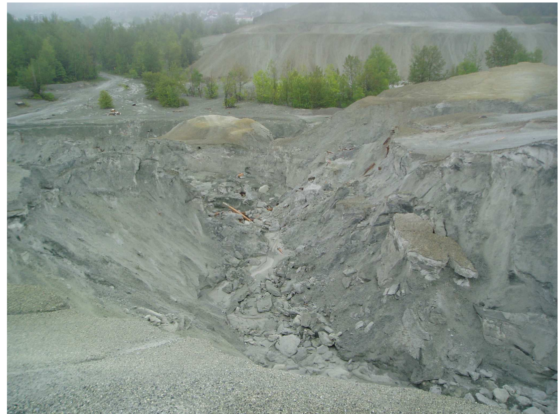
M : QA-2010-06-01-024 – Résidus au sud, sortie de la crevasse fait par l'eau en Avril 2010 vers les résidences (vue vers le sud)
