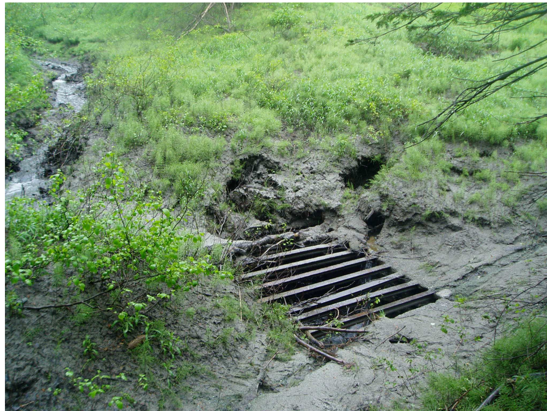
K : QA-2010-06-01-020 – Début du tuyau de drainage qui passe sous les résidus. De plus à sécuriser (vue vers le nord-ouest)
