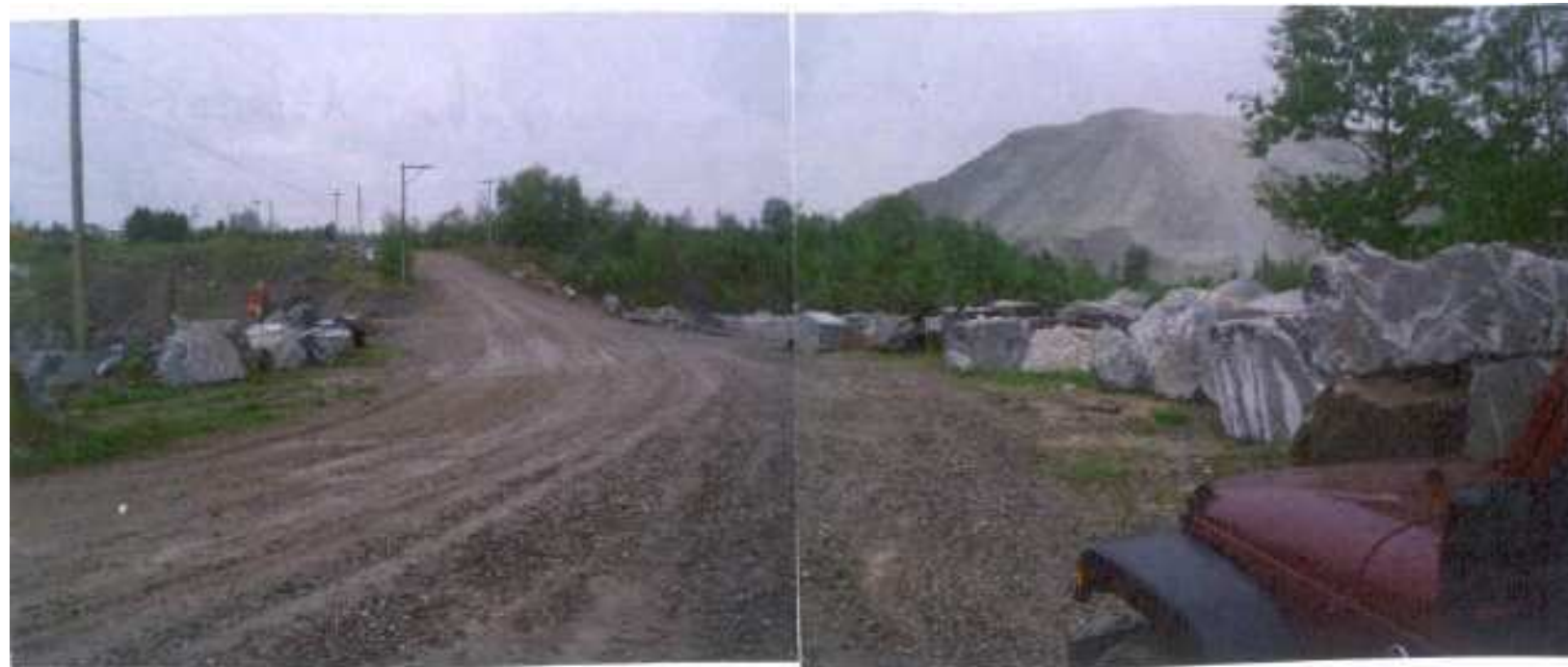
A : QA-2010-06-01-003 et 004 – Au fond à gauche les 2 bâtiments de la cie : Les Pierres Stéatites et à droite les résidus du côté Ouest (vue vers le nord)
