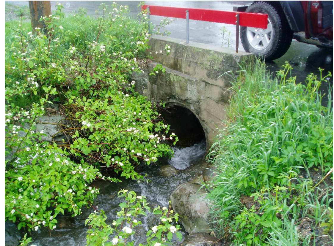
J : QA-2010-06-01-019 – Entrée du tuyau de drainage à la 9 ièée rue (vue vers le sud)
