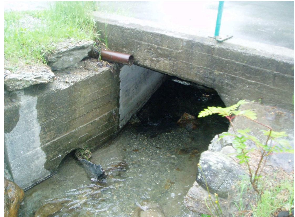
G : QA-2010-06-01-014 – Entrée du tuyau de drainage de la 13 ième rue. (vue vers le sud)
