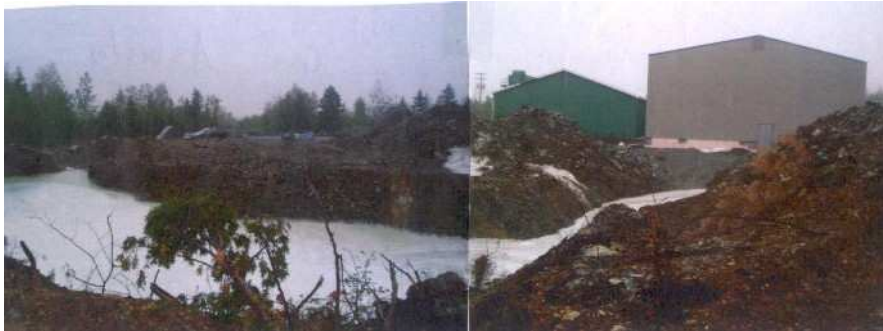
P : QA-2010-06-01-033 et 034 – En arrière du bâtiment avec le bassin de sédimentation de la cie : LES PIERRES STÉATITES (vue vers l'ouest)
