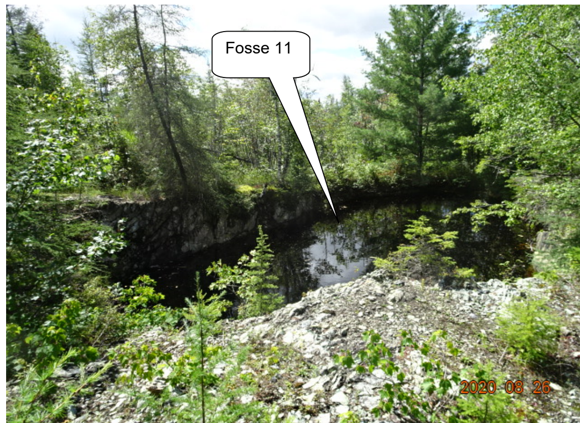
ACh-2020-08-26-006 – Fosse 11 à sécuriser par remblayage (vue vers le Sud-Ouest) Coordonnées UTM Nad 83 : 323862 Est, 5097779 Nord
