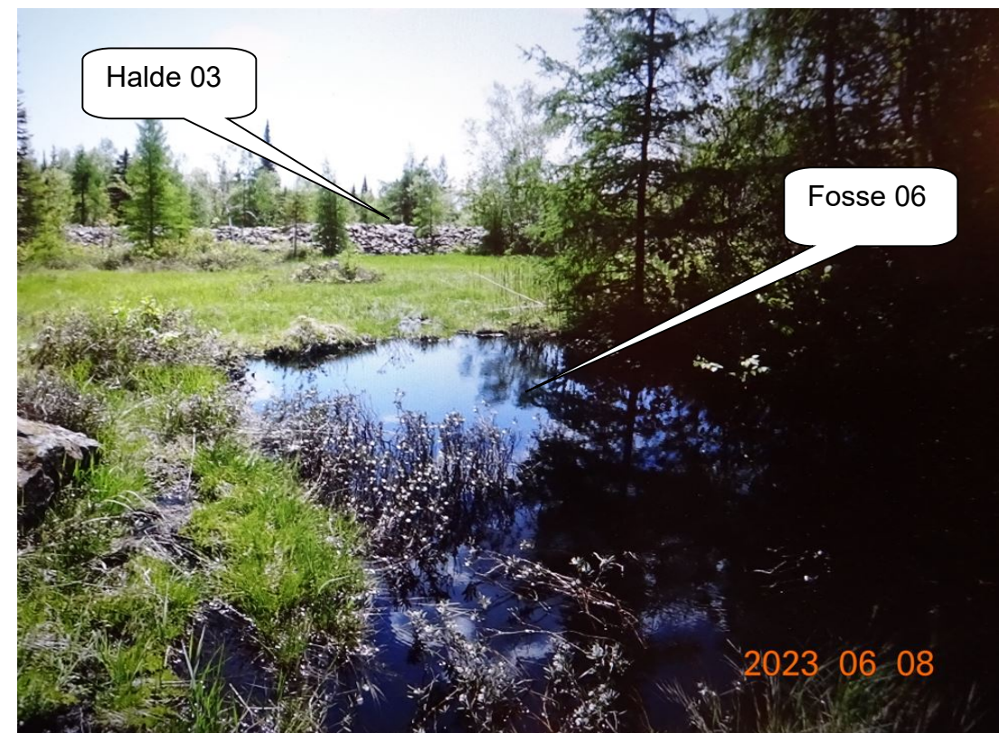
ACH-2023-06-08-006 – Fosse 06 à sécuriser par remblayage. En arrière halde à stériles 03 (vue vers le Nord)
